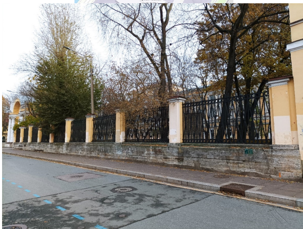
2. Объект культурного наследия федерального значения: «Ограда с воротами дворца Разумовского К.Г.», по адресу: Санкт-Петербург, р. Мойки наб., 48, корп. 5, входящий в состав объекта культурного наследия федерального значения «Воспитательный дом Императорский», по адресу: Санкт-Петербург, р. Мойки наб., 48-54, Гороховая ул., 18, Казанская ул., 3. Дата съемки: 18.10.2023г.
