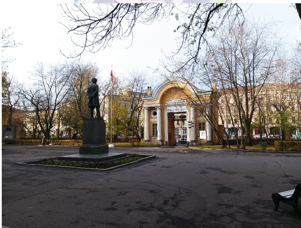
7. Объект культурного наследия федерального значения: «Ограда с воротами дворца Разумовского К.Г.», по адресу: Санкт-Петербург, р. Мойки наб., 48, корп. 5, входящий в состав объекта культурного наследия федерального значения «Воспитательный дом Императорский», по адресу: Санкт-Петербург, р. Мойки наб., 48-54, Гороховая ул., 18, Казанская ул., 3. Дата съемки: 18.10.2023г.
