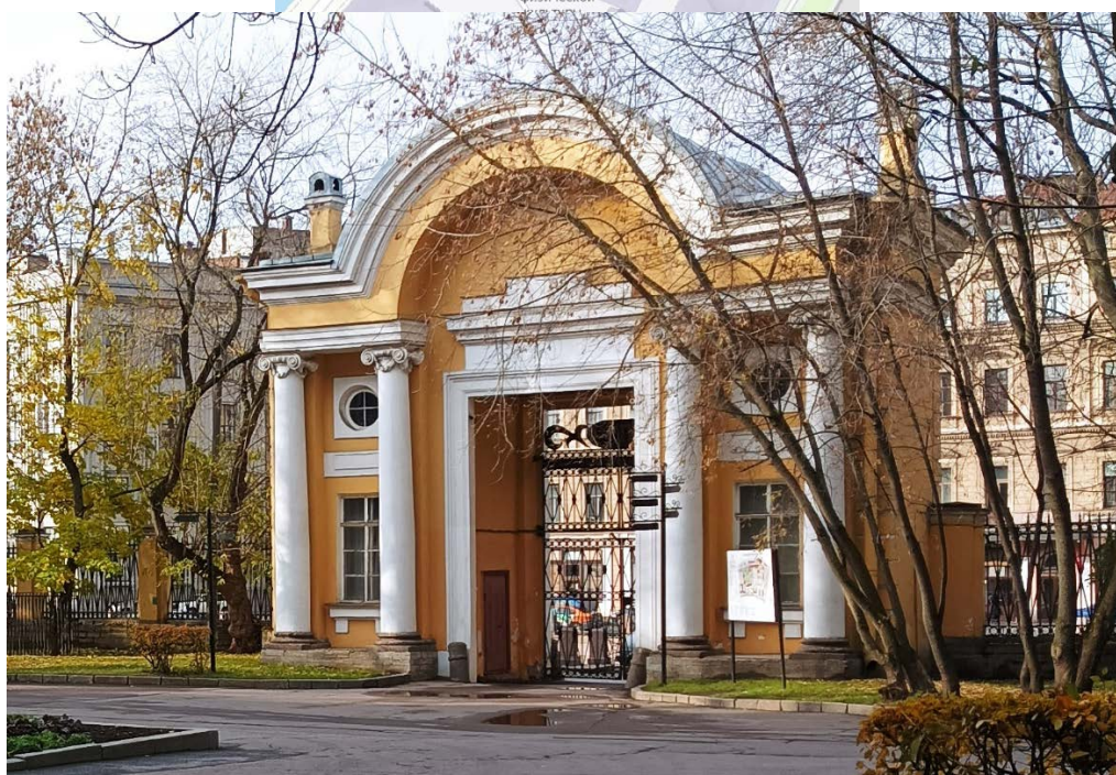
6. Объект культурного наследия федерального значения: «Ограда с воротами дворца Разумовского К.Г.», по адресу: Санкт-Петербург, р. Мойки наб., 48, корп. 5, входящий в состав объекта культурного наследия федерального значения «Воспитательный дом Императорский», по адресу: Санкт-Петербург, р. Мойки наб., 48-54, Гороховая ул., 18, Казанская ул., 3. Дата съемки: 18.10.2023г.
