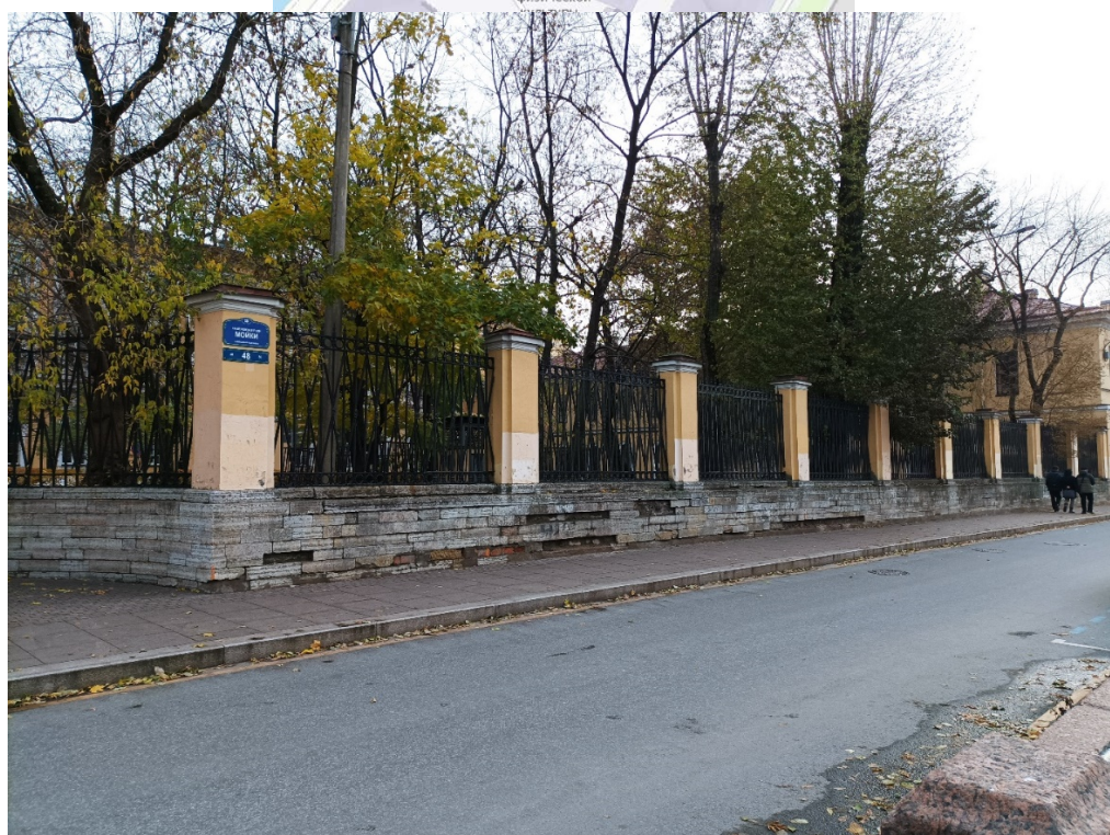
3. Объект культурного наследия федерального значения: «Ограда с воротами дворца Разумовского К.Г.», по адресу: Санкт-Петербург, р. Мойки наб., 48, корп. 5, входящий в состав объекта культурного наследия федерального значения «Воспитательный дом Императорский», по адресу: Санкт-Петербург, р. Мойки наб., 48-54, Гороховая ул., 18, Казанская ул., 3. Дата съемки: 18.10.2023г.
