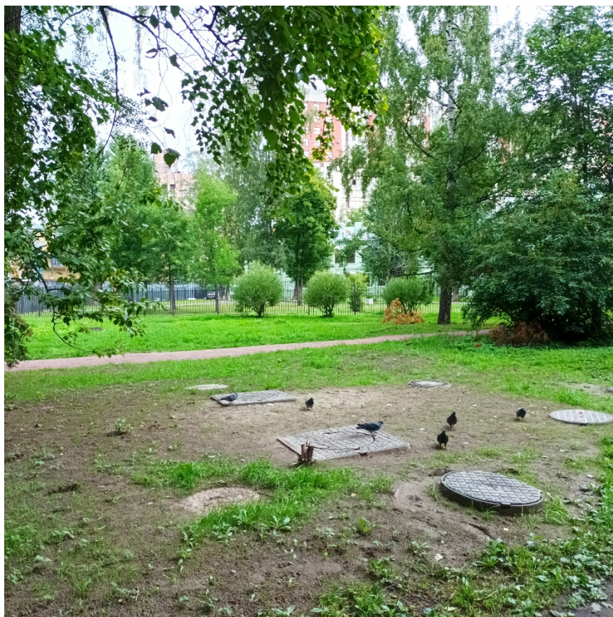
20. Вид участка проектируемого объекта «Реконструкция тепловых сетей в квартале 3 Малой Охты». Дата съемки: 03.07.2023г.
