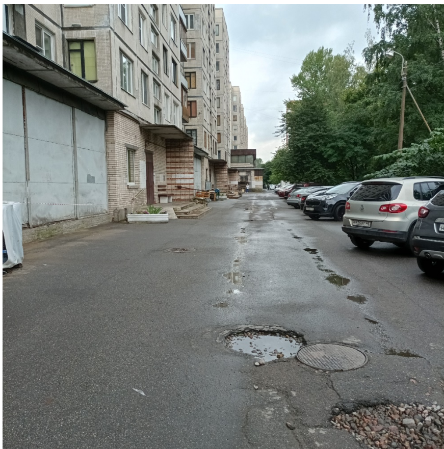
24. Вид участка проектируемого объекта «Реконструкция тепловых сетей в квартале 3 Малой Охты». Дата съемки: 03.07.2023г.
