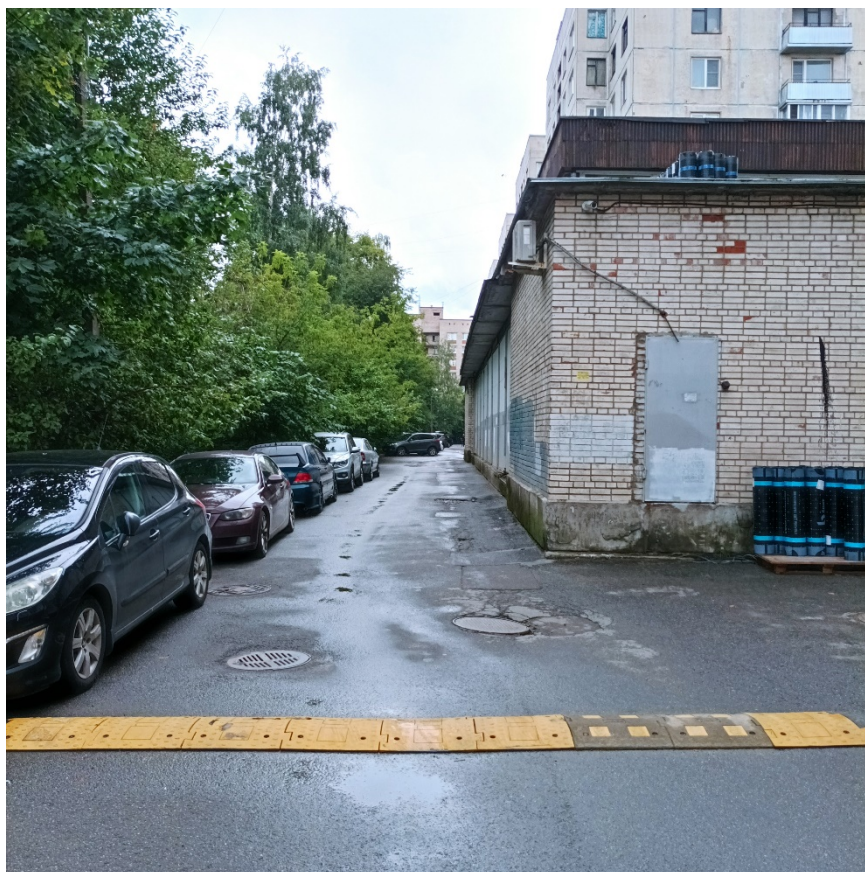
23. Вид участка проектируемого объекта «Реконструкция тепловых сетей в квартале 3 Малой Охты». Дата съемки: 03.07.2023г.
