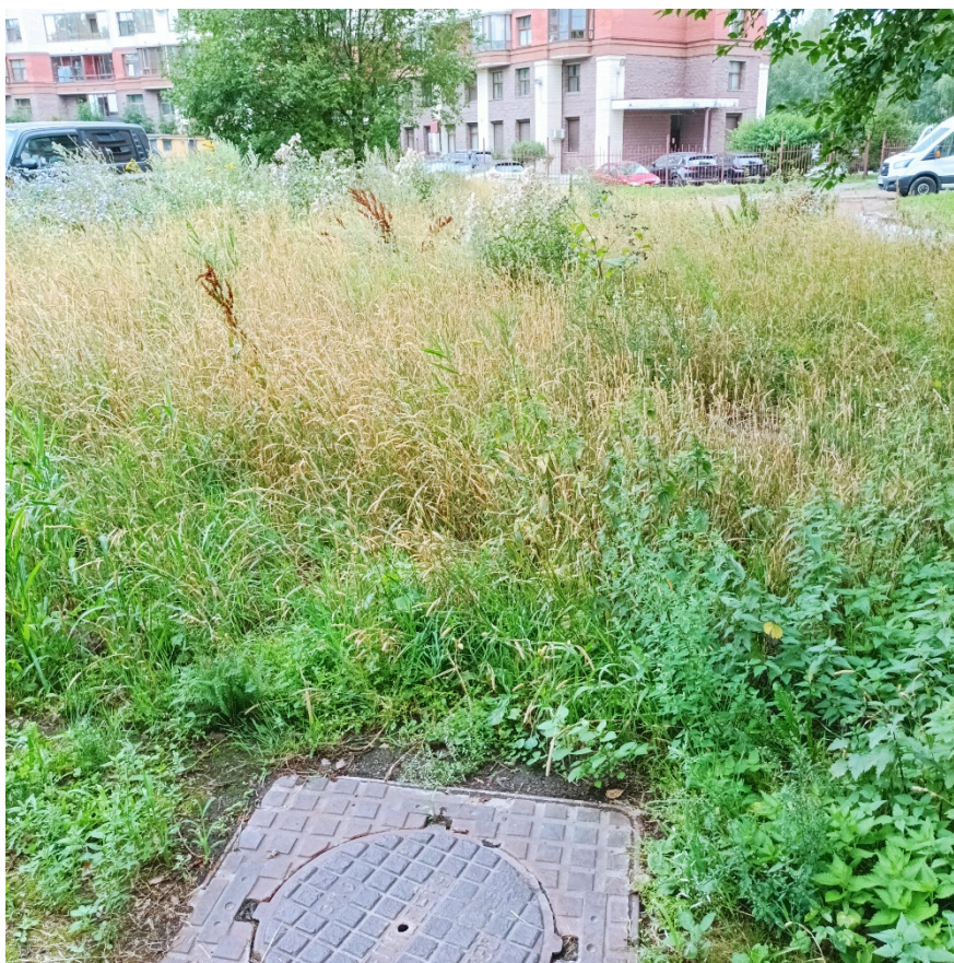
17. Вид участка проектируемого объекта «Реконструкция тепловых сетей в квартале 3 Малой Охты». Дата съемки: 03.07.2023г.
