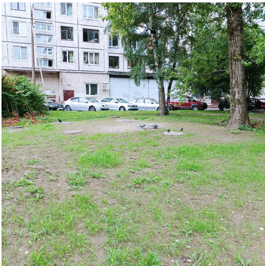
21. Вид участка проектируемого объекта «Реконструкция тепловых сетей в квартале 3 Малой Охты». Дата съемки: 03.07.2023г.
