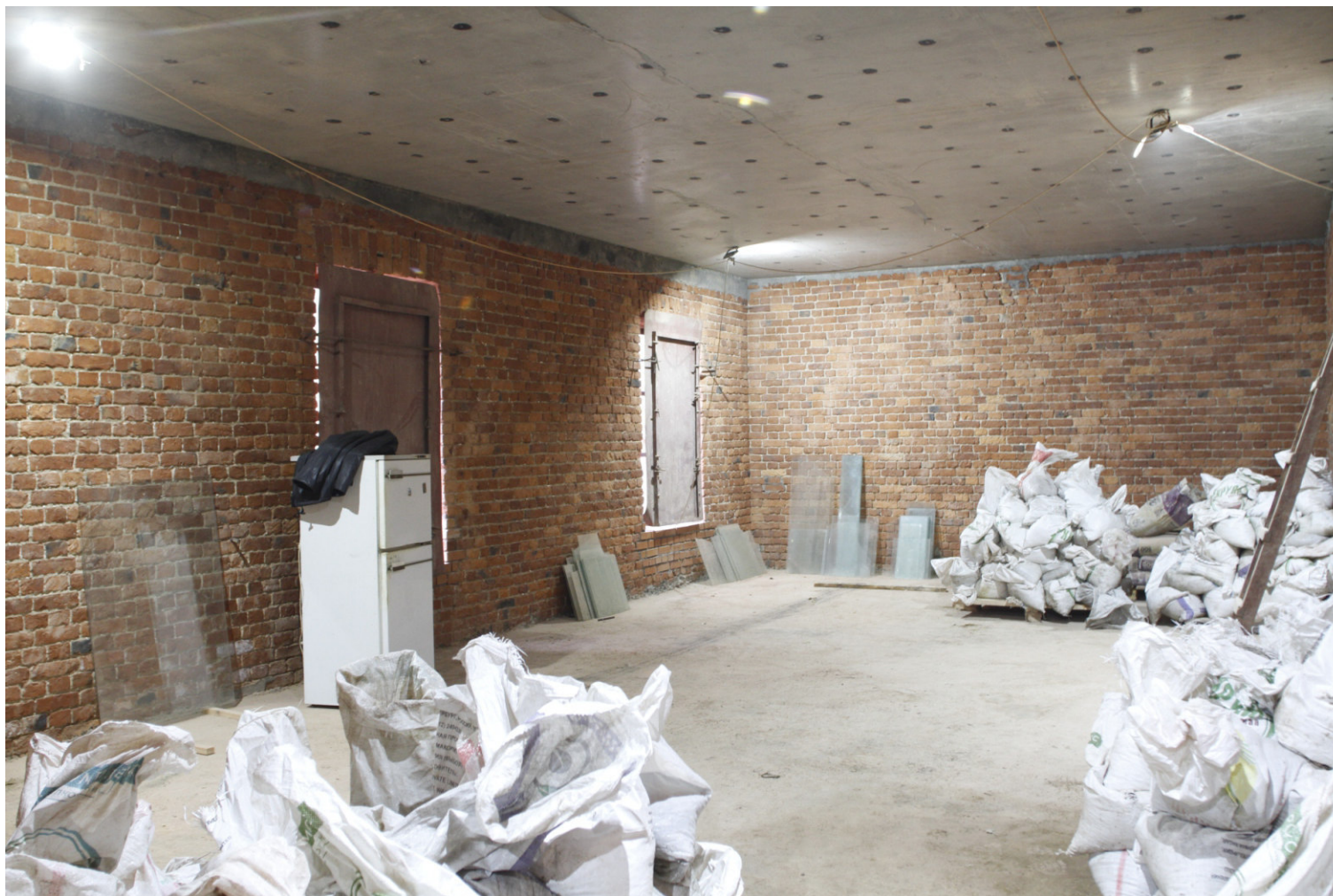
13. “Офицерский флигель (чайная”). г. Ломоносов, Владимирская ул., дом 15, лит.А. 1-й этаж. Фрагмент помещения кв. № 3. Фото:30.10.2023.
