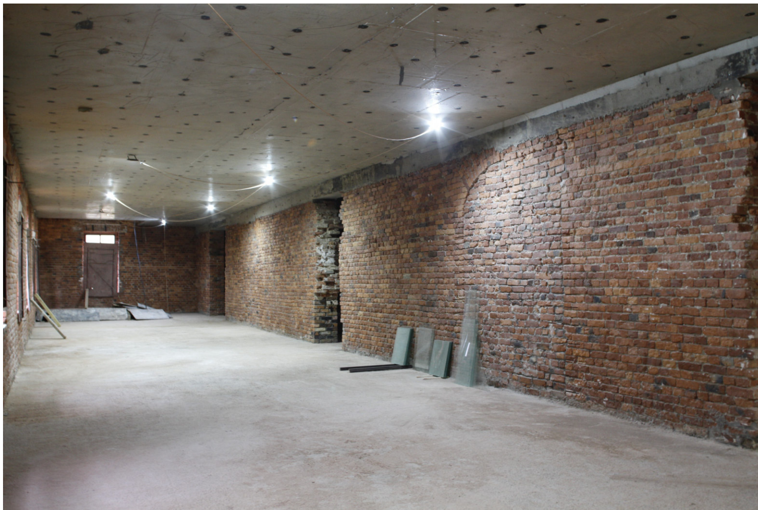
19. “Офицерский флигель (чайная)”. г. Ломоносов, Владимирская ул., дом 15, лит.А. 2-й этаж. Фрагмент помещения кв. № 5. Фото:30.10.2023.
