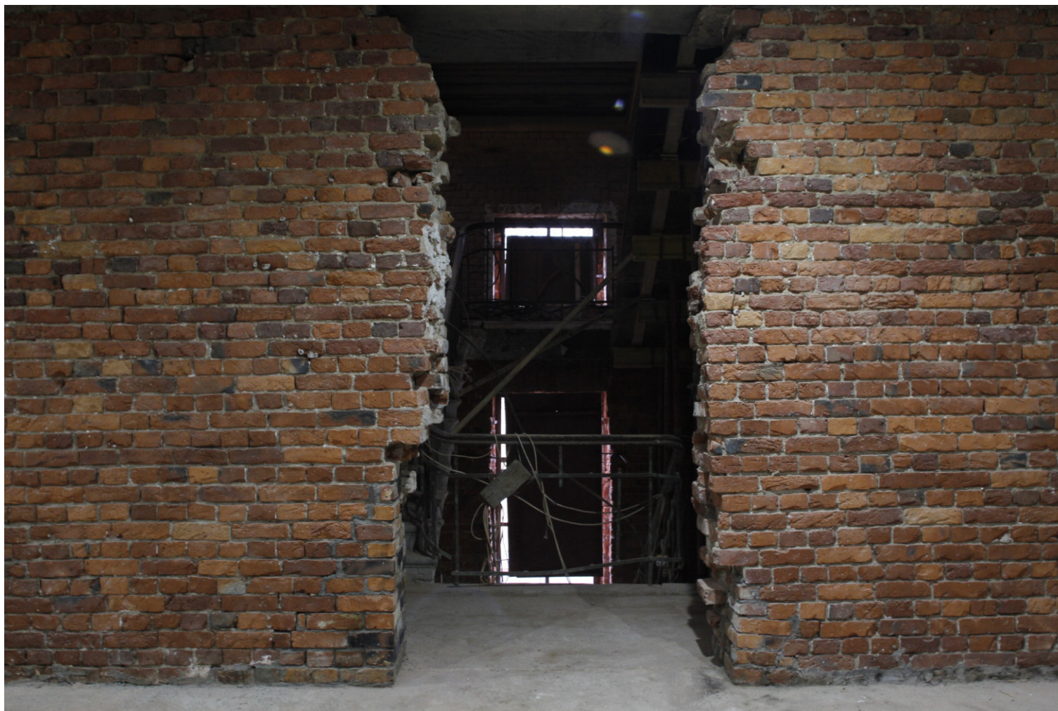
22. “Офицерский флигель (чайная”). г. Ломоносов, Владимирская ул., дом 15, лит.А. 2-й этаж. Фрагмент помещения кв. № 5. Фото:30.10.2023.
