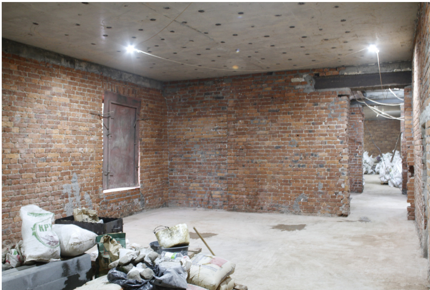
17. “Офицерский флигель (чайная)”. г. Ломоносов, Владимирская ул., дом 15, лит.А. 1-й этаж. Фрагмент помещения кв. №1. Фото:30.10.2023.
