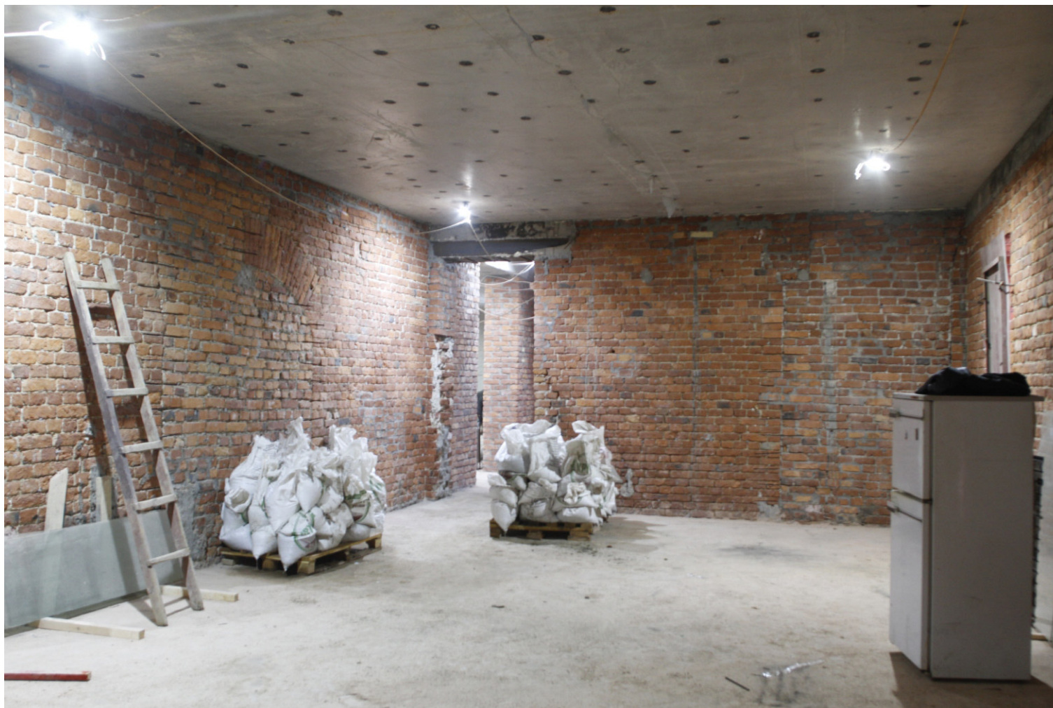
14. “Офицерский флигель (чайная”). г. Ломоносов, Владимирская ул., дом 15, лит.А. 1-й этаж. Фрагмент помещения кв. № 3. Фото:30.10.2023.
