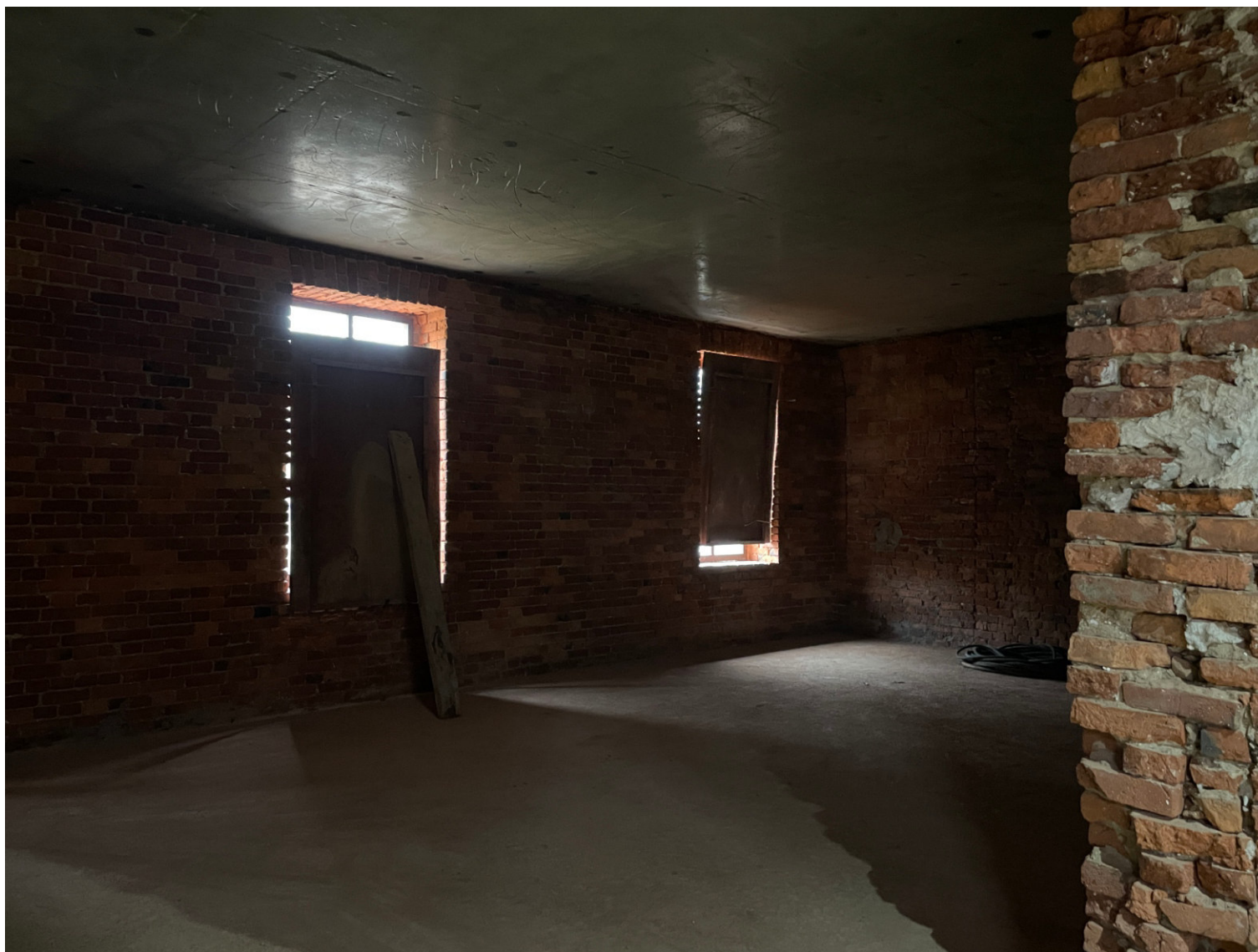
24. “Офицерский флигель (чайная”). г. Ломоносов, Владимирская ул., дом 15, лит.А. 2-й этаж. Фрагмент помещения кв. № 4. Фото:30.10.2023.
