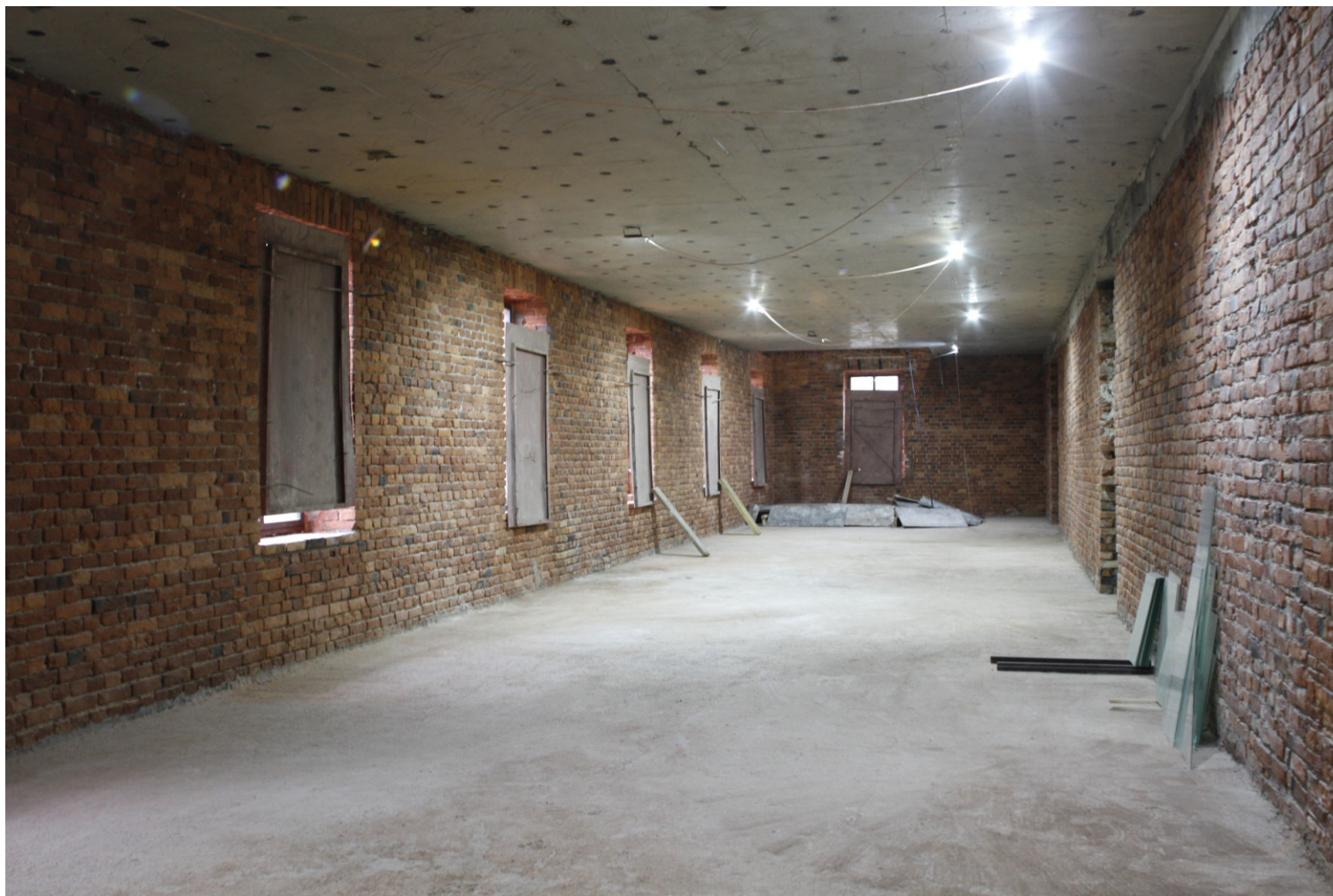
18. “Офицерский флигель (чайная”). г. Ломоносов, Владимирская ул., дом 15, лит.А. 2-й этаж. Фрагмент помещения кв. № 5. Фото:30.10.2023.
