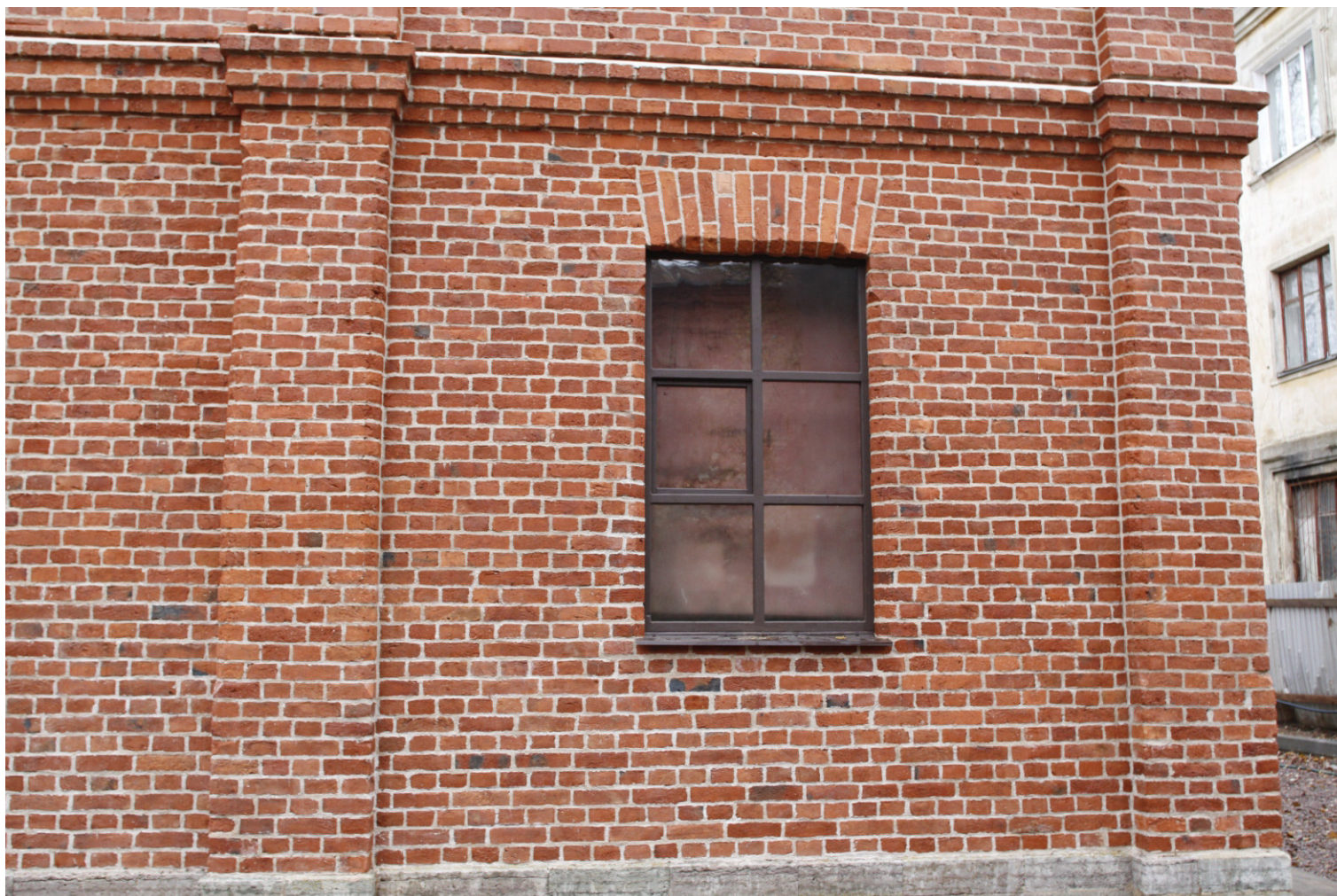
6. “Офицерский флигель (чайная)”. г. Ломоносов, Владимирская ул., дом 15, лит.А. Восточный лицевой фасад. Фрагмент. Фото:30.10.2023.
