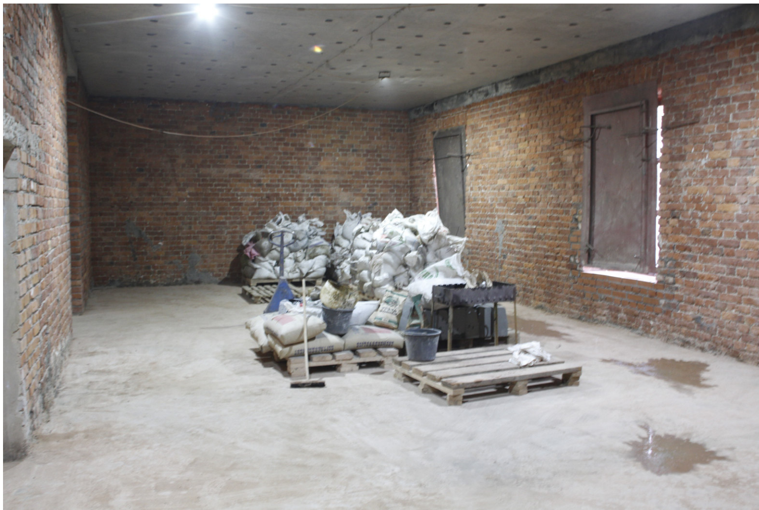
16. “Офицерский флигель (чайная)”. г. Ломоносов, Владимирская ул., дом 15, лит.А. 1-й этаж. Фрагмент помещения кв. № 1. Фото:30.10.2023.
