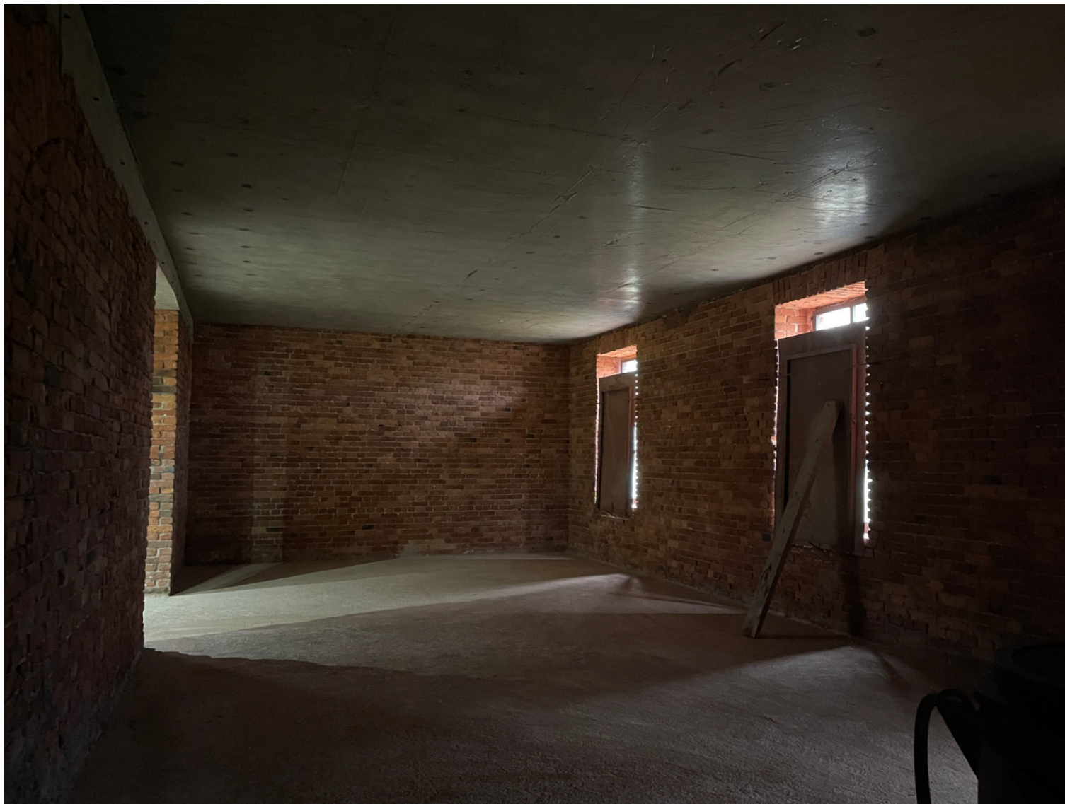
23. “Офицерский флигель (чайная”). г. Ломоносов, Владимирская ул., дом 15, лит.А. 2-й этаж. Фрагмент помещения кв. № 4. Фото:30.10.2023.
