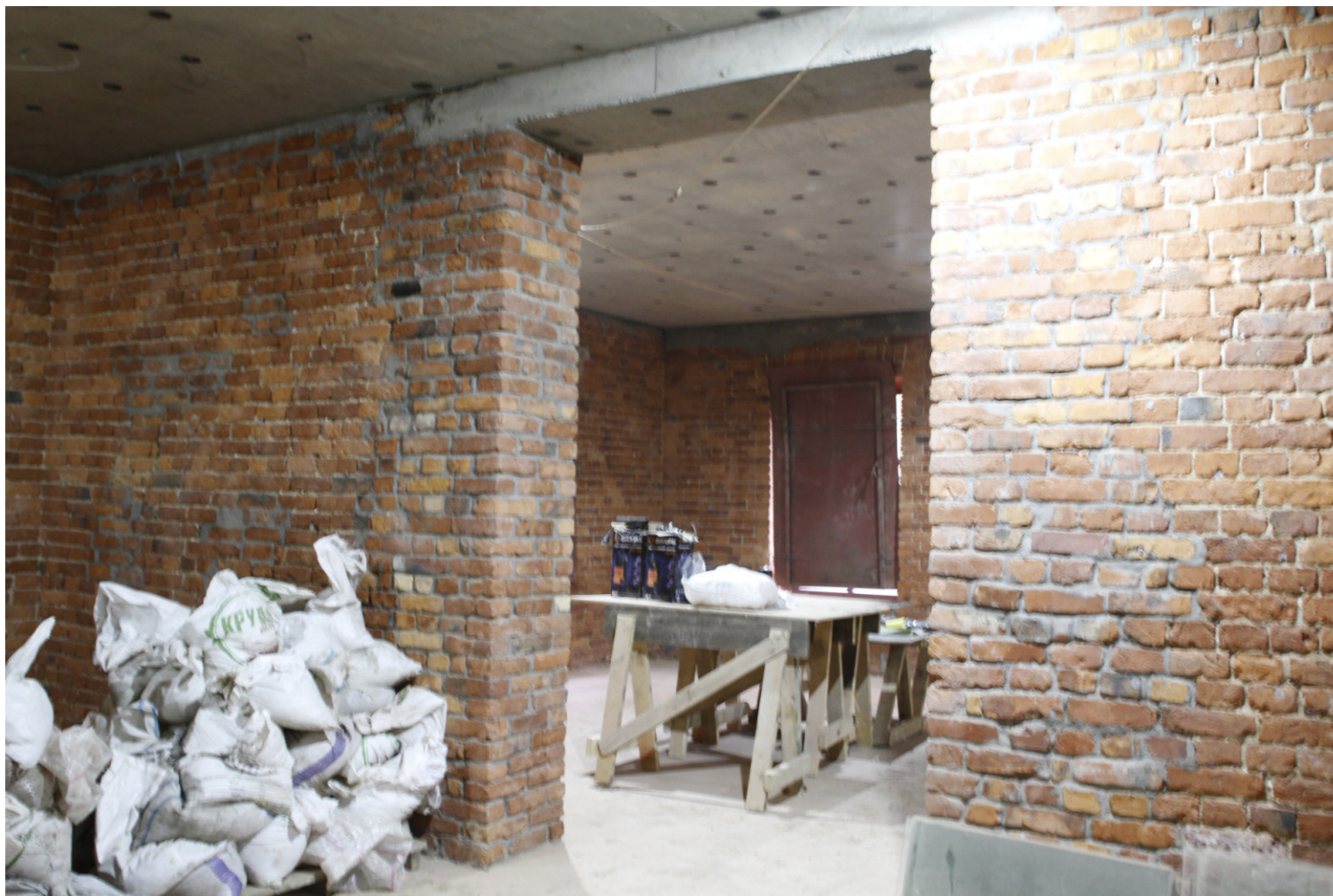
15. “Офицерский флигель (чайная)”. г. Ломоносов, Владимирская ул., дом 15, лит.А. 1-й этаж. Фрагмент помещения кв. № 3. Фото:30.10.2023.
