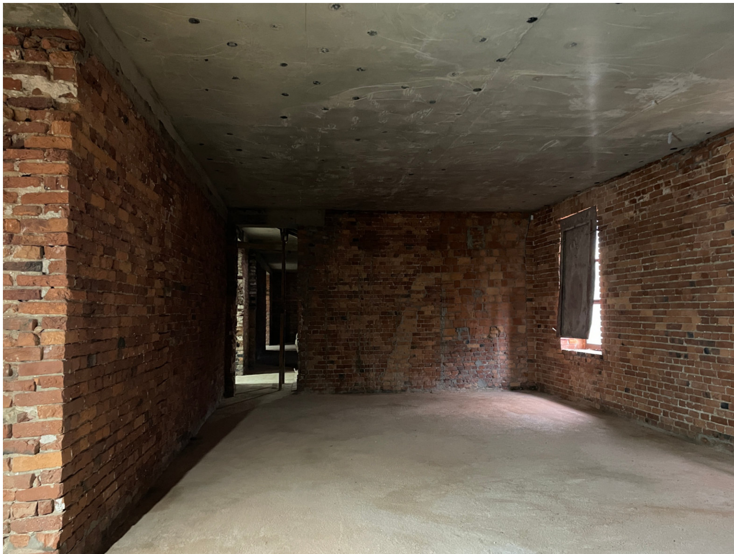
25. “Офицерский флигель (чайная”). г. Ломоносов, Владимирская ул., дом 15, лит.А. 2-й этаж. Фрагмент помещения кв. № 6. Фото:30.10.2023.
