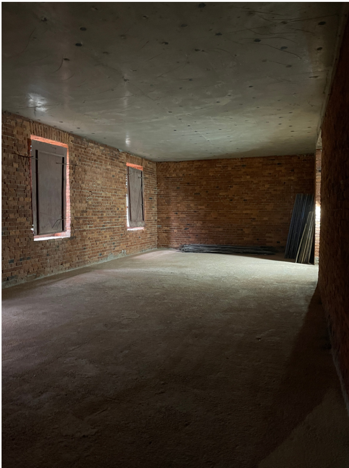
26. “Офицерский флигель (чайная)”. г. Ломоносов, Владимирская ул., дом 15, лит.А. 2-й этаж. Фрагмент помещения кв. № 6. Фото:30.10.2023.
