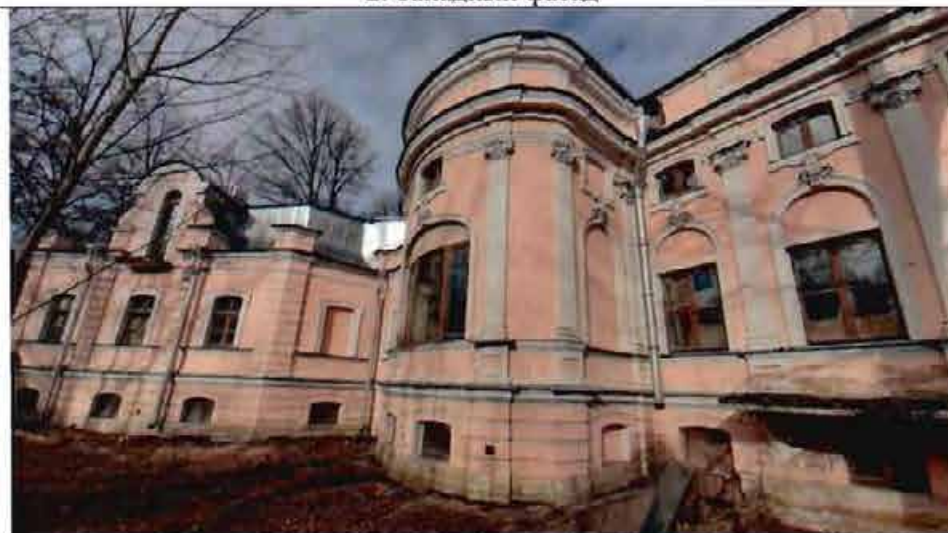
3. Фрагмент южного фасада
