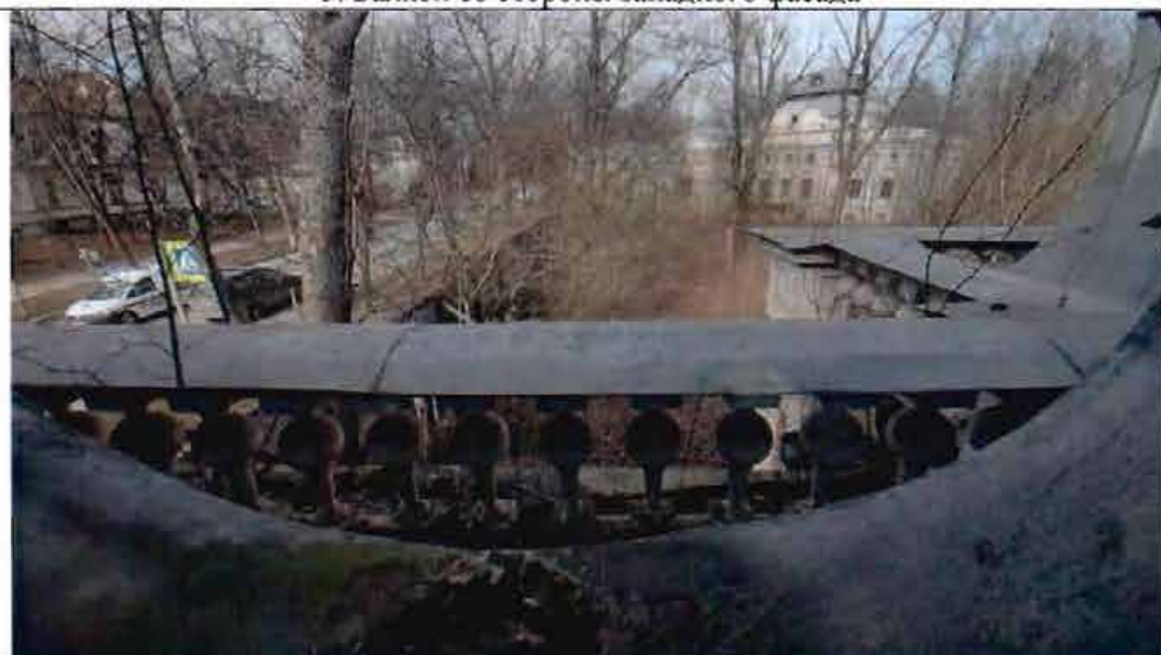
6. Балюстрадное ограждение крыши
