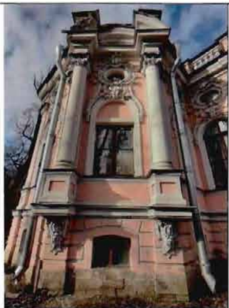
7. Фрагмент восточного фасада
