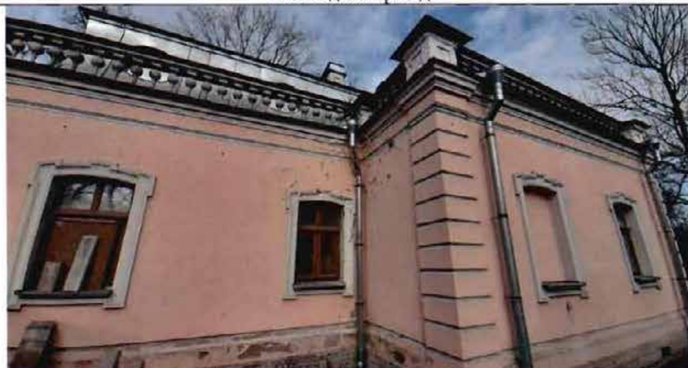
3. Фрагмент южного фасада
