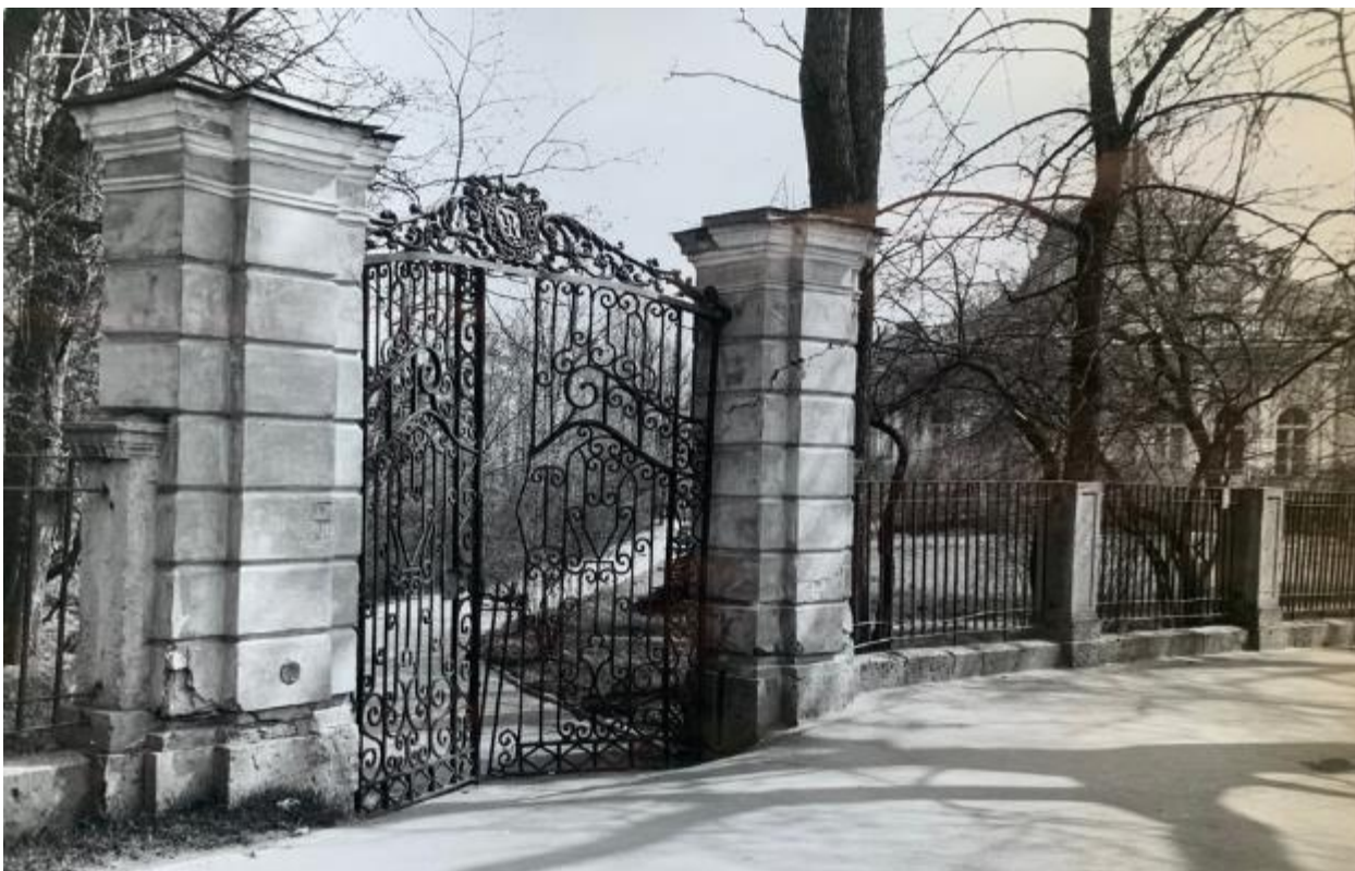
8. Ворота в северной части участка. Фотография 1981 г. Архив КГИОП. Фототека. № 127116
