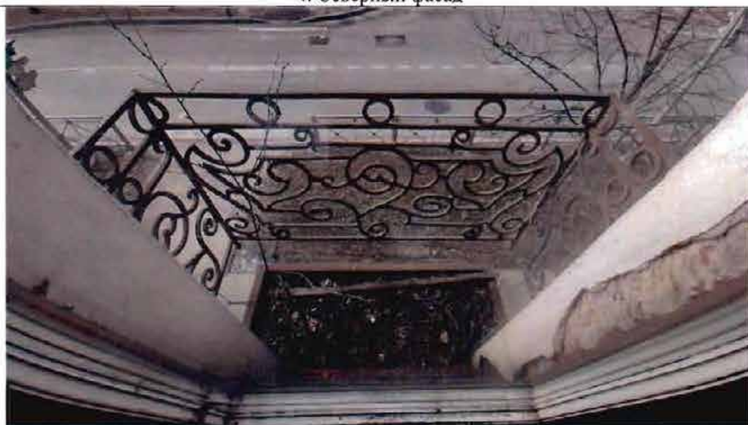
5. Балкон со стороны западного фасада
