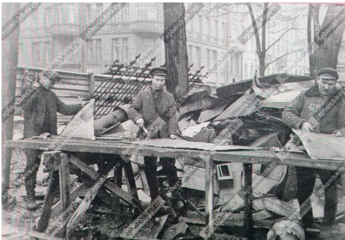
Илл. 86. Выпрямление кровельного железа, снятого с разрушенной церкви Покрова Пресвятой Богородицы на пл. Тургенева. 1934 // ЦГАКФФД СПб. Бр 7804
