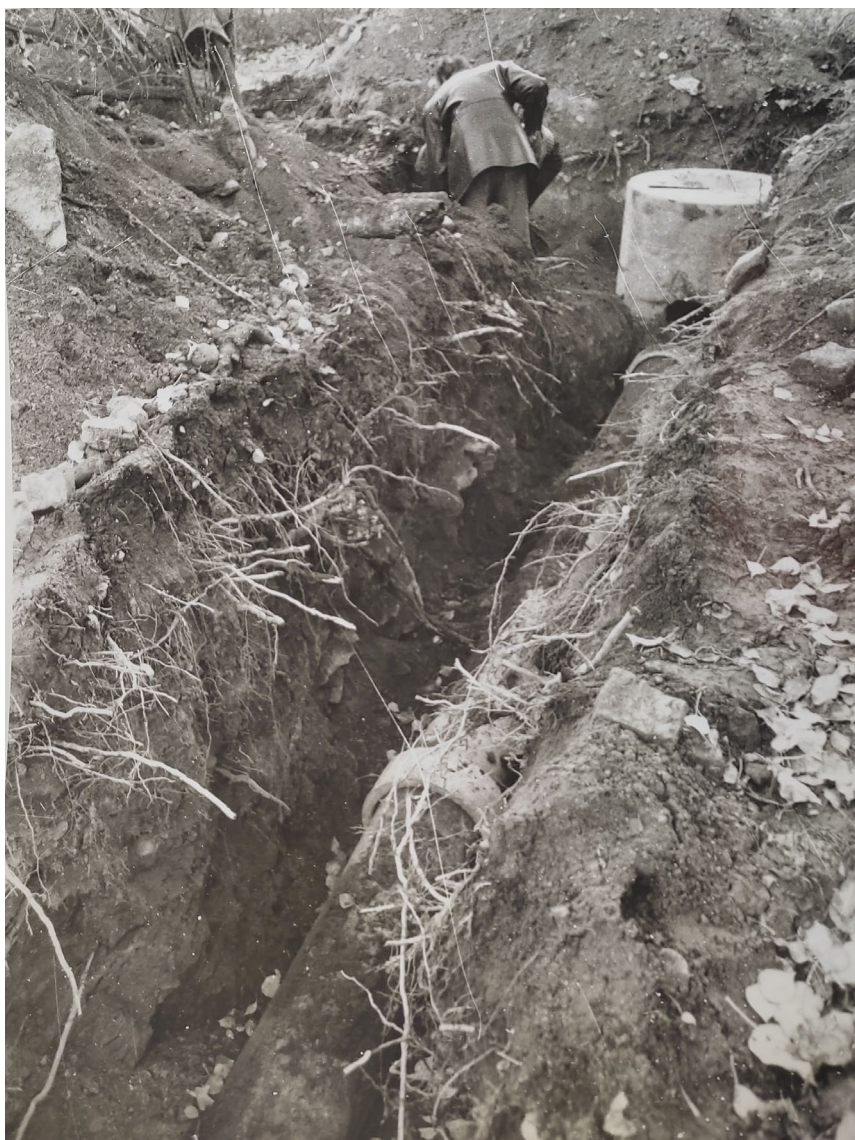
Илл. 96. Археологические работы на площади Тургенева. Прокладка траншеи и устройство дренажа на месте, где стояла Покровская церковь. Фото В. Ф. Егоровский. Октябрь 1996 // Фототека отдела охраны памятников № 941/8-Н
