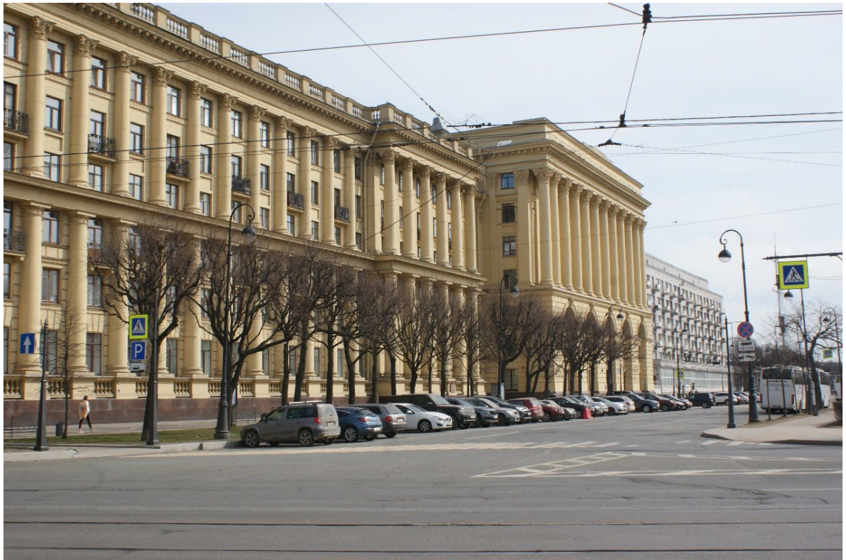
Фото 1. Вид на территорию выявленного объекта культурного наследия «Собор Пресвятой Троицы (Троице-Петровский) (фундамент)» с ул. Куйбышева. Съемка 17.04.2023 г. Трушковский В.Э.
