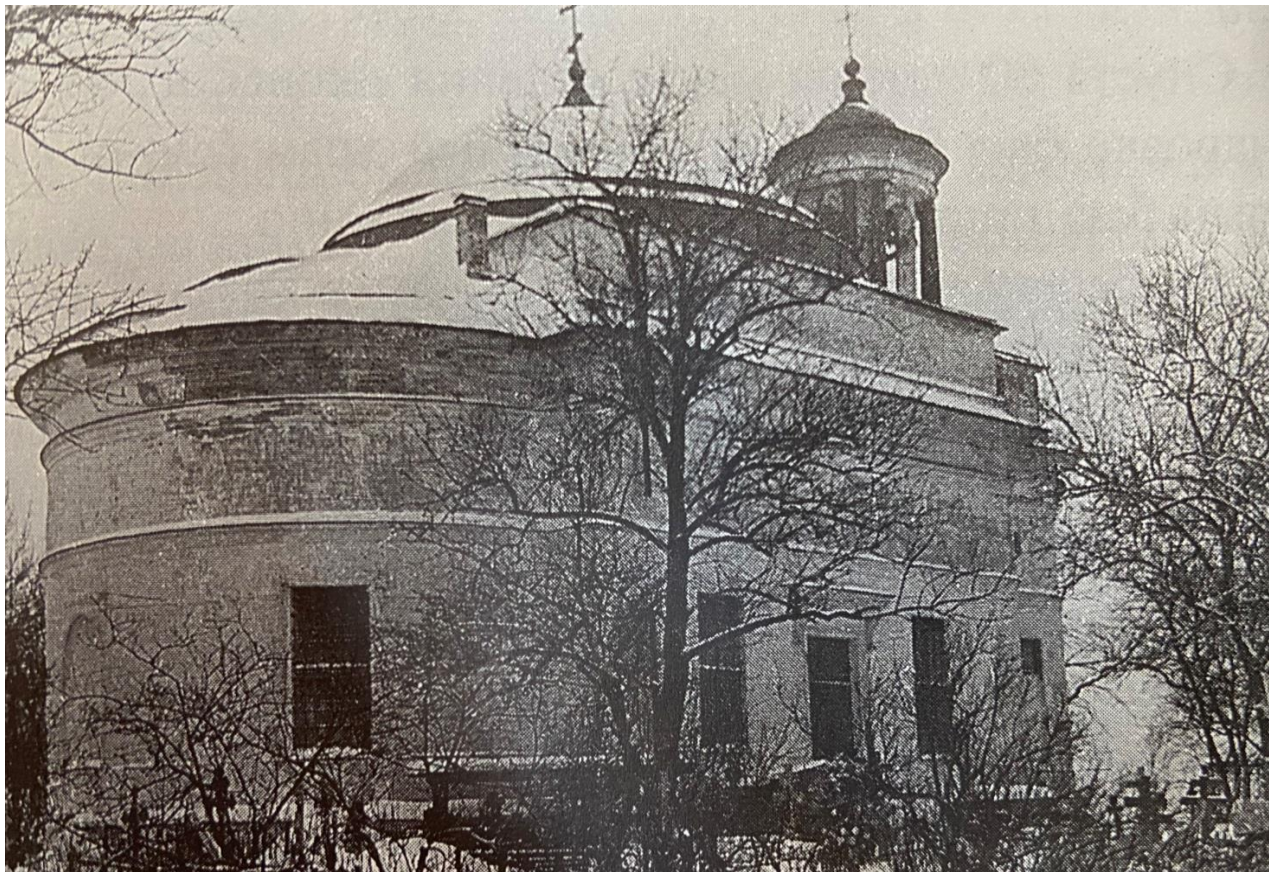
Ил. 7. Церковь Благовещения Богородицы, вид с юго-востока, фото 1930-х гг.
