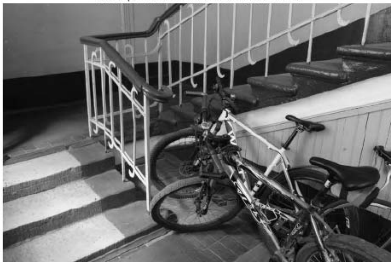
Фото 220. Выявленный объект культурного наследия «Баня». Лестница 2-Н. Фото 03.05.2023 г.
