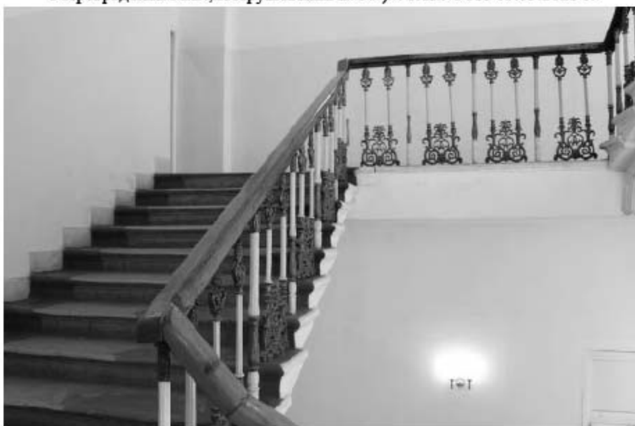
Фото 151. Выявленный объект культурного наследия «Корпус квартир офицеров (угловой)» (объект культурного наследия регионального значения «Академия Михайловская артиллерийская, где преподавали ученые Ленц Э.Х., Остроградский М.В., Петрушевский В.Ф.»). 1ЛК. Фото 03.05.2023 г.
