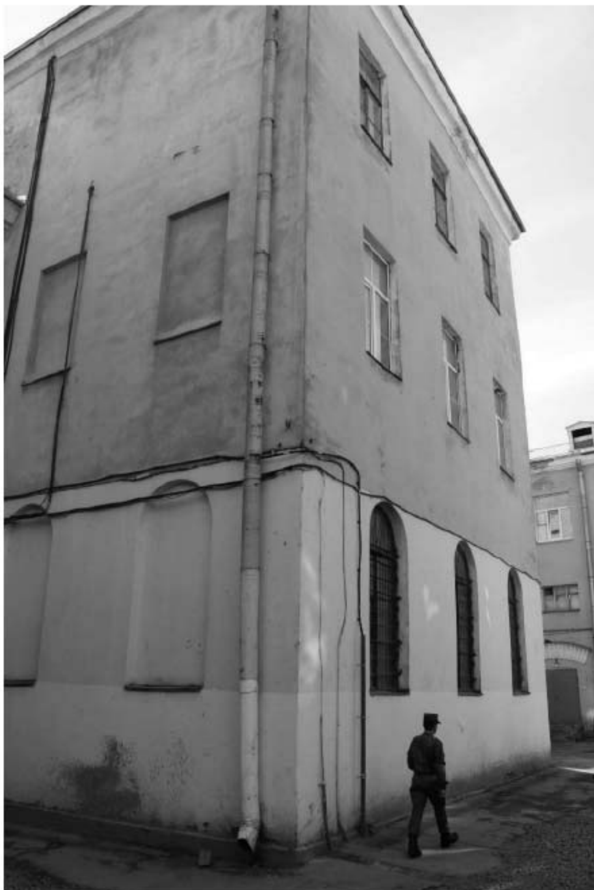
Фото 65. Вид на северный фасад выявленного объекта культурного наследия «Лабораторный корпус». Фото 03.05.2023 г.
