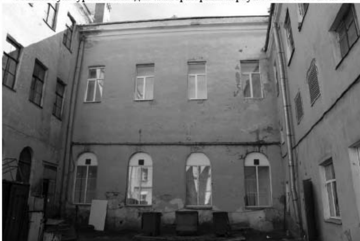
Фото 67. Вид на северный фасад выявленного объекта культурного наследия «Лабораторный корпус». Фото 03.05.2023 г.
