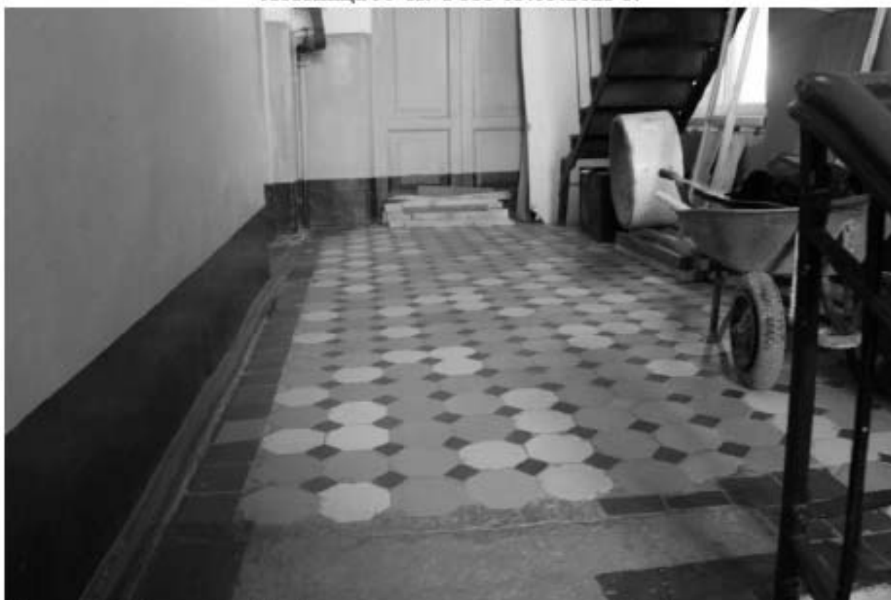
Фото 214. Выявленный объект культурного наследия «Лабораторный корпус». Лестница 99-Н. Фото 03.05.2023 г.
