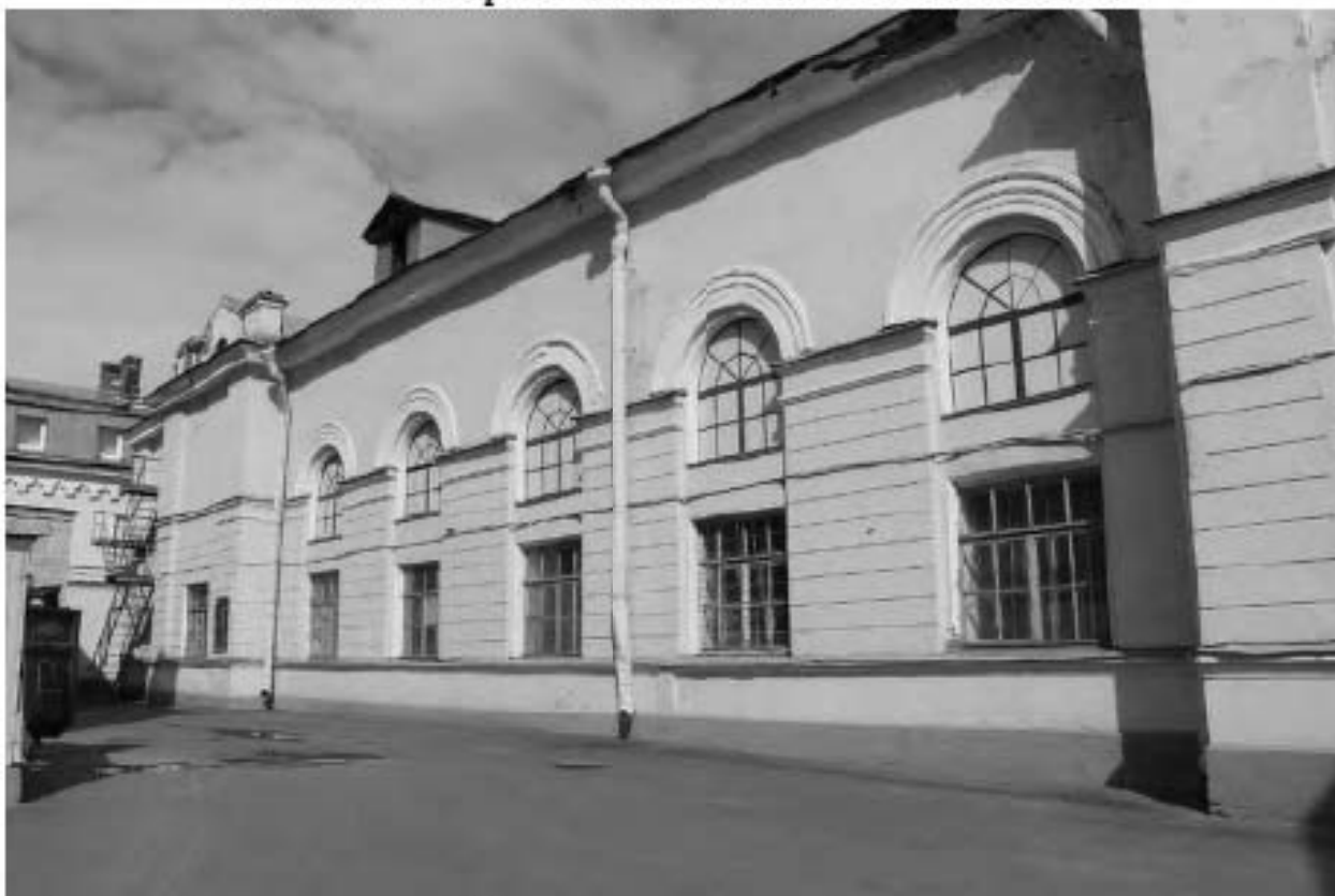
Фото 69. Вид на западный фасад выявленного объекта культурного наследия «Экипажный сарай с конюшнями». Фото 03.05.2023 г.
