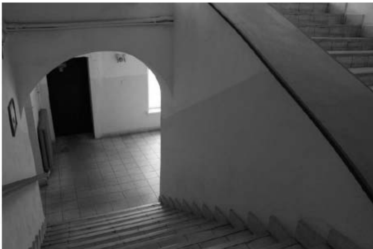
Фото 117. Выявленный объект культурного наследия «Главный корпус с 1-м солдатским корпусом, офицерским флигелем и Михайловское артиллерийское училище». 7ЛК. Фото 03.05.2023 г.
