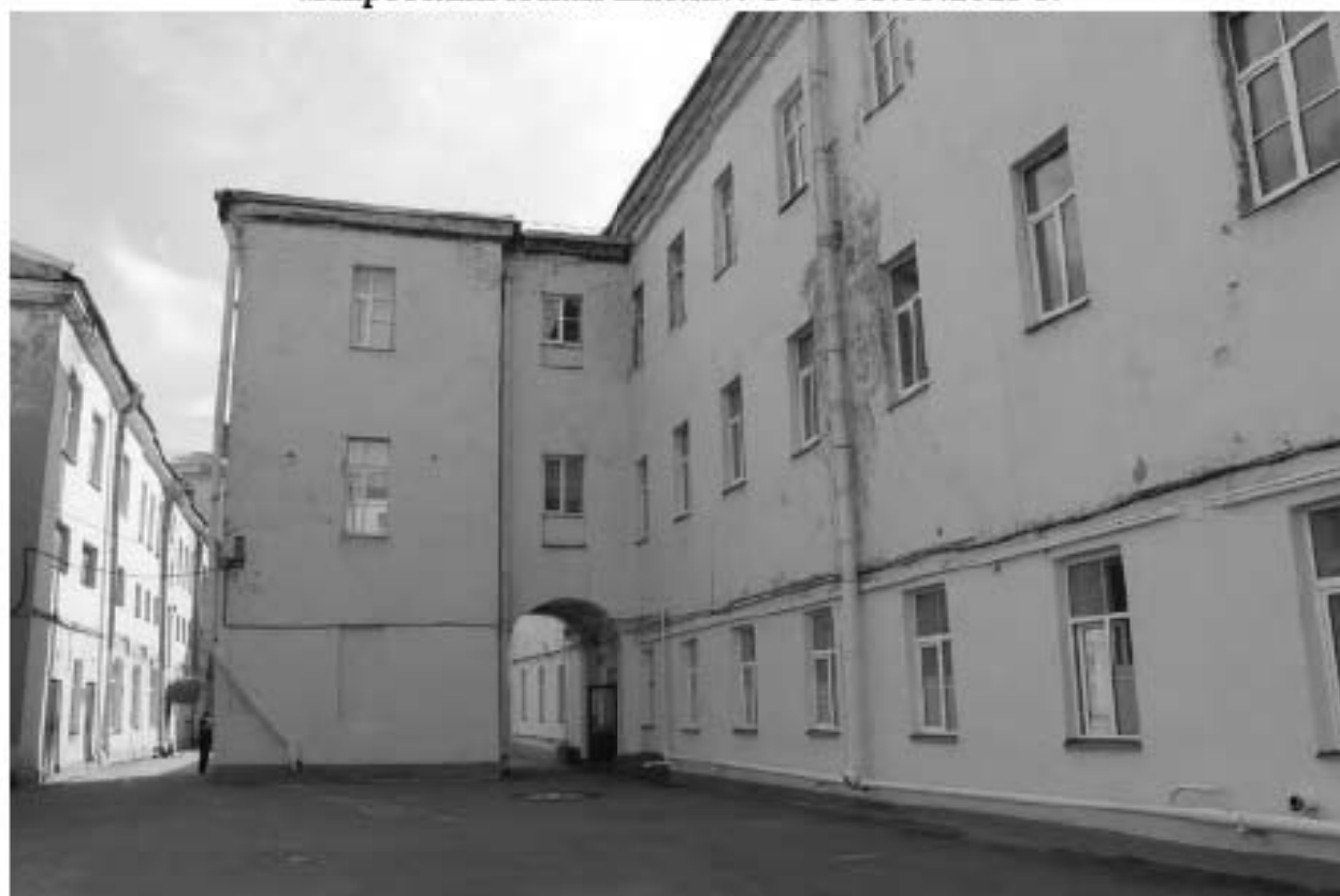
Фото 61. Вид на восточный фасад выявленного объекта культурного наследия «Пиротехническая школа». Фото 03.05.2023 г.
