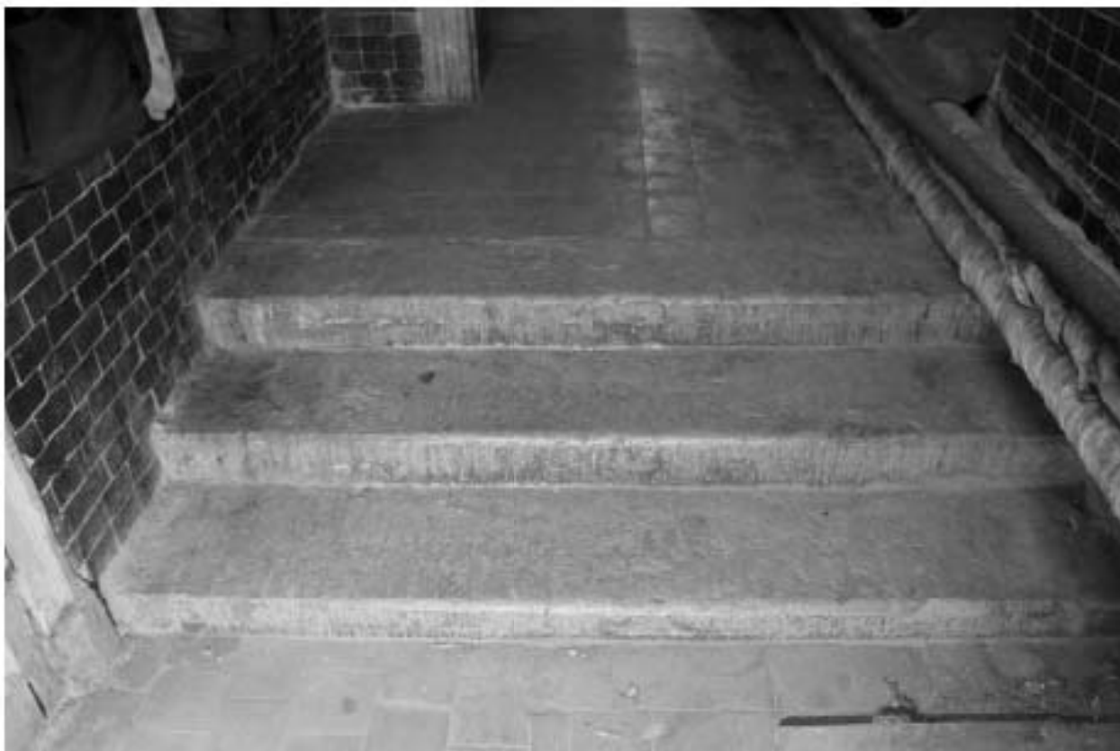
Фото 217. Выявленный объект культурного наследия «Баня». Внутренние помещения 1-го этажа. Фото 03.05.2023 г.
