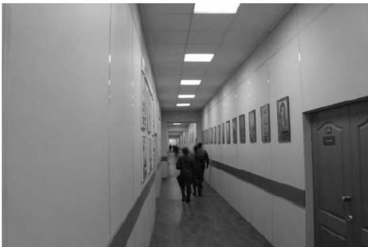
Фото 95. Выявленный объект культурного наследия «Главный корпус с 1-м солдатским корпусом, офицерским флигелем и Михайловское артиллерийское училище». Внутренние помещения 2-го этажа. Фото 03.05.2023 г.
