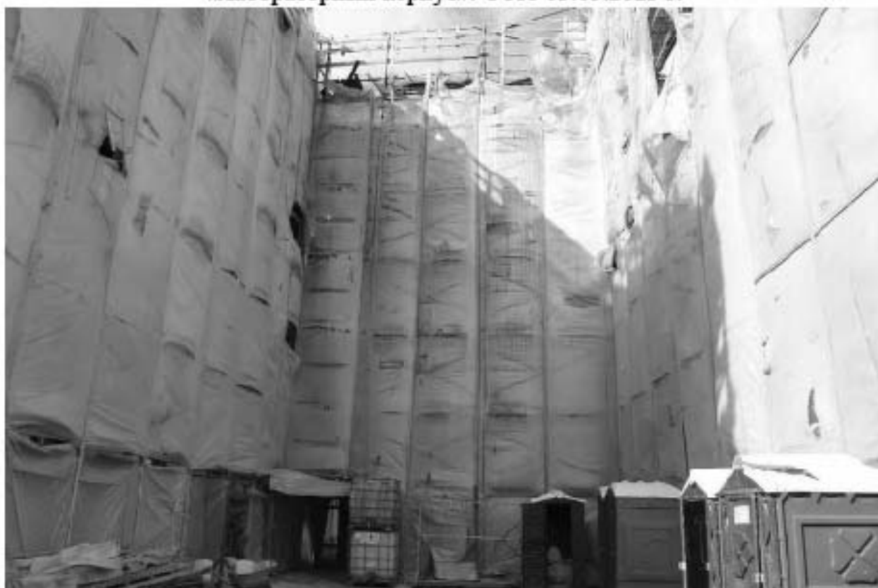
Фото 56. Вид на южный фасад выявленного объекта культурного наследия «Лабораторный корпус». Фото 03.05.2023 г.
