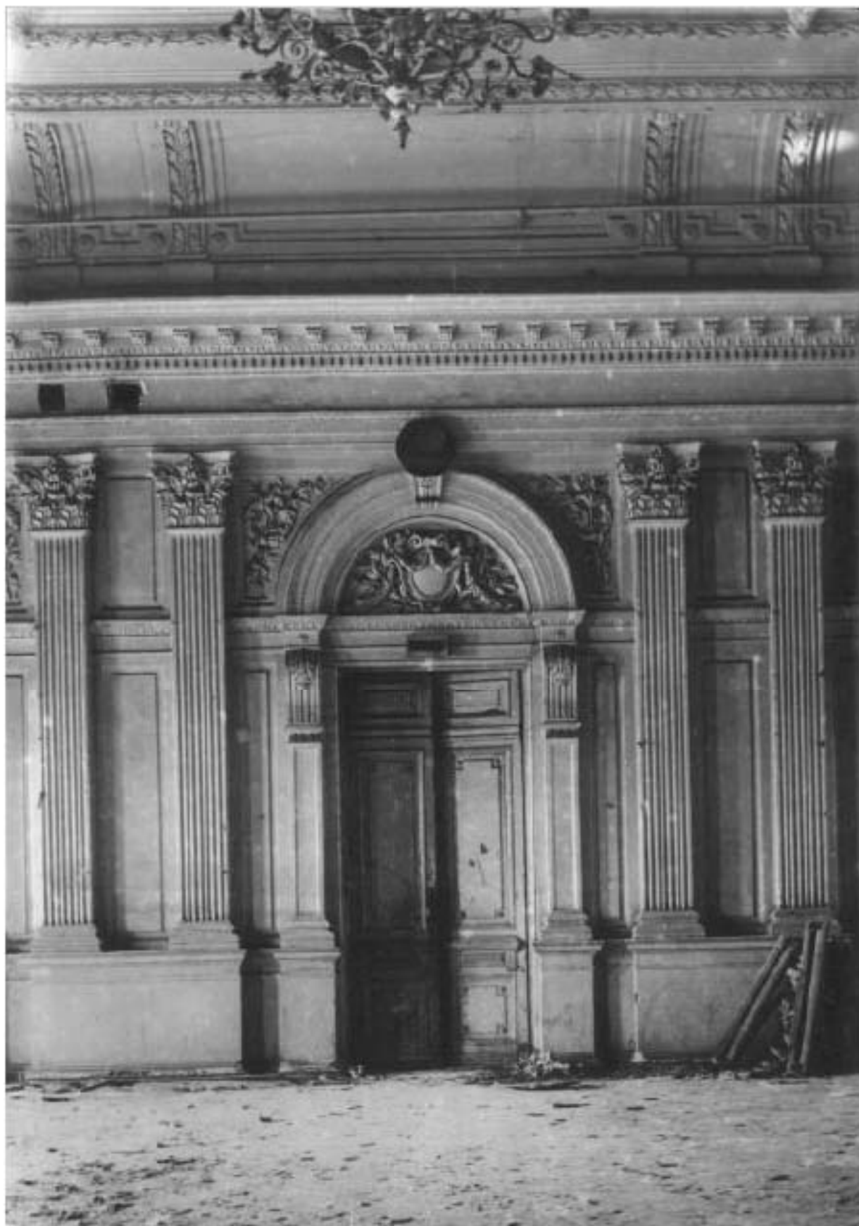
Илл. 89. Архитектурное оформление части торцевой стены зала Высшей офицерской артиллерийской школы. 19.04.1946 г. (источник: архив КГИОП. Фототека отд. охр. пам. № 17095).
