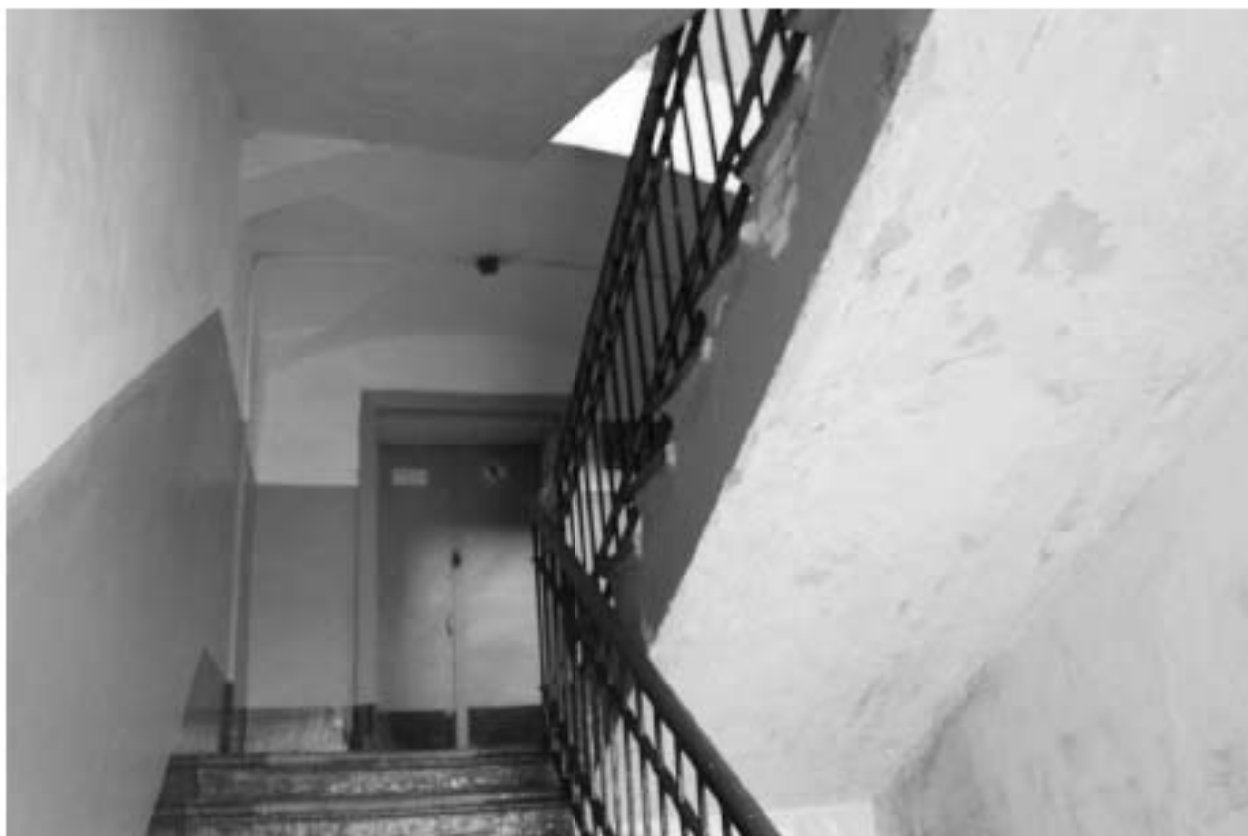
Фото 211. Выявленный объект культурного наследия «Лабораторный корпус». Лестница 99-Н. Фото 03.05.2023 г.
