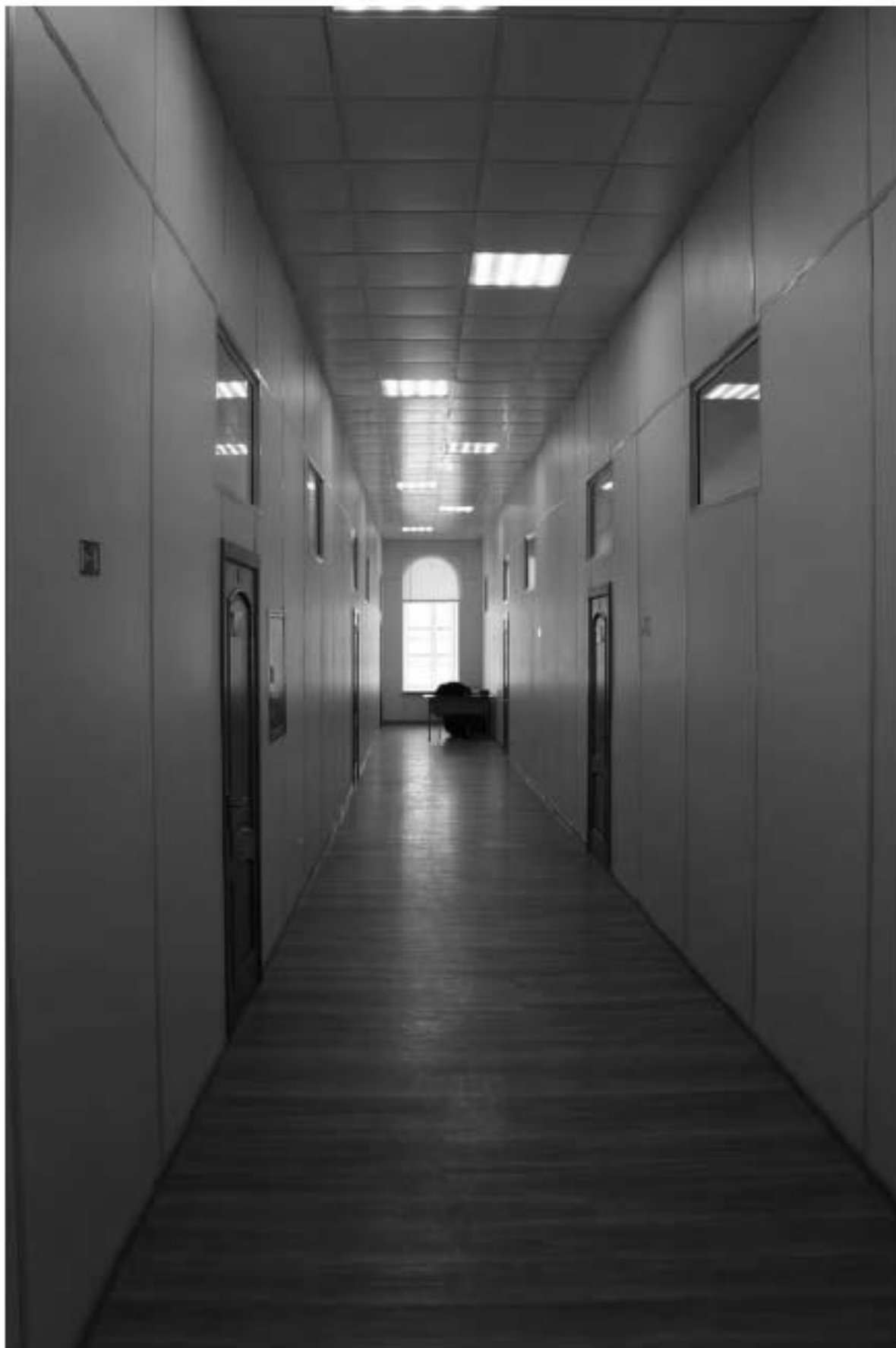
Фото 135. Выявленный объект культурного наследия «Главный корпус с 1-м солдатским корпусом, офицерским флигелем и Михайловское артиллерийское училище». Внутренние помещения 2-го этажа. Фото 03.05.2023 г.
