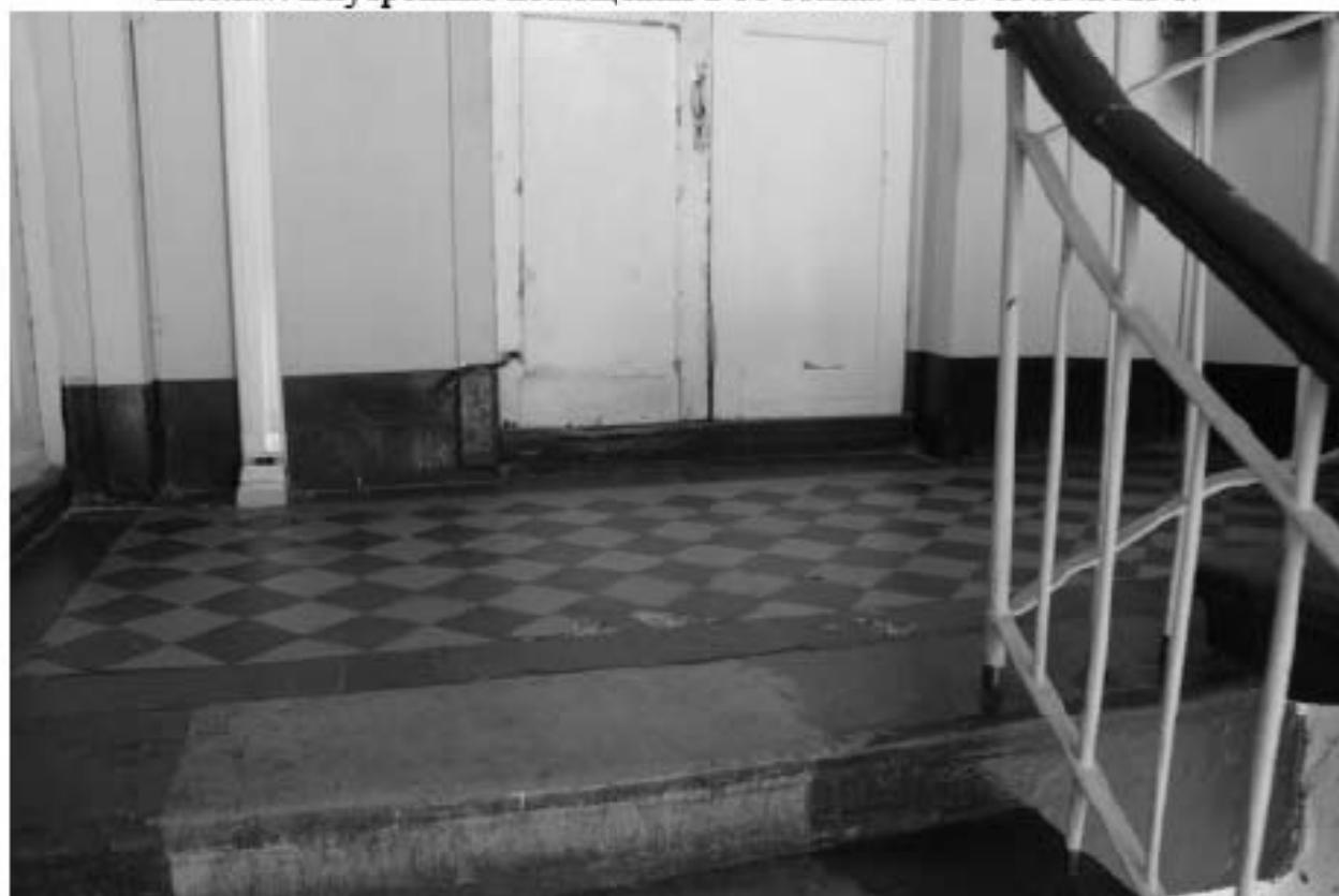
Фото 191. Выявленный объект культурного наследия «Орудийный сарай». Лестница 44-Н. Фото 03.05.2023 г.
