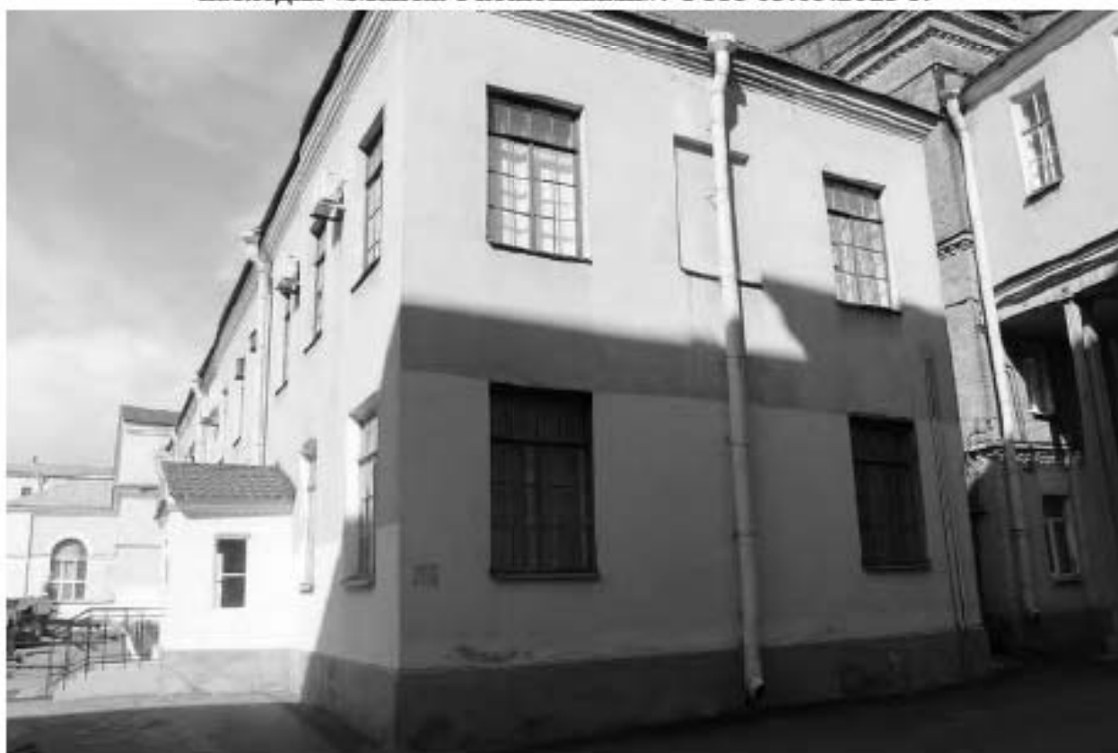
Фото 42. Вид на юго-западное крыло выявленного объекта культурного наследия «Манеж с конюшнями». Фото 03.05.2023 г.
