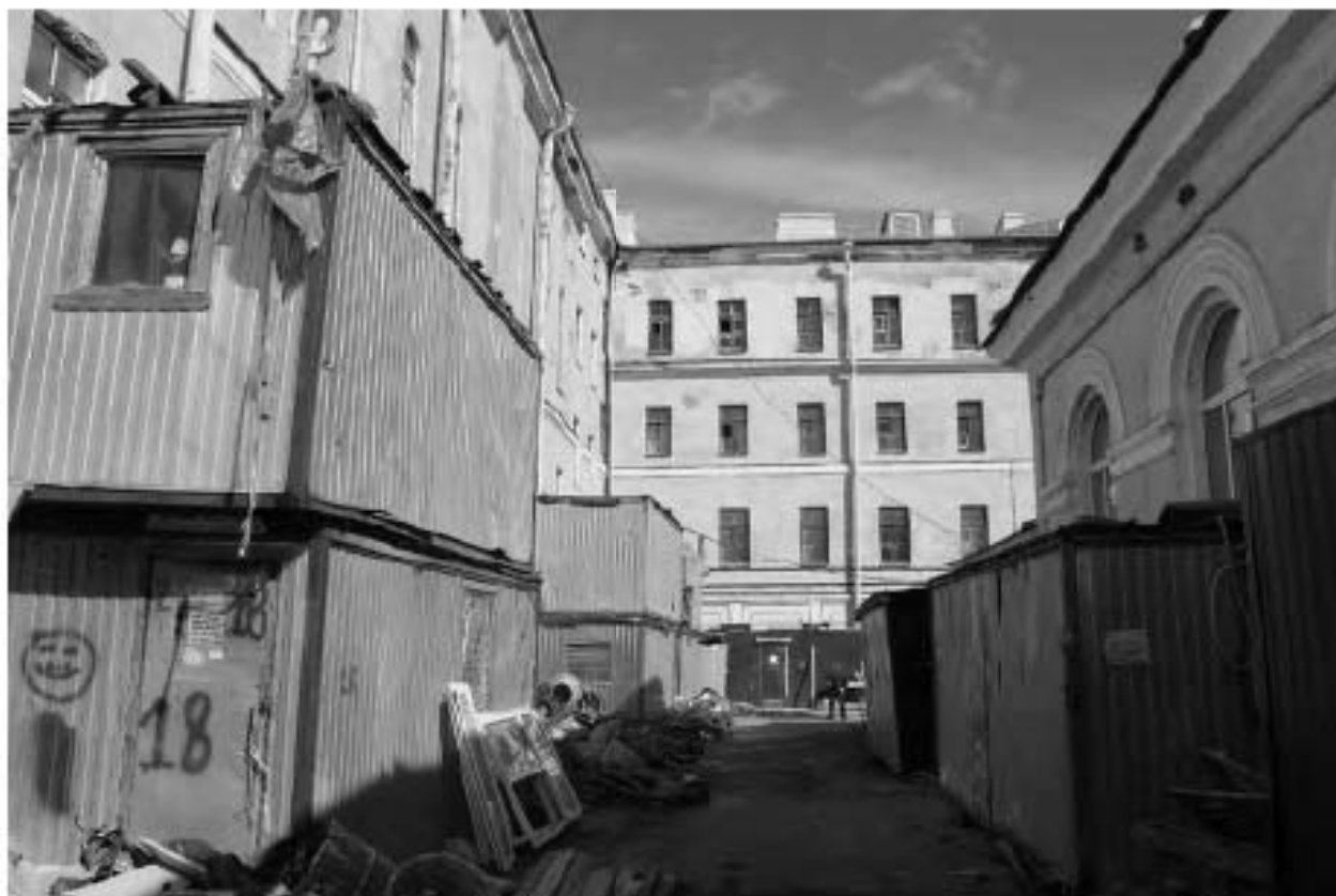
Фото 28. Вид на западный фасад восточного корпуса выявленного объекта культурного наследия «Главный корпус с 1-м солдатским корпусом, офицерским флигелем и Михайловское артиллерийское училище». Фото 03.05.2023 г.
