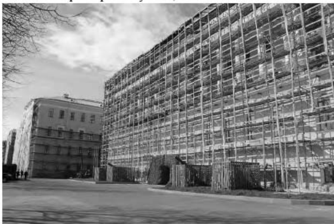
Фото 16. Вид на южный фасад южного корпуса выявленного объекта культурного наследия «Главный корпус с 1-м солдатским корпусом, офицерским флигелем и Михайловское артиллерийское училище». Фото 03.05.2023 г.
