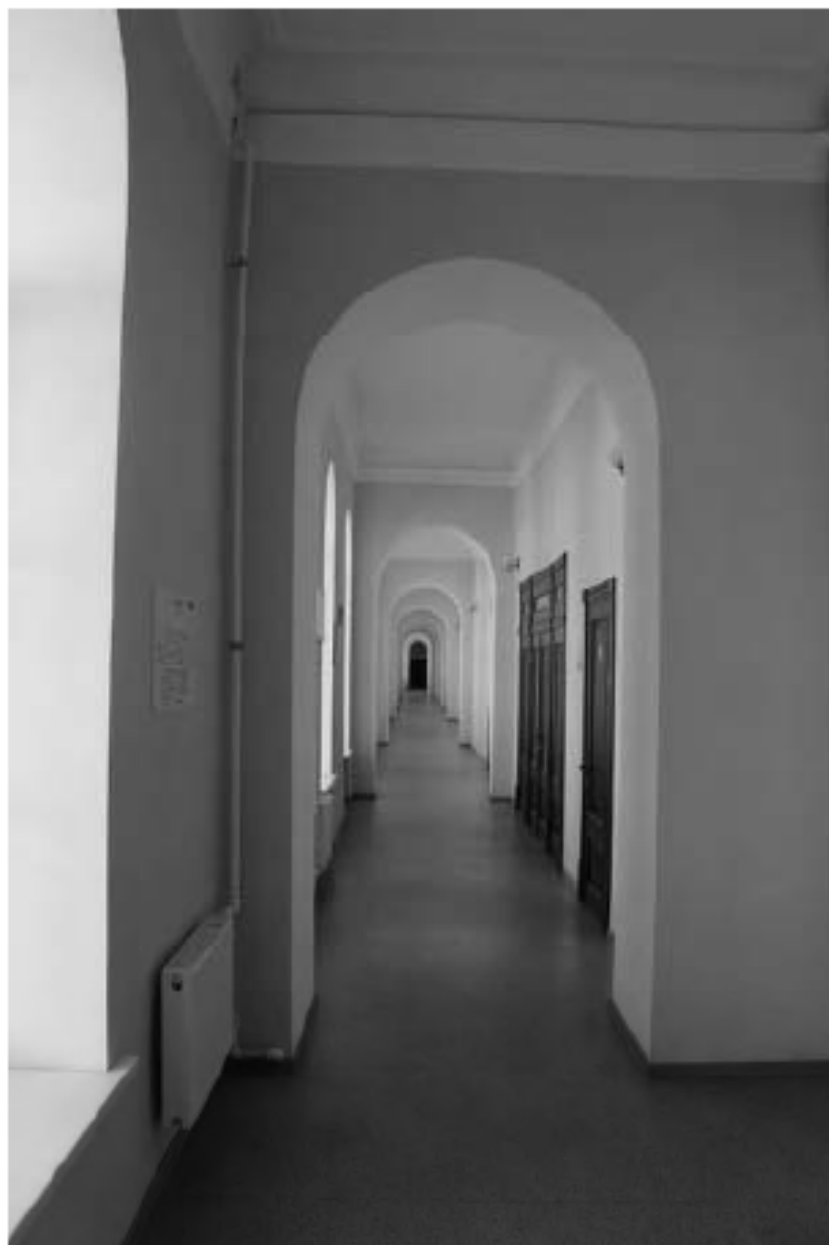
Фото 146. Выявленный объект культурного наследия «Главный корпус с 1-м солдатским корпусом, офицерским флигелем и Михайловское артиллерийское училище». Внутренние помещения 2-го этажа. Фото 03.05.2023 г.
