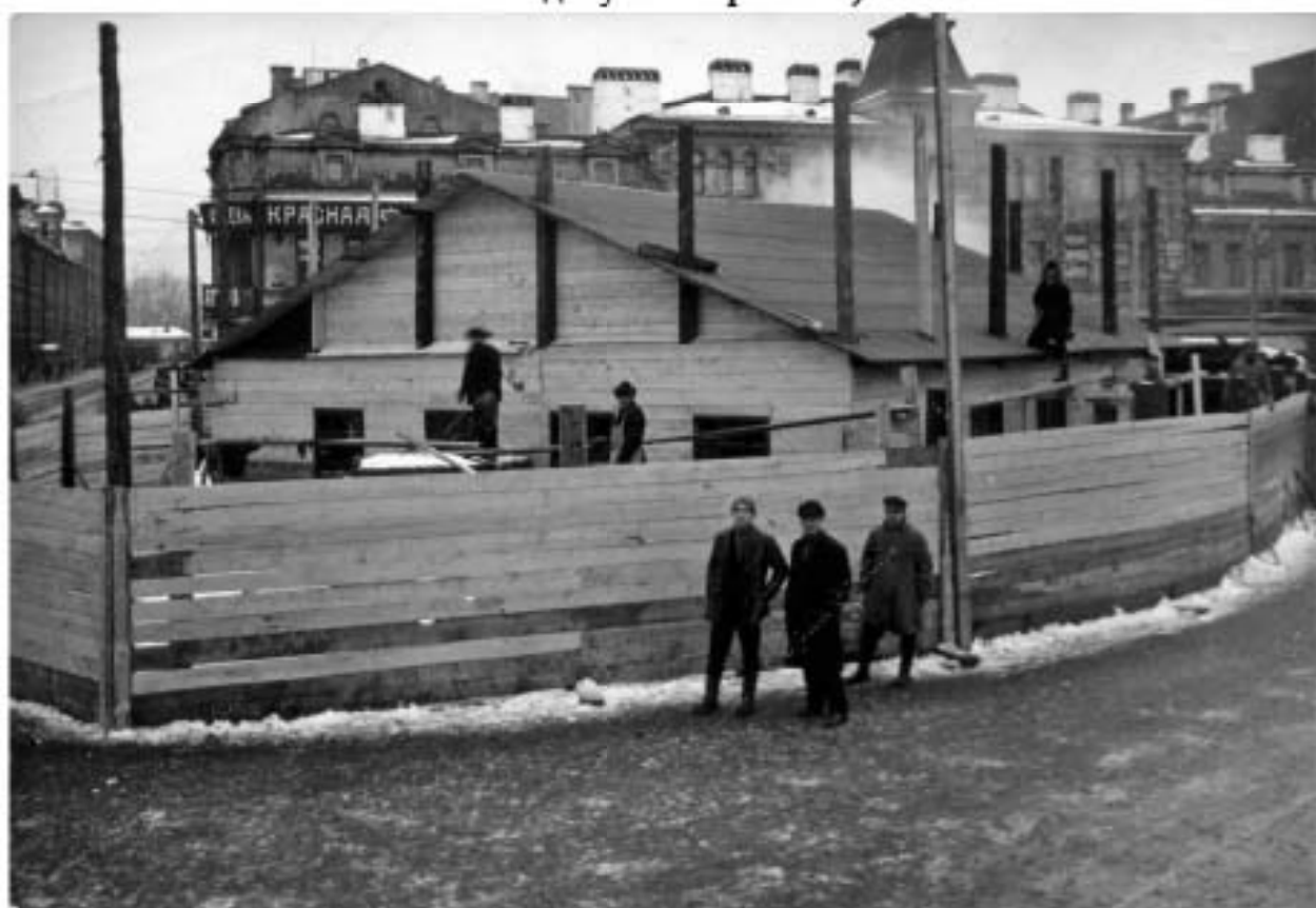
Илл. 68. Сооружение памятника В.И. Ленину. 1925 г. (источник: https://pastvu.com/p/912688 ).
