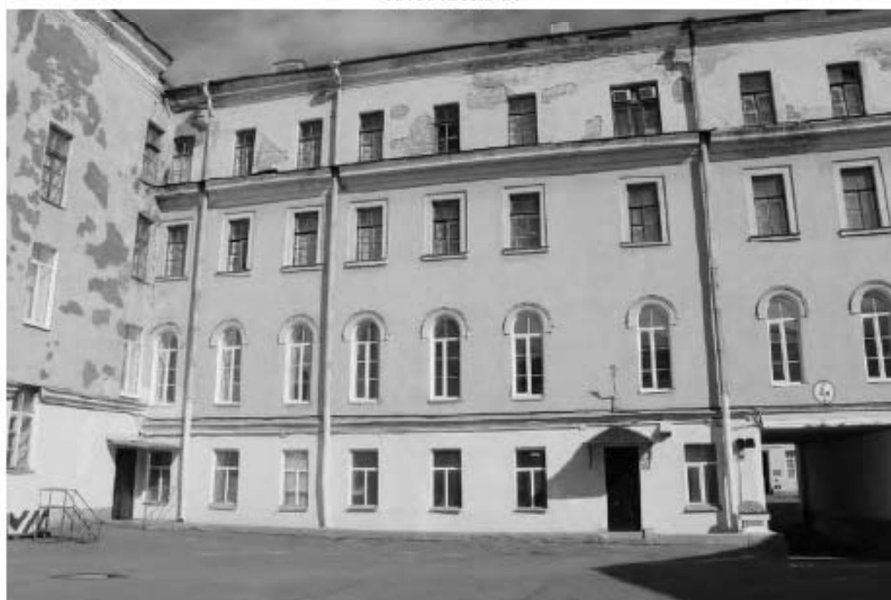
Фото 23. Вид на западный фасад западного корпуса выявленного объекта культурного наследия «Главный корпус с 1-м солдатским корпусом, офицерским флигелем и Михайловское артиллерийское училище». Фото 03.05.2023 г.
