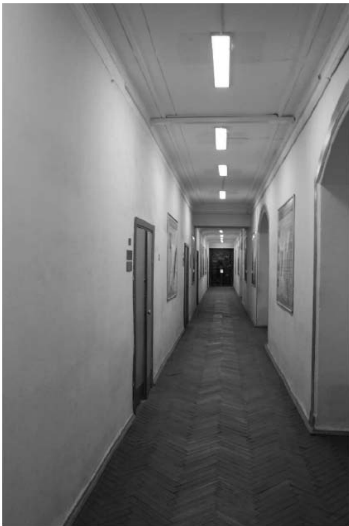
Фото 216. Выявленный объект культурного наследия «Главный корпус с 1-м солдатским корпусом, офицерским флигелем и Михайловское артиллерийское училище». Внутренние помещения 3-го этажа. Фото 03.05.2023 г.
