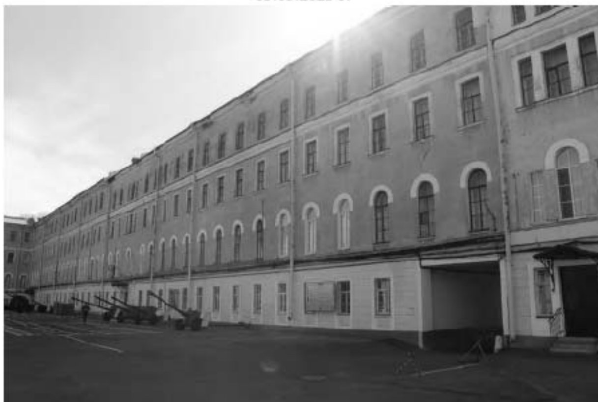
Фото 25. Вид на восточный фасад западного корпуса выявленного объекта культурного наследия «Главный корпус с 1-м солдатским корпусом, офицерским флигелем и Михайловское артиллерийское училище». Фото 03.05.2023 г.
