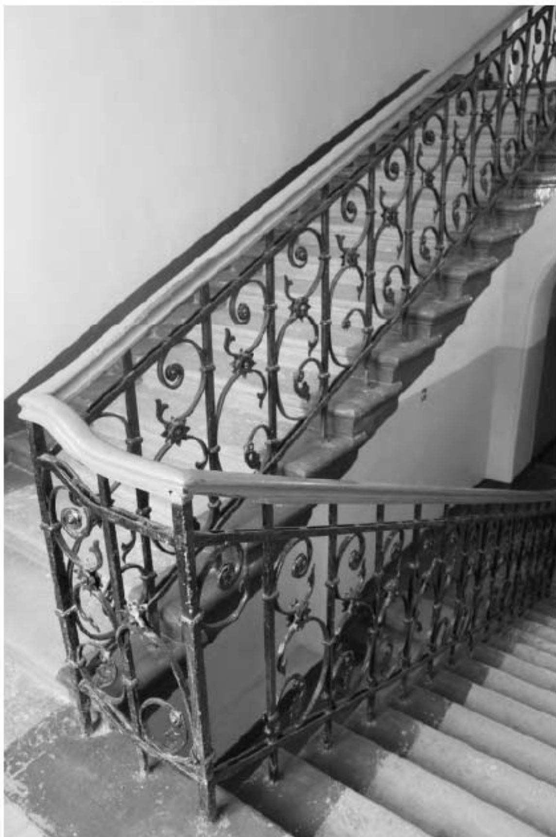
Фото 175. Выявленный объект культурного наследия «Корпус квартир офицеров (угловой)» (объект культурного наследия регионального значения «Академия Михайловская артиллерийская, где преподавали ученые Ленц Э.Х., Остроградский М.В., Петрушевский В.Ф.»). 10ЛК. Фото 03.05.2023 г.
