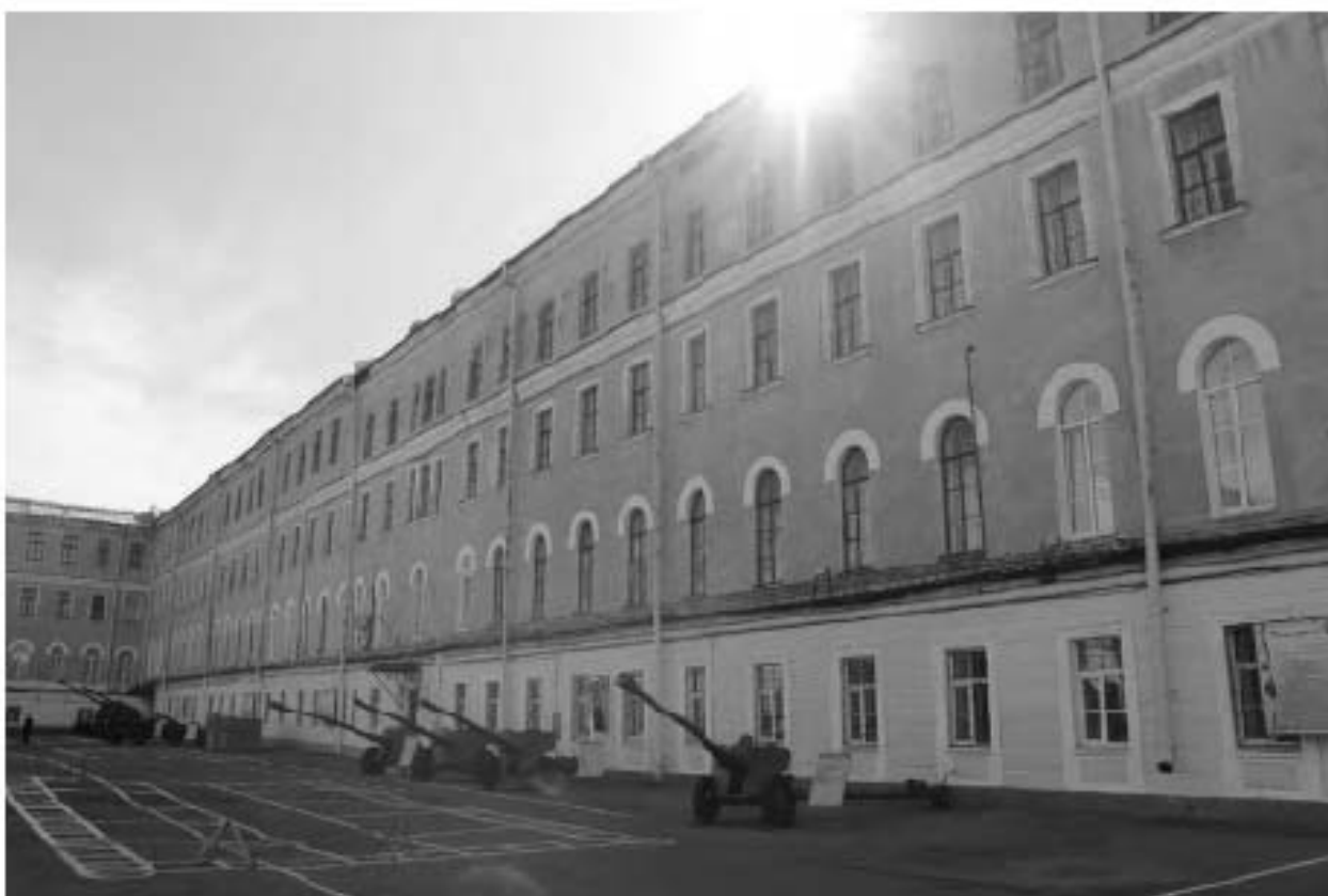
Фото 37. Вид на восточный фасад западного корпуса выявленного объекта культурного наследия «Главный корпус с 1-м солдатским корпусом, офицерским флигелем и Михайловское артиллерийское училище». Фото 03.05.2023 г.
