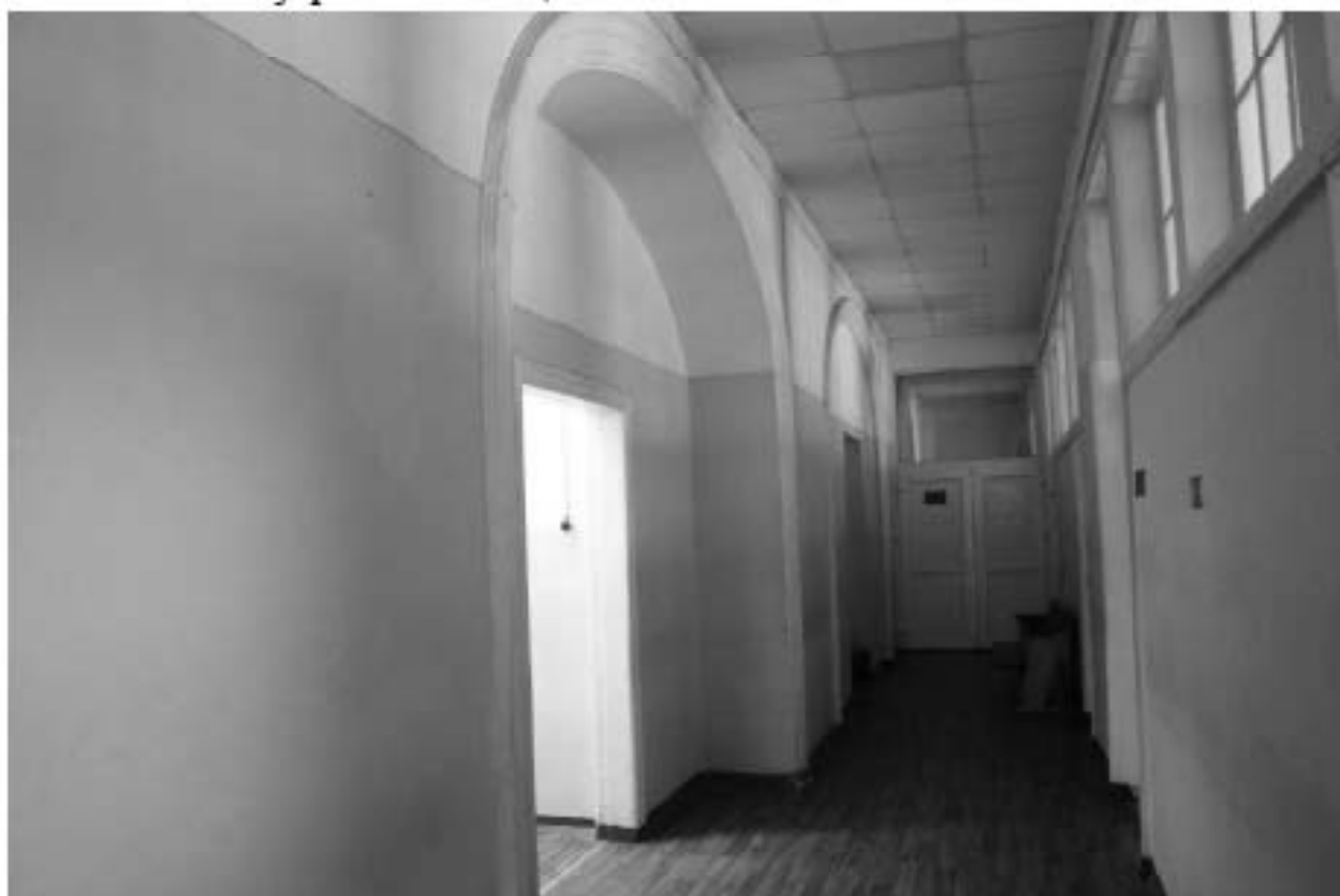
Фото 189. Выявленный объект культурного наследия «Пиротехническая школа». Внутренние помещения 2-го этажа. Фото 03.05.2023 г.
