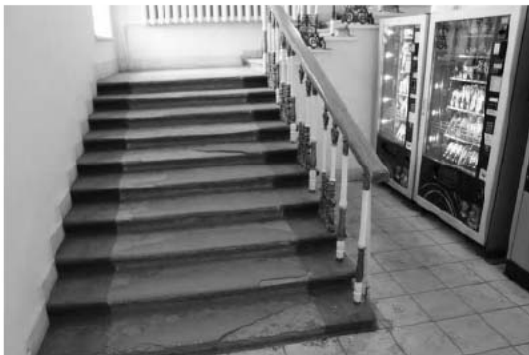
Фото 148. Выявленный объект культурного наследия «Корпус квартир офицеров (угловой)» (объект культурного наследия регионального значения «Академия Михайловская артиллерийская, где преподавали ученые Ленц Э.Х., Остроградский М.В., Петрушевский В.Ф.»). 1ЛК. Фото 03.05.2023 г.
