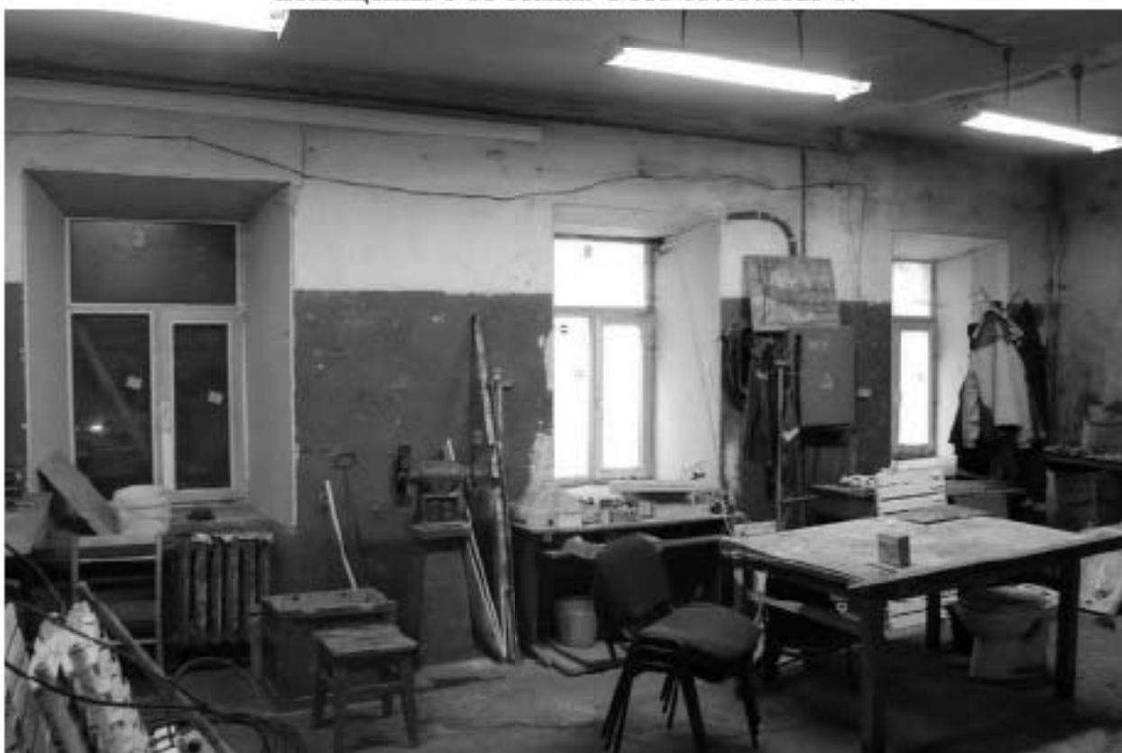
Фото 218. Выявленный объект культурного наследия Баня». Внутренние помещения 1-го этажа. Фото 03.05.2023 г.
