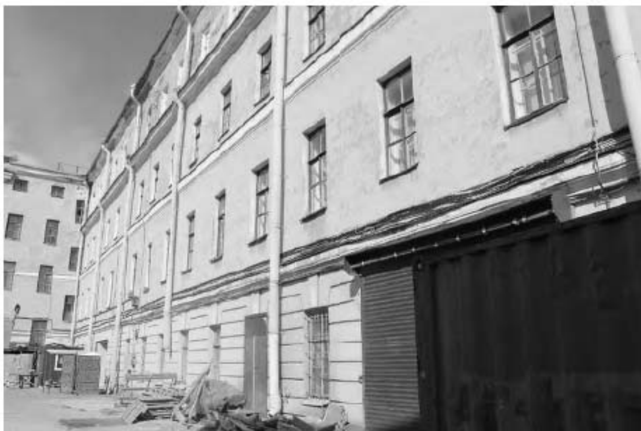
Фото 30. Вид на западный фасад восточного корпуса выявленного объекта культурного наследия «Главный корпус с 1-м солдатским корпусом, офицерским флигелем и Михайловское артиллерийское училище». Фото 03.05.2023 г.
