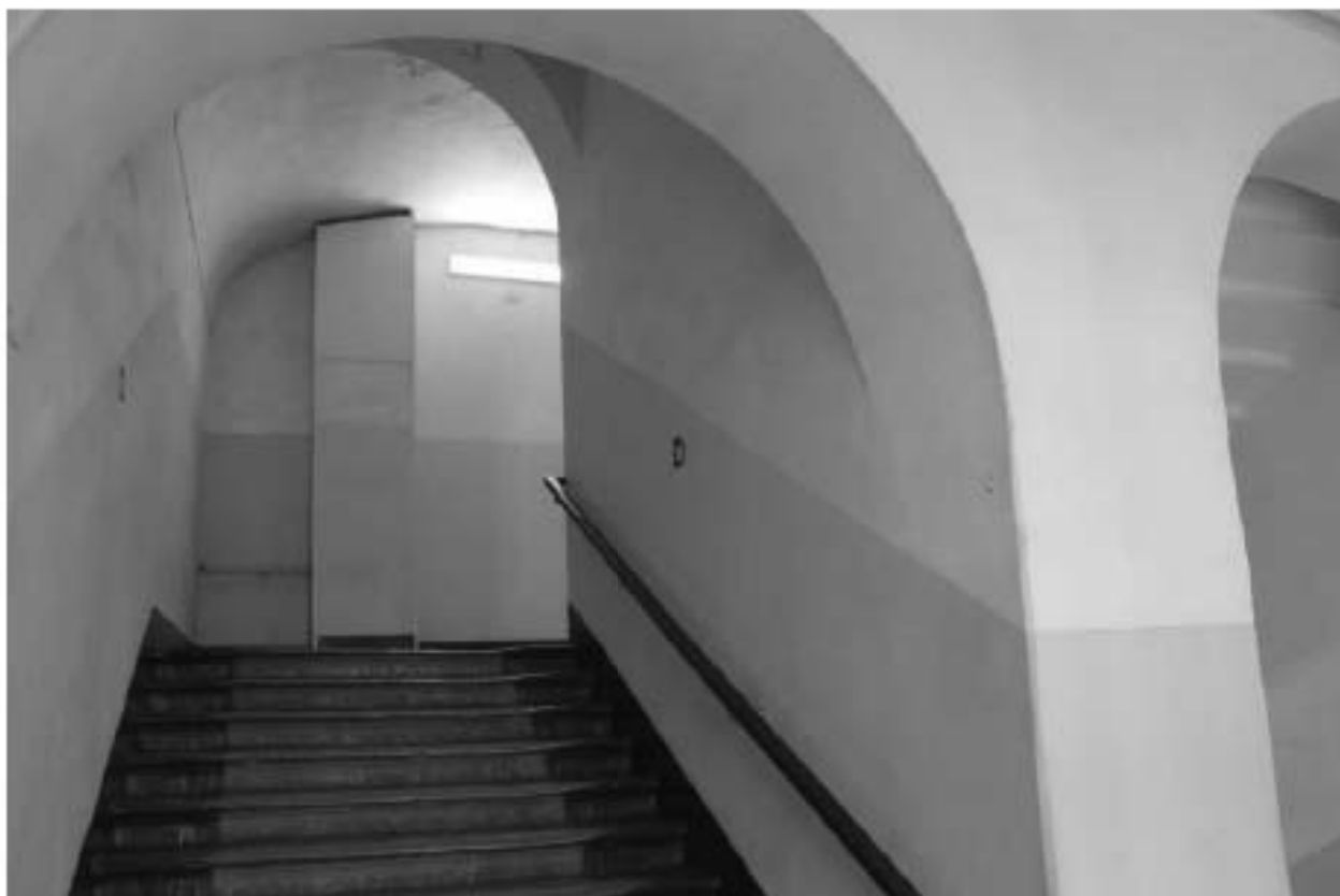
Фото 99. Выявленный объект культурного наследия «Главный корпус с 1-м солдатским корпусом, офицерским флигелем и Михайловское артиллерийское училище». 4ЛК. Фото 03.05.2023 г.
