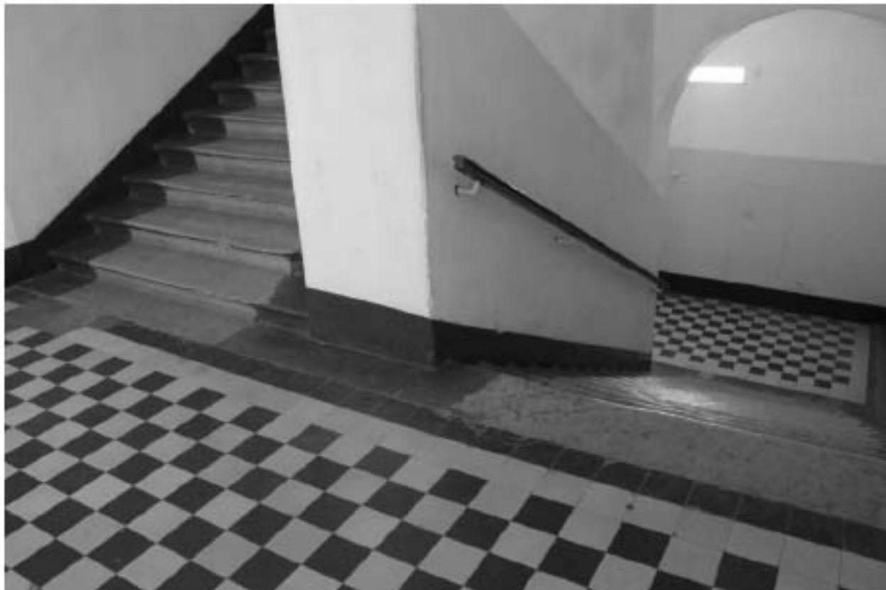
Фото 100. Выявленный объект культурного наследия «Главный корпус с 1-м солдатским корпусом, офицерским флигелем и Михайловское артиллерийское училище». 4ЛК. Фото 03.05.2023 г.
