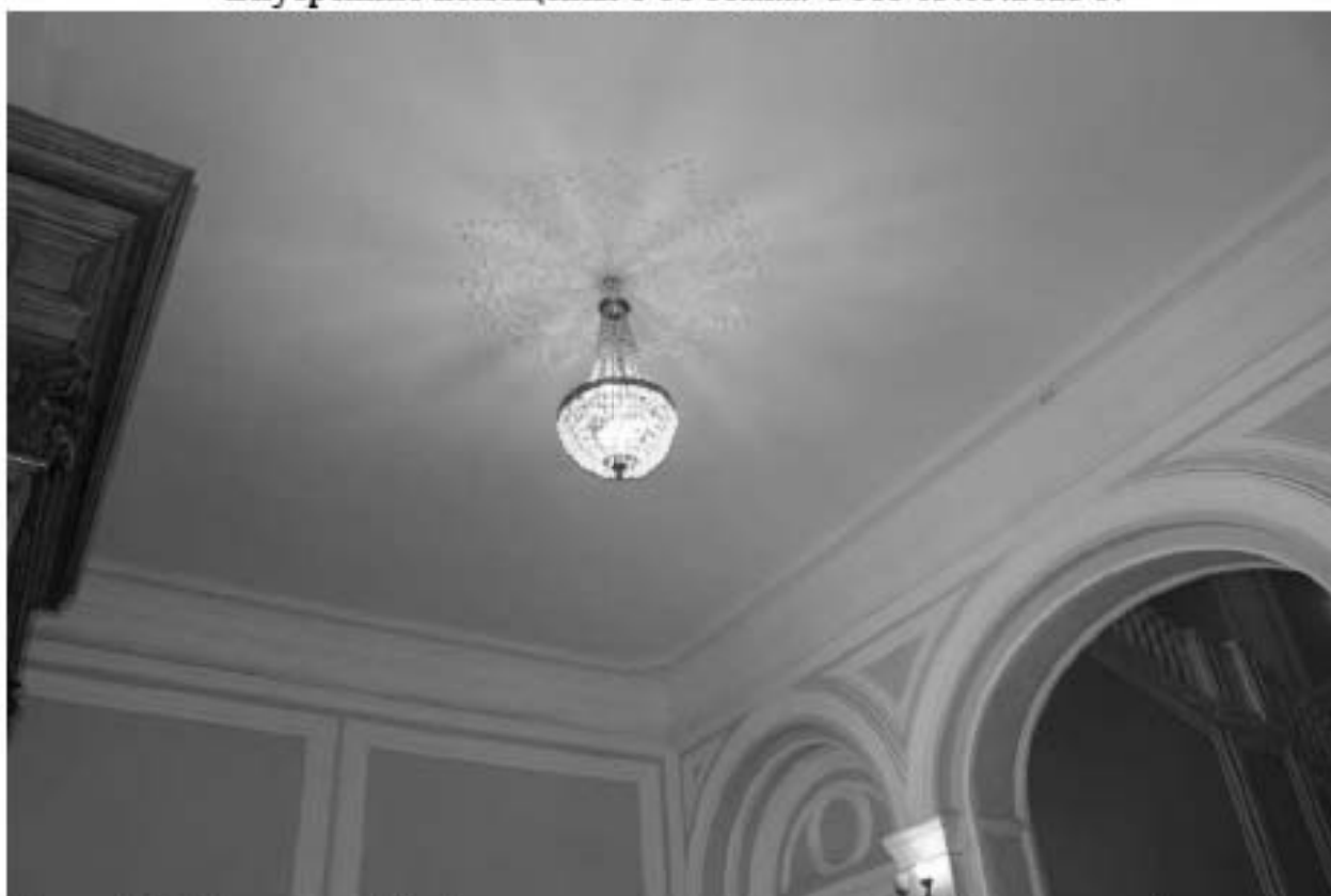
Фото 123. Выявленный объект культурного наследия «Лабораторный корпус». Внутренние помещения 1-го этажа. Фото 03.05.2023 г.
