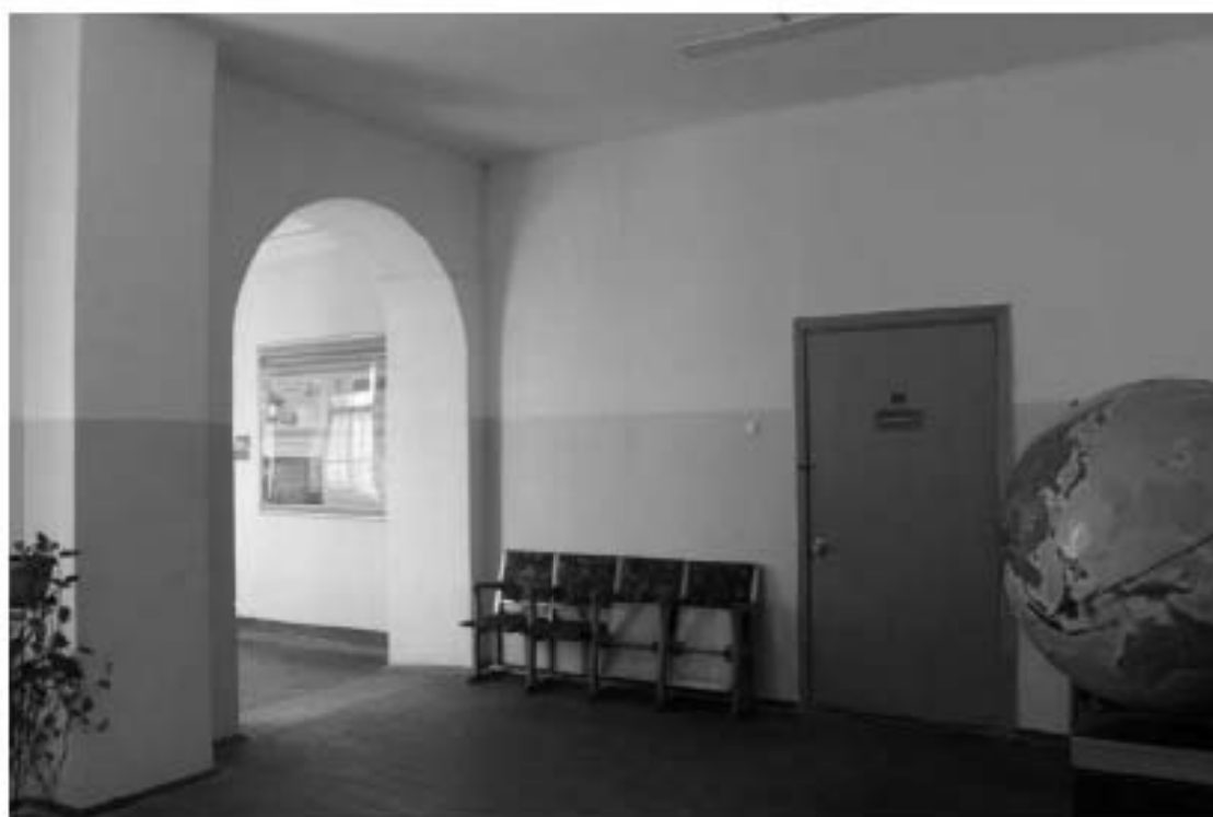
Фото 155. Выявленный объект культурного наследия «Главный корпус с 1-м солдатским корпусом, офицерским флигелем и Михайловское артиллерийское училище». Внутренние помещения 4-го этажа. Фото 03.05.2023 г.
