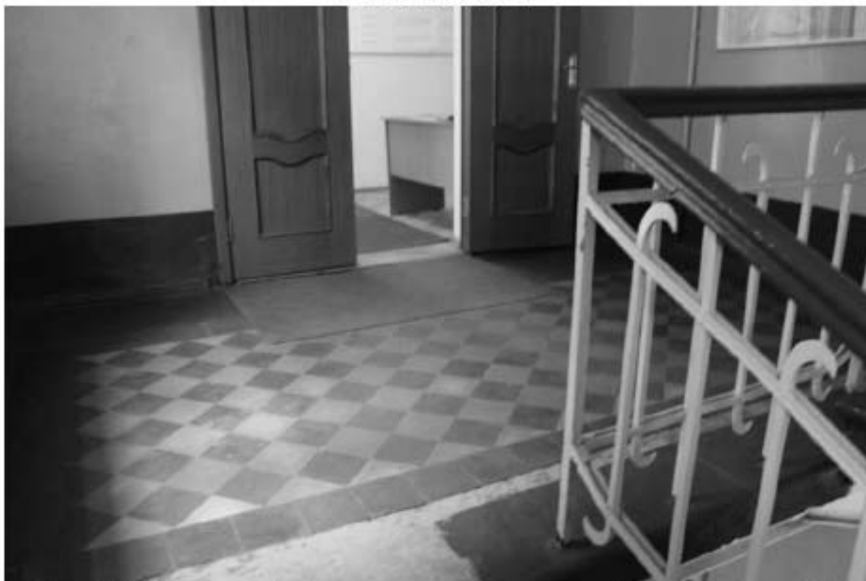
Фото 222. Выявленный объект культурного наследия «Баня». Лестница 2-Н. Фото 03.05.2023 г.
