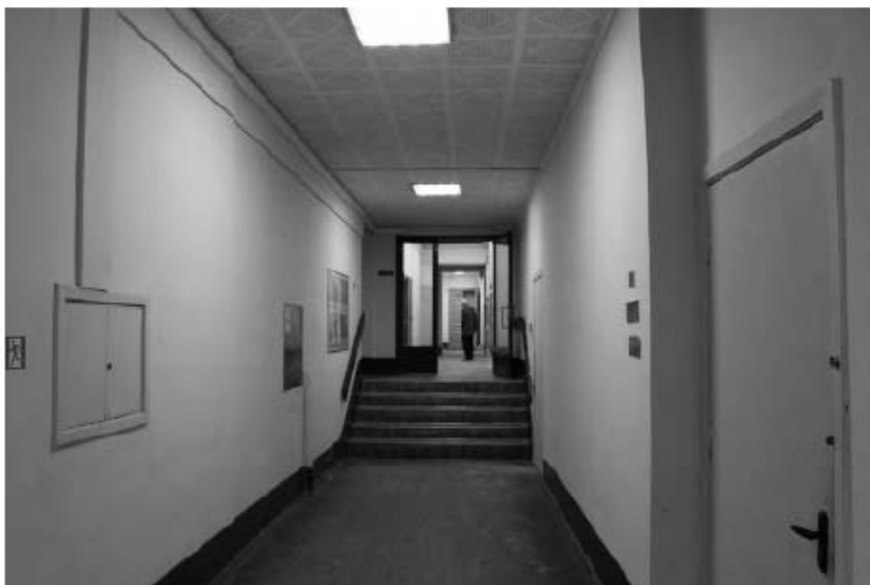
Фото 154. Выявленный объект культурного наследия «Корпус квартир офицеров (угловой)» (объект культурного наследия регионального значения «Академия Михайловская артиллерийская, где преподавали ученые Ленц Э.Х., Остроградский М.В., Петрушевский В.Ф.»). Внутренние помещения 4-го этажа. Фото 03.05.2023 г.
