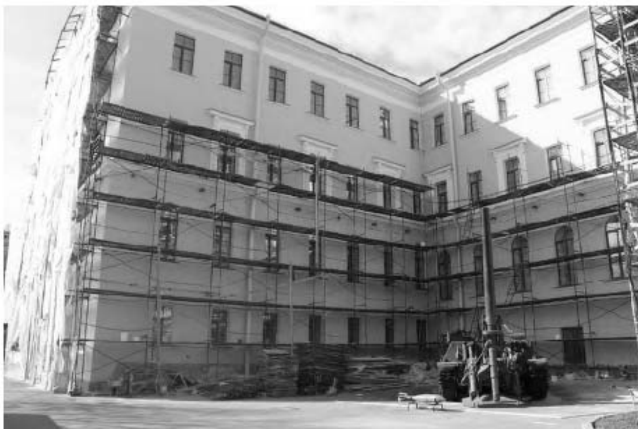
Фото 17. Вид на восточный фасад западного корпуса и южный фасад южного корпуса выявленного объекта культурного наследия «Главный корпус с 1-м солдатским корпусом, офицерским флигелем и Михайловское артиллерийское училище». Фото 03.05.2023 г.
