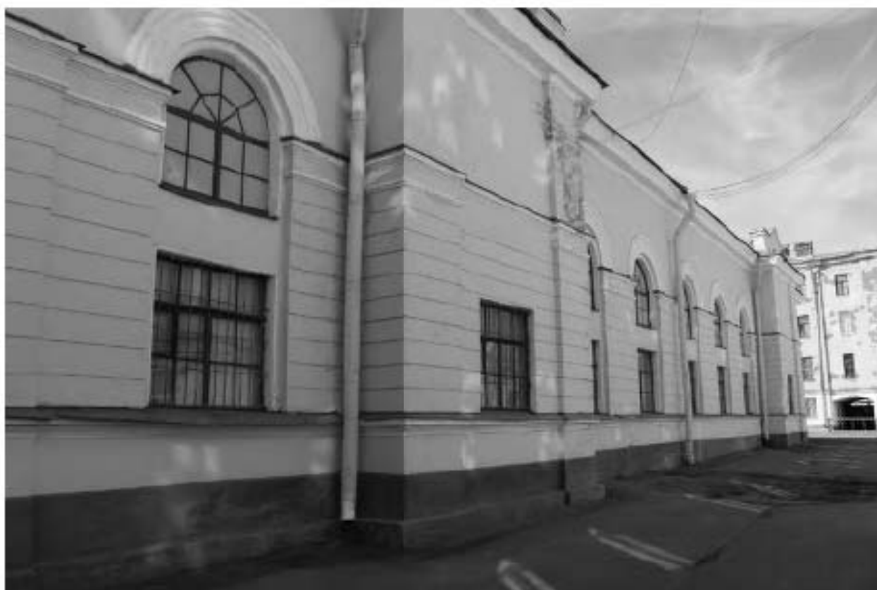
Фото 71. Вид на восточный фасад выявленного объекта культурного наследия «Экипажный сарай с конюшнями». Фото 03.05.2023 г.
