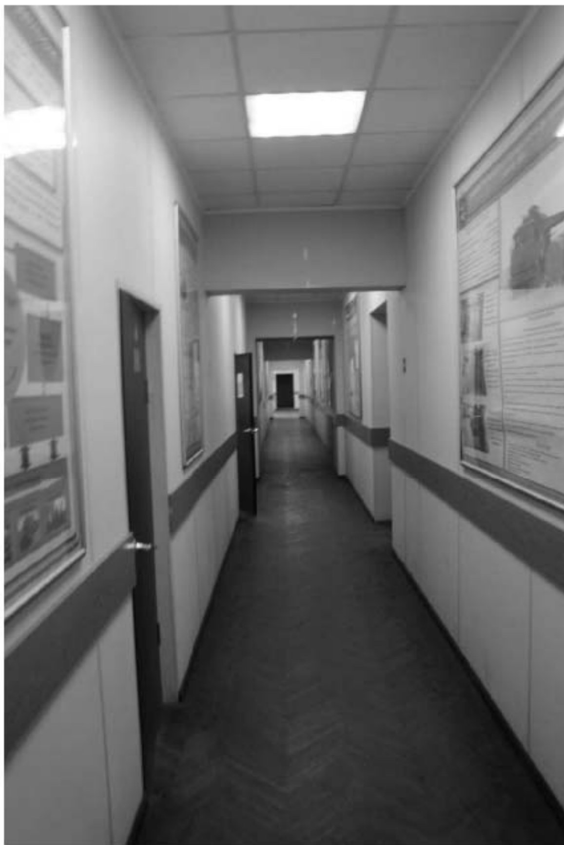
Фото 102. Выявленный объект культурного наследия «Главный корпус с 1-м солдатским корпусом, офицерским флигелем и Михайловское артиллерийское училище». Внутренние помещения 2-го этажа. Фото 03.05.2023 г.
