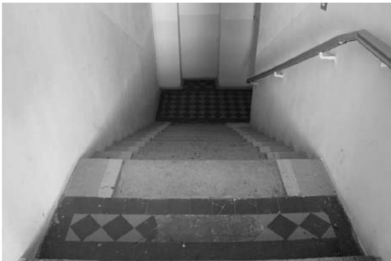
Фото 145. Выявленный объект культурного наследия «Главный корпус с 1-м солдатским корпусом, офицерским флигелем и Михайловское артиллерийское училище». 8ЛК. Фото 03.05.2023 г.
