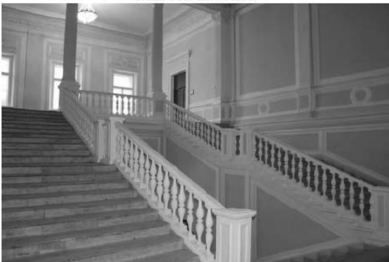
Фото 126. Выявленный объект культурного наследия «Лабораторный корпус». 15ЛК. Фото 03.05.2023 г.
