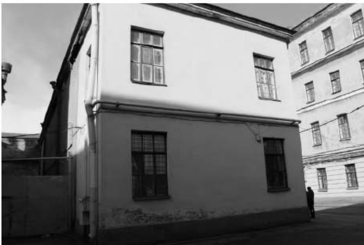
Фото 43. Вид на юго-восточное крыло выявленного объекта культурного наследия «Манеж с конюшнями». Фото 03.05.2023 г.
