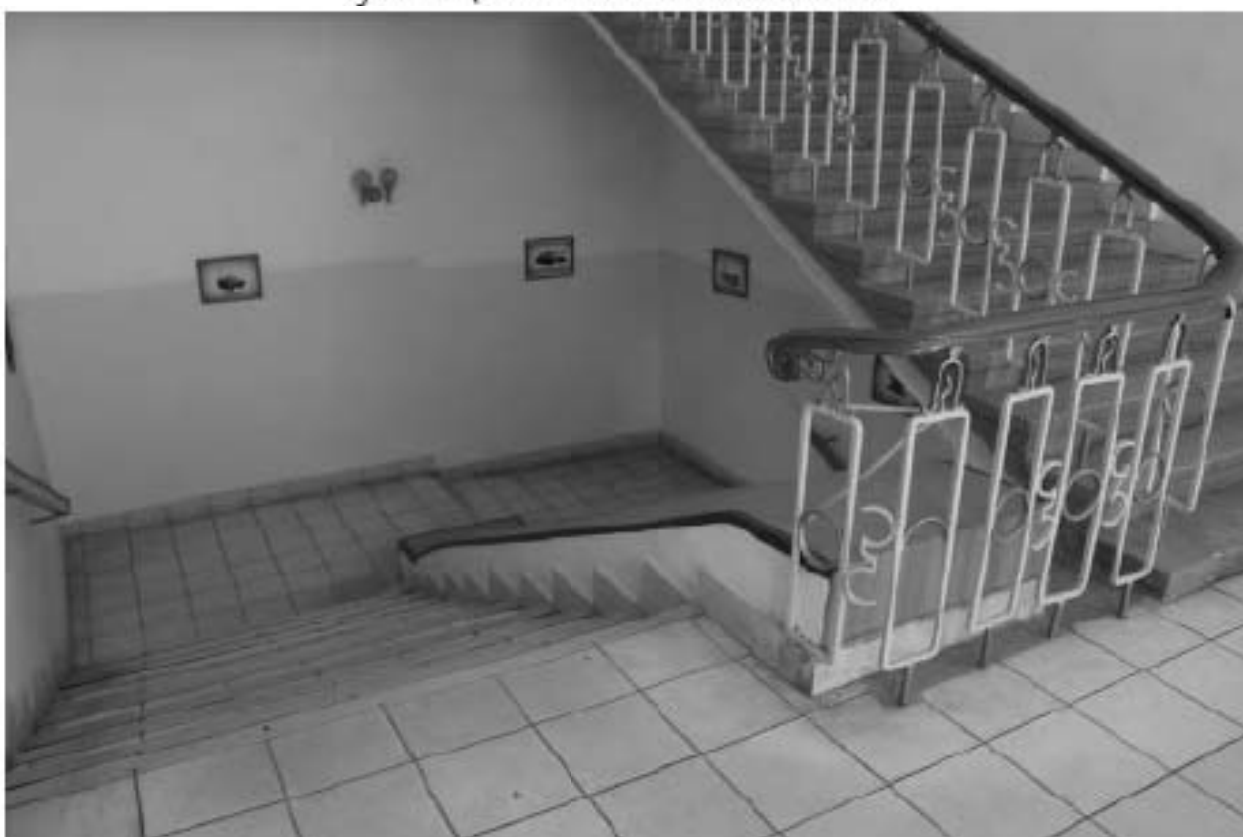
Фото 116. Выявленный объект культурного наследия «Главный корпус с 1-м солдатским корпусом, офицерским флигелем и Михайловское артиллерийское училище». 7ЛК. Фото 03.05.2023 г.
