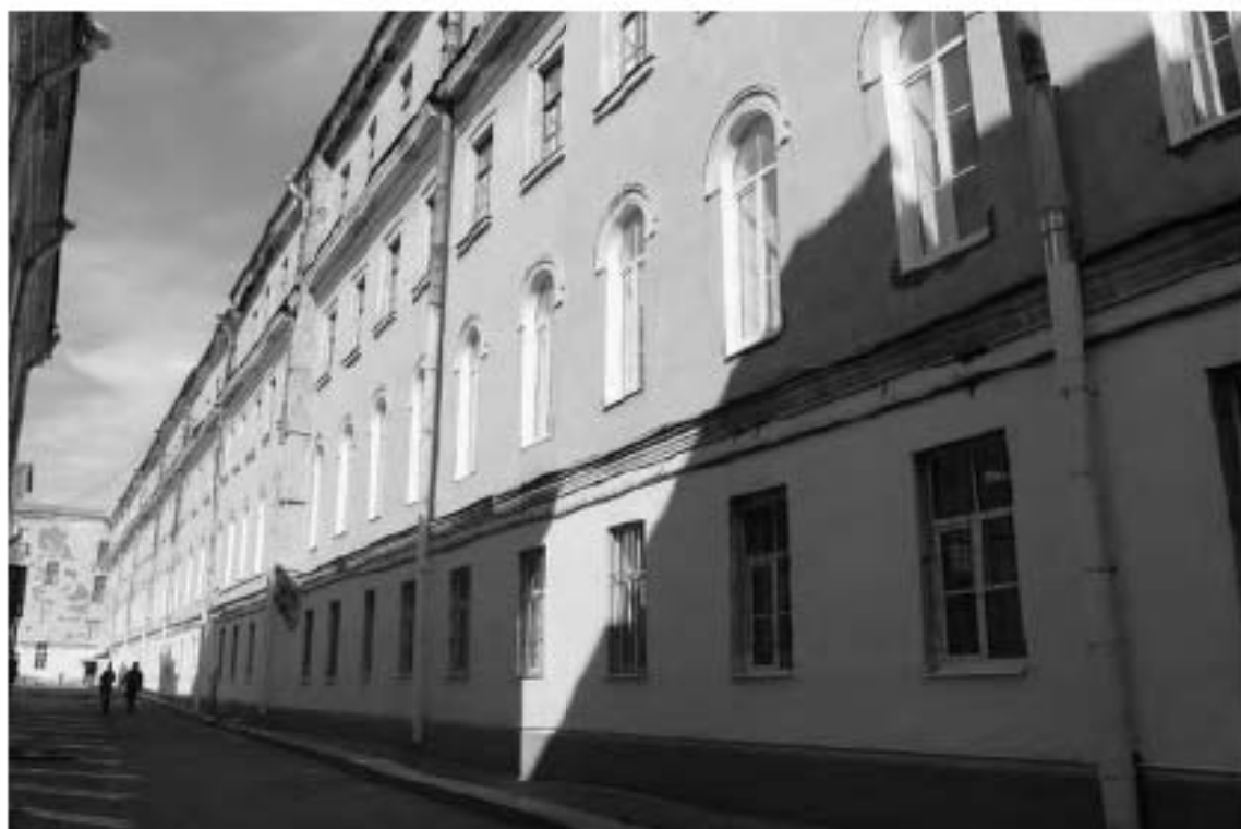
Фото 21. Вид на западный фасад западного корпуса выявленного объекта культурного наследия «Главный корпус с 1-м солдатским корпусом, офицерским флигелем и Михайловское артиллерийское училище». Фото 03.05.2023 г.
