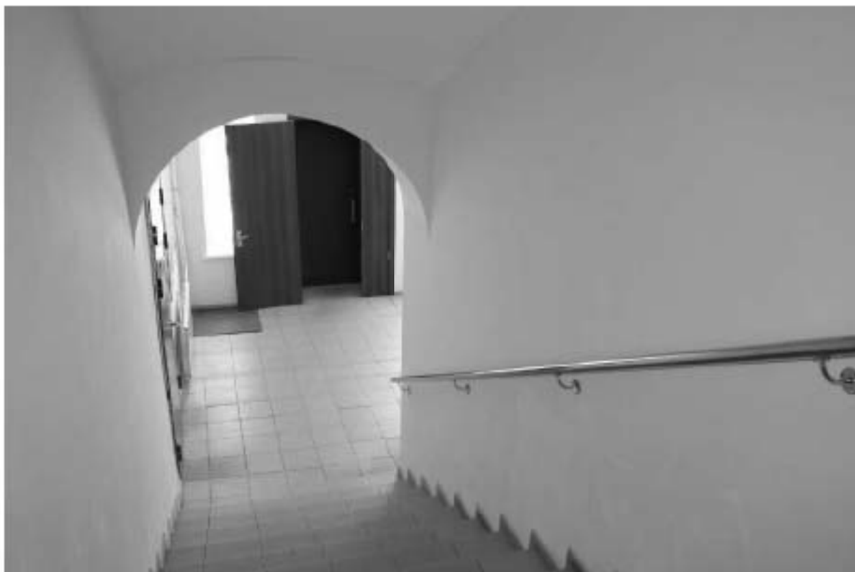
Фото 140. Выявленный объект культурного наследия «Главный корпус с 1-м солдатским корпусом, офицерским флигелем и Михайловское артиллерийское училище». 8ЛК. Фото 03.05.2023 г.
