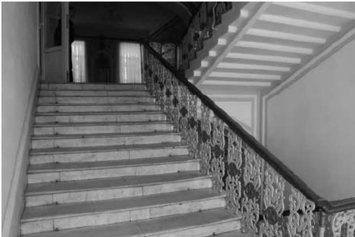
Фото 76. Выявленный объект культурного наследия «Главный корпус с 1-м солдатским корпусом, офицерским флигелем и Михайловское артиллерийское училище». 2ЛК. Фото 03.05.2023 г.
