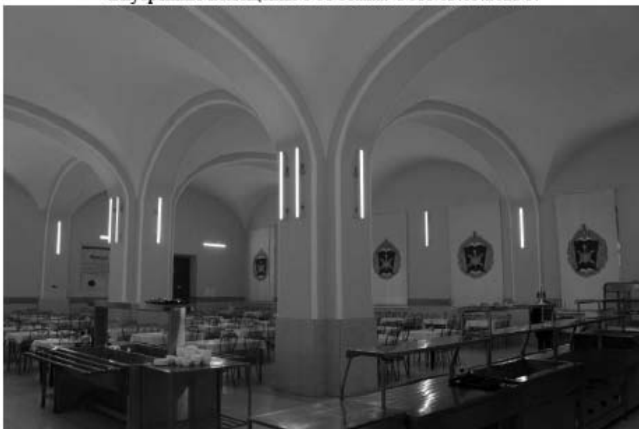
Фото 133. Выявленный объект культурного наследия «Лабораторный корпус». Внутренние помещения 1-го этажа. Фото 03.05.2023 г.
