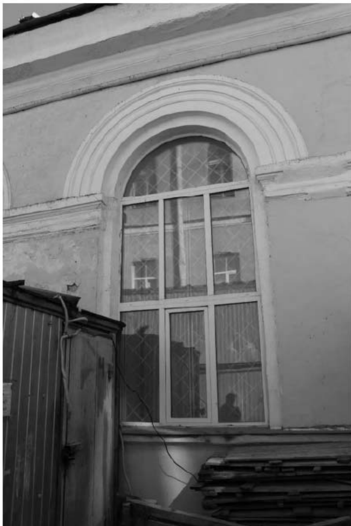
Фото 49. Вид на оконный проем северного фасада выявленного объекта культурного наследия «Малый манеж». Фото 03.05.2023 г.
