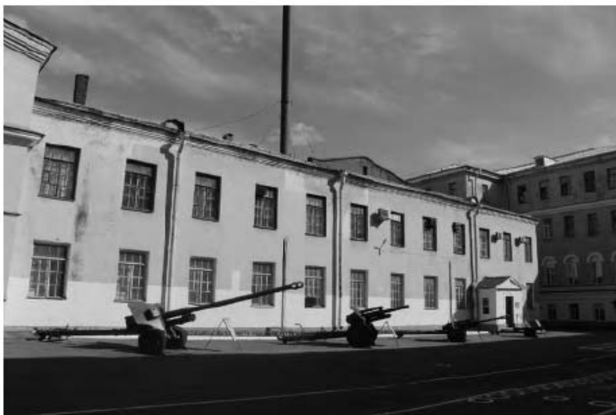
Фото 41. Вид на юго-западное крыло выявленного объекта культурного наследия «Манеж с конюшнями». Фото 03.05.2023 г.
