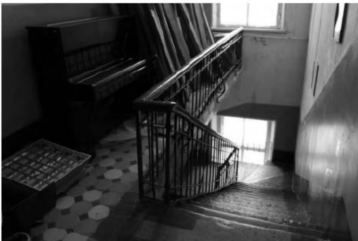
Фото 215. Выявленный объект культурного наследия «Лабораторный корпус». Лестница 99-Н. Фото 03.05.2023 г.
