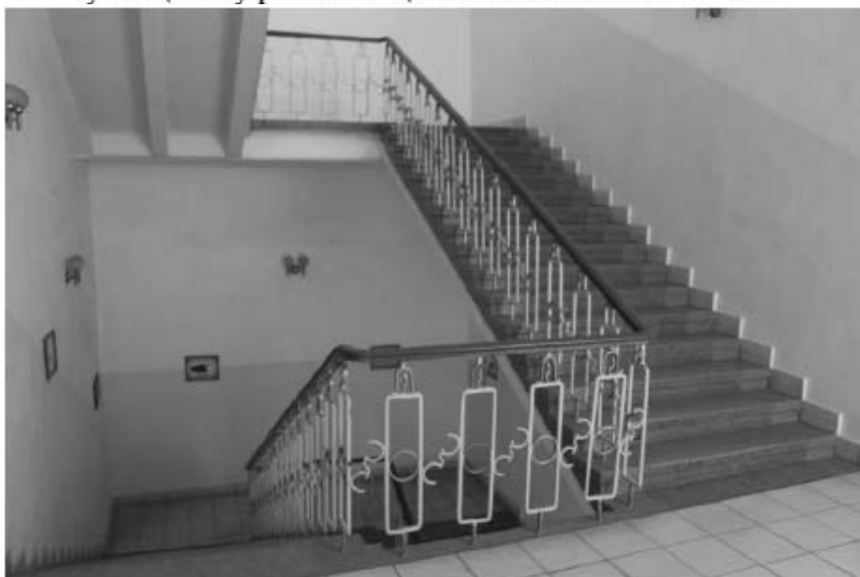
Фото 114. Выявленный объект культурного наследия «Главный корпус с 1-м солдатским корпусом, офицерским флигелем и Михайловское артиллерийское училище». 7ЛК. Фото 03.05.2023 г.
