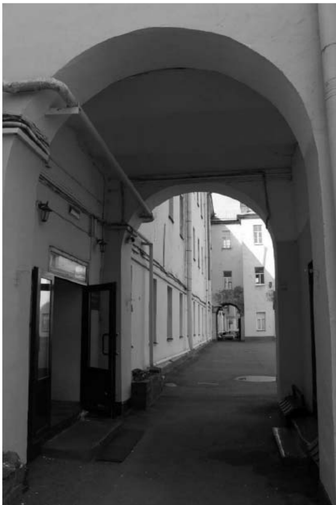
Фото 59. Вид на арку центрального дворового объема и восточный фасад выявленного объекта культурного наследия «Пиротехническая школа». Фото 03.05.2023 г.
