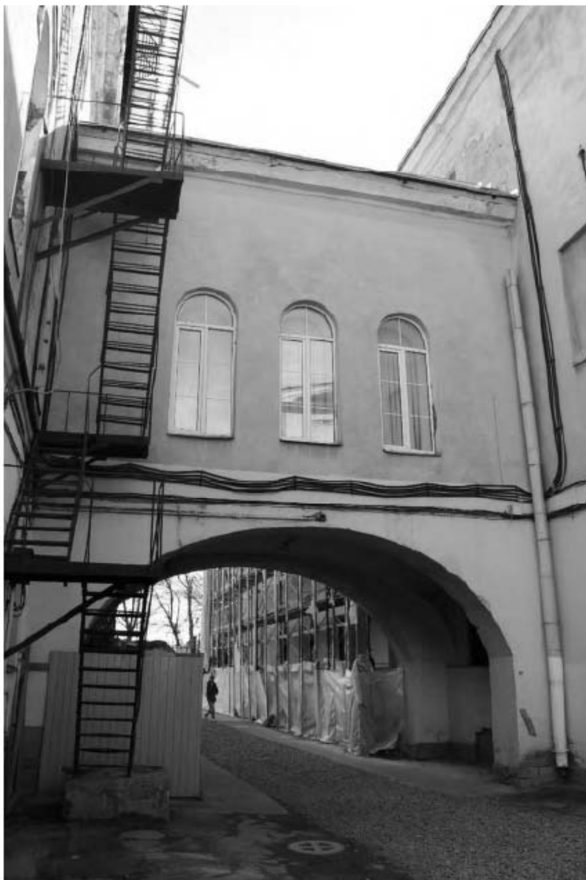
Фото 19. Вид на надземный переход между западным корпусом выявленного объекта культурного наследия «Главный корпус с 1-м солдатским корпусом, офицерским флигелем и Михайловское артиллерийское училище» и выявленным объектом культурного наследия «Лабораторный корпус». Фото 03.05.2023 г.
