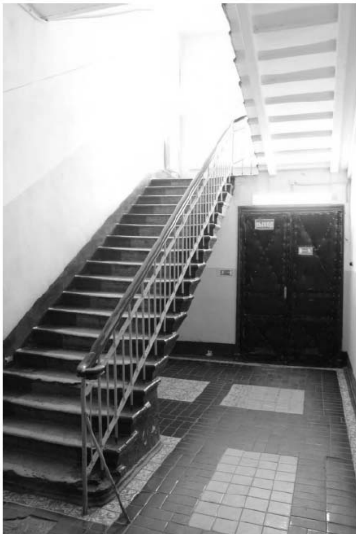
Фото 181. Выявленный объект культурного наследия «Орудийный сарай». Лестница 44-Н. Фото 03.05.2023 г.
