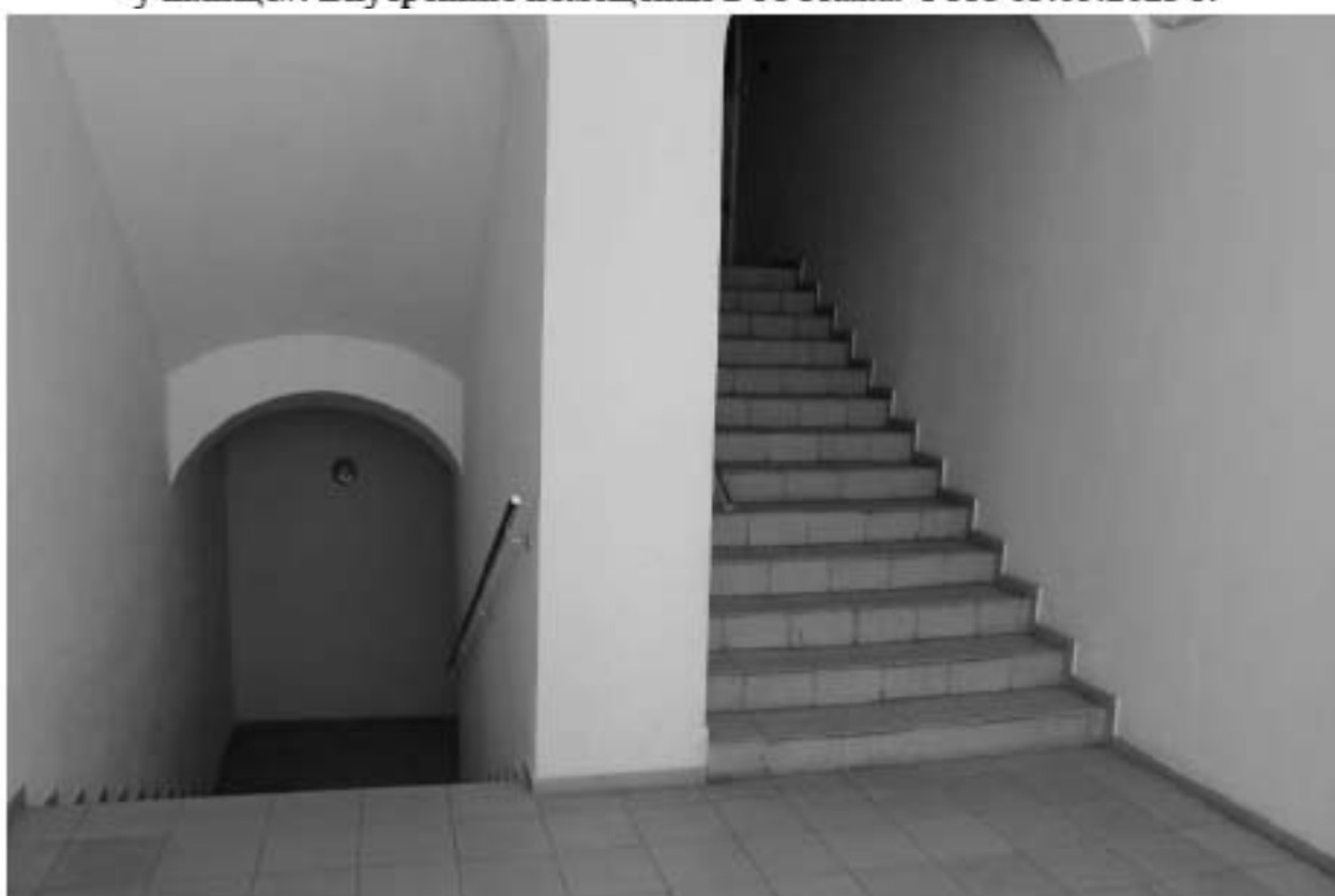
Фото 139. Выявленный объект культурного наследия «Главный корпус с 1-м солдатским корпусом, офицерским флигелем и Михайловское артиллерийское училище». 8ЛК. Фото 03.05.2023 г.
