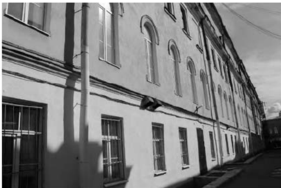
Фото 22. Вид на западный фасад западного корпуса выявленного объекта культурного наследия «Главный корпус с 1-м солдатским корпусом, офицерским флигелем и Михайловское артиллерийское училище». Фото 03.05.2023 г.
