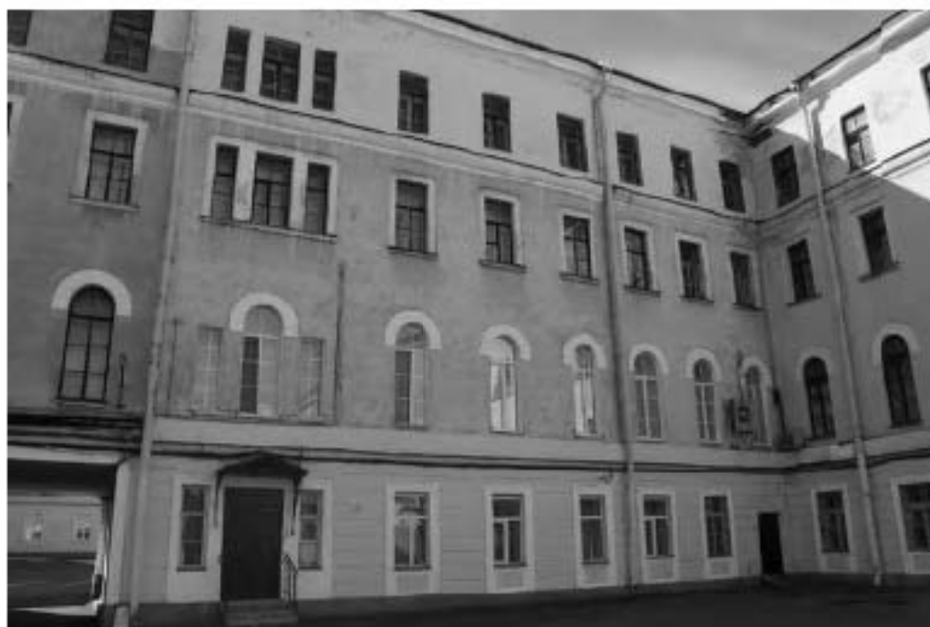
Фото 26. Вид на восточный фасад западного корпуса выявленного объекта культурного наследия «Главный корпус с 1-м солдатским корпусом, офицерским флигелем и Михайловское артиллерийское училище». Фото 03.05.2023 г.
