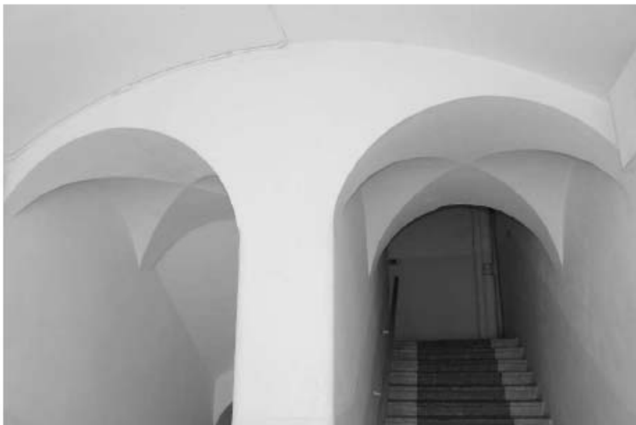
Фото 142. Выявленный объект культурного наследия «Главный корпус с 1-м солдатским корпусом, офицерским флигелем и Михайловское артиллерийское училище». 8ЛК. Фото 03.05.2023 г.
