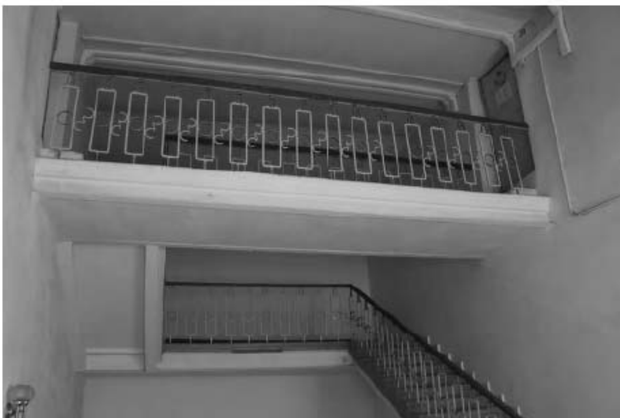
Фото 115. Выявленный объект культурного наследия «Главный корпус с 1-м солдатским корпусом, офицерским флигелем и Михайловское артиллерийское училище». 7ЛК. Фото 03.05.2023 г.
