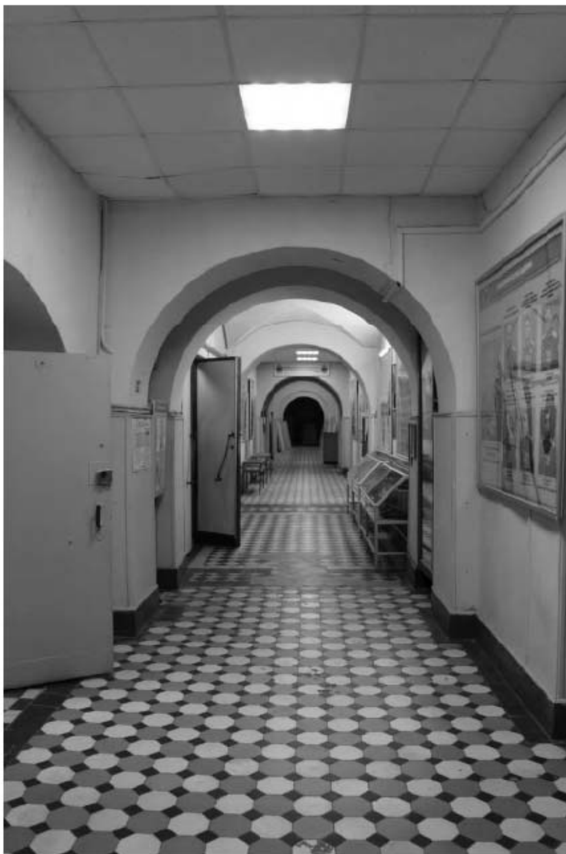
Фото 92. Выявленный объект культурного наследия «Главный корпус с 1-м солдатским корпусом, офицерским флигелем и Михайловское артиллерийское училище». Внутренние помещения 1-го этажа. Фото 03.05.2023 г.
