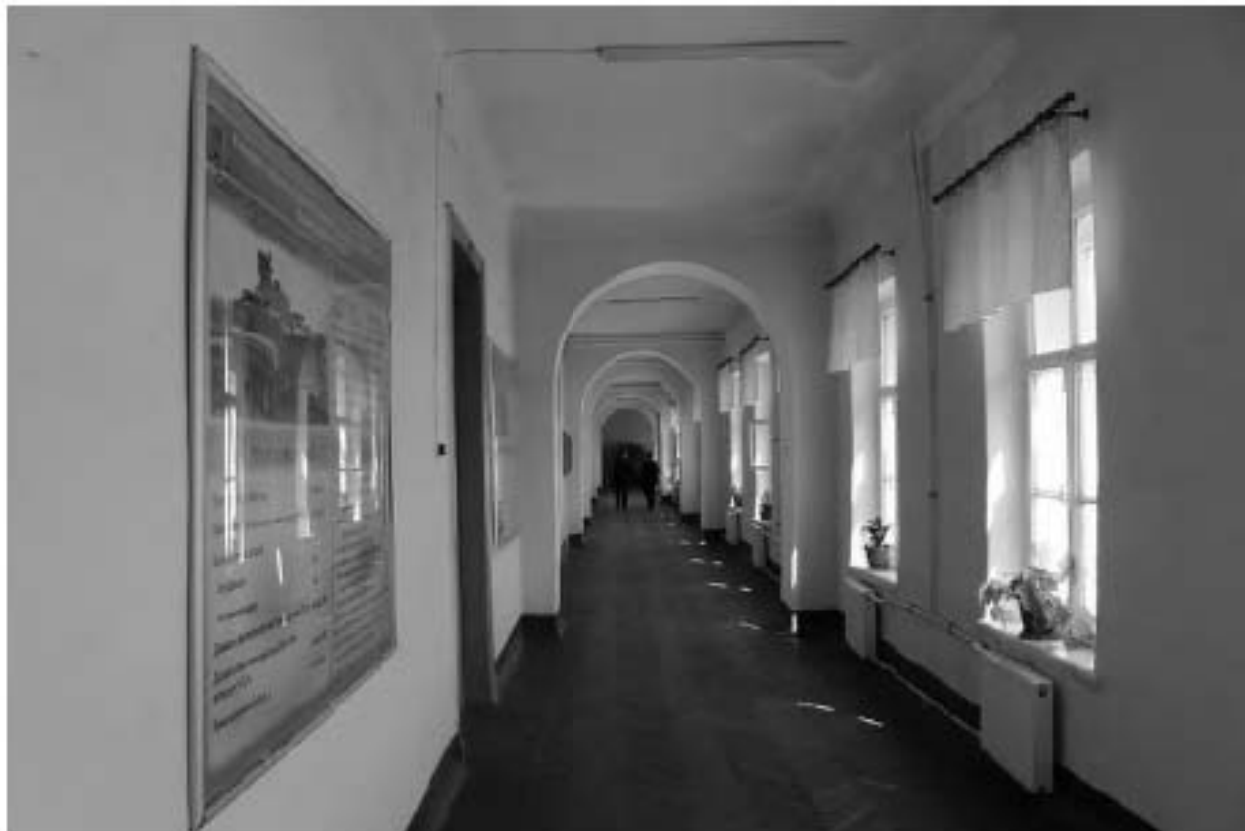
Фото 157. Выявленный объект культурного наследия «Главный корпус с 1-м солдатским корпусом, офицерским флигелем и Михайловское артиллерийское училище». Внутренние помещения 4-го этажа. Фото 03.05.2023 г.
