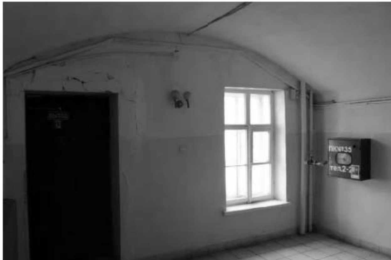
Фото 118. Выявленный объект культурного наследия «Главный корпус с 1-м солдатским корпусом, офицерским флигелем и Михайловское артиллерийское училище». 7ЛК. Фото 03.05.2023 г.
