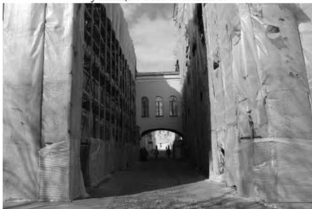
Фото 18. Вид на надземный переход между западным корпусом выявленного объекта культурного наследия «Главный корпус с 1-м солдатским корпусом, офицерским флигелем и Михайловское артиллерийское училище» и выявленным объектом культурного наследия «Лабораторный корпус». Фото 03.05.2023 г.
