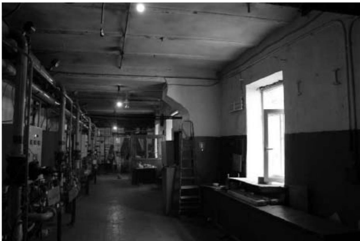
Фото 219. Выявленный объект культурного наследия «Баня». Внутренние помещения 1-го этажа. Фото 03.05.2023 г.
