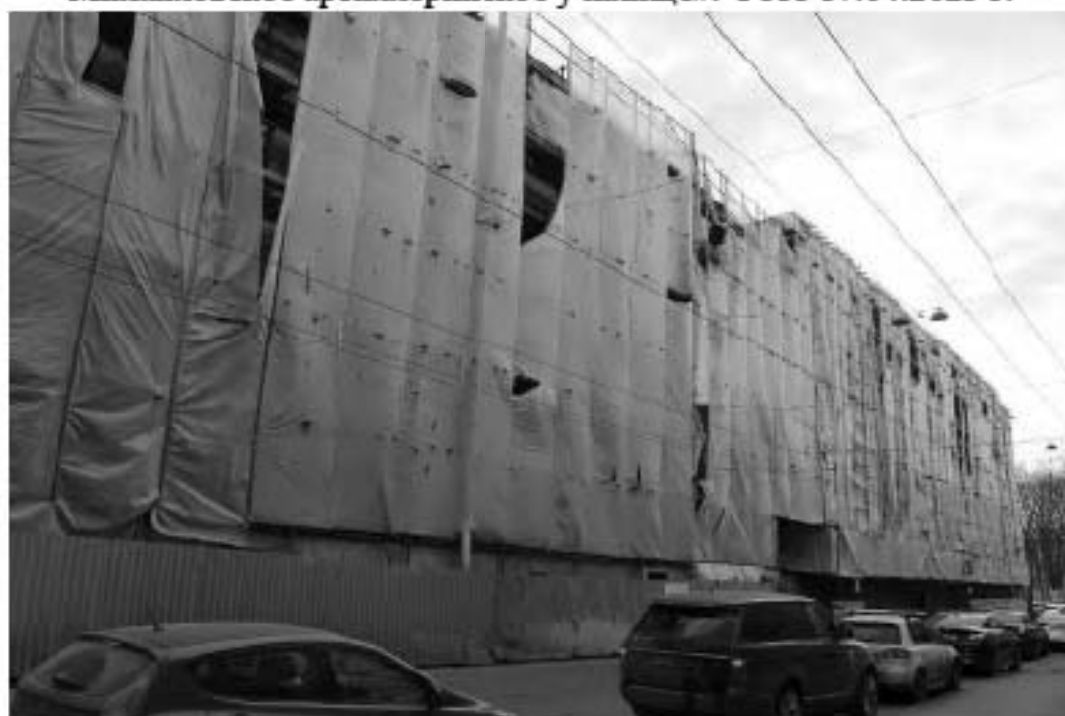
Фото 6. Вид на лицевые фасады выявленных объектов культурного наследия «Корпус квартир офицеров (угловой)» (объект культурного наследия регионального значения «Академия Михайловская артиллерийская, где преподавали ученые Ленц Э.Х., Остроградский М.В., Петрушевский В.Ф.»)), «Главный корпус с 1-м солдатским корпусом, офицерским флигелем и Михайловское артиллерийское училище». Фото 17.04.2023 г.
