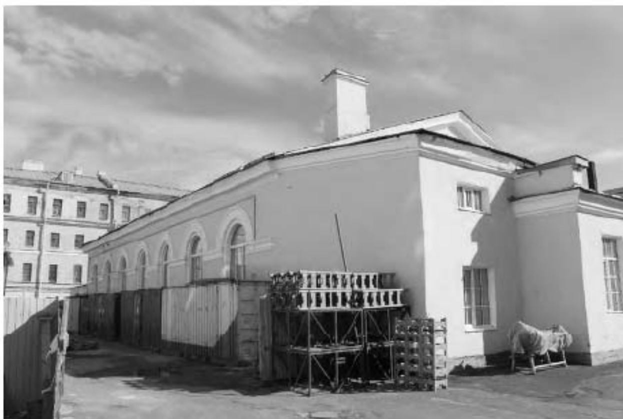
Фото 50. Вид на северный фасад выявленного объекта культурного наследия «Малый манеж». Фото 03.05.2023 г.
