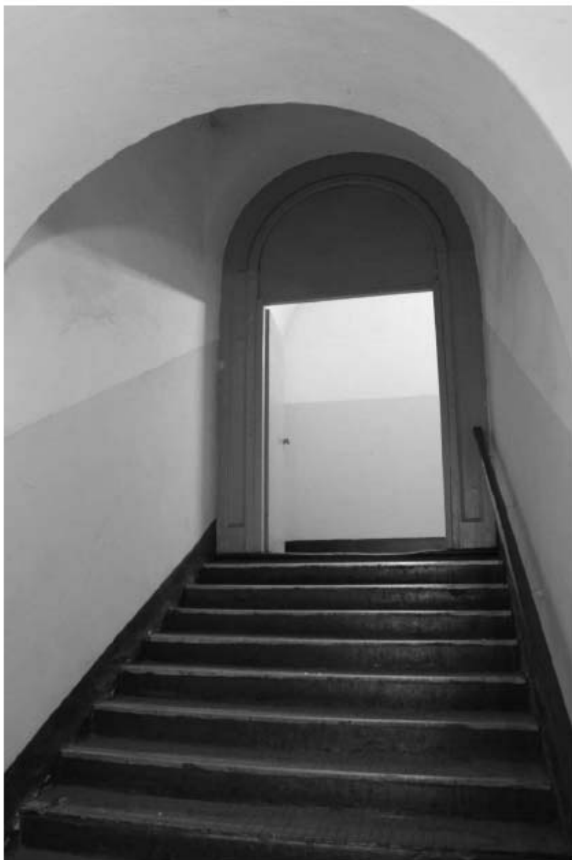
Фото 96. Выявленный объект культурного наследия «Главный корпус с 1-м солдатским корпусом, офицерским флигелем и Михайловское артиллерийское училище». 4ЛК. Фото 03.05.2023 г.
