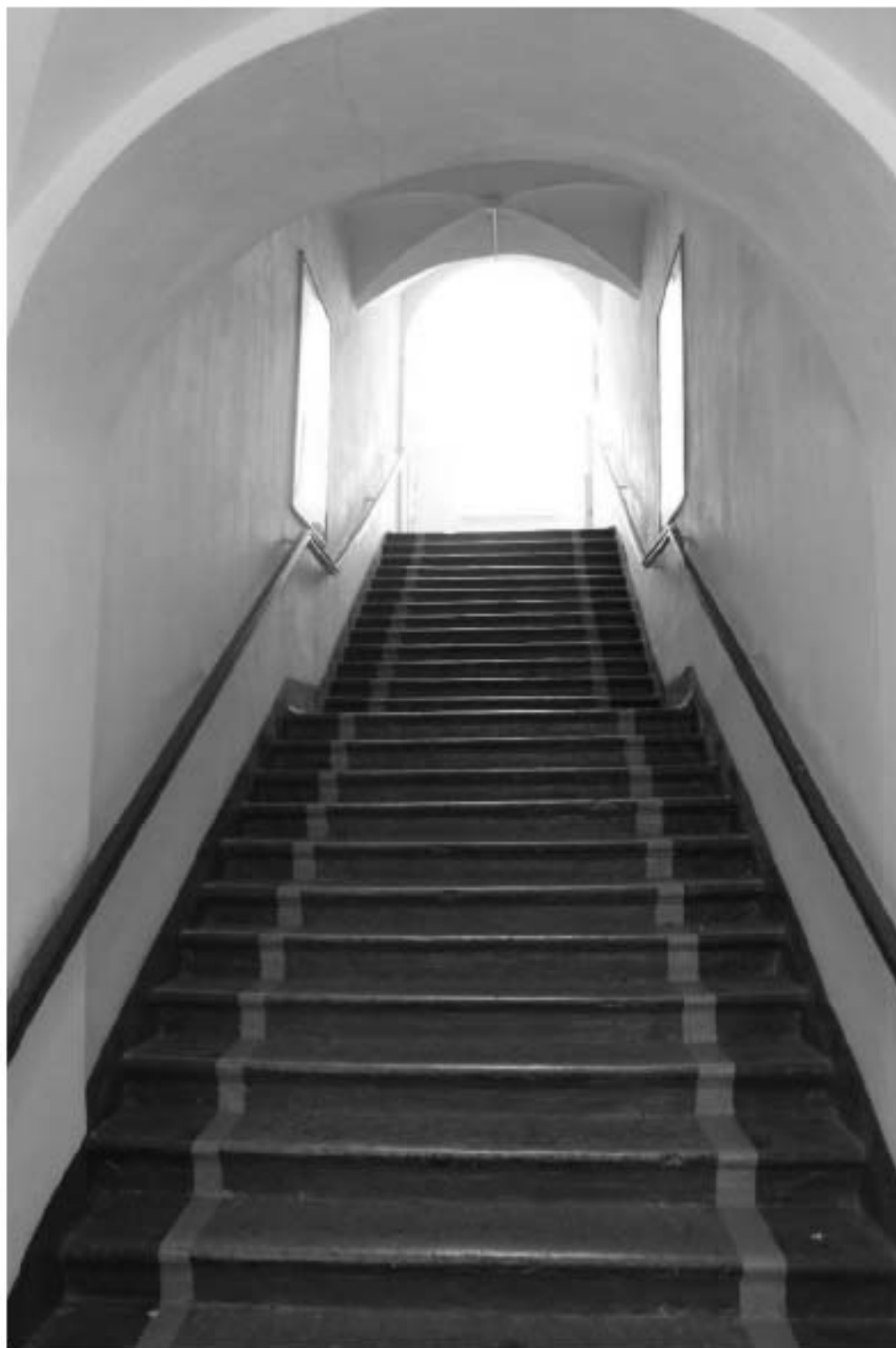
Фото 107. Выявленный объект культурного наследия «Главный корпус с 1-м солдатским корпусом, офицерским флигелем и Михайловское артиллерийское училище». 5ЛК. Фото 03.05.2023 г.
