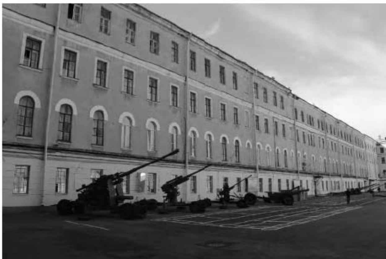
Фото 35. Вид на восточный фасад западного корпуса выявленного объекта культурного наследия «Главный корпус с 1-м солдатским корпусом, офицерским флигелем и Михайловское артиллерийское училище». Фото 03.05.2023 г.
