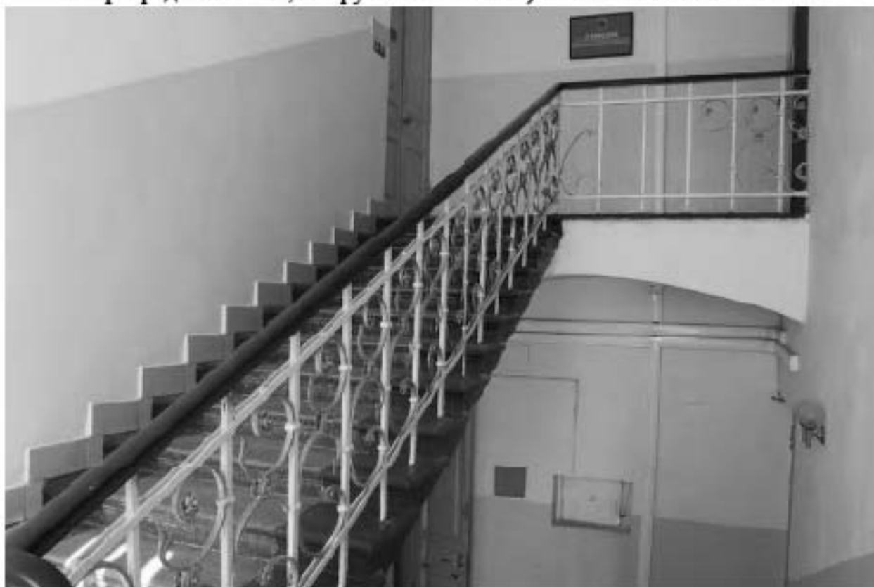
Фото 171. Выявленный объект культурного наследия «Корпус квартир офицеров (угловой)» (объект культурного наследия регионального значения «Академия Михайловская артиллерийская, где преподавали ученые Ленц Э.Х., Остроградский М.В., Петрушевский В.Ф.»). 9ЛК. Фото 03.05.2023 г.
