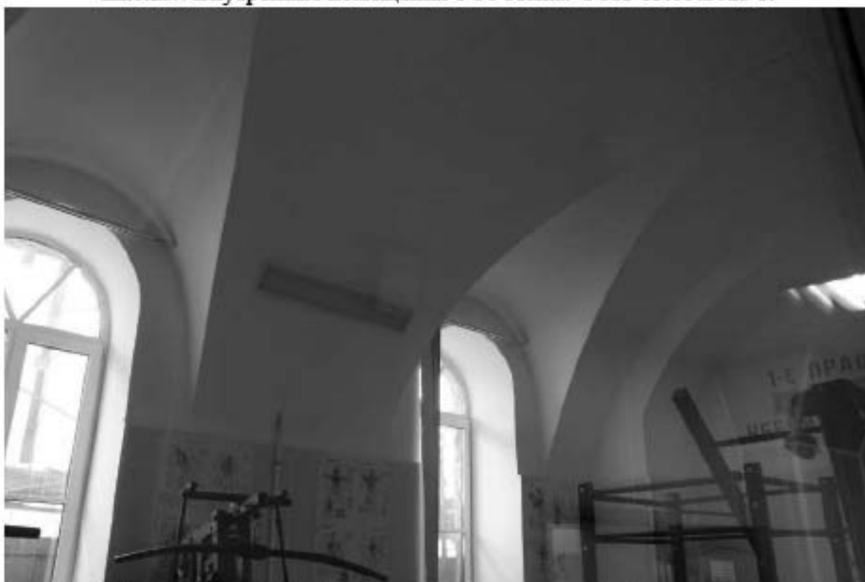
Фото 209. Выявленный объект культурного наследия «Пиротехническая школа». Внутренние помещения 1-го этажа. Фото 03.05.2023 г.
