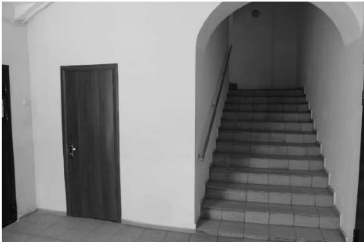
Фото 141. Выявленный объект культурного наследия «Главный корпус с 1-м солдатским корпусом, офицерским флигелем и Михайловское артиллерийское училище». 8ЛК. Фото 03.05.2023 г.
