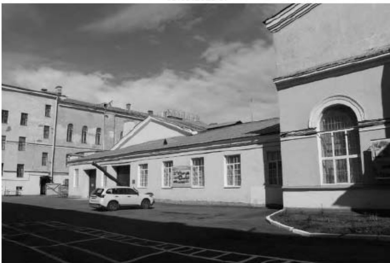
Фото 38. Вид на северо-западное крыло выявленного объекта культурного наследия «Манеж с конюшнями». Фото 03.05.2023 г.
