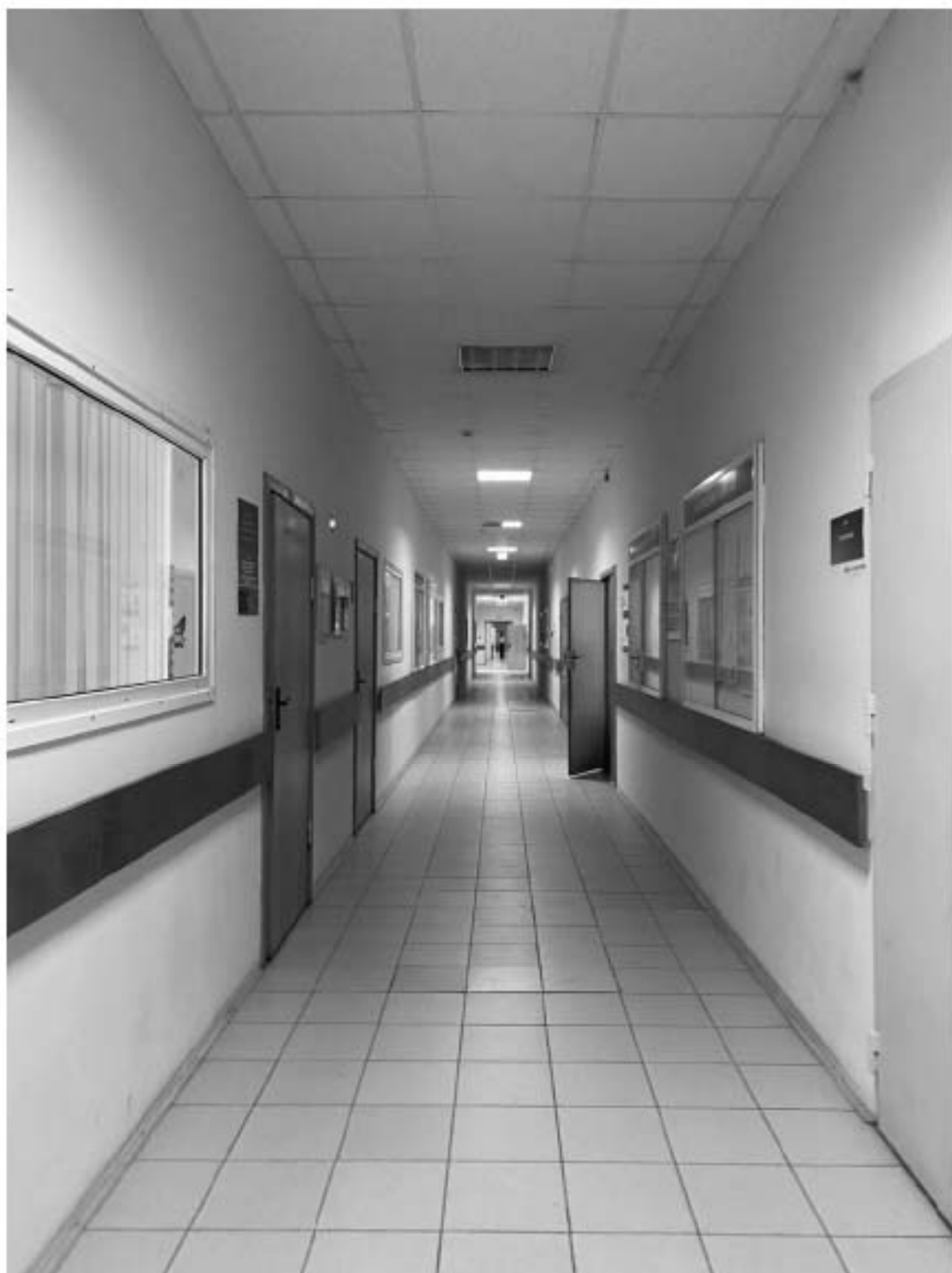
54. Интерьер помещений объекта культурного наследия в уровне 2-го этажа.
