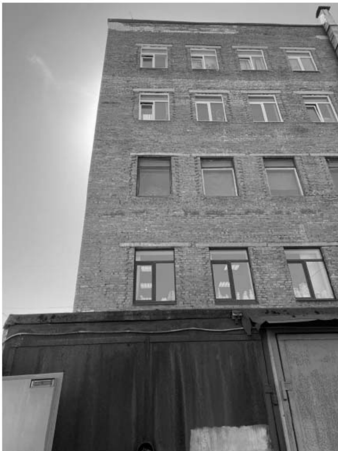
21. Пристройка к южному ризалиту объекта культурного наследия.
