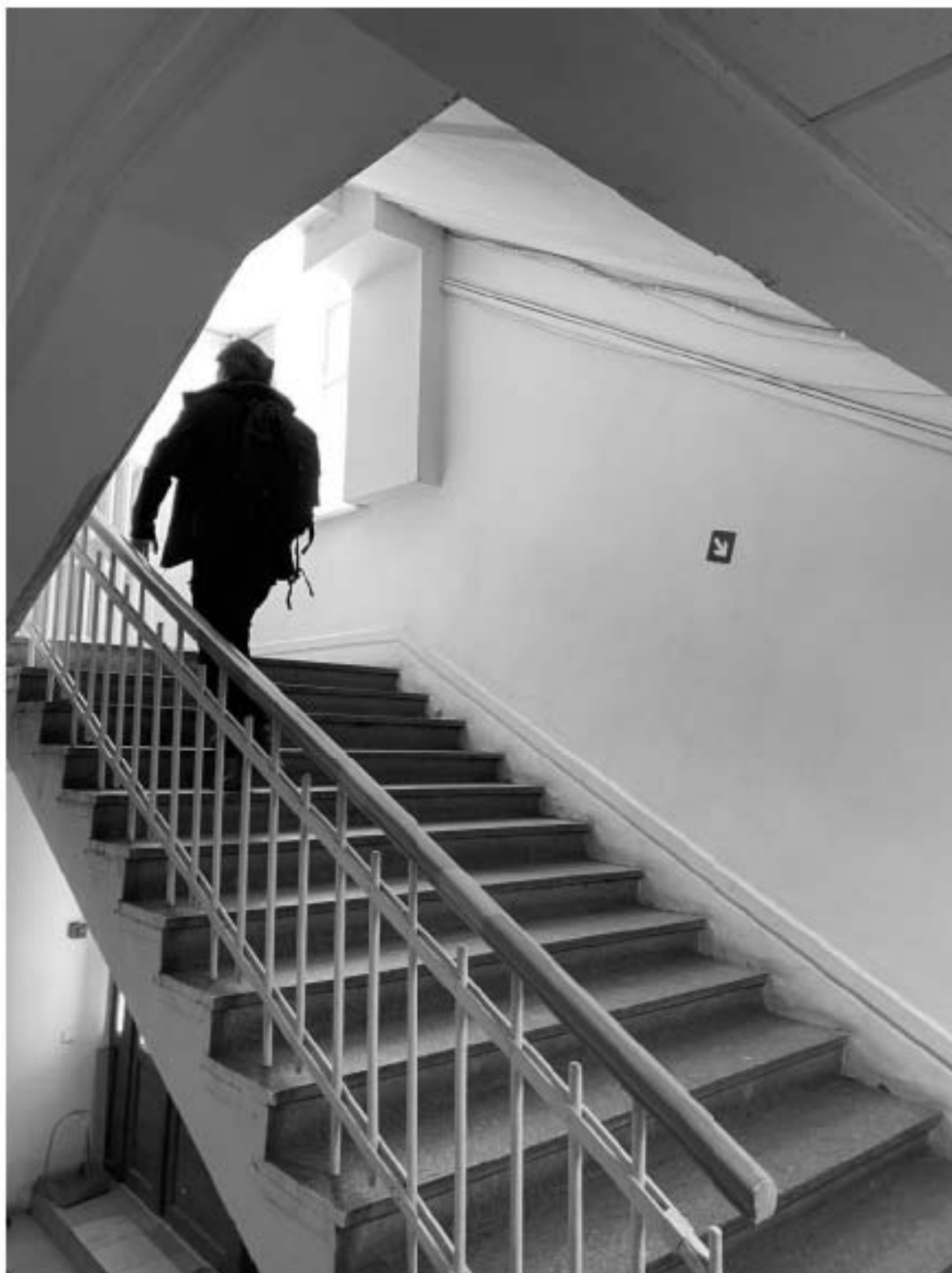
46. Общий вид лестницы объекта культурного наследия в уровне 1-го этажа.
