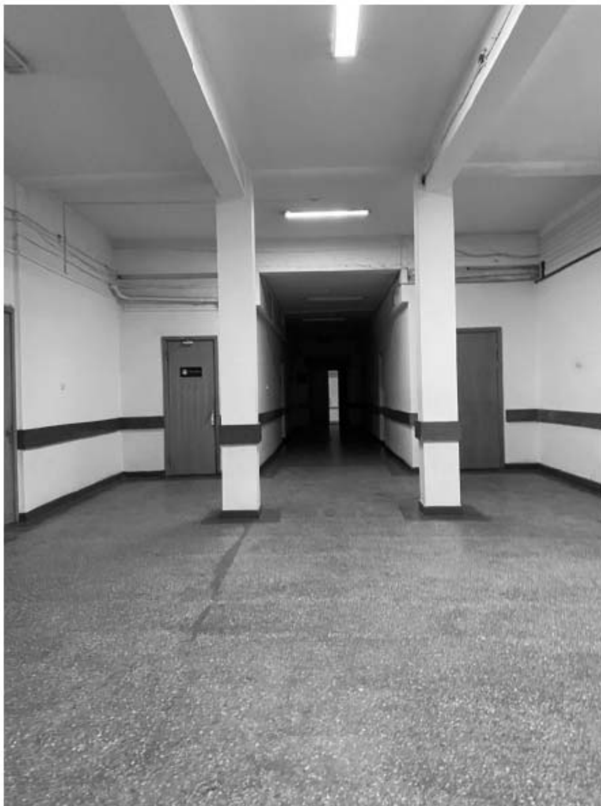
111. Интерьер помещений объекта культурного наследия в уровне 4-го этажа.
