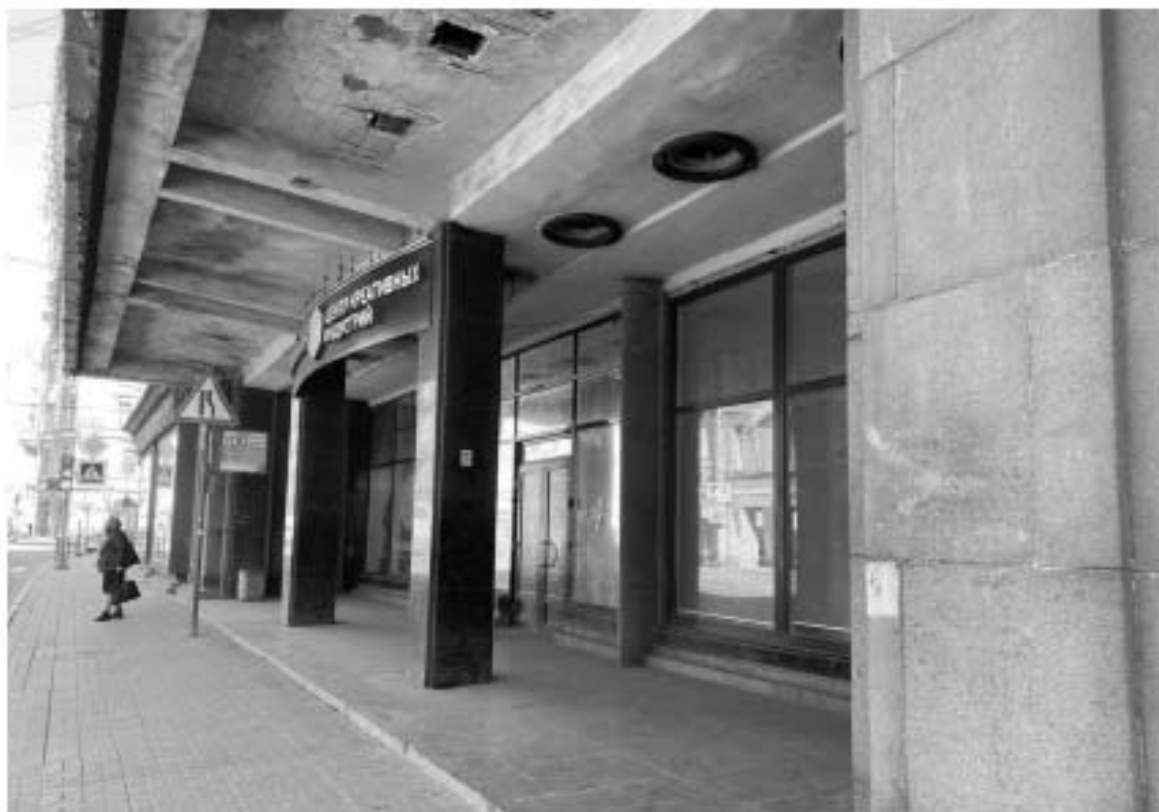
14. Входная группа лицевого фасада объекта культурного наследия по Вознесенскому проспекту.
