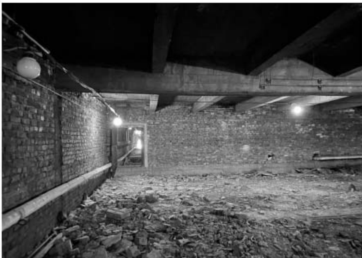
134. Общий вид помещения чердака объекта культурного наследия.
