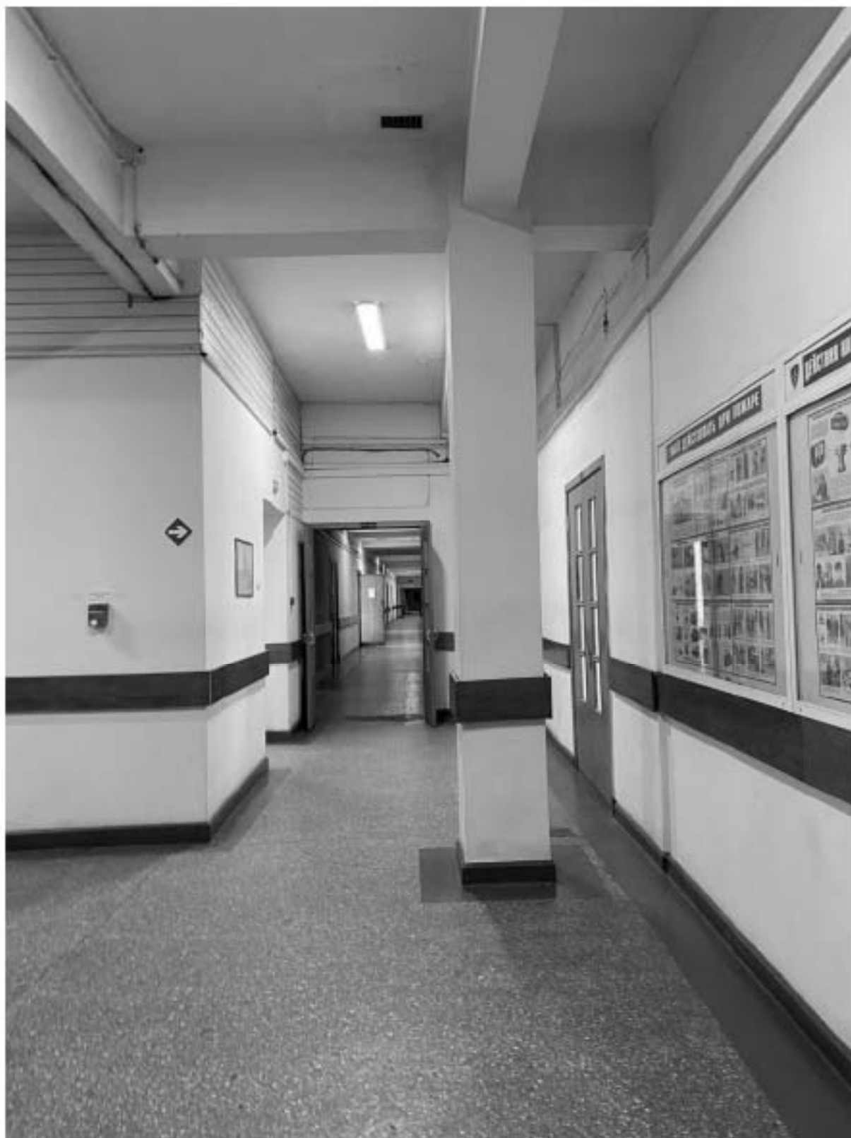
110. Интерьер помещений объекта культурного наследия в уровне 4-го этажа.
