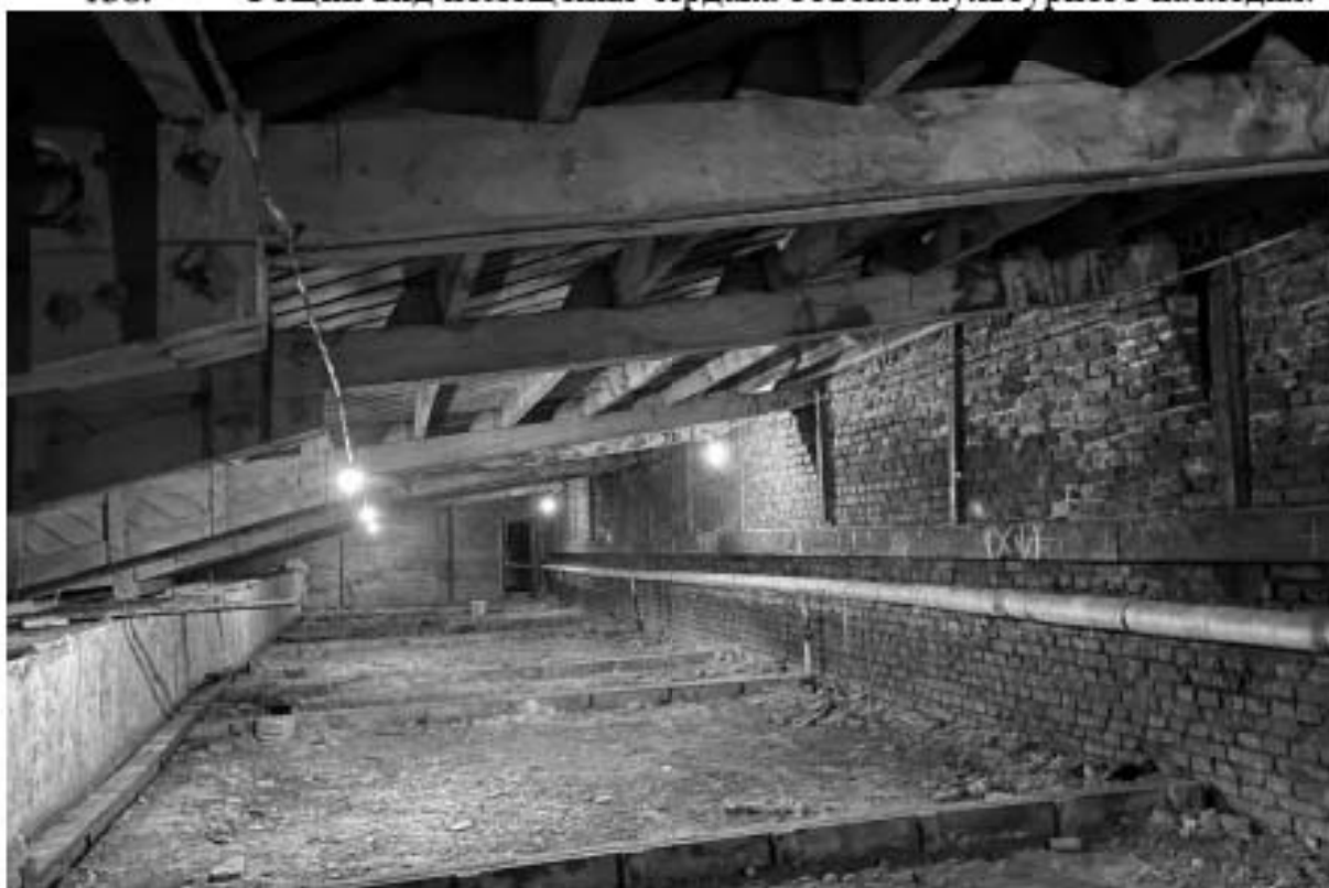
139. Общий вид помещения чердака объекта культурного наследия.
