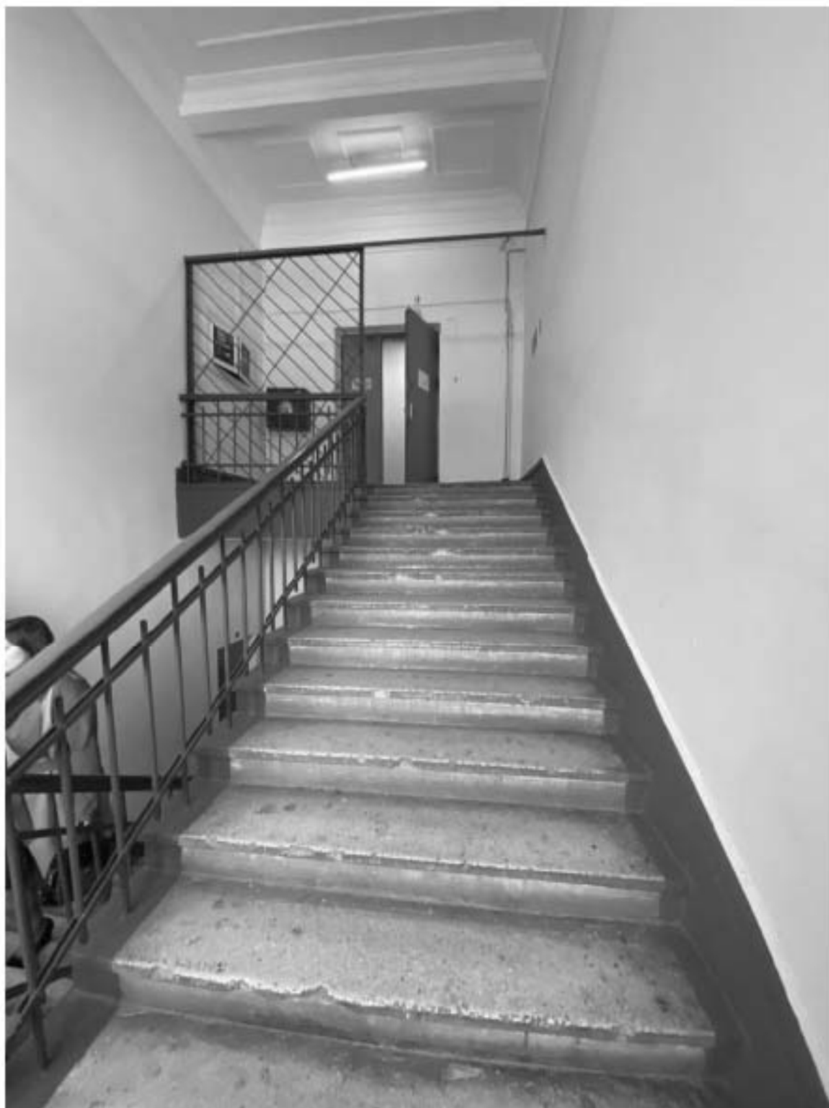
97. Общий вид лестницы объекта культурного наследия в уровне 4-го этажа.
