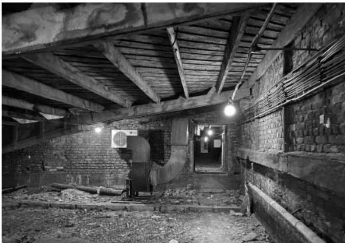
138. Общий вид помещения чердака объекта культурного наследия.
