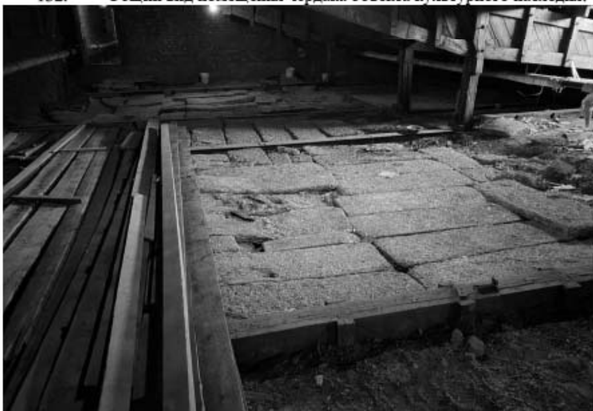
133. Общий вид помещения чердака объекта культурного наследия.
