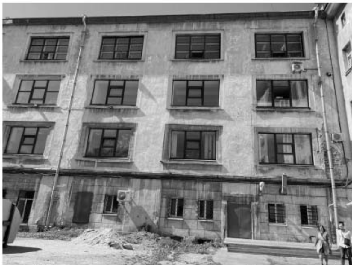
18. Фрагмент южной части дворового фасада объекта культурного наследия.
