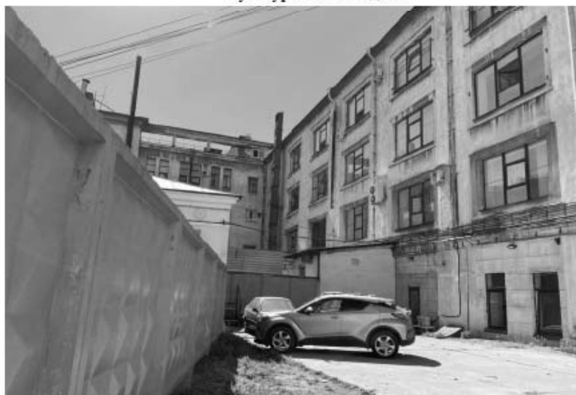
27. Общий вид дворового фасада и центрального ризалита объекта культурного наследия.
