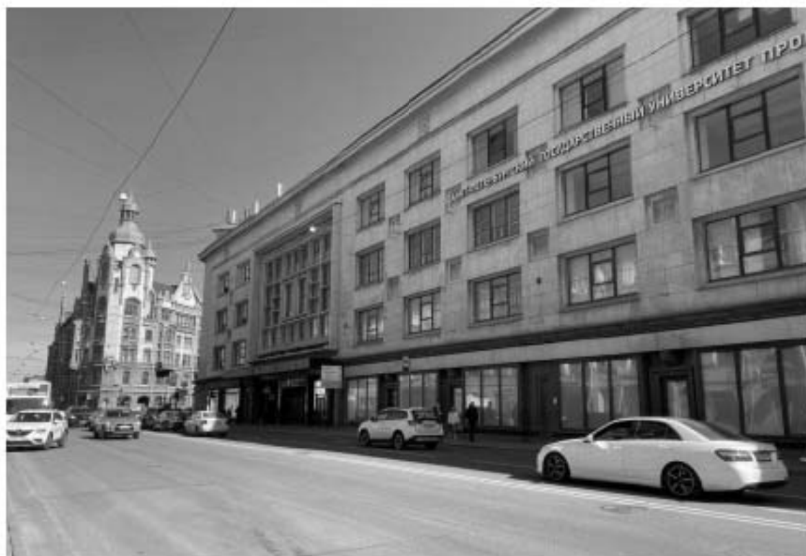
6. Фрагмент оконного заполнения лицевого фасада объекта культурного наследия по Вознесенскому проспекту.
