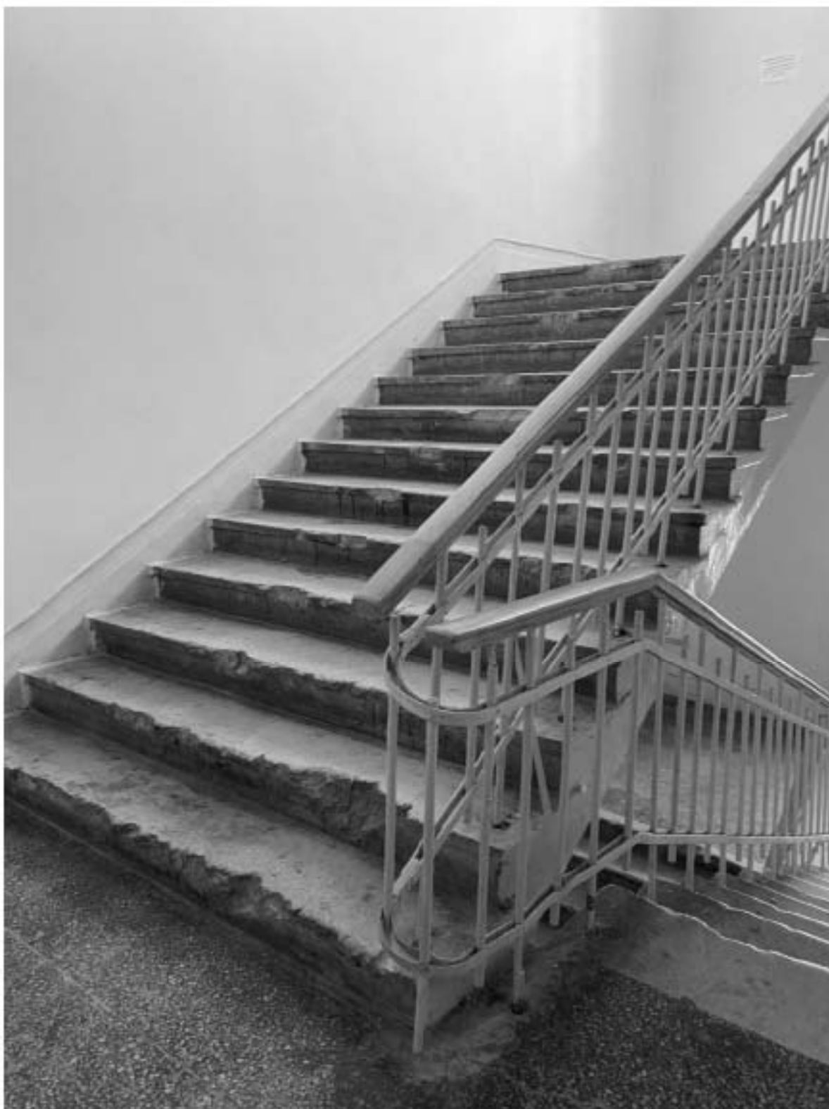
65. Общий вид лестницы объекта культурного наследия в уровне 2-го этажа.
