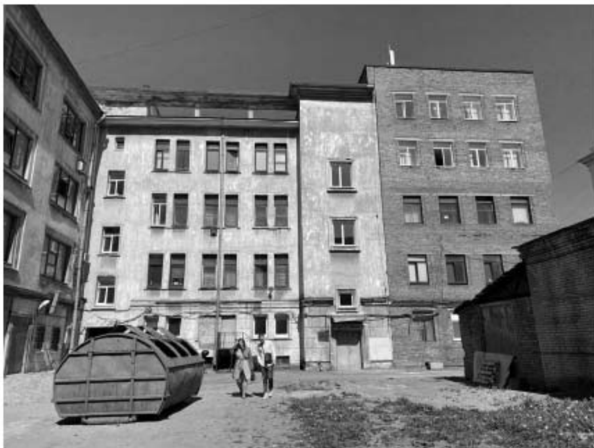
20. Общий вид дворового фасада и южного ризалита объекта культурного наследия.
