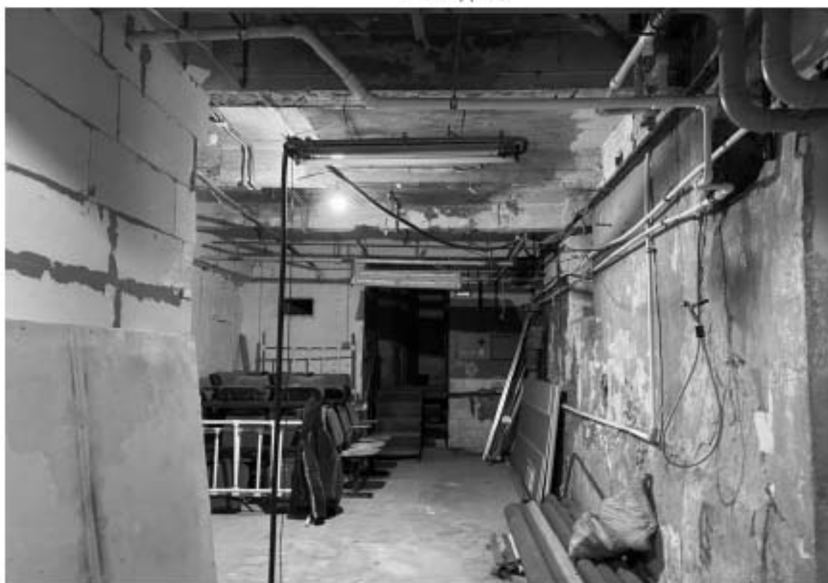
29. Общий вид помещения подвального этажа объекта культурного наследия.
