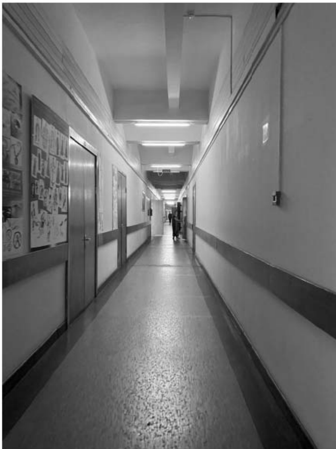
79. Интерьер помещений объекта культурного наследия в уровне 3-го этажа.
