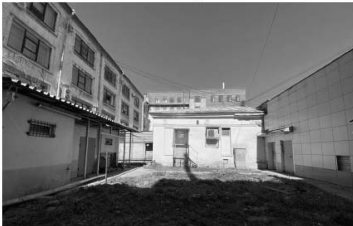
23. Фрагмент центральной части дворового фасада объекта культурного наследия.
