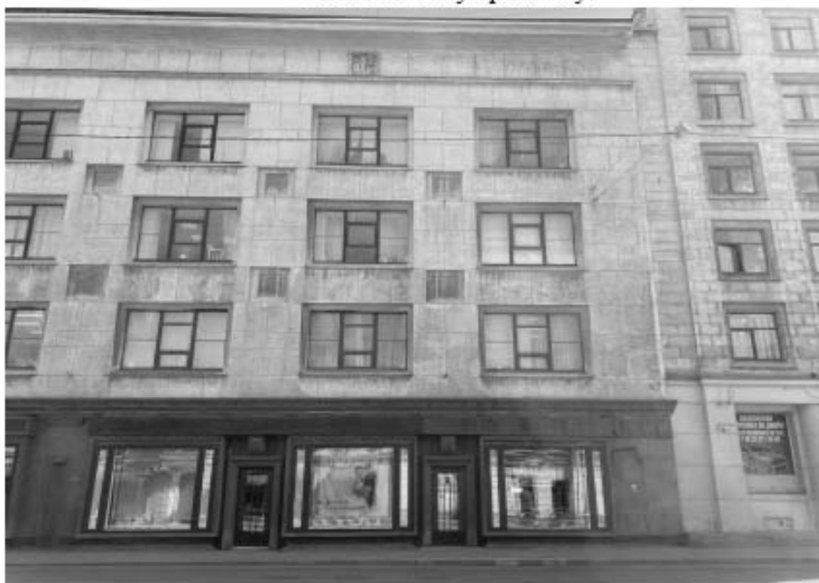
9. Фрагмент лицевого фасада объекта культурного наследия по Вознесенскому проспекту.
