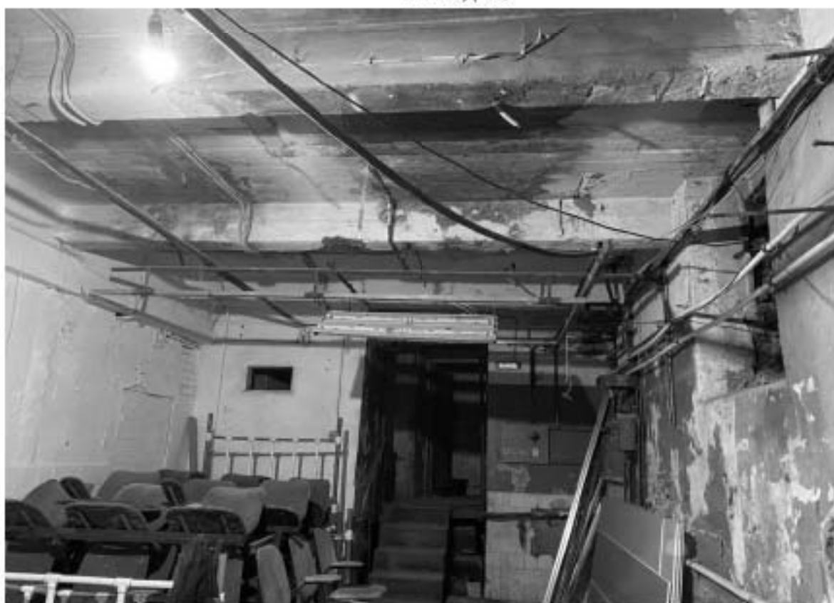
31. Общий вид помещения подвального этажа объекта культурного наследия.
