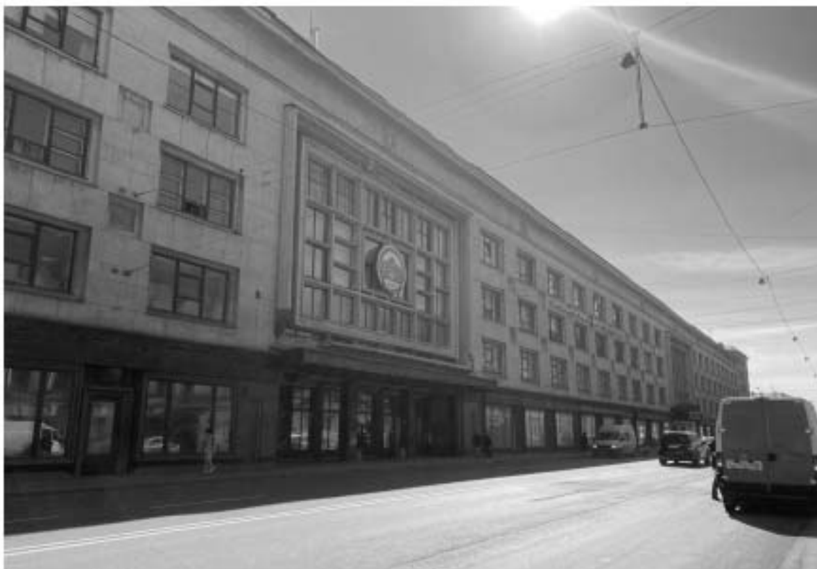
8. Фрагмент лицевого фасада объекта культурного наследия по Вознесенскому проспекту.
