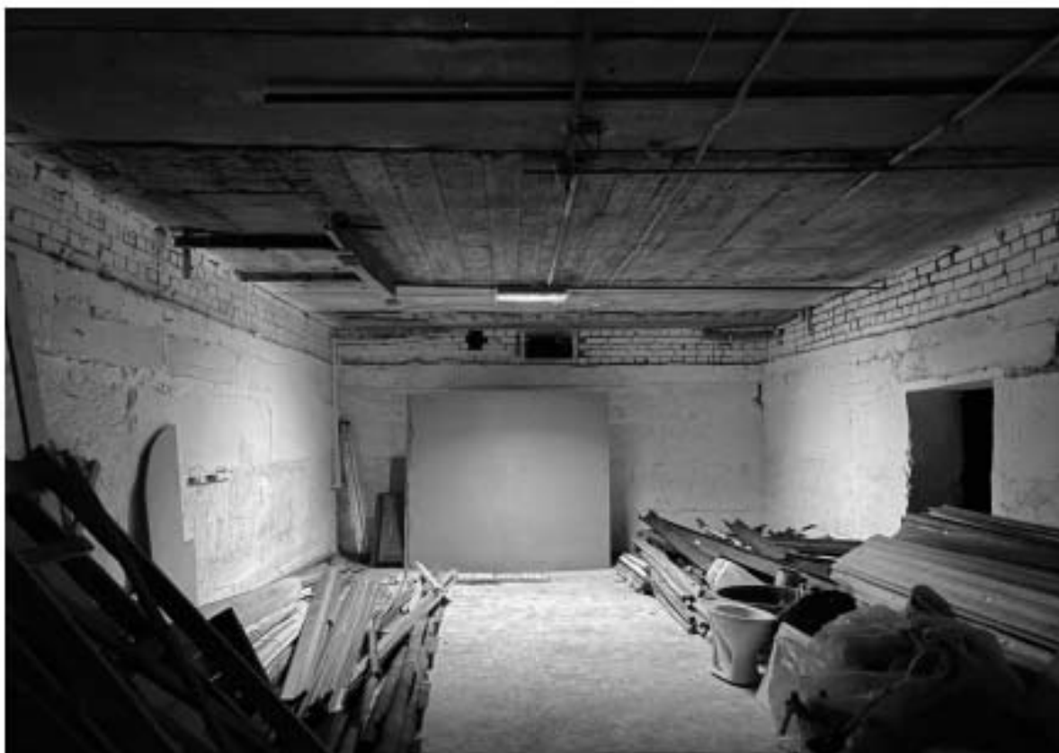
32. Общий вид помещения подвального этажа объекта культурного наследия.
