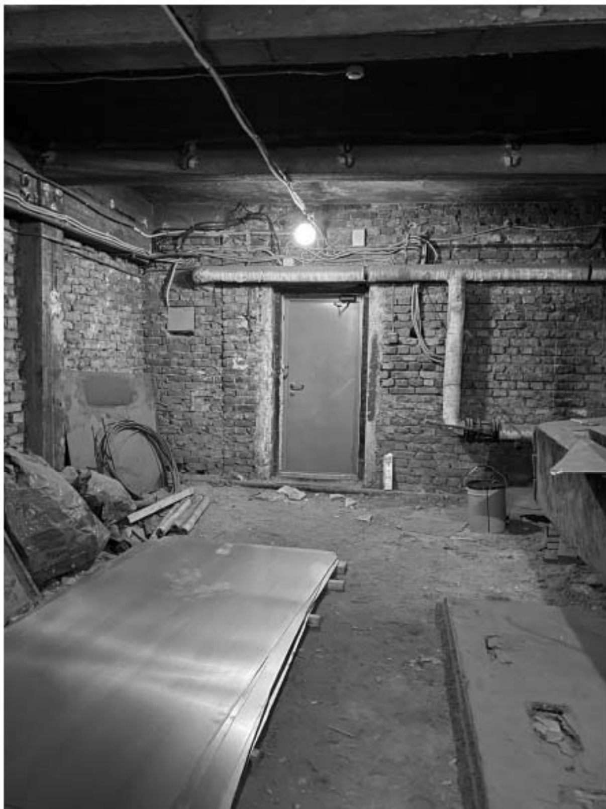
141. Общий вид помещения чердака объекта культурного наследия.
