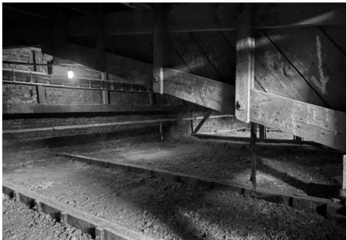
130. Общий вид помещения чердака объекта культурного наследия.
