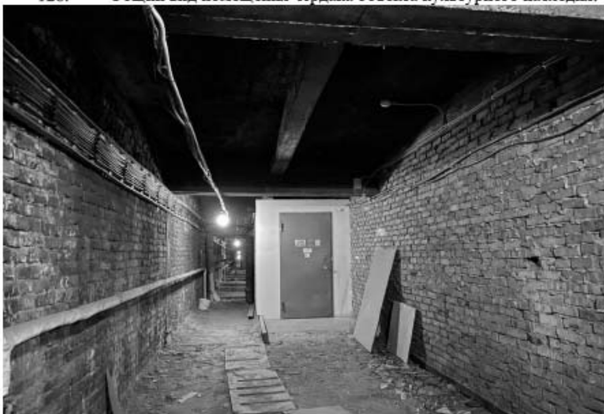
127. Общий вид помещения чердака объекта культурного наследия.
