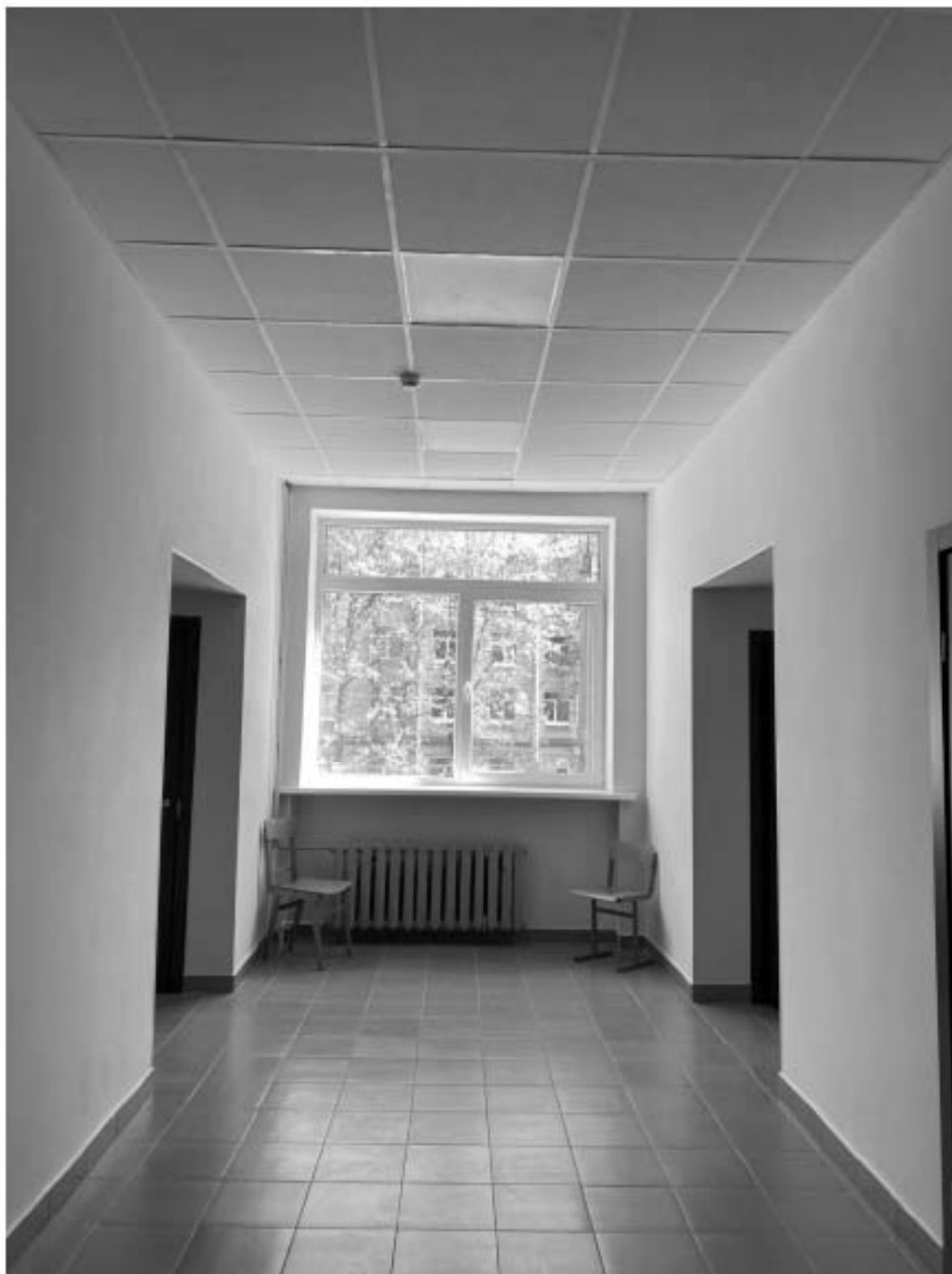
62. Интерьер помещений объекта культурного наследия в уровне 2-го этажа.
