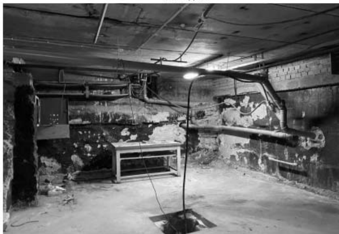
35. Общий вид помещения подвального этажа объекта культурного наследия.
