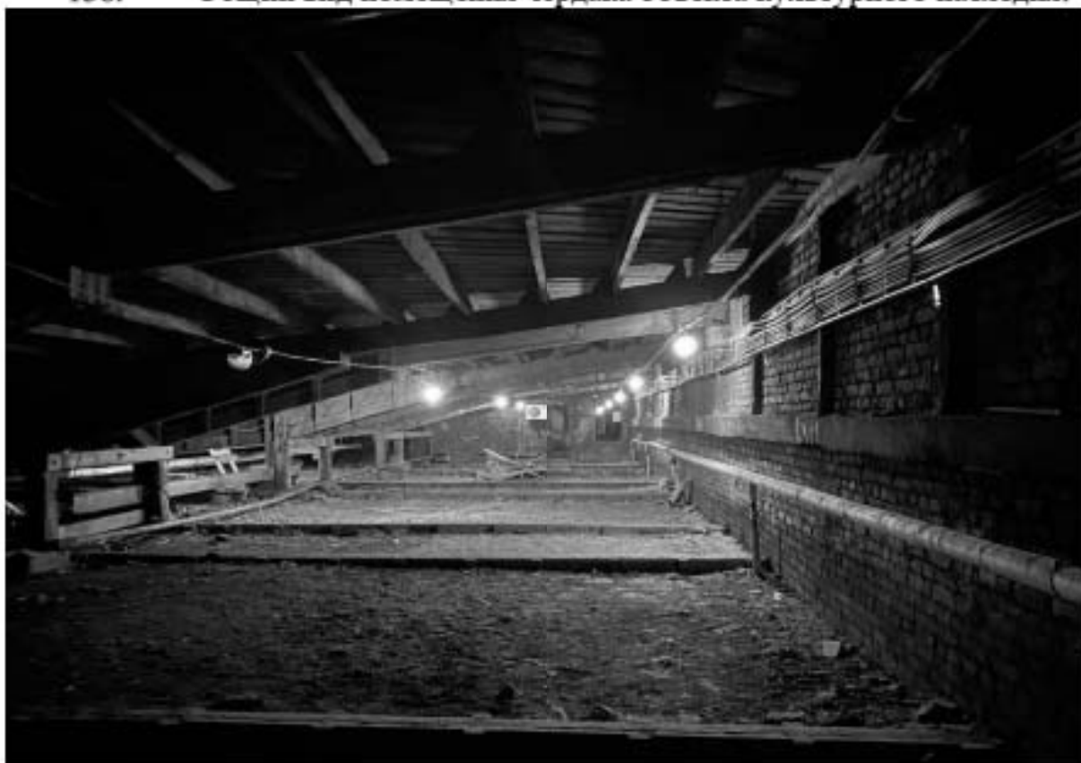
137. Общий вид помещения чердака объекта культурного наследия.
