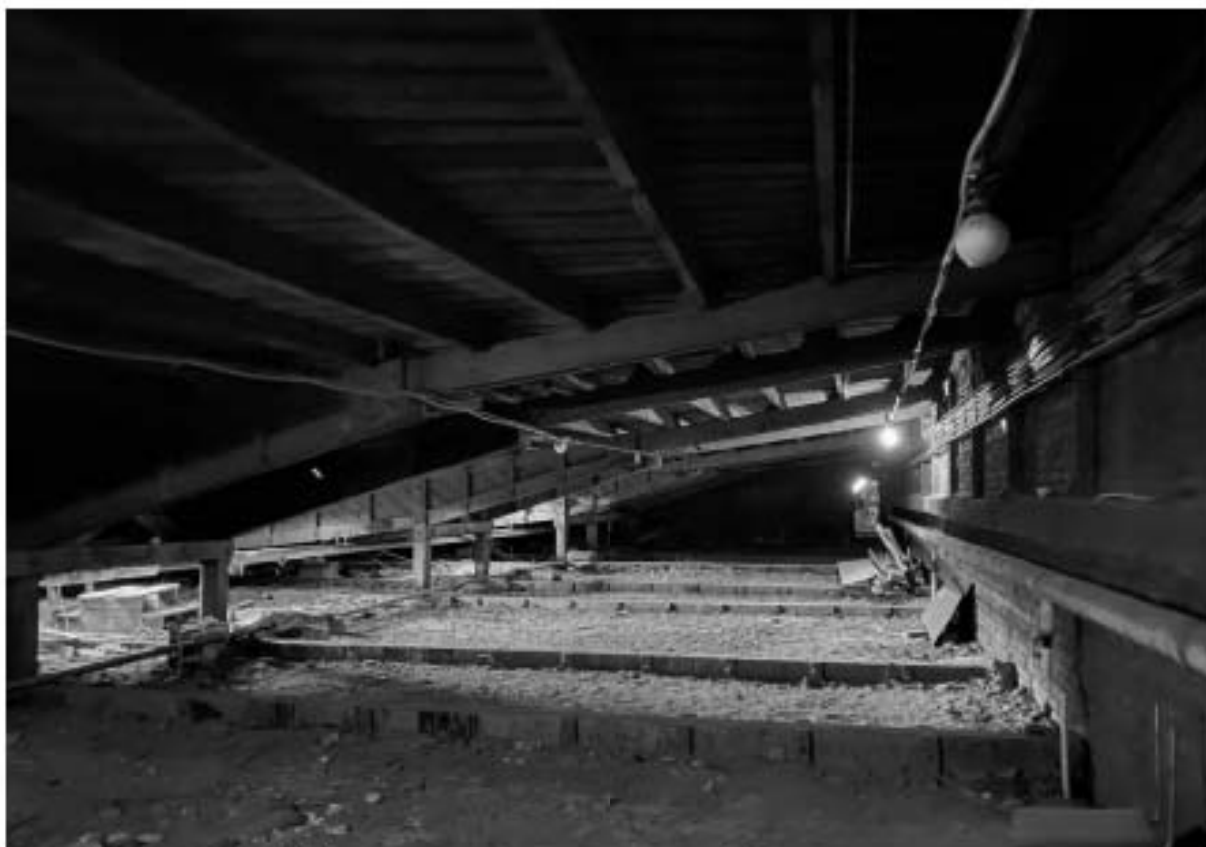
136. Общий вид помещения чердака объекта культурного наследия.
