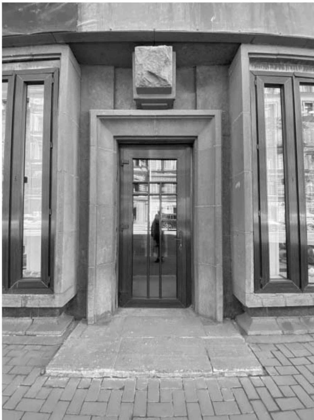
11. Дверное заполнение лицевого фасада объекта культурного наследия по Вознесенскому проспекту.
