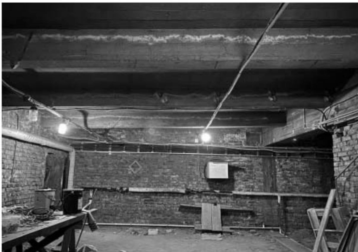
126. Общий вид помещения чердака объекта культурного наследия.
