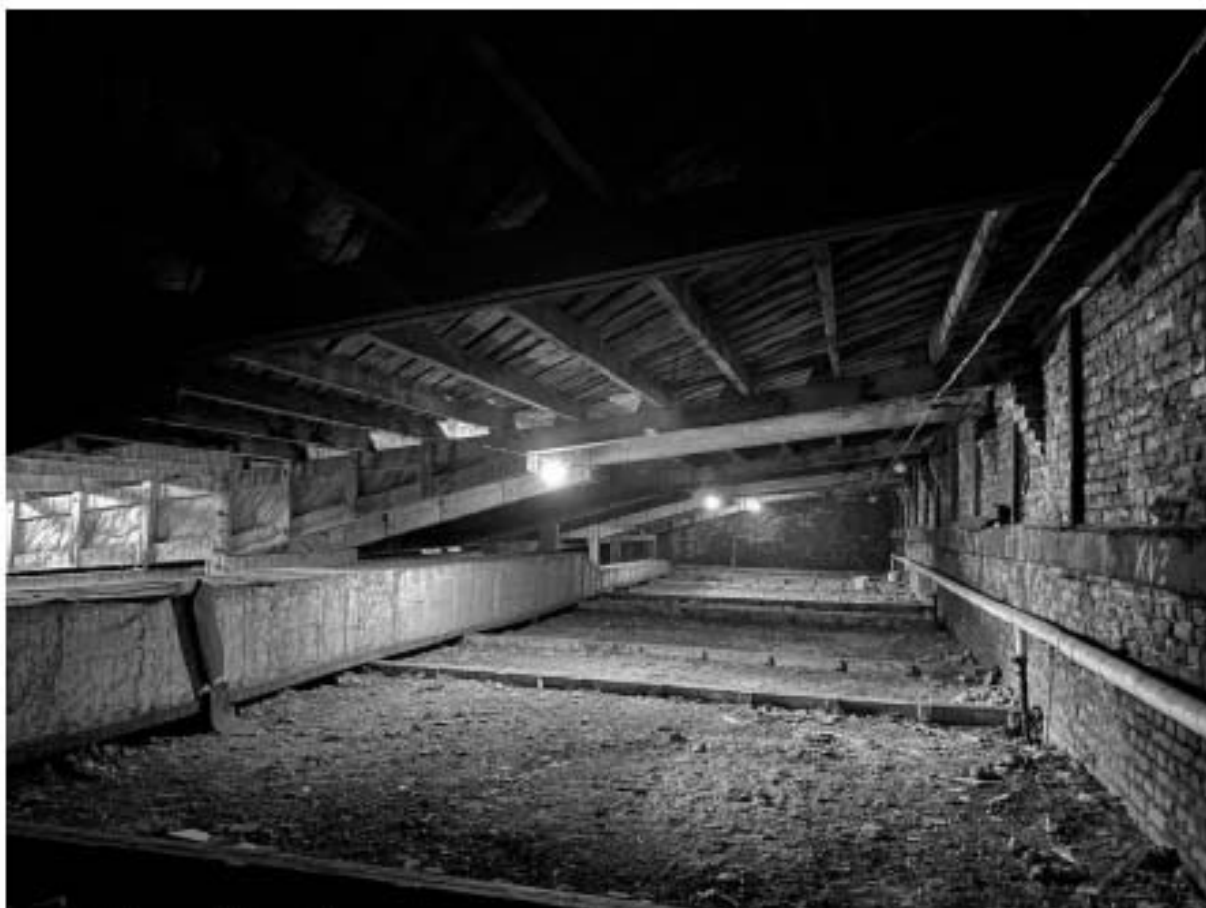
140. Общий вид помещения чердака объекта культурного наследия.
