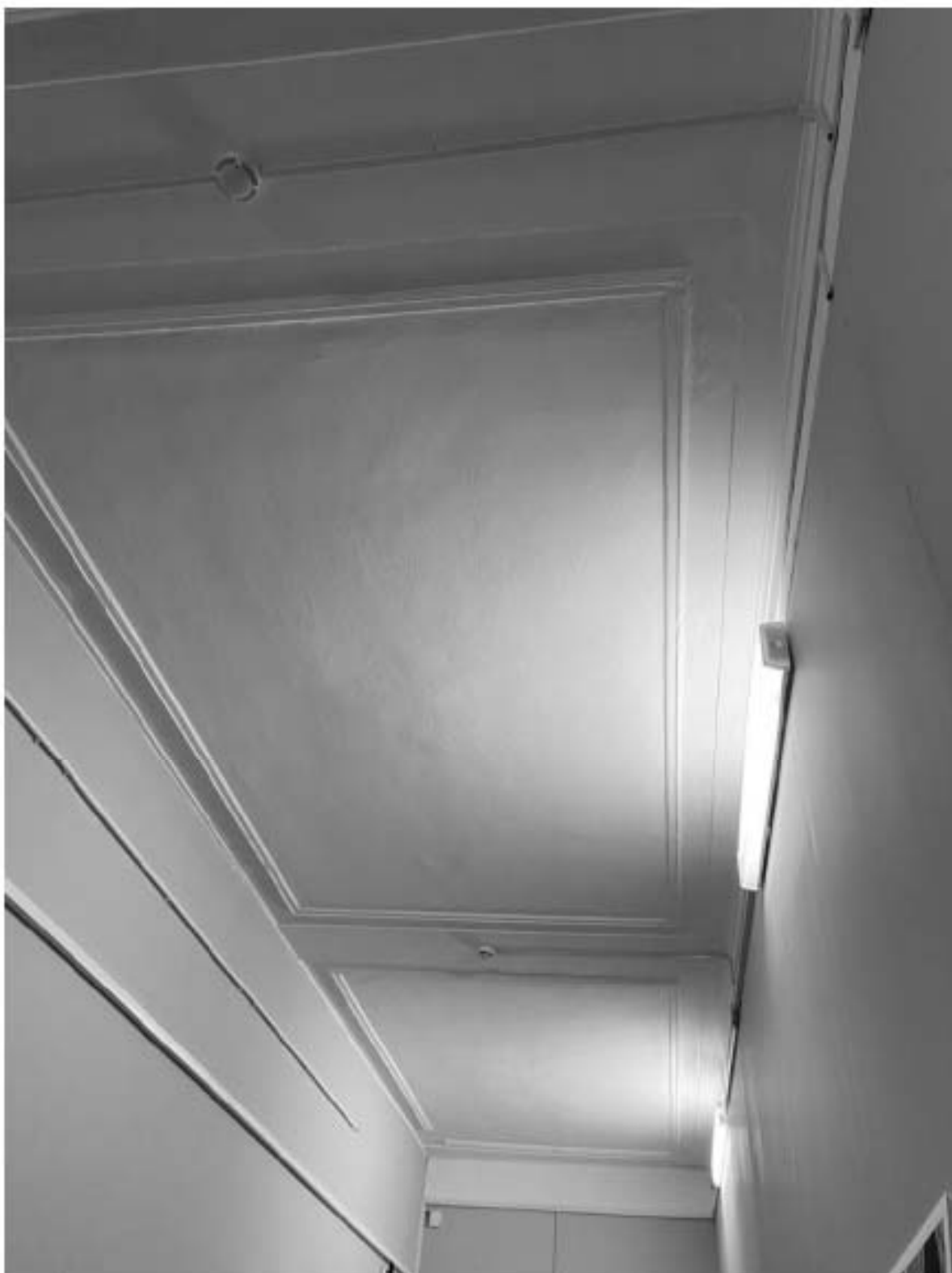
52. Фрагмент потолка помещений объекта культурного наследия в уровне 2-го этажа.
