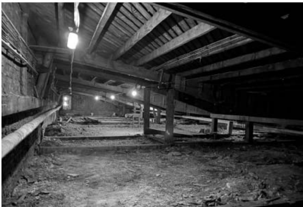
132. Общий вид помещения чердака объекта культурного наследия.
