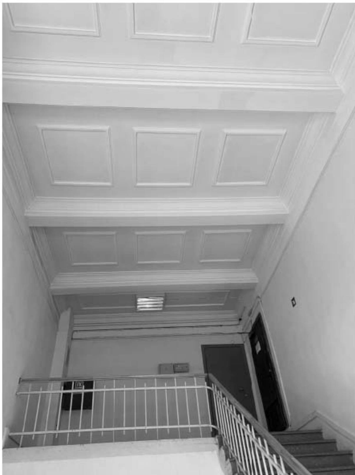
113. Верхнее перекрытие лестницы объекта культурного наследия в уровне 4-го этажа.
