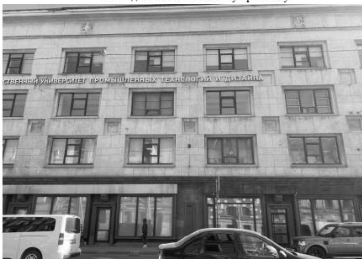
7. Фрагмент лицевого фасада объекта культурного наследия по Вознесенскому проспекту.
