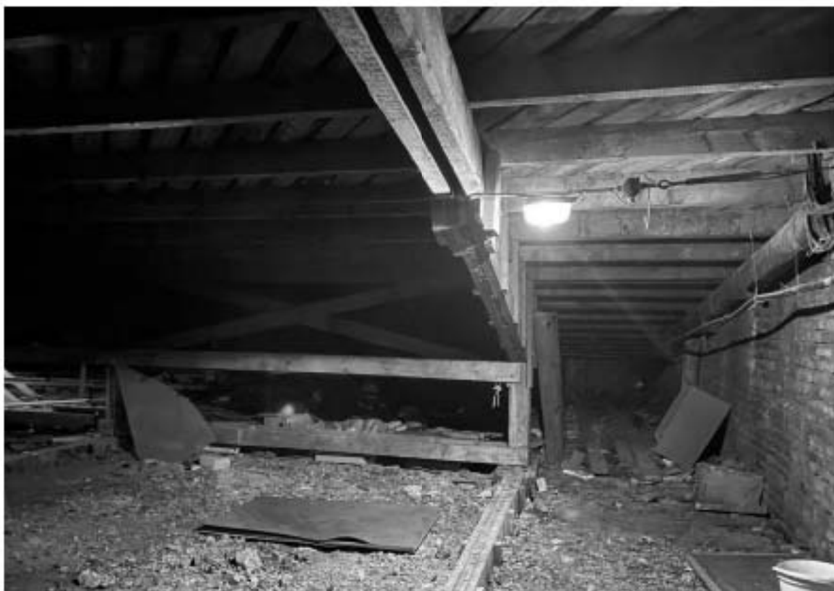
128. Общий вид помещения чердака объекта культурного наследия.
