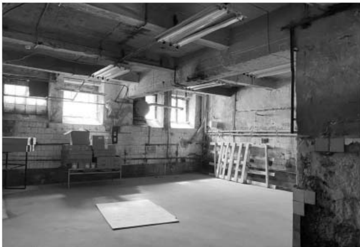
30. Общий вид помещения подвального этажа объекта культурного наследия.
