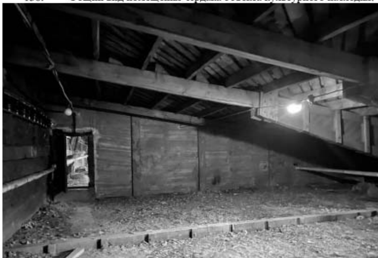
131. Общий вид помещения чердака объекта культурного наследия.
