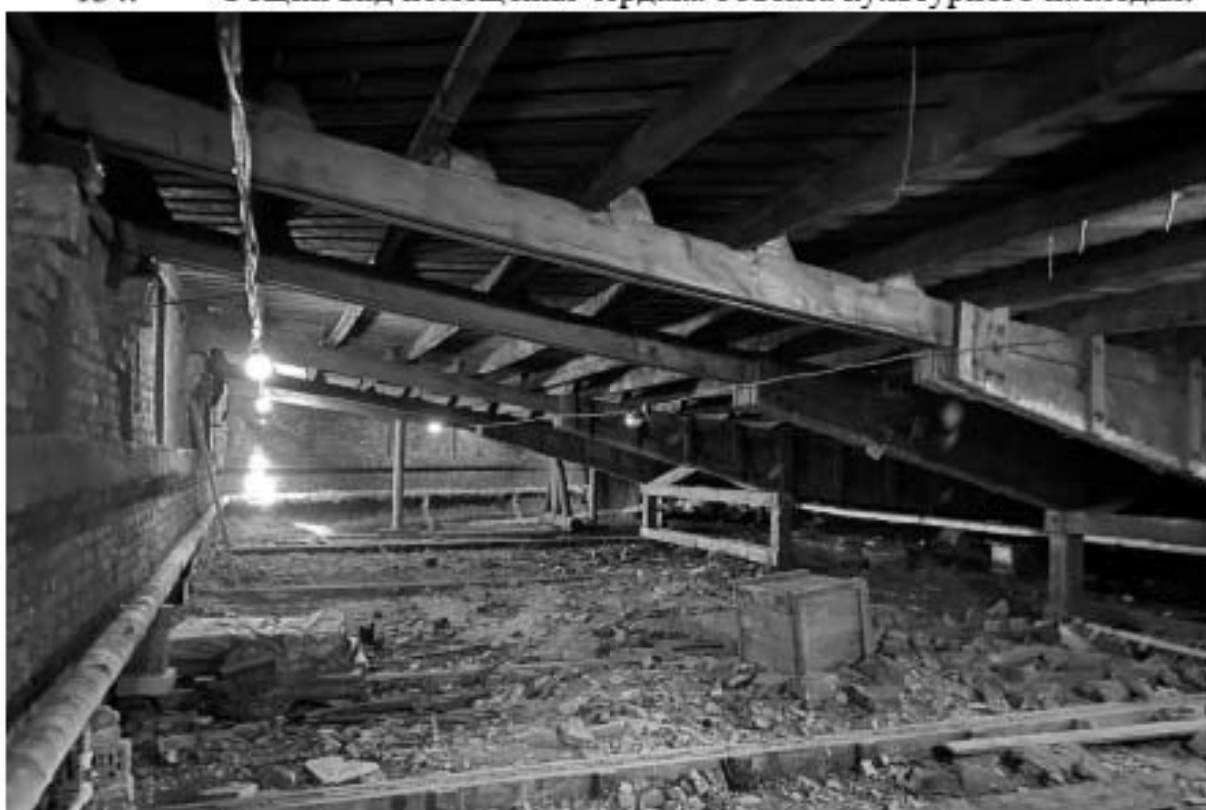
135. Общий вид помещения чердака объекта культурного наследия.
