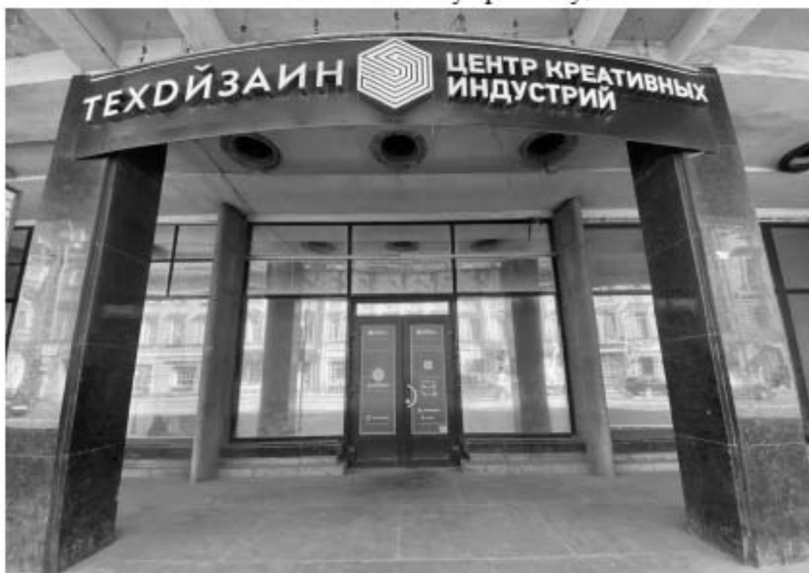
15. Входная группа лицевого фасада объекта культурного наследия по Вознесенскому проспекту.
