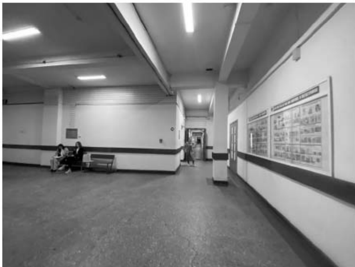
108. Интерьер помещений объекта культурного наследия в уровне 4-го этажа.
