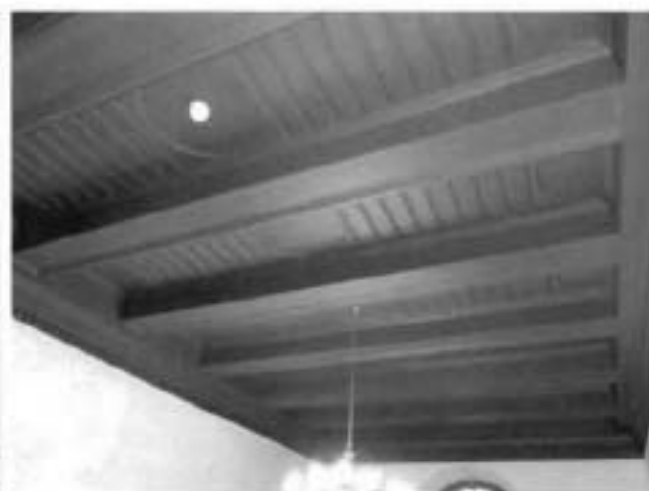
8. Оформление потолка над лестничной клеткой.
