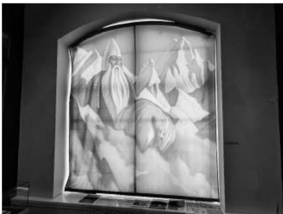
16. «Дом Боткина М.П.», ул. 18-я линия В.О., д.1, лит. А. Третий этаж. Помещение в осях 9-В. Оконное заполнение. Общий вид. Фото 22.06.2023г.
