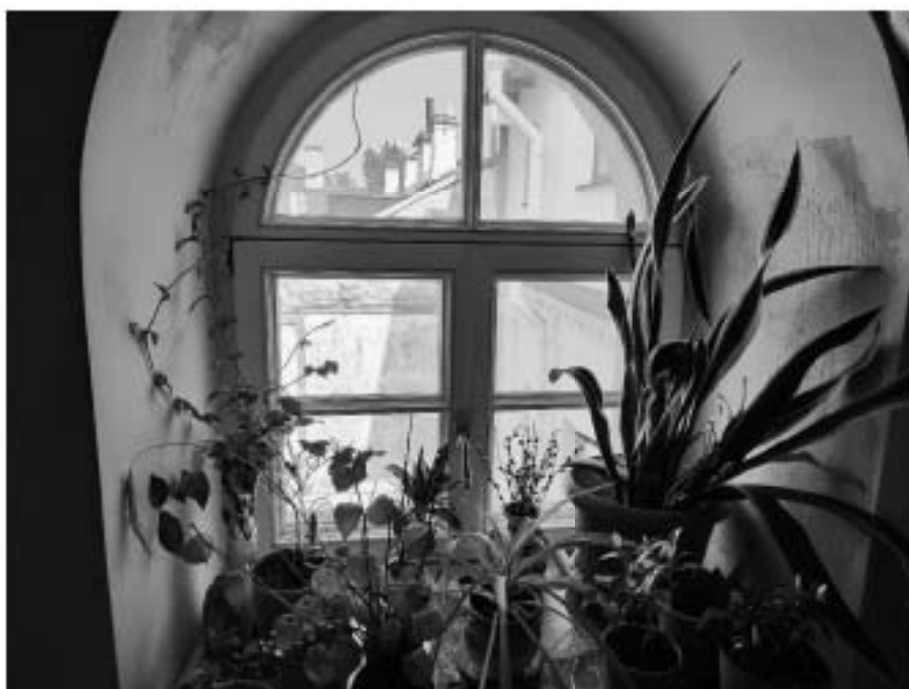
10. «Дом Боткина М.П.», ул. 18-я линия В.О., д.1, лит. А. Третий этаж. Помещение в осях 5-Д. Оконное заполнение. Общий вид. Фото 22.06.2023г.
