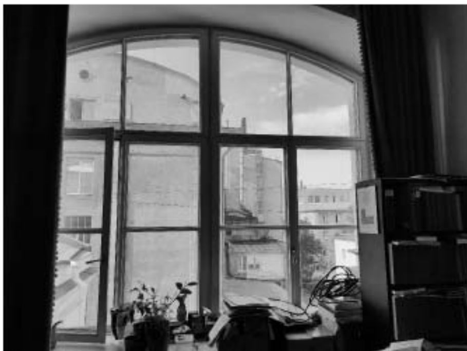
17. «Дом Боткина МП.», ул. 18-я линия В.О., д.1, лит. А. Третий этаж. Помещение в осях 8-Г. Оконное заполнение. Общий вид. Фото 22.06.2023г.
