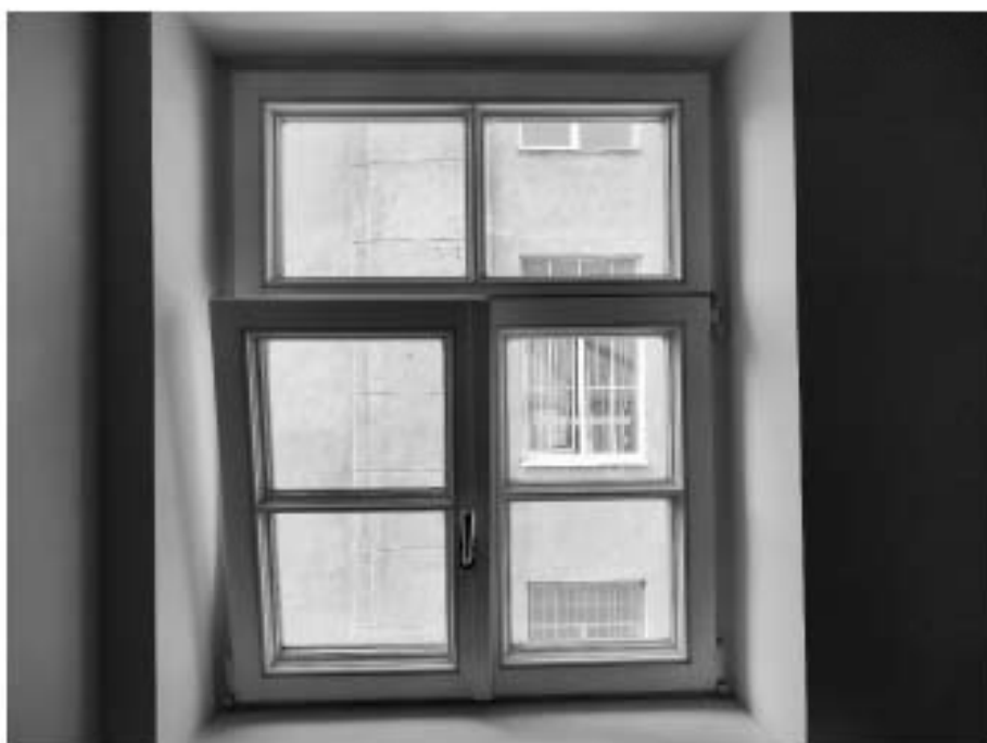
20. «Дом Боткина МП.», ул. 18-я линия В.О., д.1, лит. А. Третий этаж. Помещение в осях 9-Г. Оконное заполнение. Общий вид. Фото 22.06.2023г.
