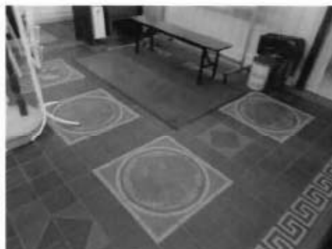
6. Покрытие пола нижнего уровня вестибюля.
