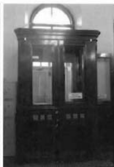
3. Тамбур главного входа.
