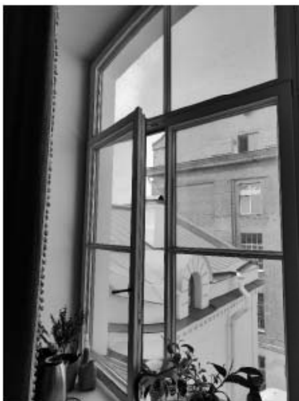
18. «Дом Боткина МП.», ул. 18-я линия В.О., д.1, лит. А. Третий этаж. Помещение в осях 8-Г. Оконное заполнение. Фрагмент. Фото 22.06.2023г.
