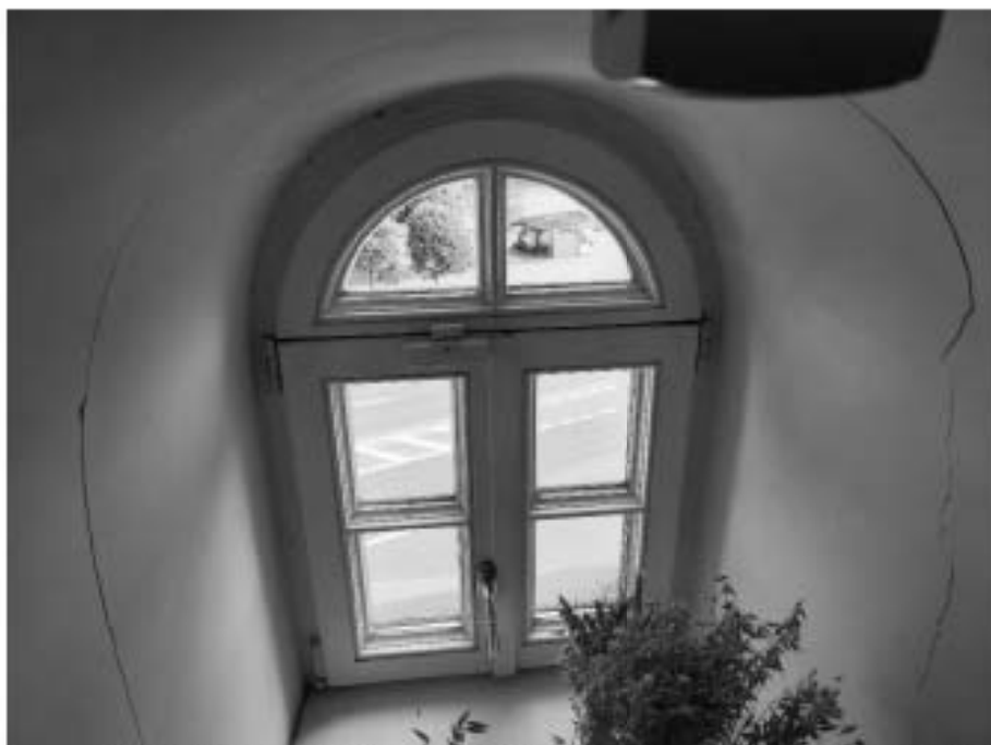
13. «Дом Боткина М.П.», ул. 18-я линия В.О., д.1, лит. А. Третий этаж. Помещение в осях 2-А. Оконное заполнение. Общий вид. Фото 22.06.2023г.
