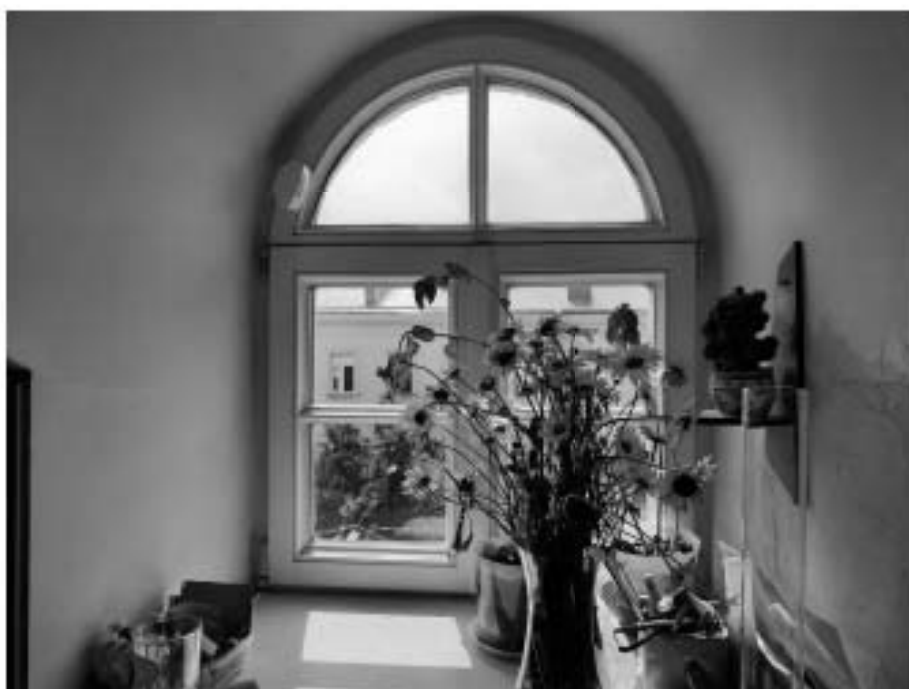
8. «Дом Боткина М.П.», ул. 18-я линия В.О., д.1, лит. А. Третий этаж. Помещение в осях 1-Ж. Оконное заполнение. Общий вид. Фото 22.06.2023г.
