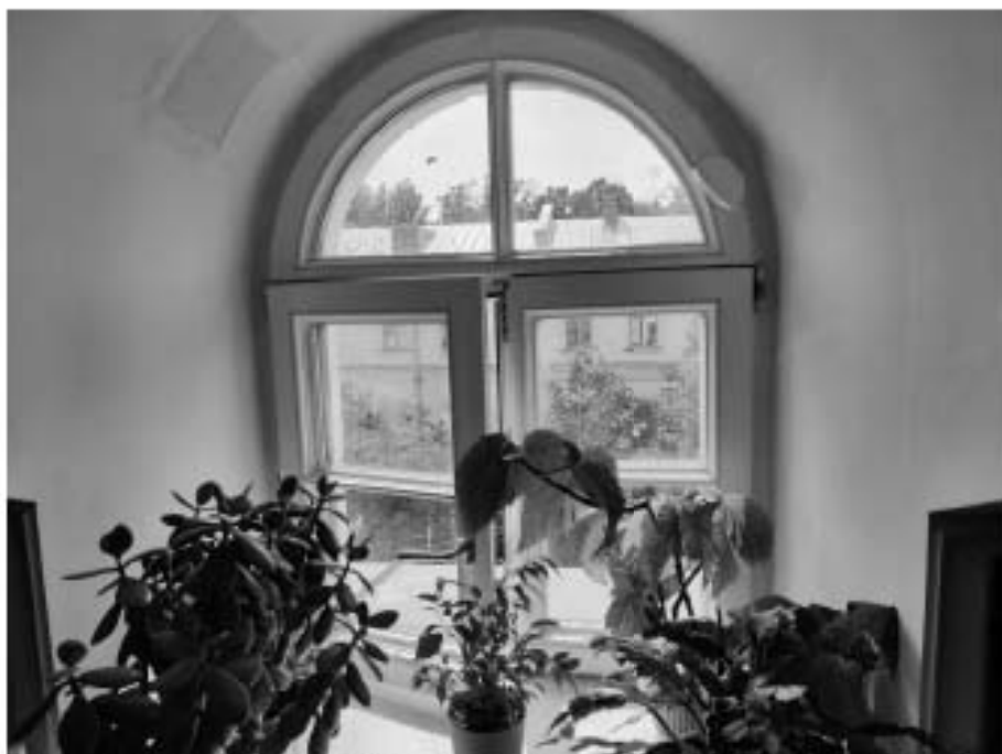
9. «Дом Боткина М.П.», ул. 18-я линия В.О., д.1, лит. А. Третий этаж. Помещение в осях 1-Д. Оконное заполнение. Общий вид. Фото 22.06.2023г.
