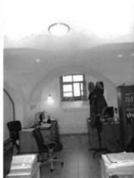
4. Свод цокольного этажа.
