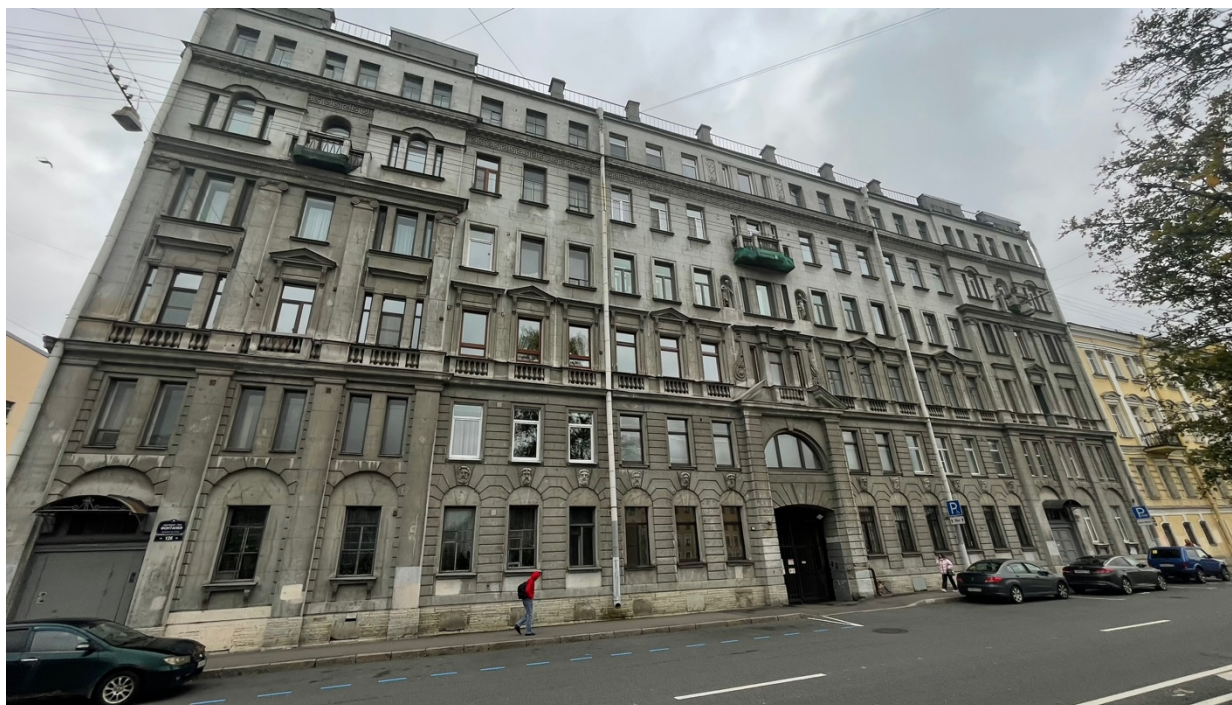
1. Вид на главный фасад выявленного объекта культурного наследия «Дом В.Г. и О.М.Чубаковых», расположенного по адресу: г. Санкт-Петербург, набережная реки Фонтанки, дом 126, литера А (Фонтанки р.наб., 126);
