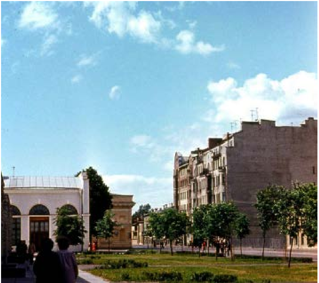
14. 1980 г. Вид на жилой дом по адресу: г. Санкт-Петербург, ул. Шпалерная, д. 44б, лит. А. Проектная документация на проведение работ по сохранению объекта культурного наследия регионального значения «Дом, в котором: в 1912-1913 гг. проходили совещания фракции большевиков IV Государственной думы и членов редакции газеты «Правда» (кв.32), в 1916-1917 гг. жил философ, писатель Розанов Василий Васильевич» (г. Санкт-Петербург, ул. Шпалерная, дом 44Б, литера А)
