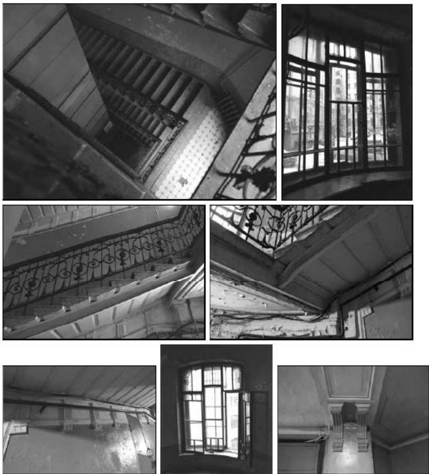
16. Парадная лестница 3 ЛК. Фрагменты интерьера.
