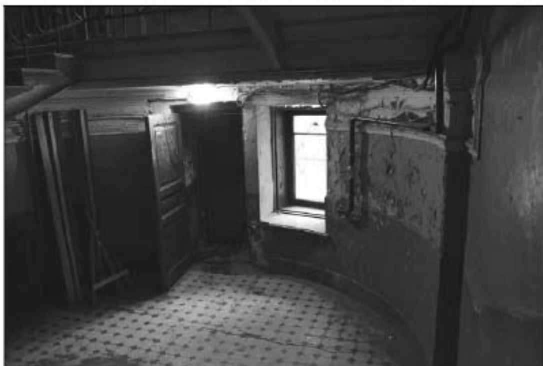
17. Парадная лестница 3 ЛК. Фрагменты интерьера.
