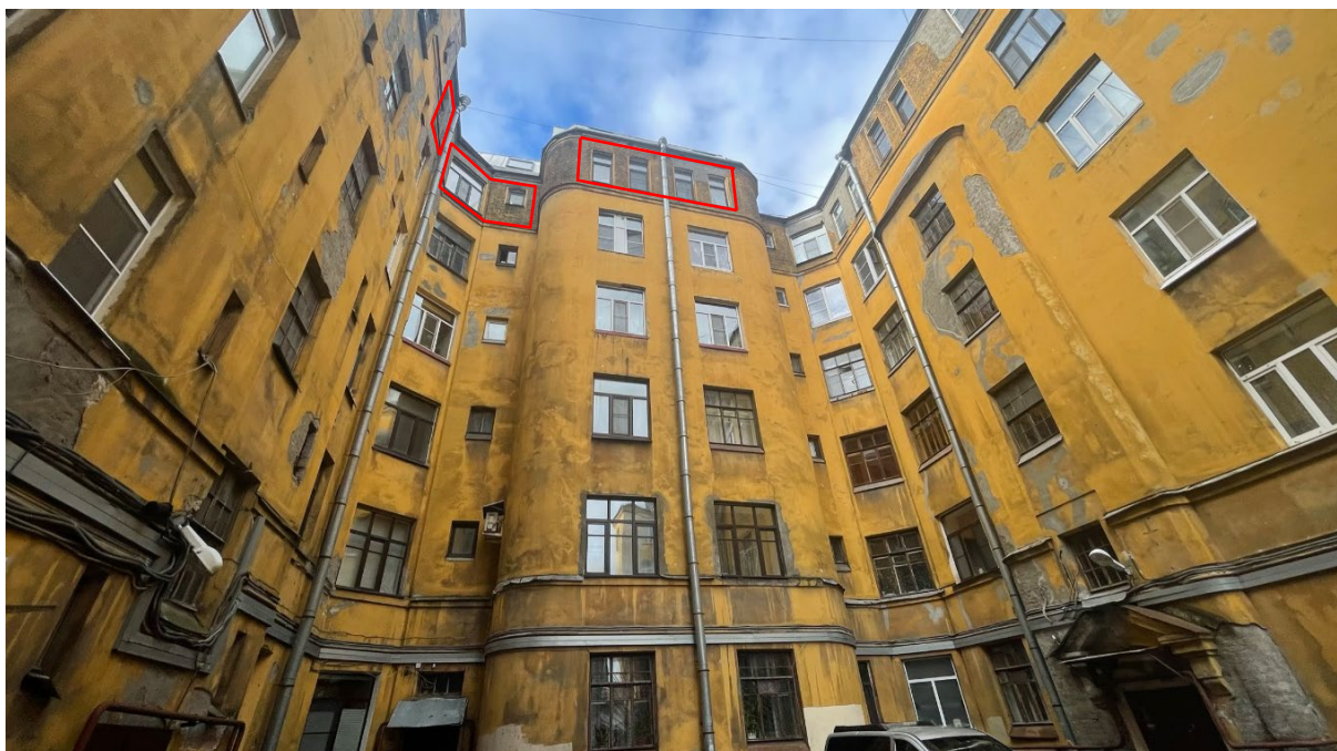
3. Вид на дворовые фасады дома №22
