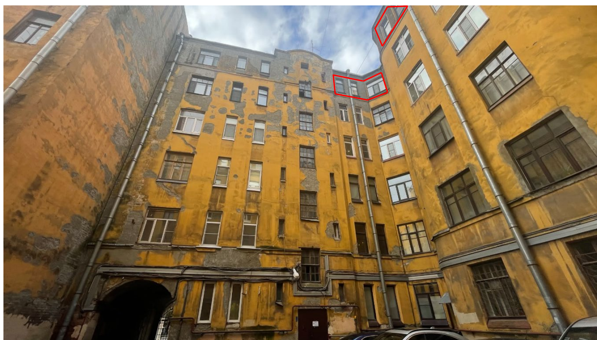
2. Вид на дворовые фасады дома №22
