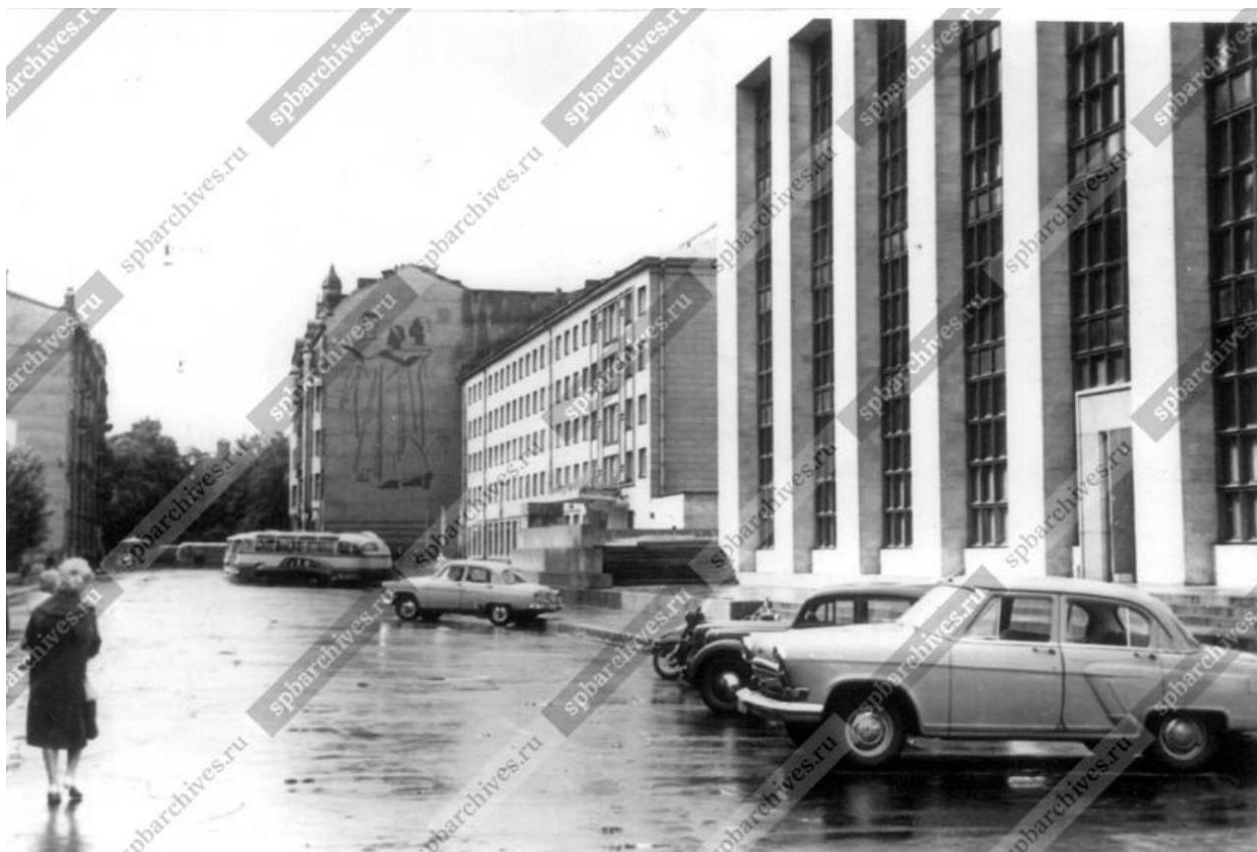
Илл. 51. Перспектива части улицы Чапыгина по линии домов № 6-2 справа налево: дом № 6 - здание Радиотелевизионного центра, дом №4 - гостиница "Дружба", дом №2 - бывший доходный дом А.Ф. Циммермана, архитектор Ф.И.Лидваль, 1906-1907 гг. // ЦГАКФФД СПб Бр 46270.
