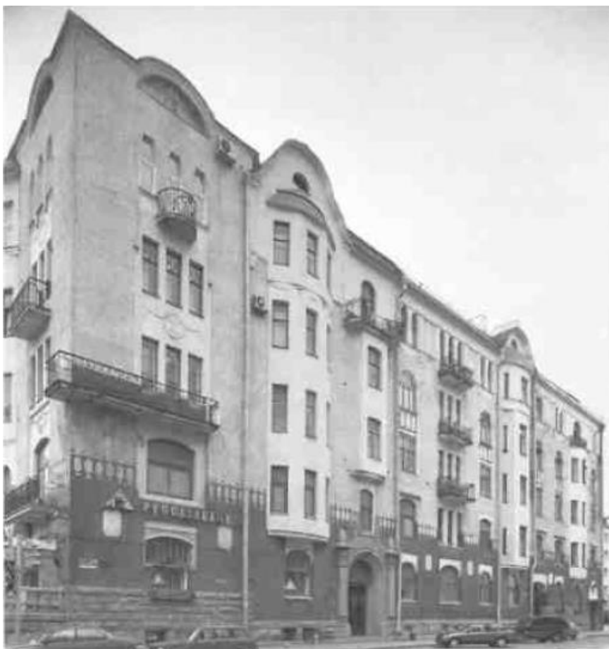
Илл. 62. Доходный дом А.Ф. Циммермана. Фрагмент фасада по ул. Чапыгина // Иллюстрация из книги Б.М. Кирикова «Архитектура Петербургского модерна. Особняки и доходные дома». 2012.
