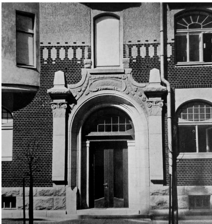
Илл. 67. Доходный дом А.Ф. Циммермана. Оформление дверного проема // https://www.citywalls.ru/
