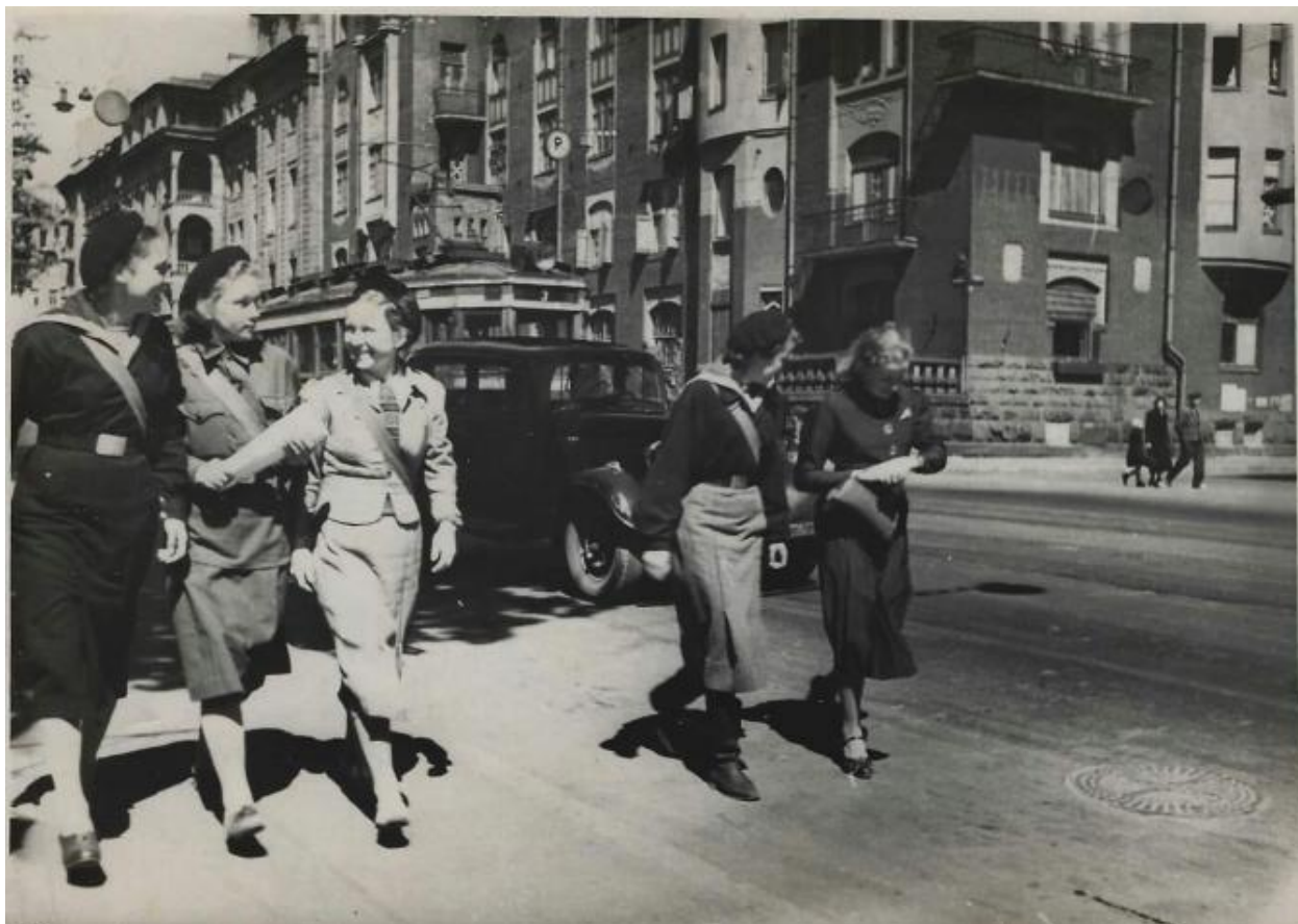
Илл. 42. Кировский проспект. Фрагмент фасада, 1941 г. // https://pastvu.com/
