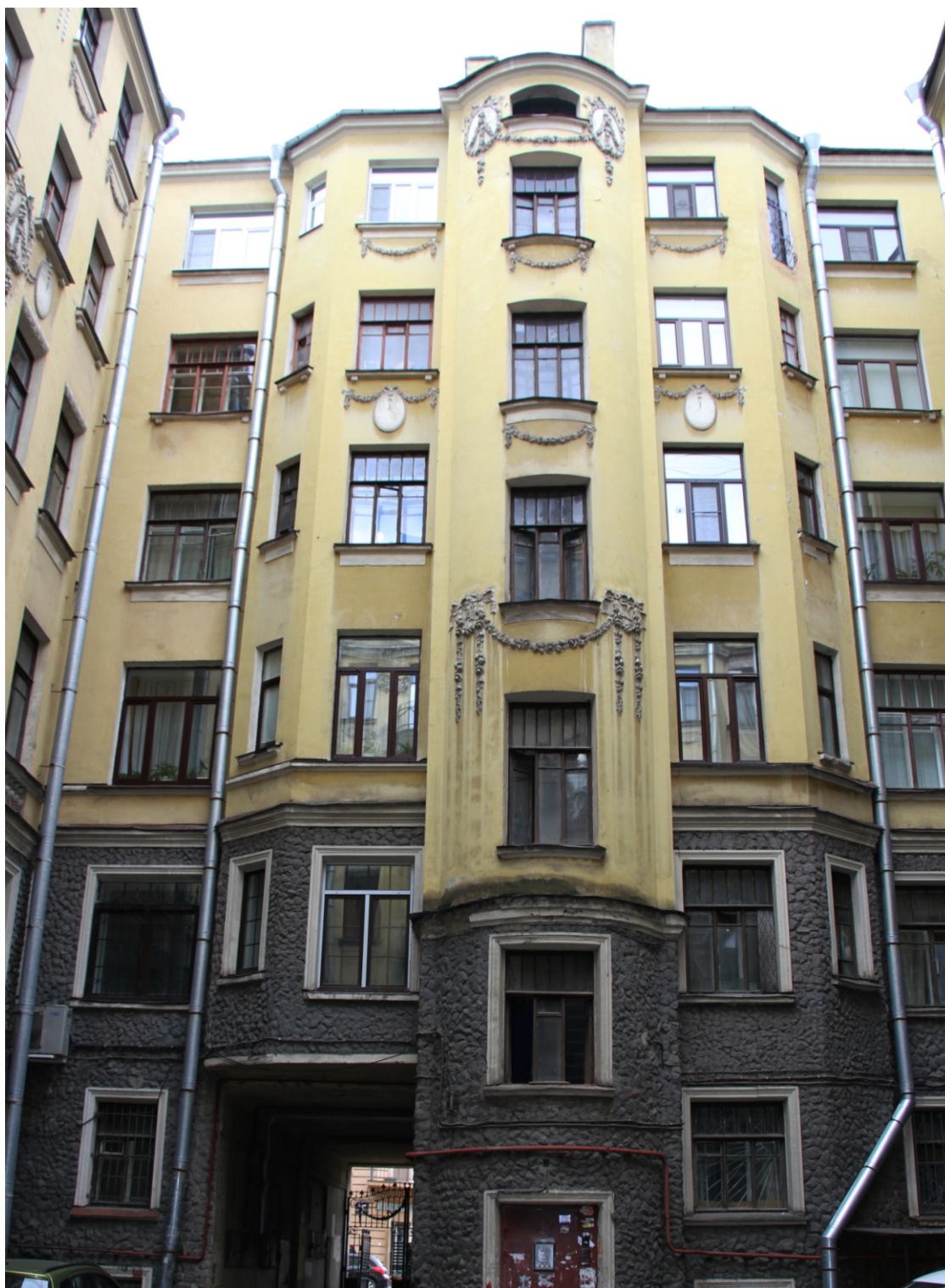
9. Дом Т.П. Павловой. Конная ул., 8, литера А. Фасад со стороны двора. Фото:20.10.2023.
