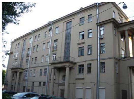
местоположение, габариты, конфигурация дверных (прямоугольные) и оконных (прямоугольные: два восьмигранных - в порталах парадных входов; два витражных - в прямоугольных нишах по осям лестниц) проемов;
