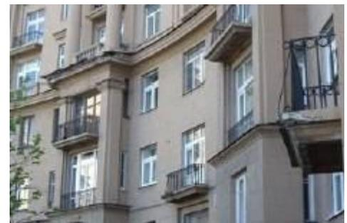
профилированный междуэтажный карниз большого выноса между 4 и 5 этажами;
