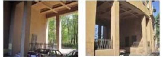
материал и характер отделки фасадной поверхности - терразитовая рустованная штукатурка;
