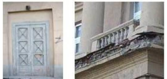
балконы – материал (металл) и рисунок балконных ограждений; балконы с балюстрадами (на уровне 5-го этажа), материал (армированный бетон и форма балясин);
