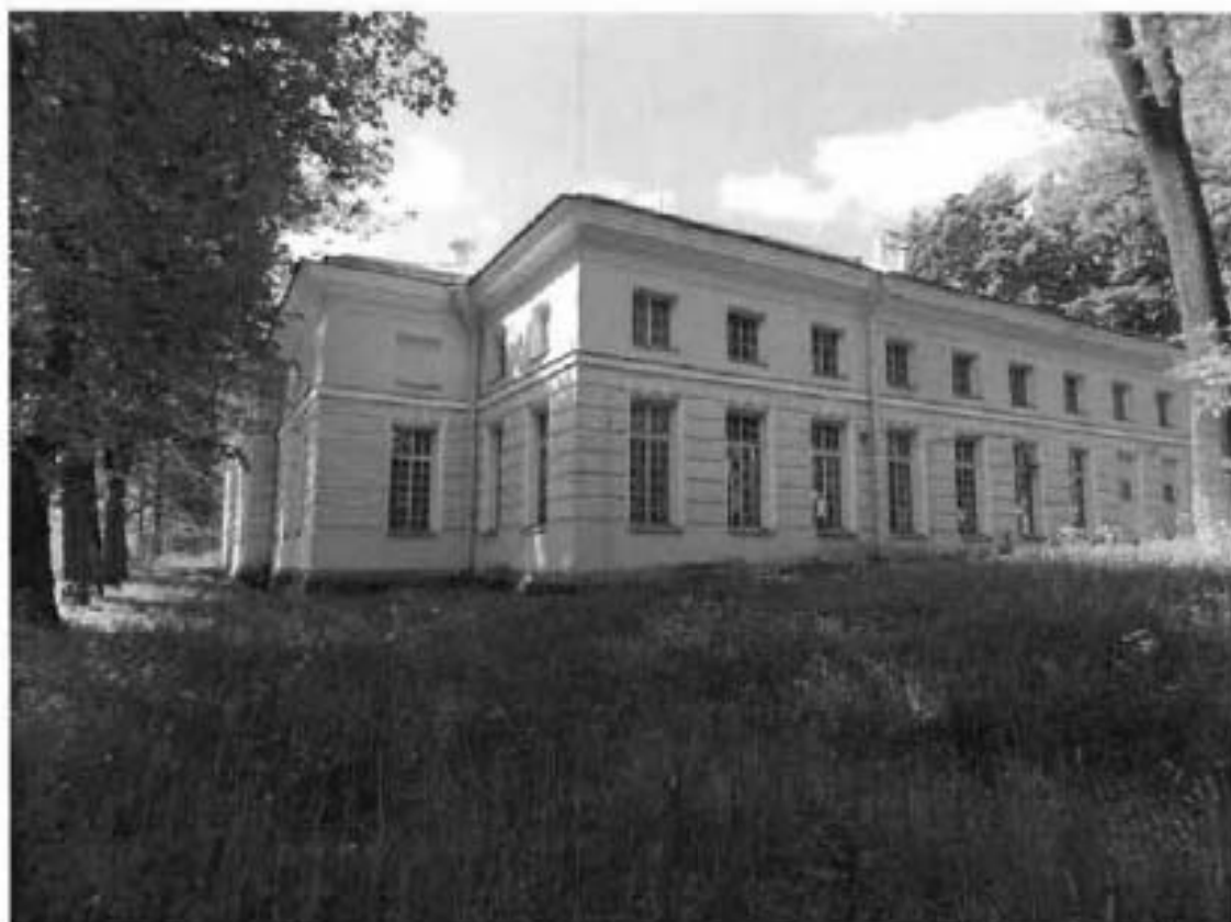
2. Вид со стороны северного фасада.
