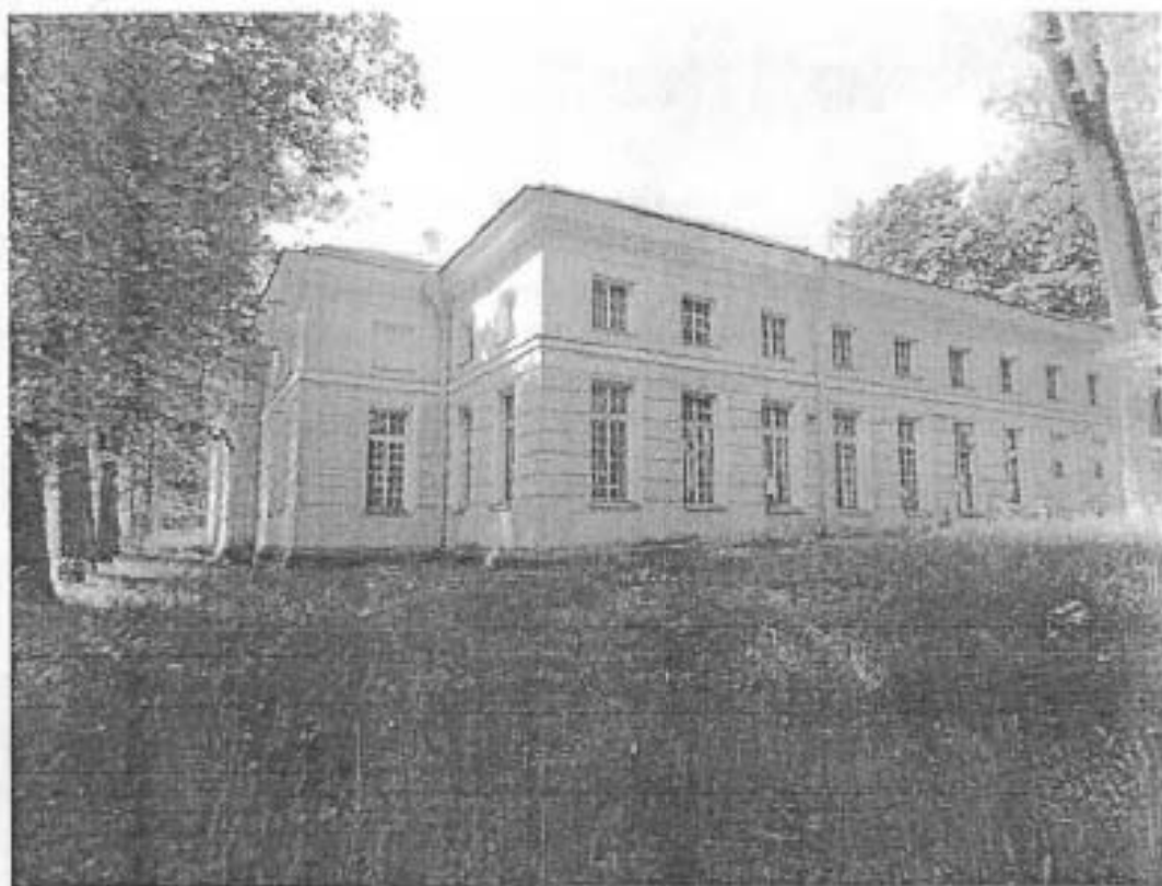
2. Вид со стороны северного фасада.
