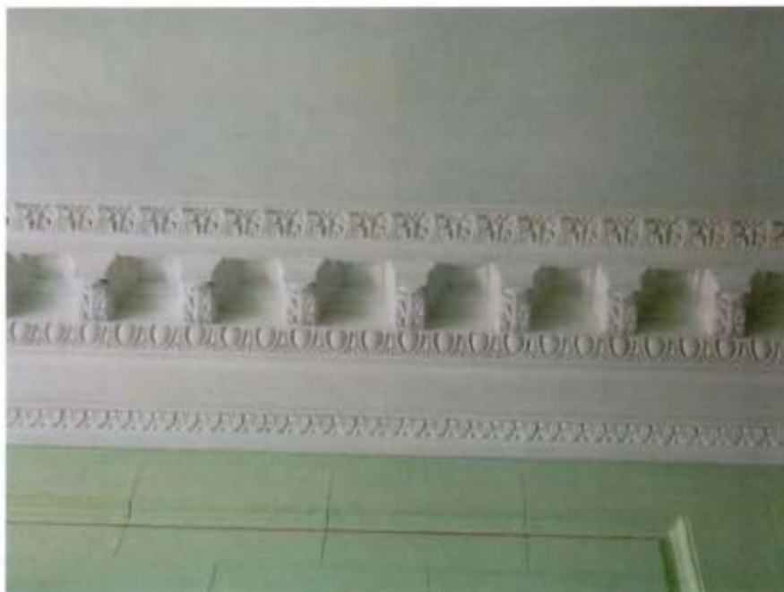
31. Венчающий карниз интерьера лестничного пролета
