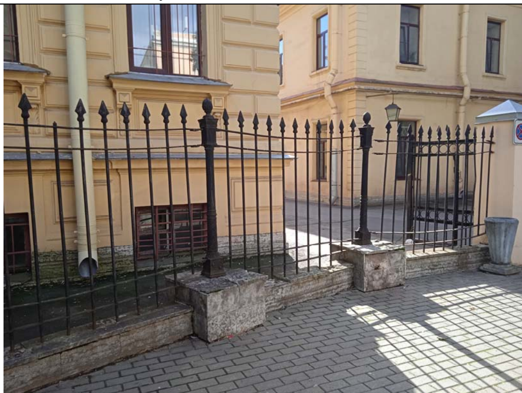
6. Особняк Горчакова К.А. Ограда по линии улицы. Фрагмент.
