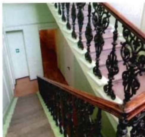
13. Лестница на 2 этаж
