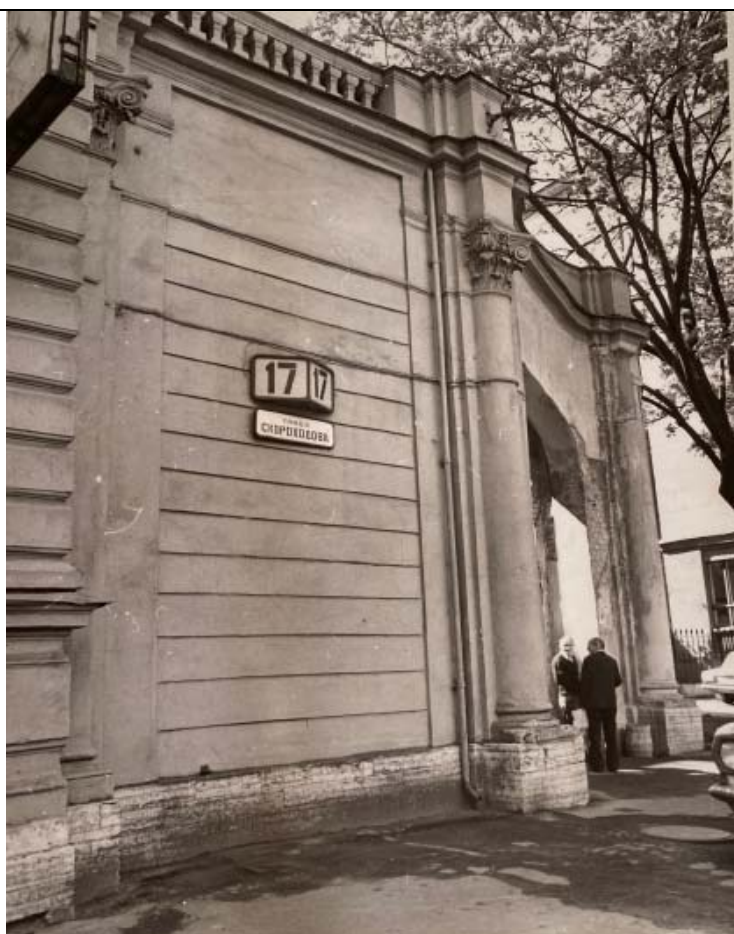
11. Фрагмент северного фасада. Фото 1991 г.
