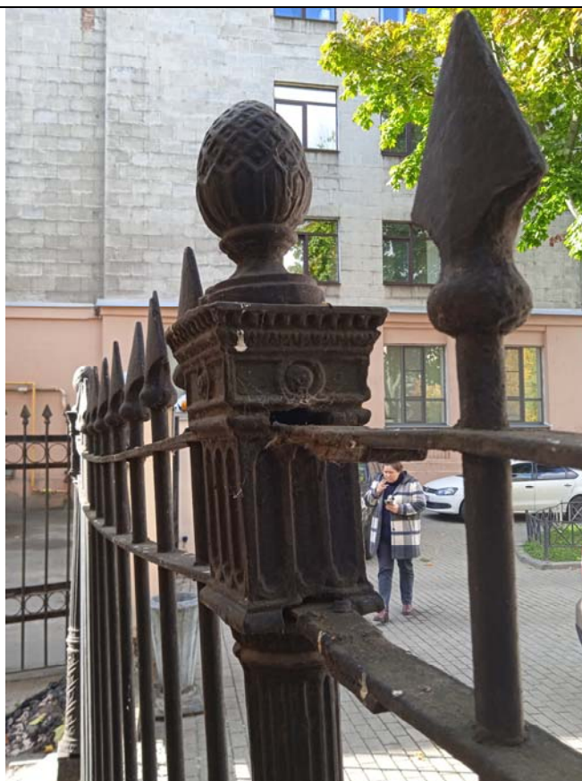
8. Особняк Горчакова К.А. Ограда по линии улицы. Фрагмент. Металлические столбики и пики.
