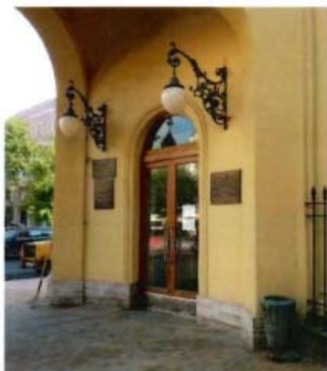
10. Вход в здание
