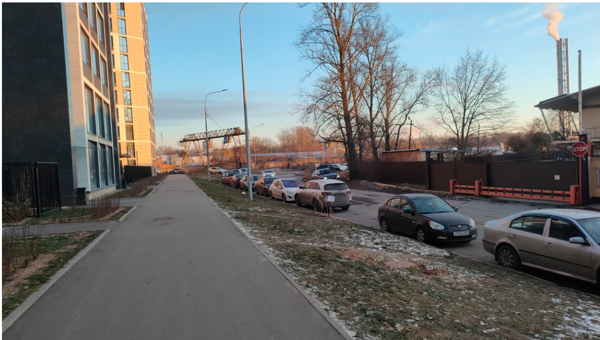
Точка фотофиксации 4. Общий вид восточной части территории обследования с ЗСЗ.
