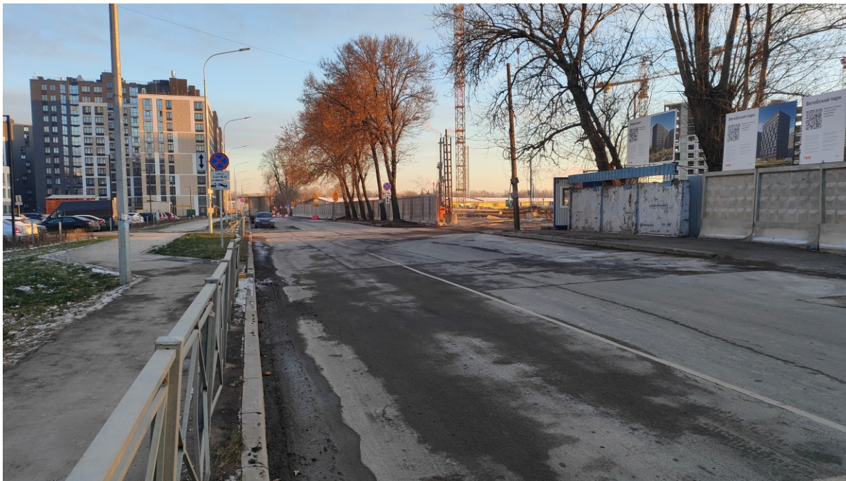
Точка фотофиксации 2. Общий вид западной части территории обследования с ЗСЗ.
