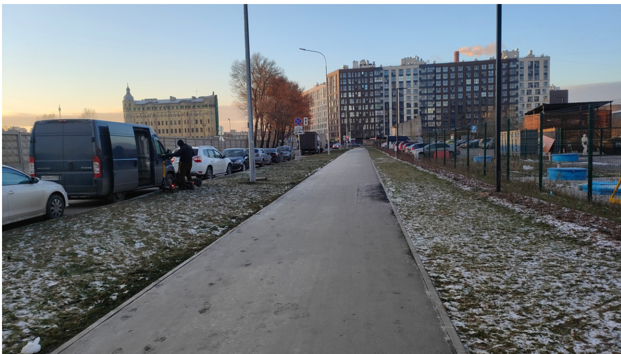
Точка фотофиксации 4. Общий вид центральной и западной части территории обследования с В.
