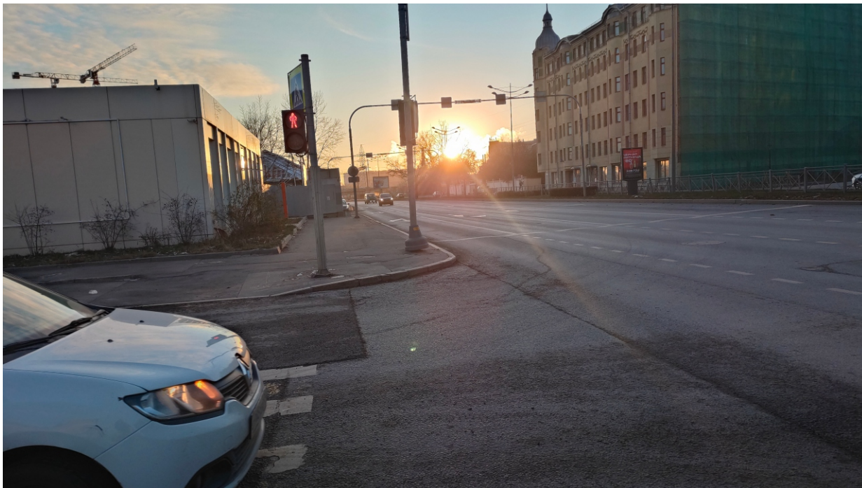
Точка фотофиксации 1. Северная часть участка. Пересечение ул. Тосина и Лиговского пр. Общий вид с СВ.
