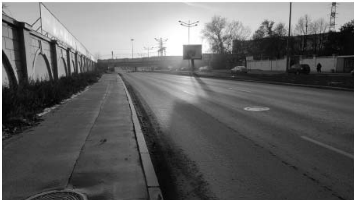
Точка фотофиксации 3. Общий вид северной части территории обследования с СВ. Лиговский пр.
