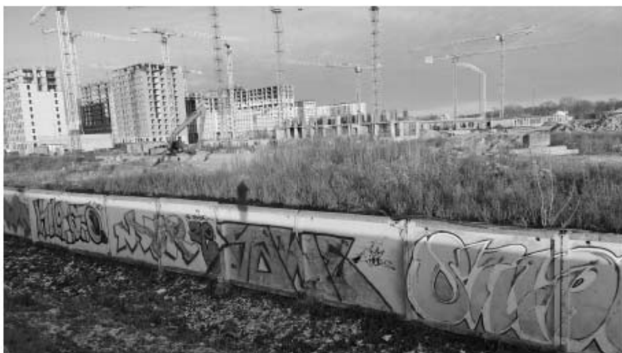
Точка фотофиксации 7. Общий вид центральной части территории обследования с ЮЗ. Строительная площадка жилого комплекса «Витебский парк».
