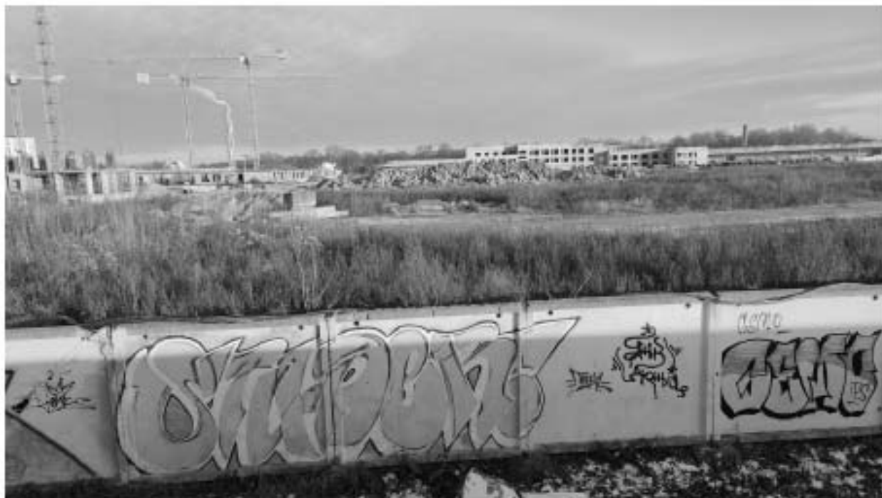
Точка фотофиксации 7. Общий вид центральной части территории обследования с 3. Строительная площадка жилого комплекса «Витебский парк».
