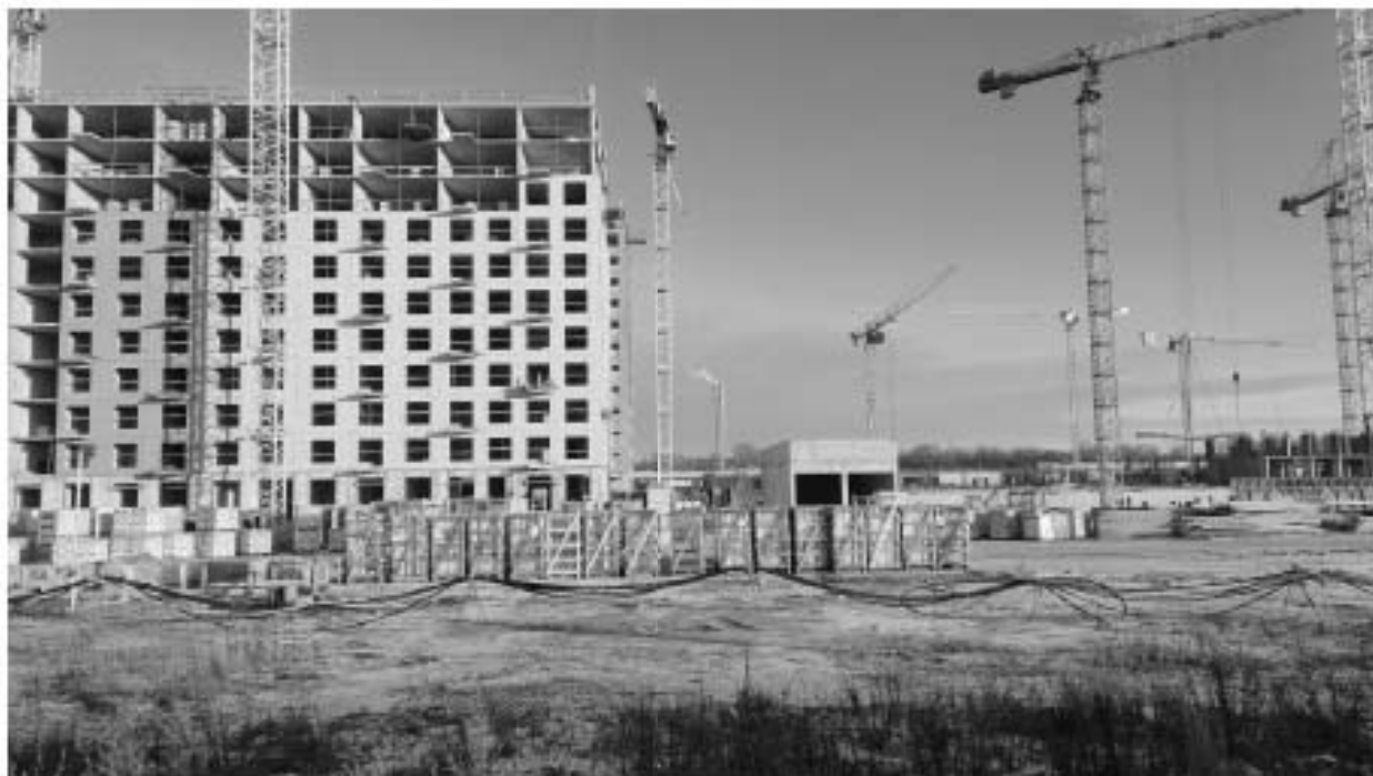
Точка фотофиксации 6. Общий вид центральной части территории обследования с З. Строительная площадка жилого комплекса «Витебский парк».
