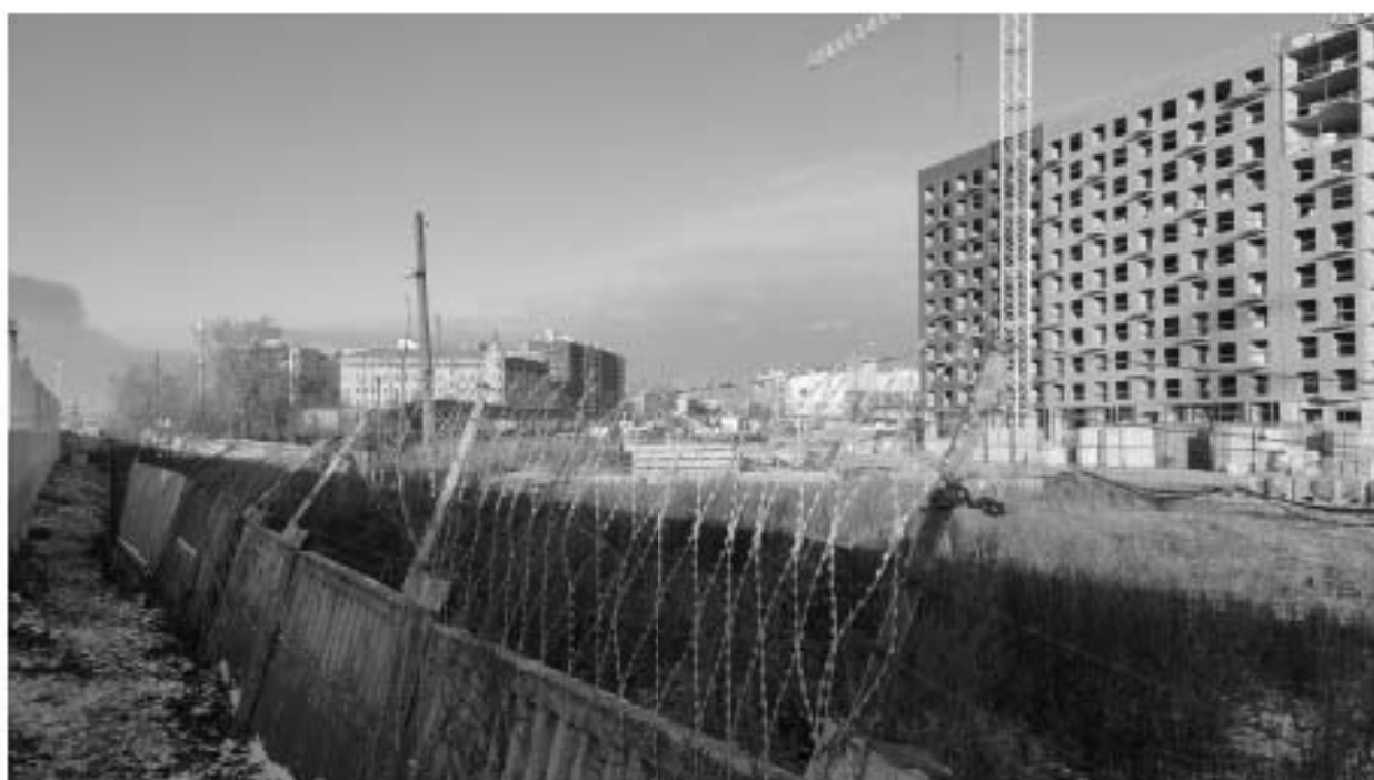
Точка фотофиксации 6. Общий вид центральной части территории обследования с Ю. Строительная площадка жилого комплекса «Витебский парк».
