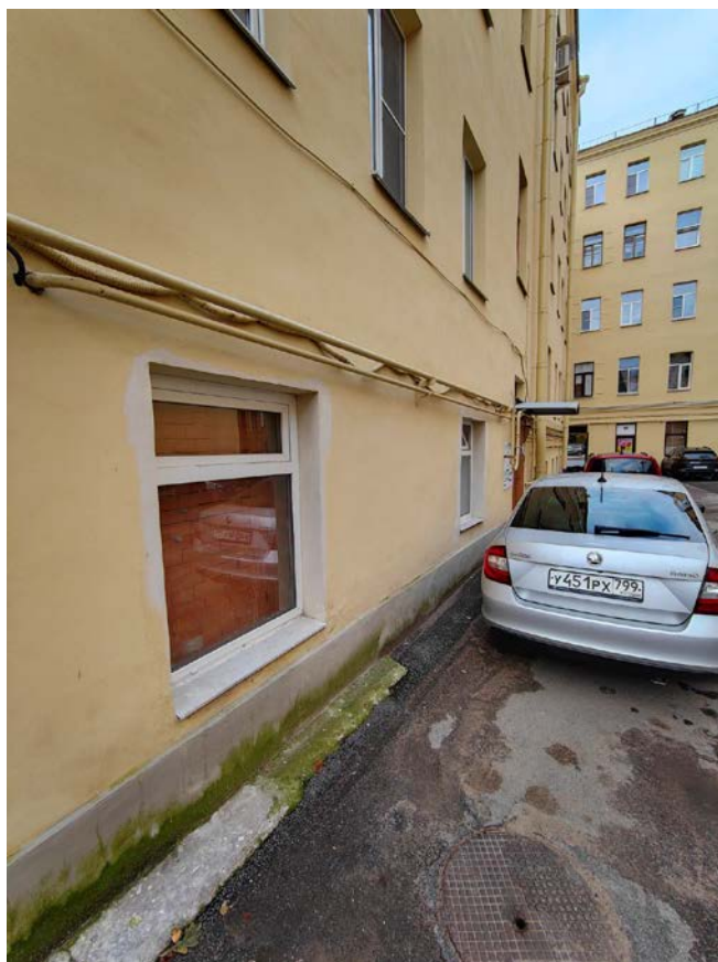
Фото 11. Фрагмент дворового фасада выявленного объекта культурного наследия «Дом В.Н. Зеленина», оконный проем пом. 2-Н
