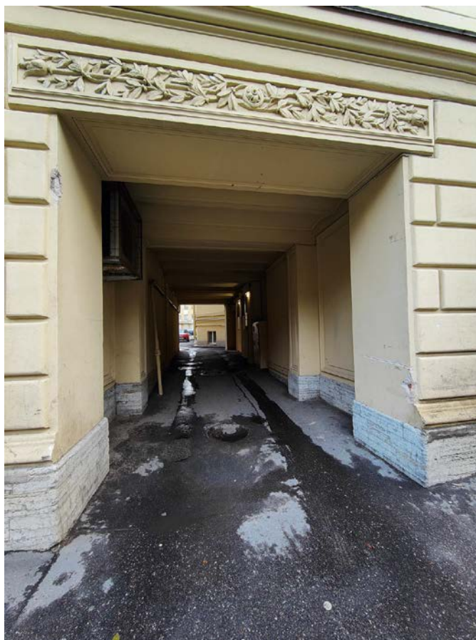
Фото 3. Фрагмент лицевого фасада выявленного объекта культурного наследия «Дом В.Н. Зеленина», воротный проезд
