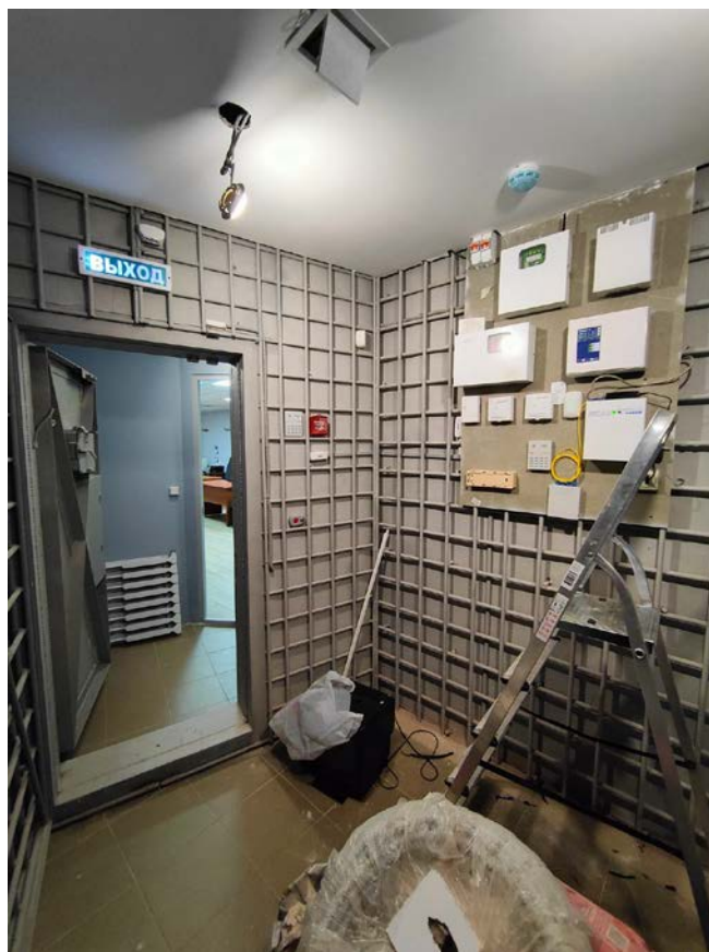
Фото 17. Интерьер пом. 2-Н выявленного объекта культурного наследия «Дом В.Н. Зеленина»
