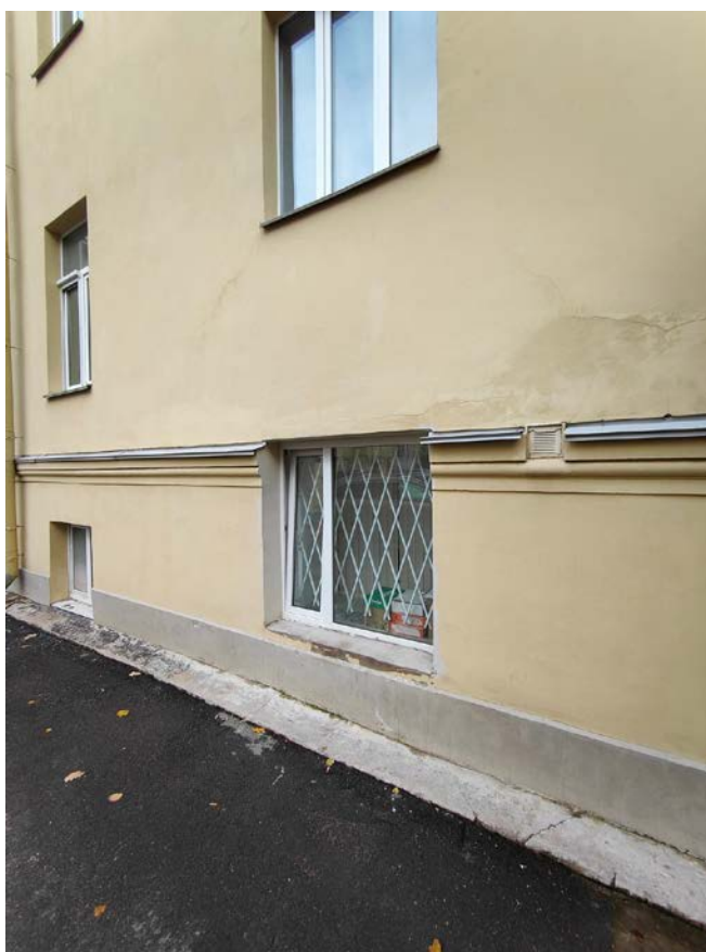
Фото 10. Фрагмент дворового фасада выявленного объекта культурного наследия «Дом В.Н. Зеленина», оконный проем пом. 2-Н
