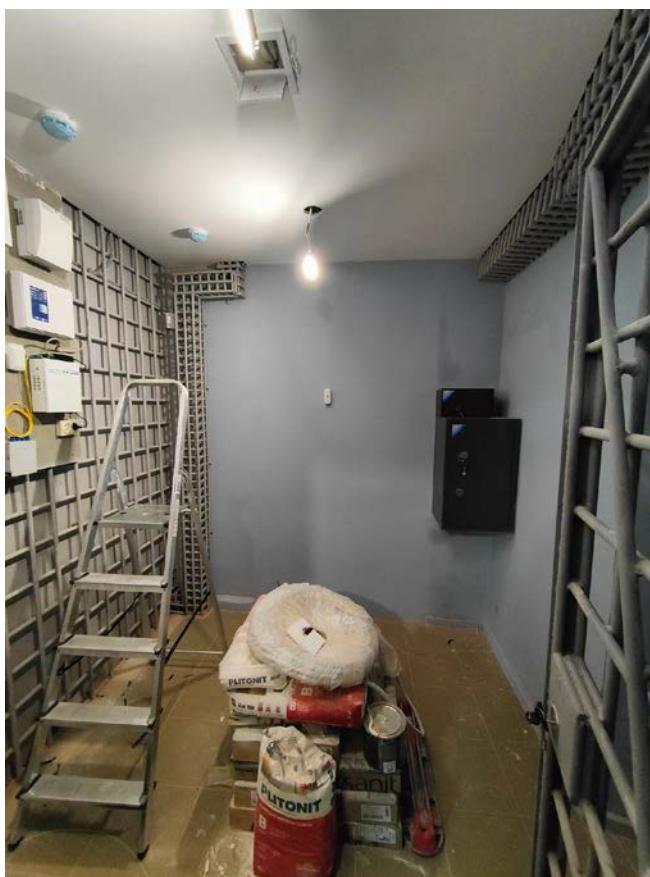
Фото 18. Интерьер пом. 2-Н выявленного объекта культурного наследия «Дом В.Н. Зеленина»
