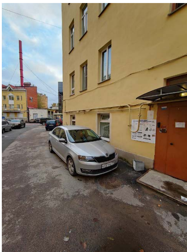
Фото 12. Фрагмент дворового фасада выявленного объекта культурного наследия «Дом В.Н. Зеленина», оконные проемы пом. 2-Н
