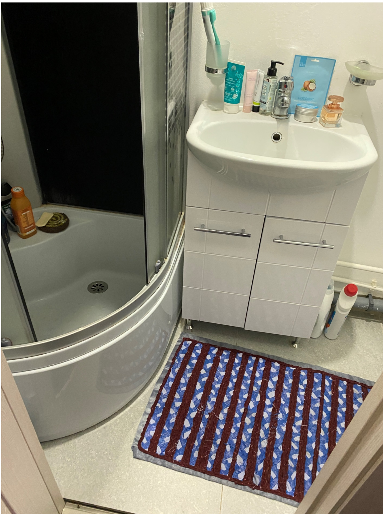
Фото 30. Вид на помещение квартиры № 21 объекта культурного наследия
