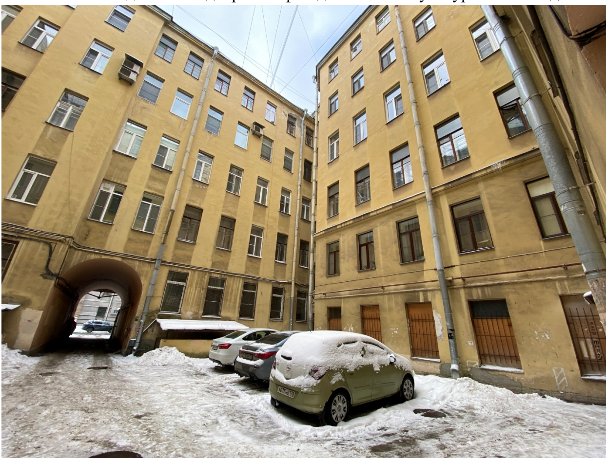
Фото 12. Вид на часть дворовых фасадов объекта культурного наследия
