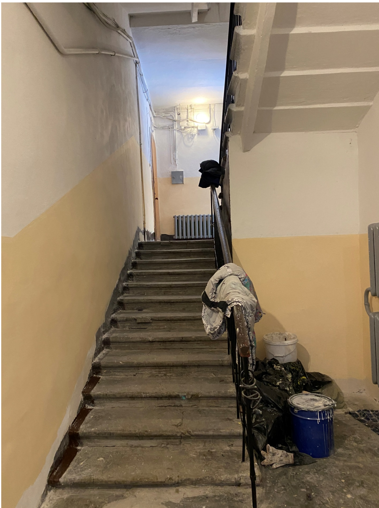
Фото 23. Общий вид лестницы объекта культурного наследия
