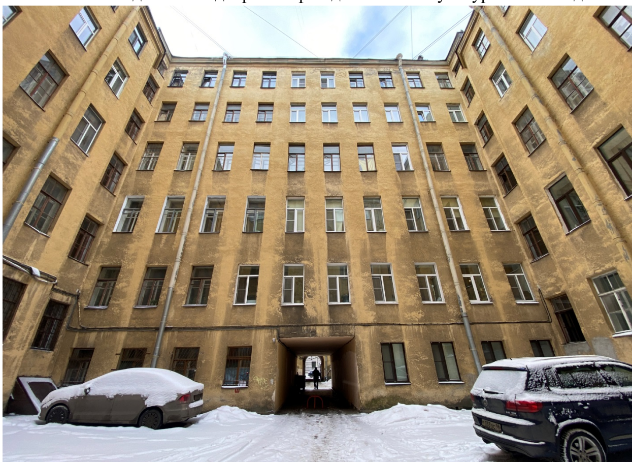
Фото 16. Вид на часть дворовых фасадов объекта культурного наследия
