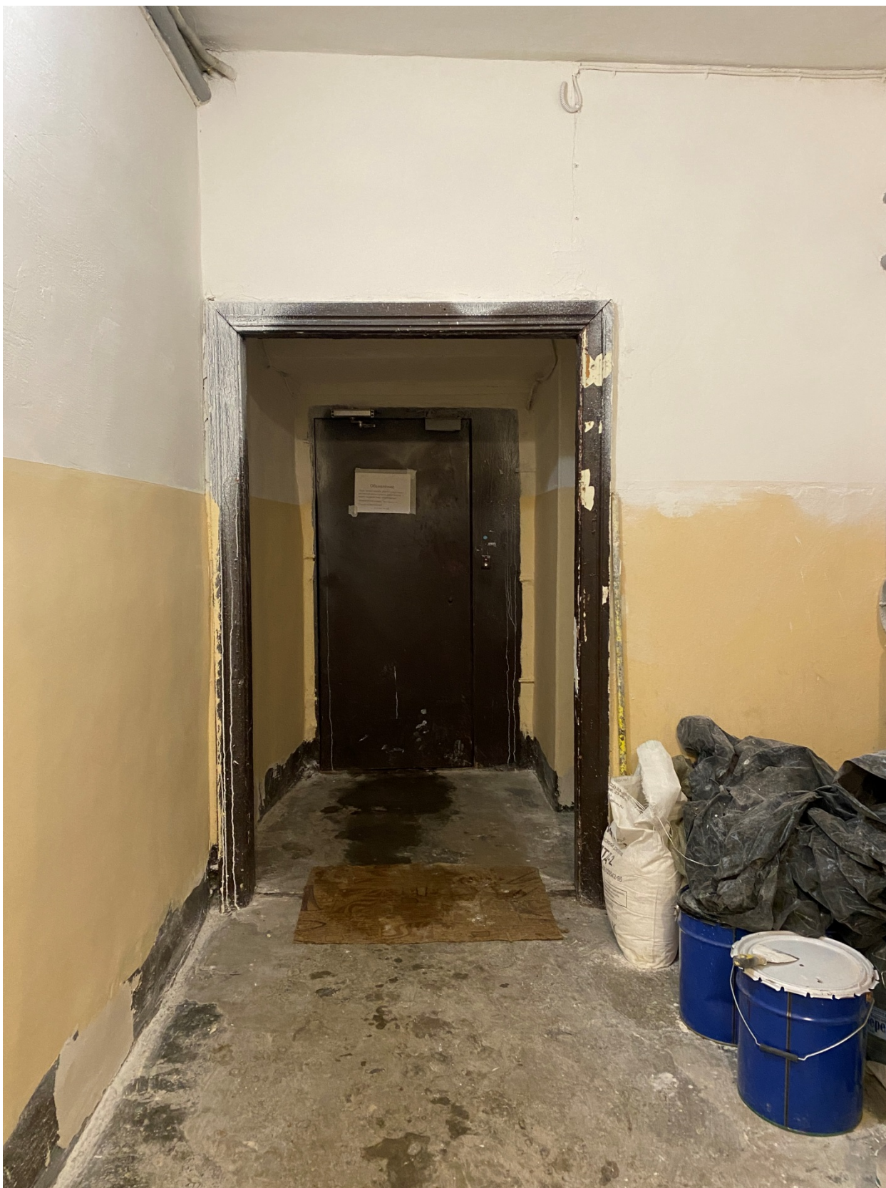
Фото 21. Общий вид парадной, ведущей в квартиру № 21, расположенную в части объекта культурного наследия
