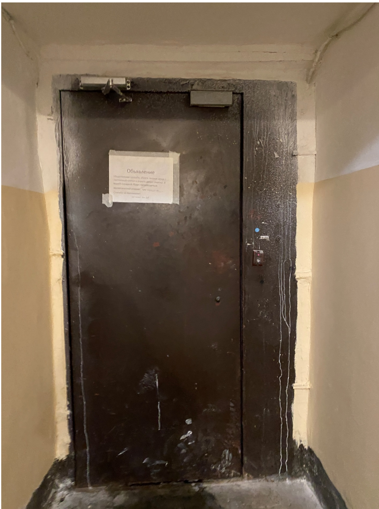
Фото 20. Вид на дверное заполнение из парадной, ведущей в квартиру № 21, расположенную в части объекта культурного наследия
