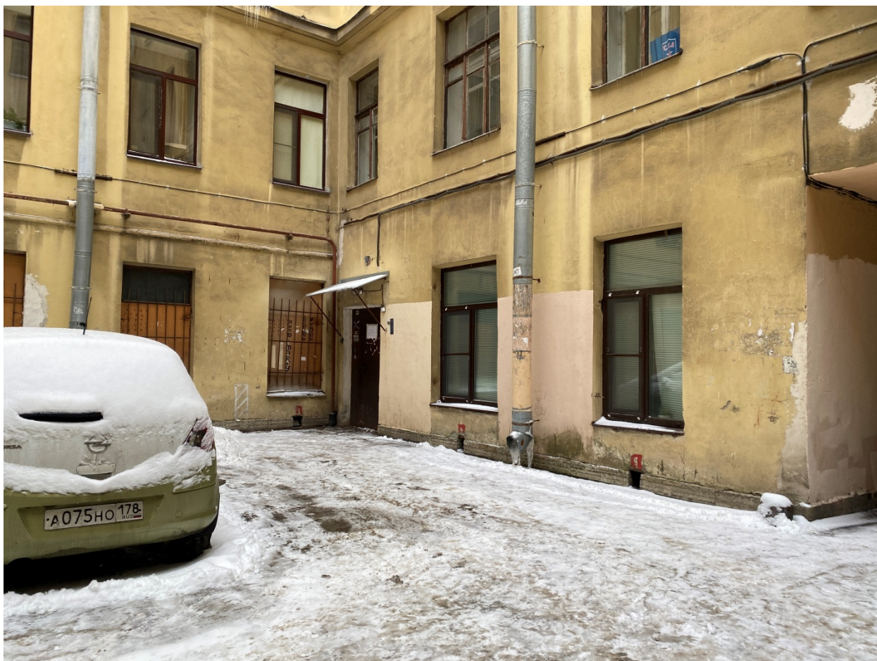
Фото 17. Вид на оконные заполнения и вход в парадную, ведущую в квартиру № 21, расположенную в части объекта культурного наследия
