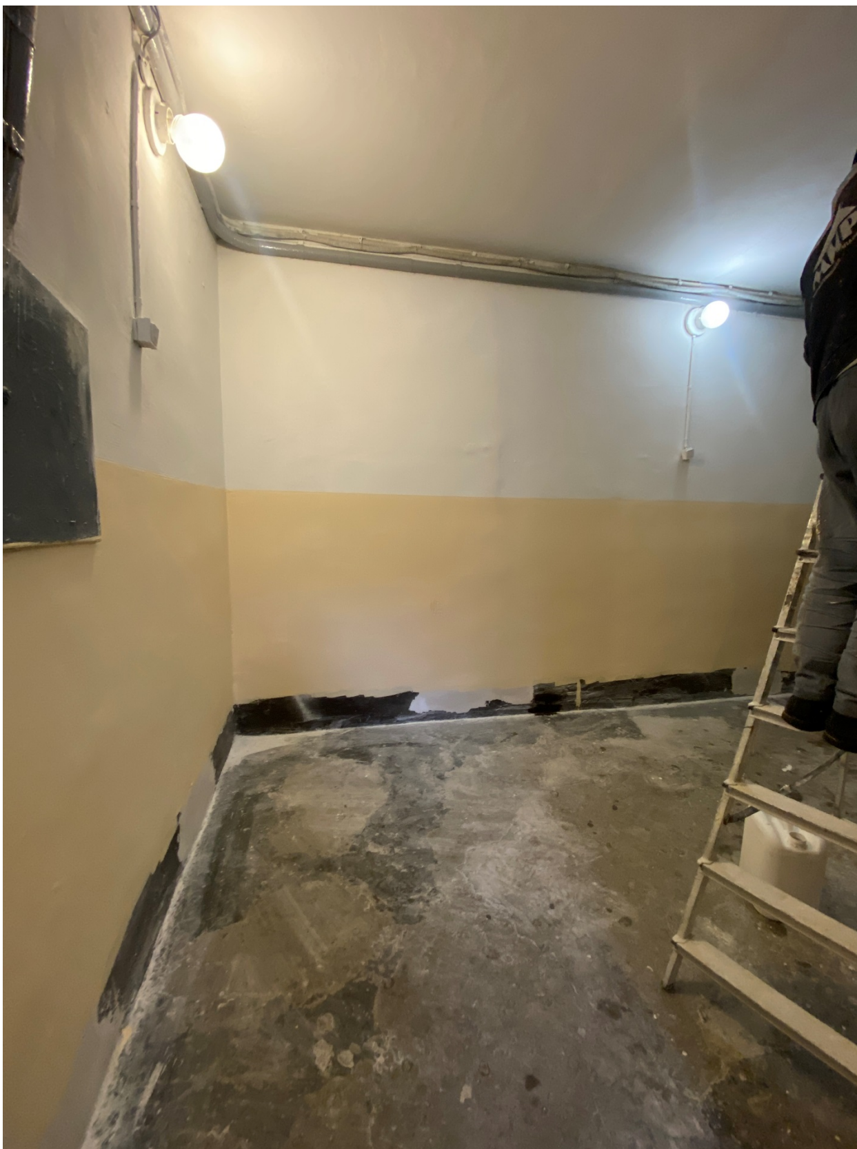
Фото 22. Общий вид парадной, ведущей в квартиру № 21, расположенную в части объекта культурного наследия
