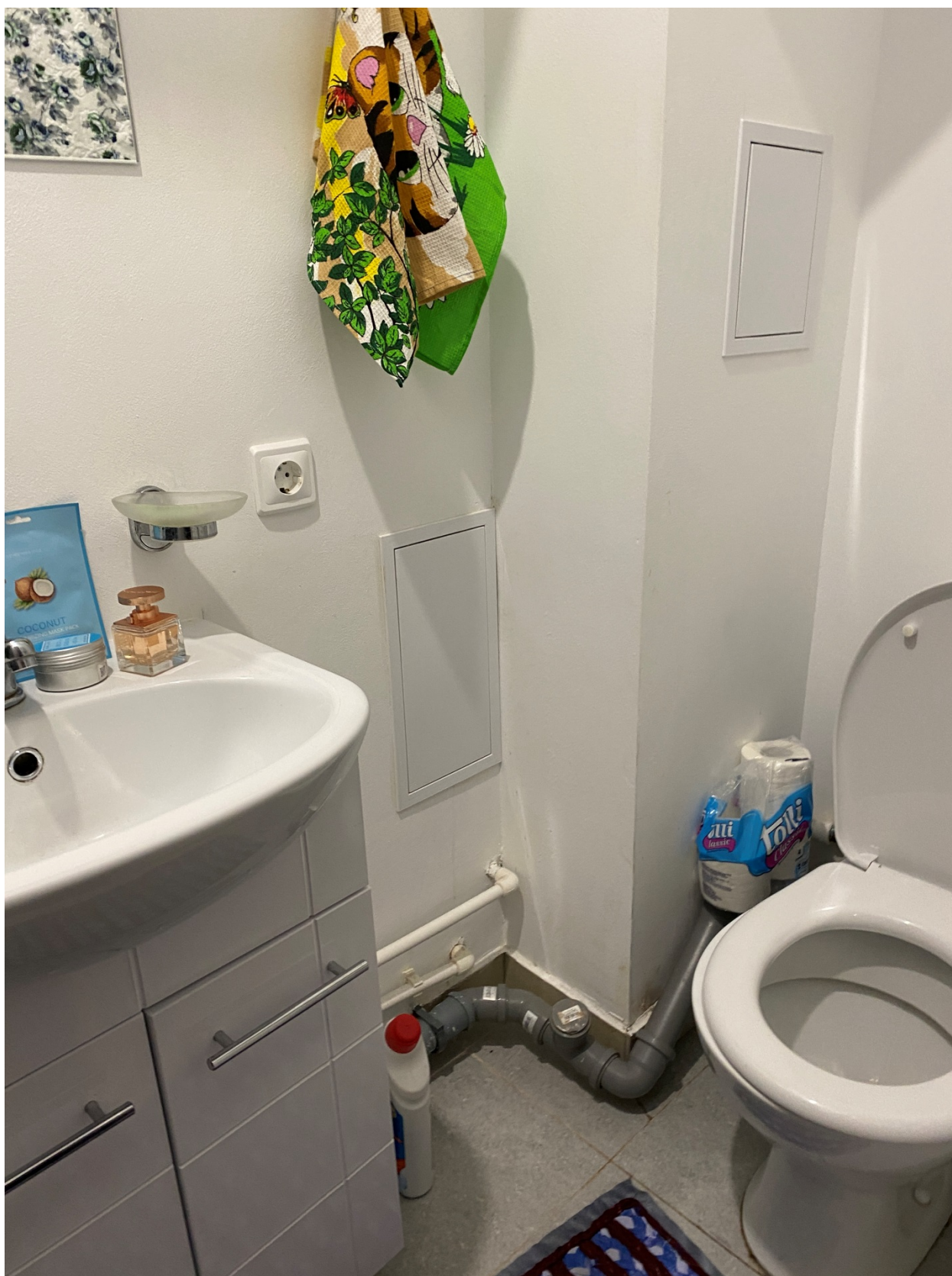
Фото 31. Вид на помещение квартиры № 21 объекта культурного наследия
