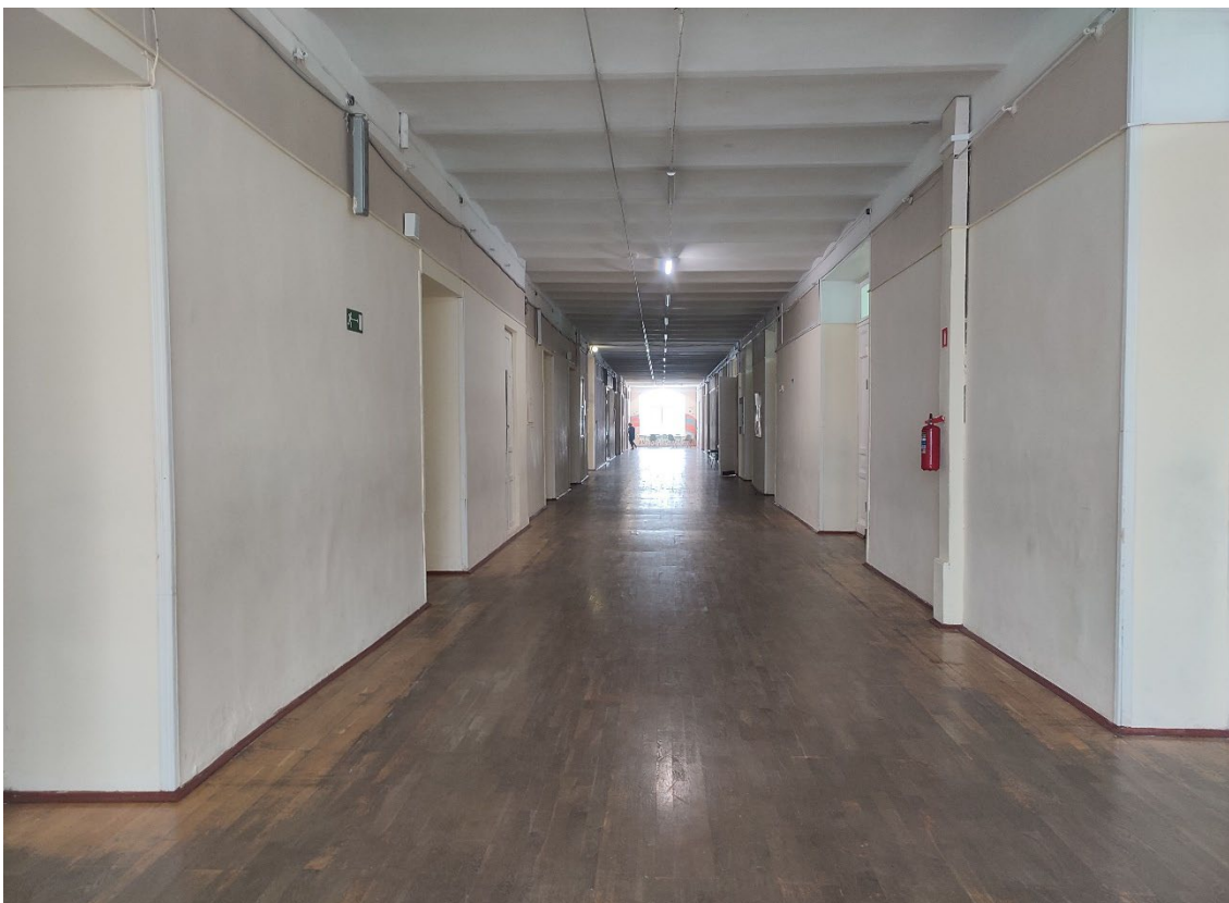
47. Объект культурного наследия регионального значения «Мужская гимназия с садом и оградой», расположенный по адресу: Санкт-Петербург, город Петергоф, Санкт-Петербургский проспект, дом 43, литера А. Общий вид пом. 2-Н (1) в уровне 2-го этажа.
