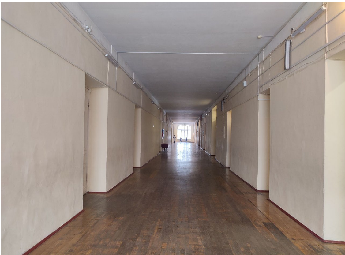
71. Объект культурного наследия регионального значения «Мужская гимназия с садом и оградой», расположенный по адресу: Санкт-Петербург, город Петергоф, Санкт-Петербургский проспект, дом 43, литера А. Общий вид пом. 3-Н (1) в уровне 3-го этажа.
