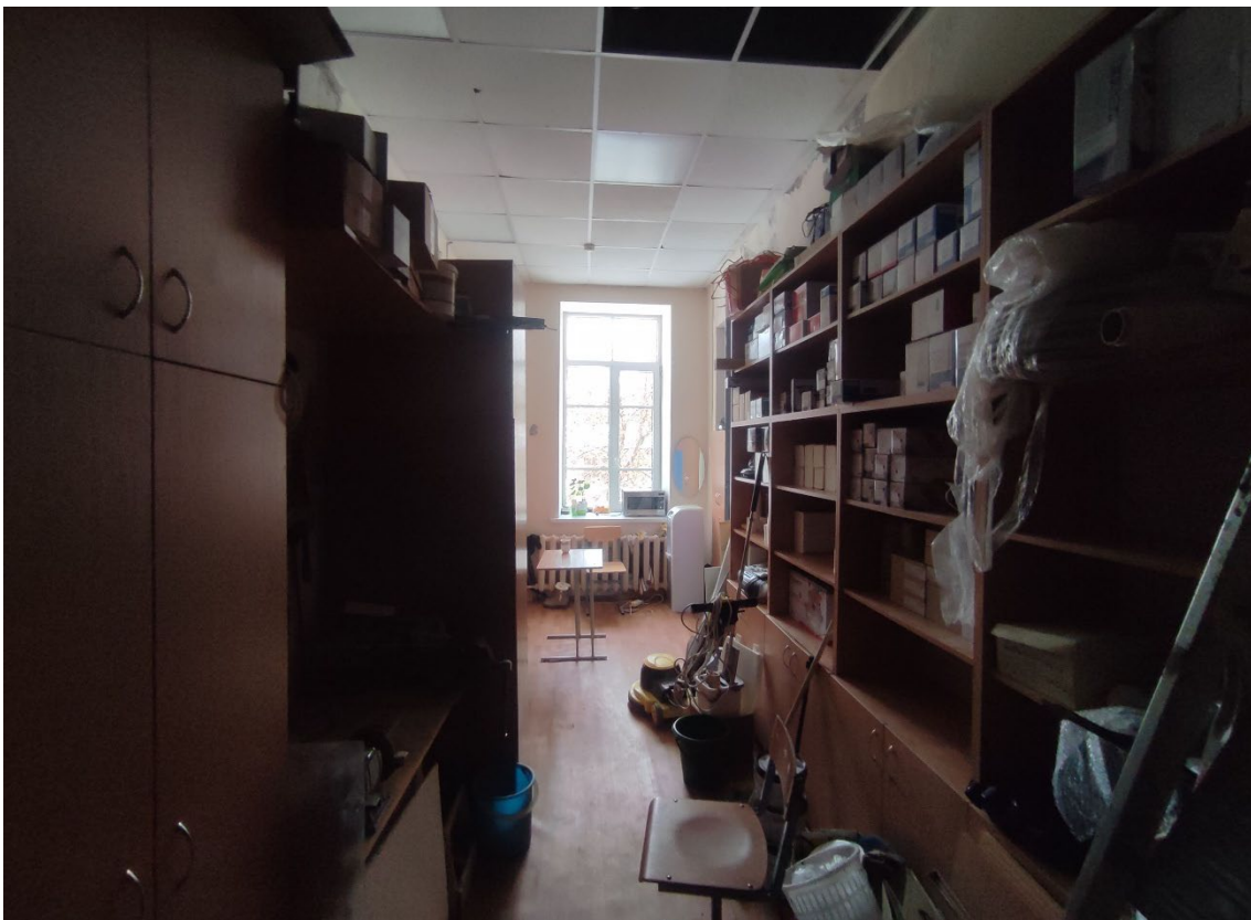
35. Объект культурного наследия регионального значения «Мужская гимназия с садом и оградой», расположенный по адресу: Санкт-Петербург, город Петергоф, Санкт-Петербургский проспект, дом 43, литера А. Общий вид пом. 2-Н (5) в уровне 2-го этажа.
