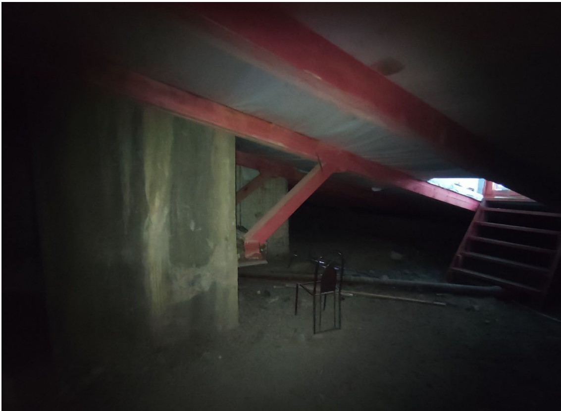
78. Объект культурного наследия регионального значения «Мужская гимназия с садом и оградой», расположенный по адресу: Санкт-Петербург, город Петергоф, Санкт-Петербургский проспект, дом 43, литера А. Фрагмент стропильной системы крыши здания.
