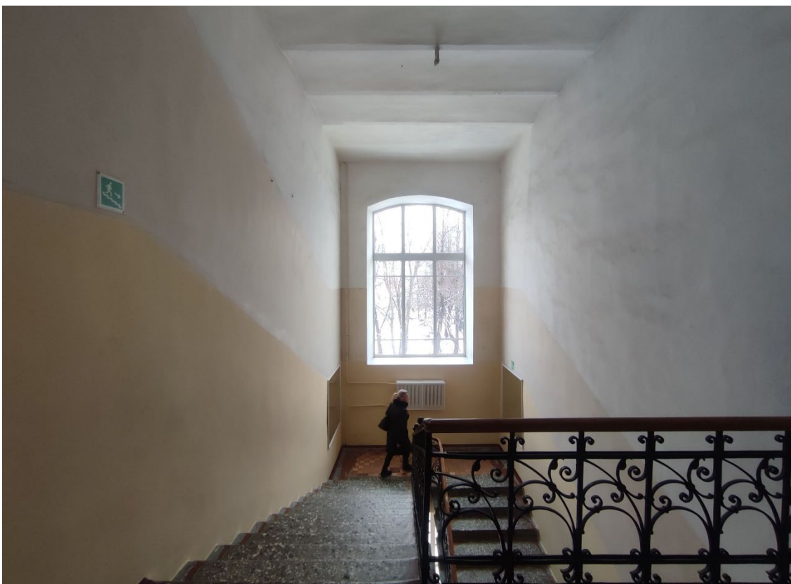
56. Объект культурного наследия регионального значения «Мужская гимназия с садом и оградой», расположенный по адресу: Санкт-Петербург, город Петергоф, Санкт-Петербургский проспект, дом 43, литера А. Общий вид парадной лестницы (пом. VIII) в уровне 3-го этажа.
