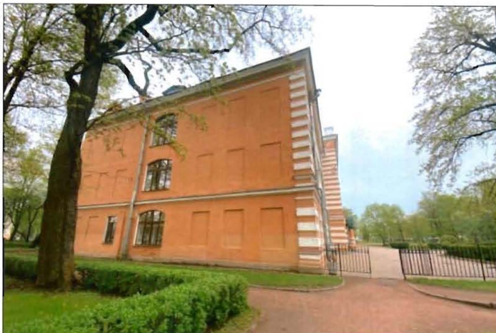
3. Общий вид на объект культурного наследия с западной стороны.
