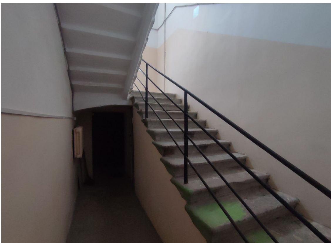
31. Объект культурного наследия регионального значения «Мужская гимназия с садом и оградой», расположенный по адресу: Санкт-Петербург, город Петергоф, Санкт-Петербургский проспект, дом 43, литера А. Общий вид служебной двухмаршевой лестницы (пом. V) в уровне 1-го этажа.
