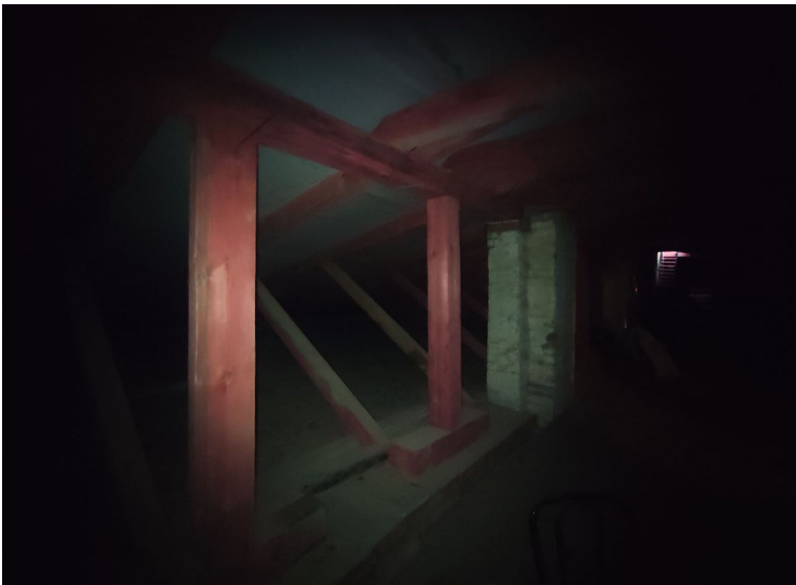
79. Объект культурного наследия регионального значения «Мужская гимназия с садом и оградой», расположенный по адресу: Санкт-Петербург, город Петергоф, Санкт-Петербургский проспект, дом 43, литера А. Фрагмент стропильной системы крыши здания.
