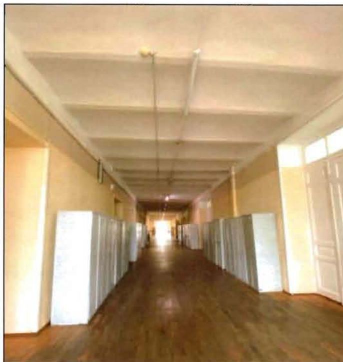
9. Сводчатые перекрытия по металлическим балкам в коридоре в уровне 1-го этажа.
