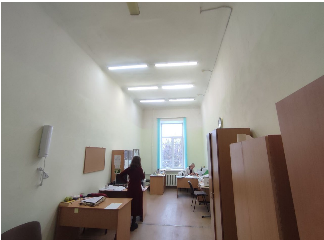
70. Объект культурного наследия регионального значения «Мужская гимназия с садом и оградой», расположенный по адресу: Санкт-Петербург, город Петергоф, Санкт-Петербургский проспект, дом 43, литера А. Общий вид пом. 3-Н (15) в уровне 3-го этажа.
