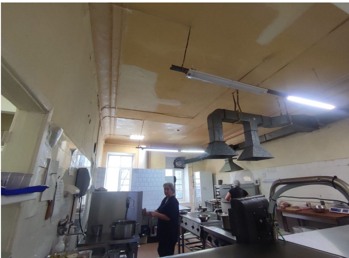
22. Объект культурного наследия регионального значения «Мужская гимназия с садом и оградой», расположенный по адресу: Санкт-Петербург, город Петергоф, Санкт-Петербургский проспект, дом 43, литера А. Общий вид пом. 1-Н (15) в уровне 1-го этажа.
