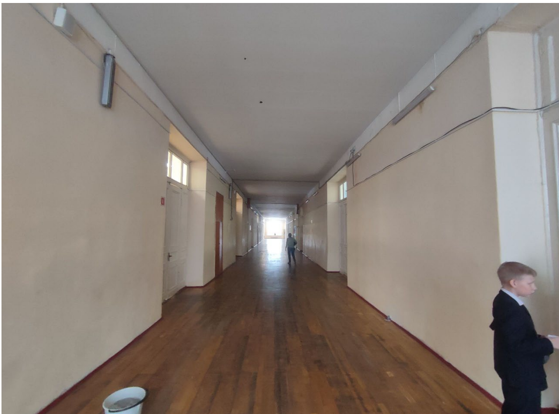
62. Объект культурного наследия регионального значения «Мужская гимназия с садом и оградой», расположенный по адресу: Санкт-Петербург, город Петергоф, Санкт-Петербургский проспект, дом 43, литера А. Общий вид пом. 3-Н (1) в уровне 3-го этажа.
