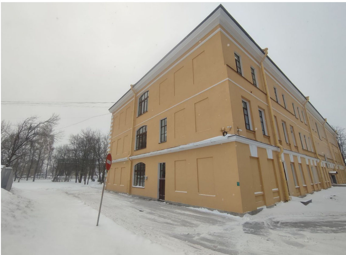
6. Объект культурного наследия регионального значения «Мужская гимназия с садом и оградой», расположенный по адресу: Санкт-Петербург, город Петергоф, Санкт-Петербургский проспект, дом 43, литера А. Общий вид восточного торцевого фасада.
