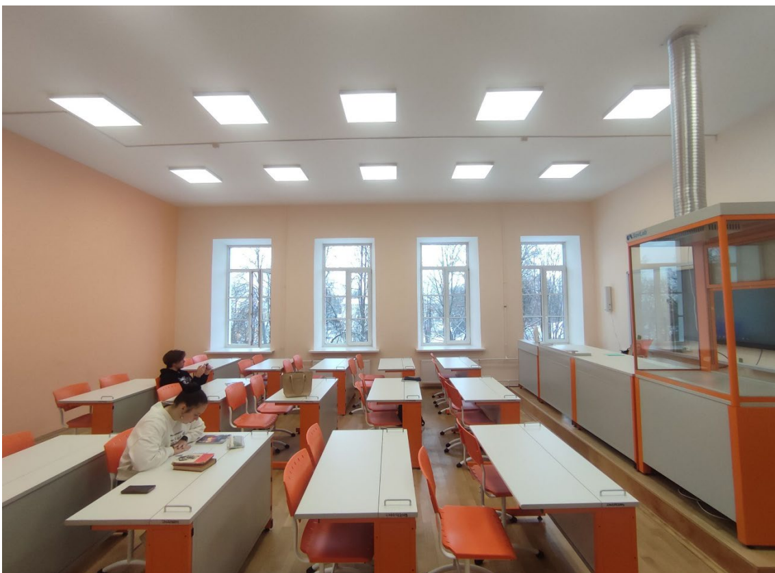
59. Объект культурного наследия регионального значения «Мужская гимназия с садом и оградой», расположенный по адресу: Санкт-Петербург, город Петергоф, Санкт-Петербургский проспект, дом 43, литера А. Общий вид пом. 3-Н (24) в уровне 3-го этажа.
