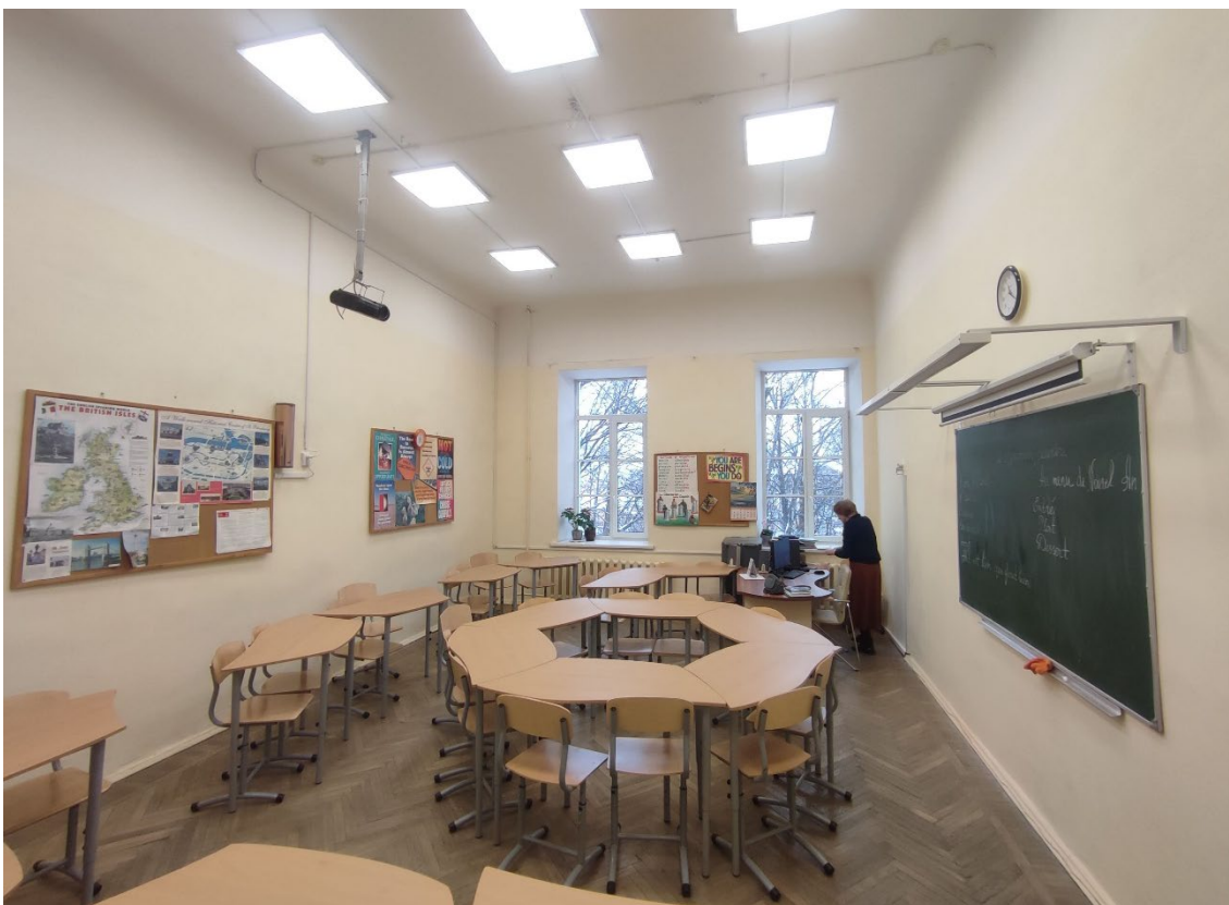
61. Объект культурного наследия регионального значения «Мужская гимназия с садом и оградой», расположенный по адресу: Санкт-Петербург, город Петергоф, Санкт-Петербургский проспект, дом 43, литера А. Общий вид пом. 3-Н (22) в уровне 3-го этажа.
