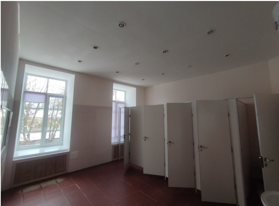
34. Объект культурного наследия регионального значения «Мужская гимназия с садом и оградой», расположенный по адресу: Санкт-Петербург, город Петергоф, Санкт-Петербургский проспект, дом 43, литера А. Общий вид пом. 2-Н (7) в уровне 2-го этажа.
