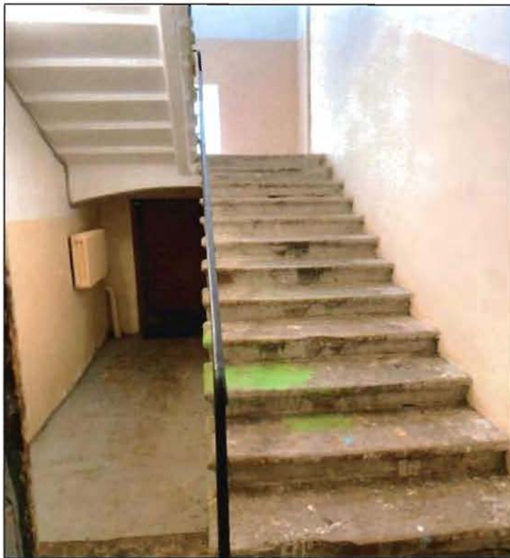
11. Двухмаршевая лестница в восточной части объекта культурного наследия.
