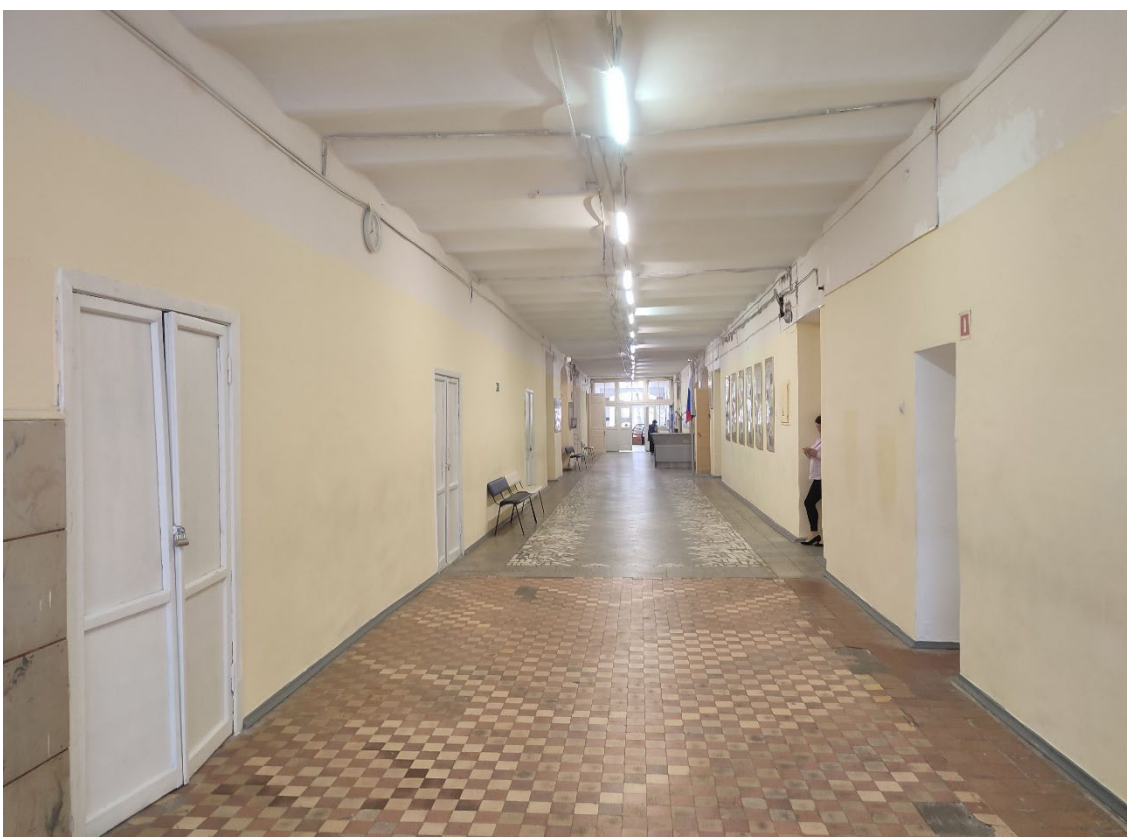
27. Объект культурного наследия регионального значения «Мужская гимназия с садом и оградой», расположенный по адресу: Санкт-Петербург, город Петергоф, Санкт-Петербургский проспект, дом 43, литера А. Общий вид пом. 1-Н (1) в уровне 1-го этажа.
