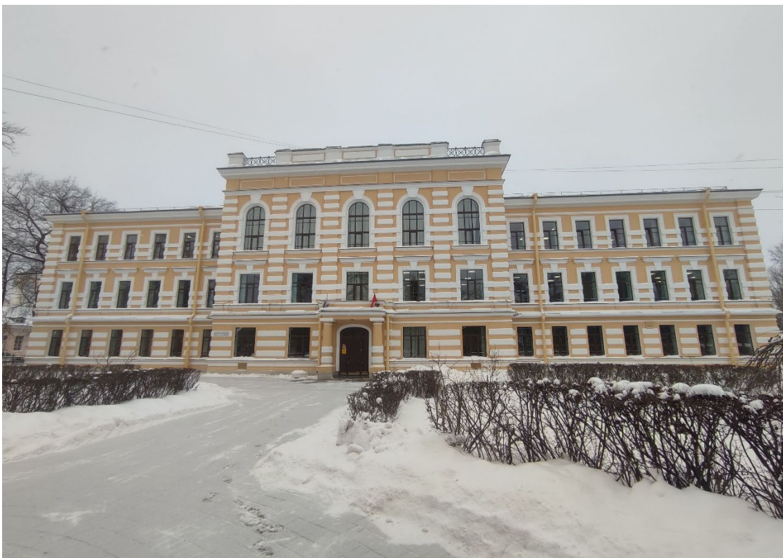
4. Объект культурного наследия регионального значения «Мужская гимназия с садом и оградой», расположенный по адресу: Санкт-Петербург, город Петергоф, Санкт-Петербургский проспект, дом 43, литера А. Общий вид южного лицевого фасада.
