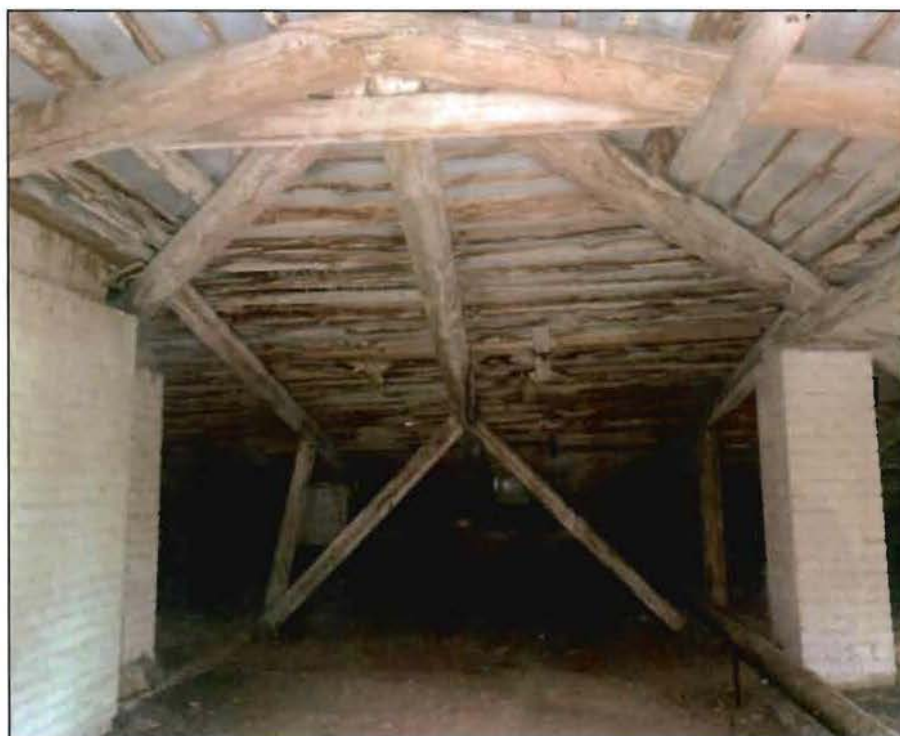
14. Стропильная система.
