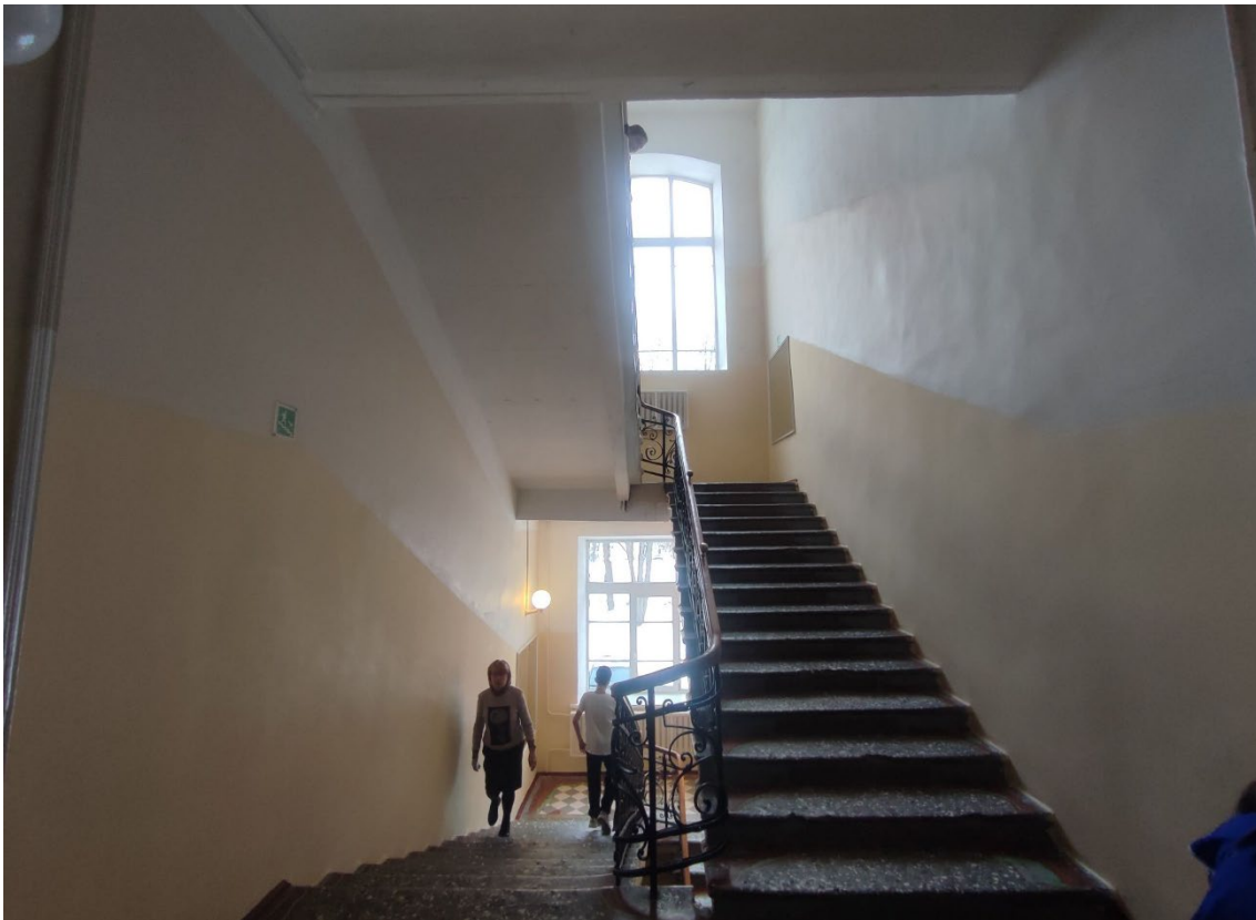
52. Объект культурного наследия регионального значения «Мужская гимназия с садом и оградой», расположенный по адресу: Санкт-Петербург, город Петергоф, Санкт-Петербургский проспект, дом 43, литера А. Общий вид парадной лестницы (пом. VI) в уровне 2-го этажа.
