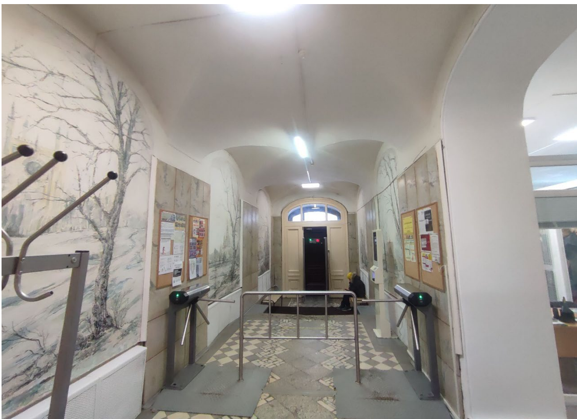
10. Объект культурного наследия регионального значения «Мужская гимназия с садом и оградой», расположенный по адресу: Санкт-Петербург, город Петергоф, Санкт-Петербургский проспект, дом 43, литера А. Общий вид вестибюля главного входа (пом. I) в уровне 1-го этажа.
