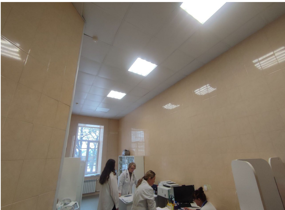
63. Объект культурного наследия регионального значения «Мужская гимназия с садом и оградой», расположенный по адресу: Санкт-Петербург, город Петергоф, Санкт-Петербургский проспект, дом 43, литера А. Общий вид пом. 3-Н (21) в уровне 3-го этажа.
