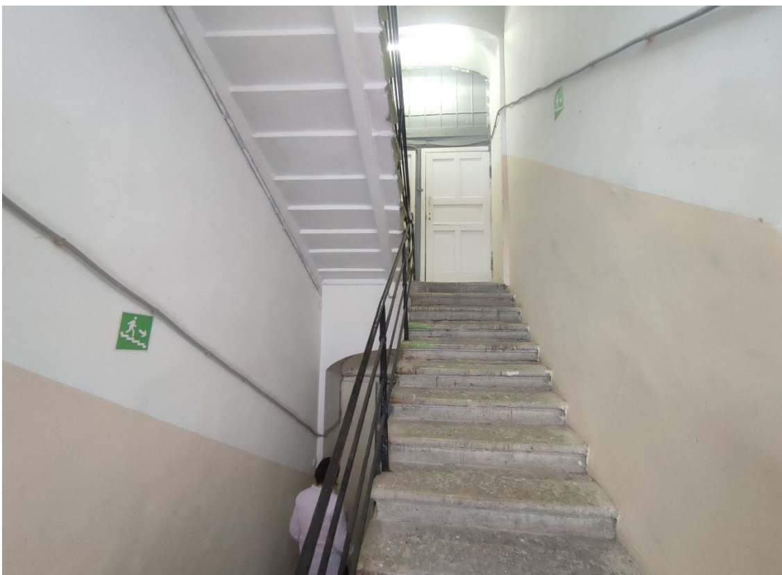
32. Объект культурного наследия регионального значения «Мужская гимназия с садом и оградой», расположенный по адресу: Санкт-Петербург, город Петергоф, Санкт-Петербургский проспект, дом 43, литера А. Общий вид служебной двухмаршевой лестницы (пом. VII) в уровне 2-го этажа.
