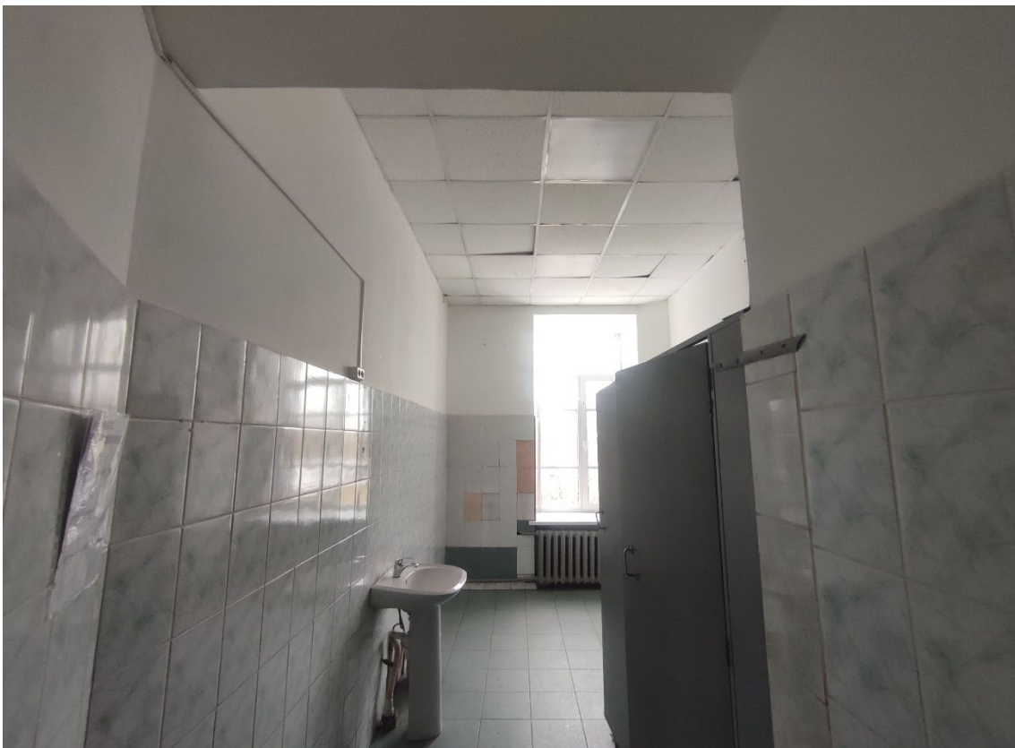
73. Объект культурного наследия регионального значения «Мужская гимназия с садом и оградой», расположенный по адресу: Санкт-Петербург, город Петергоф, Санкт-Петербургский проспект, дом 43, литера А. Общий вид пом. 3-Н (8) в уровне 3-го этажа.
