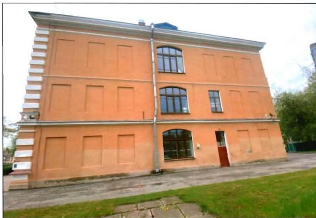
4. Общий вид на объект культурного наследия с восточной стороны.
