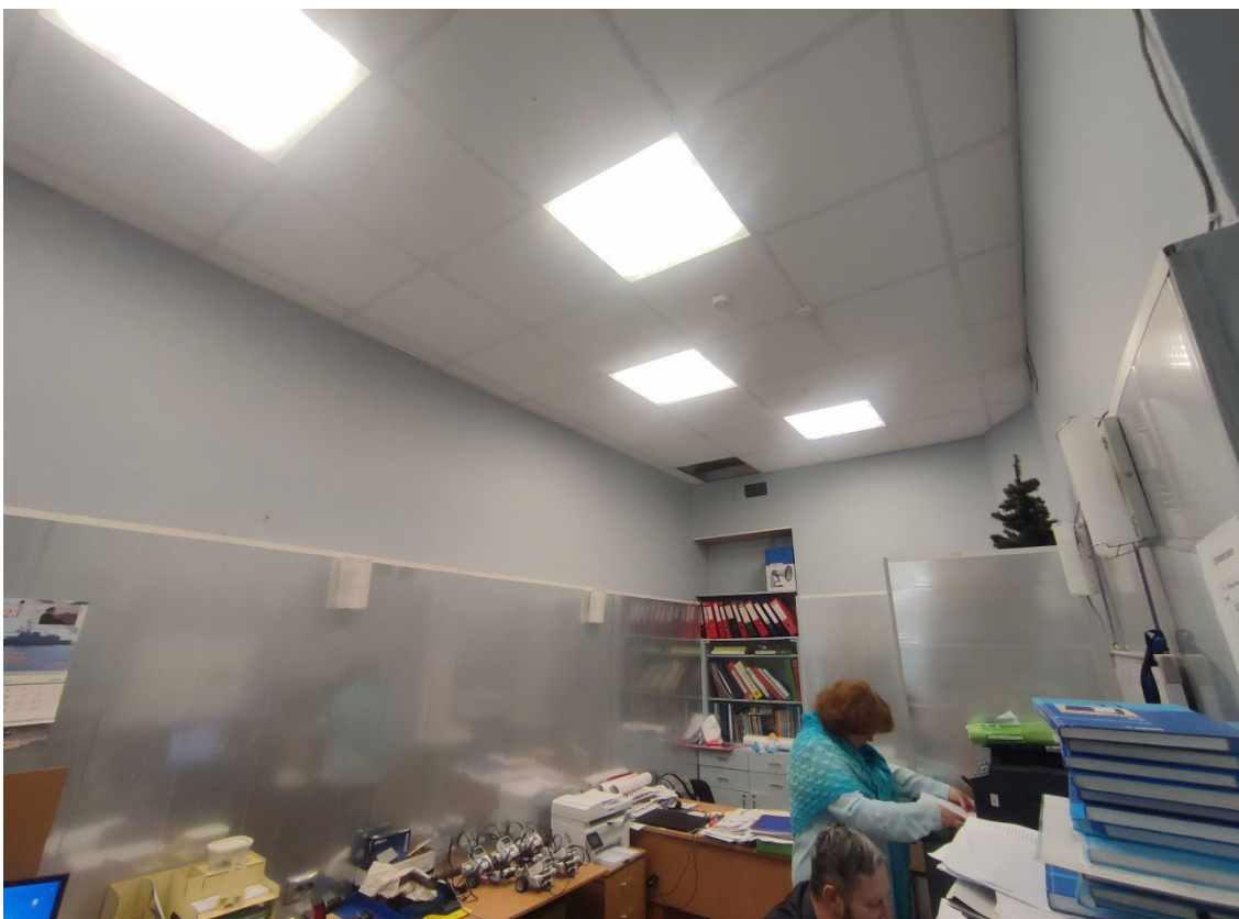
26. Объект культурного наследия регионального значения «Мужская гимназия с садом и оградой», расположенный по адресу: Санкт-Петербург, город Петергоф, Санкт-Петербургский проспект, дом 43, литера А. Общий вид пом. 1-Н (20) в уровне 1-го этажа.
