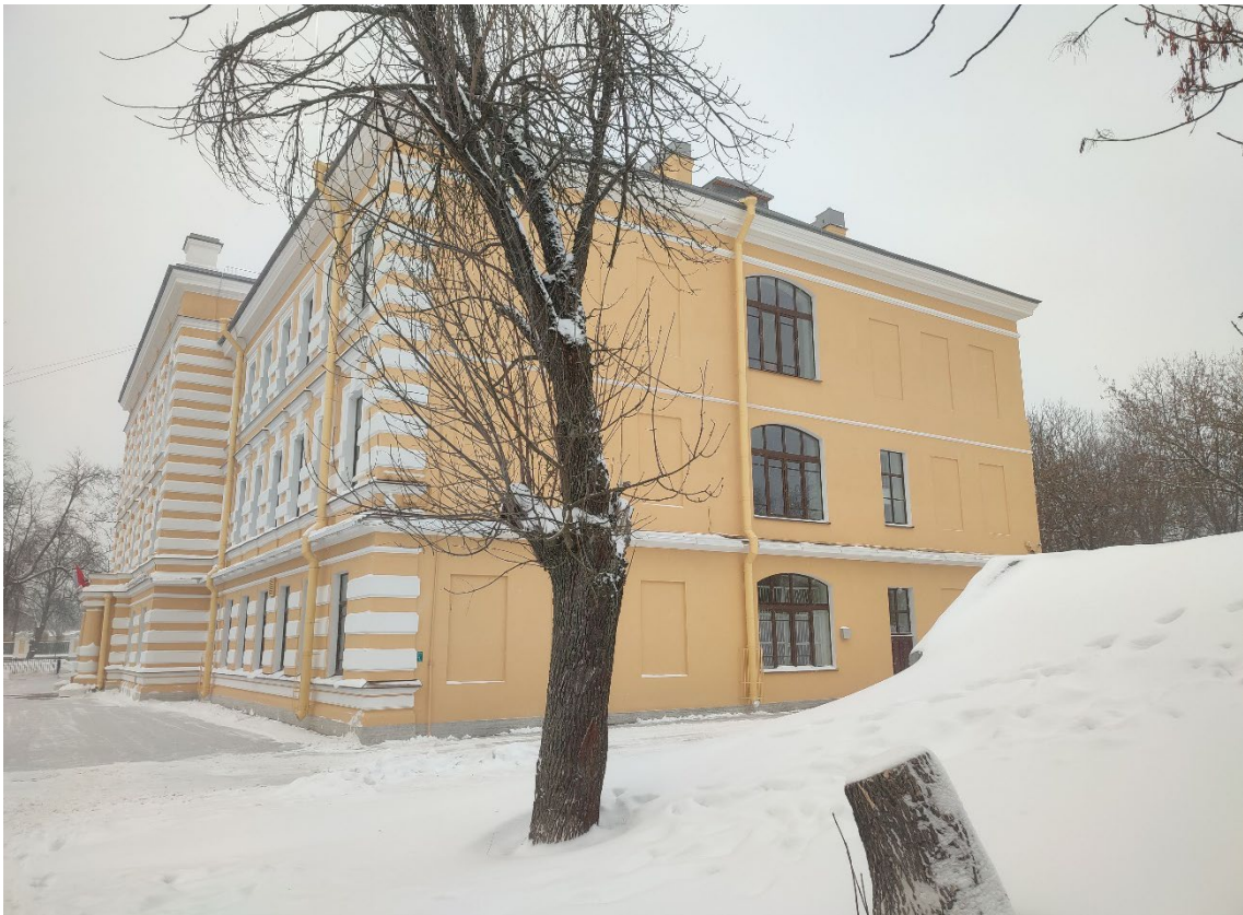
5. Объект культурного наследия регионального значения «Мужская гимназия с садом и оградой», расположенный по адресу: Санкт-Петербург, город Петергоф, Санкт-Петербургский проспект, дом 43, литера А. Общий вид восточного торцевого фасада.
