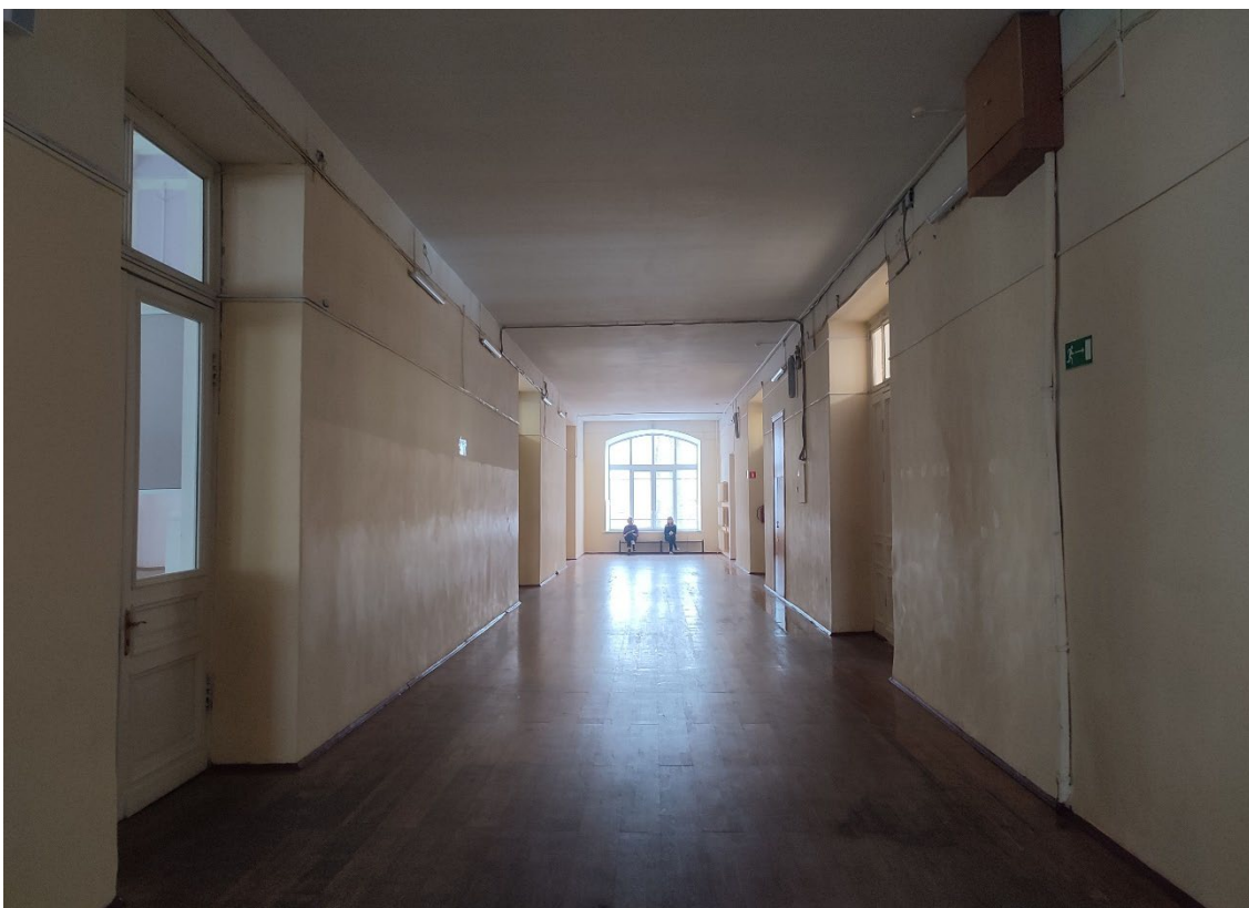
57. Объект культурного наследия регионального значения «Мужская гимназия с садом и оградой», расположенный по адресу: Санкт-Петербург, город Петергоф, Санкт-Петербургский проспект, дом 43, литера А. Общий вид пом. 3-Н (1) в уровне 3-го этажа.
