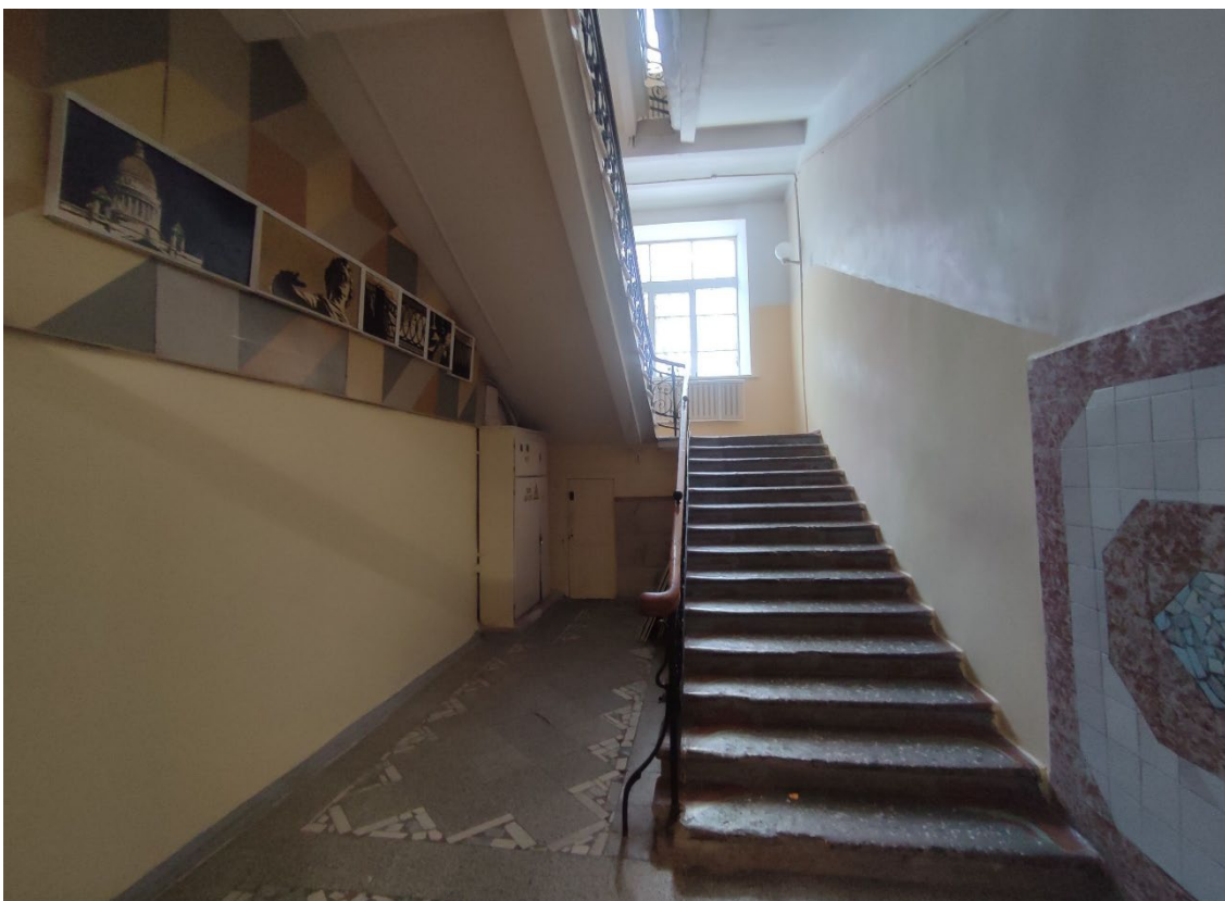
14. Объект культурного наследия регионального значения «Мужская гимназия с садом и оградой», расположенный по адресу: Санкт-Петербург, город Петергоф, Санкт-Петербургский проспект, дом 43, литера А. Общий вид парадной лестницы (пом. IV) в уровне 1-го этажа.
