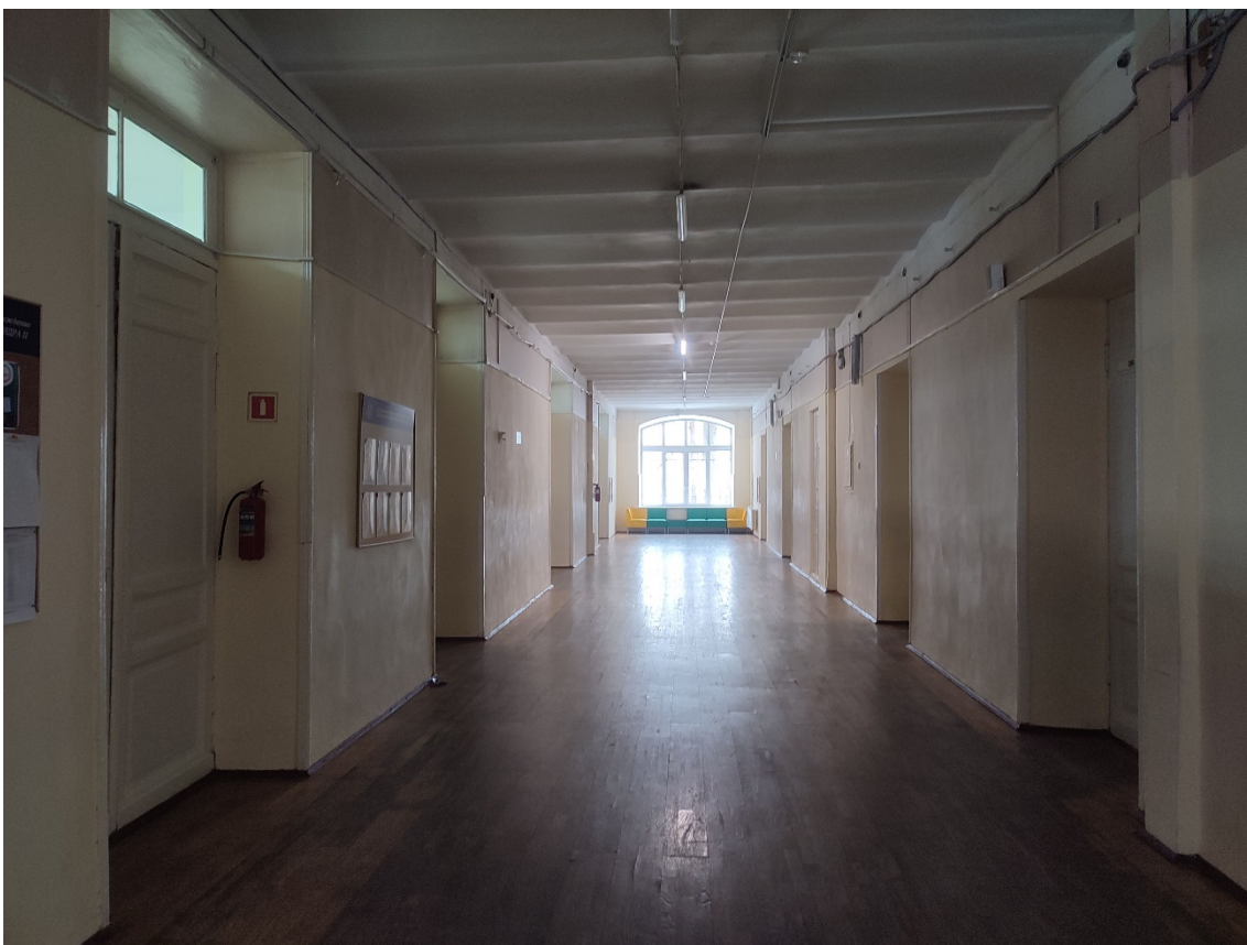
43. Объект культурного наследия регионального значения «Мужская гимназия с садом и оградой», расположенный по адресу: Санкт-Петербург, город Петергоф, Санкт-Петербургский проспект, дом 43, литера А. Общий вид пом. 2-Н (1) в уровне 2-го этажа.
