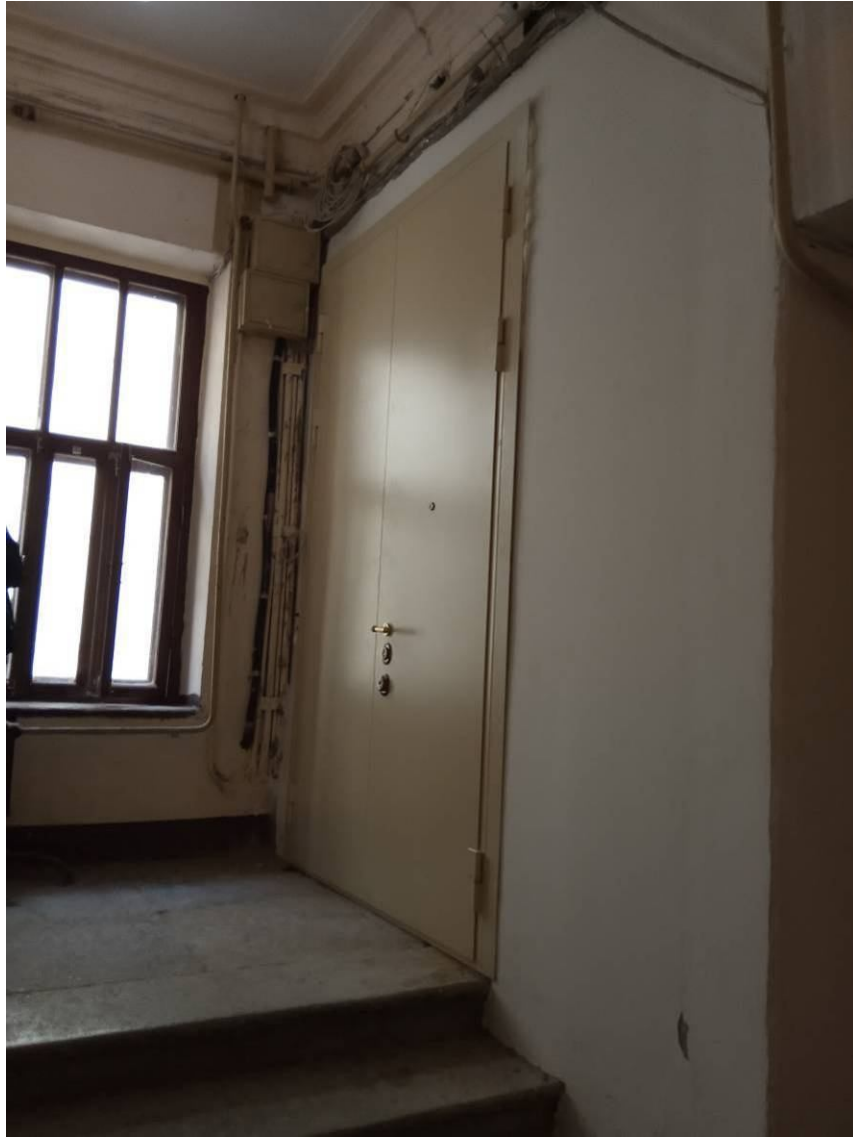
5. Вид на вход в квартиру № 24 с лестничной клетки.
