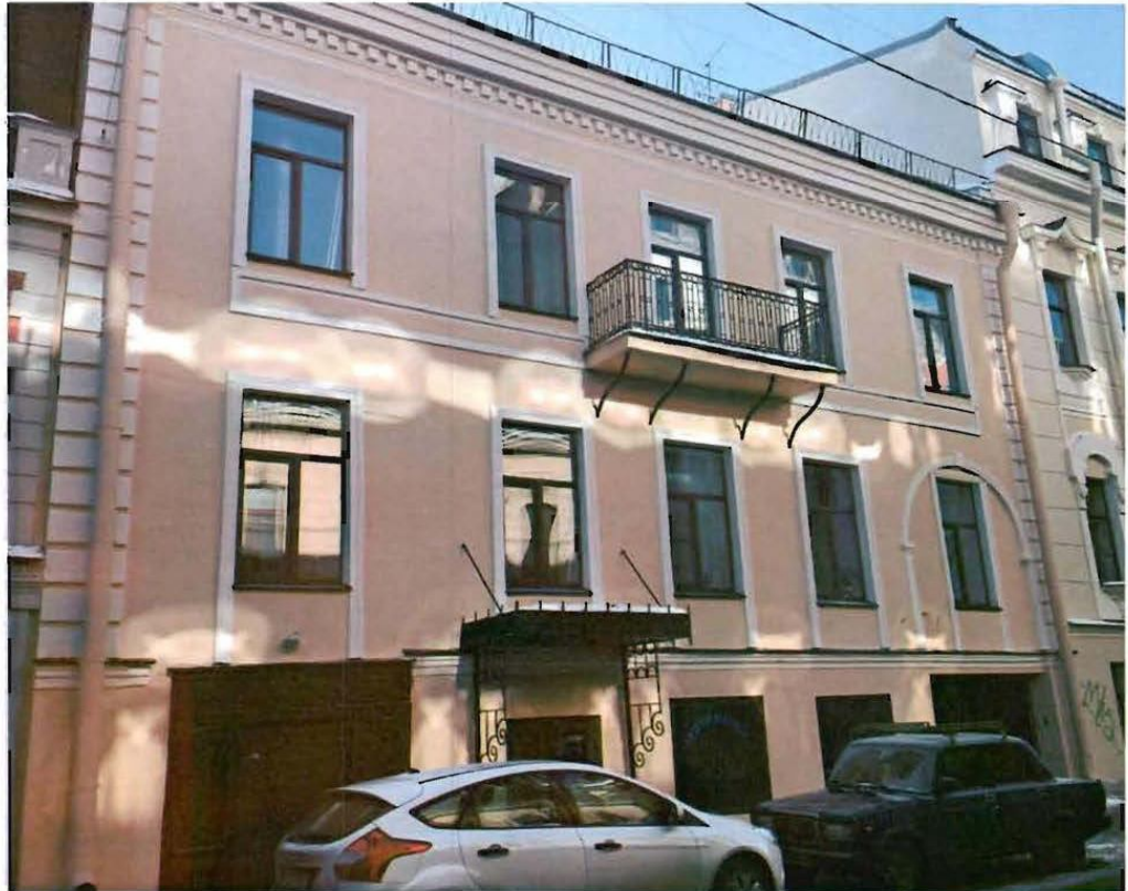
1. Лицевой фасад. Общий вид.
