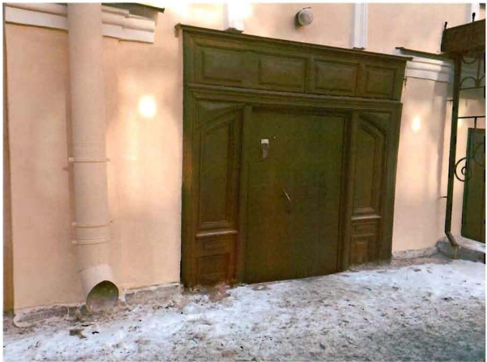
4. Дверной проем по крайней восточной оси.
