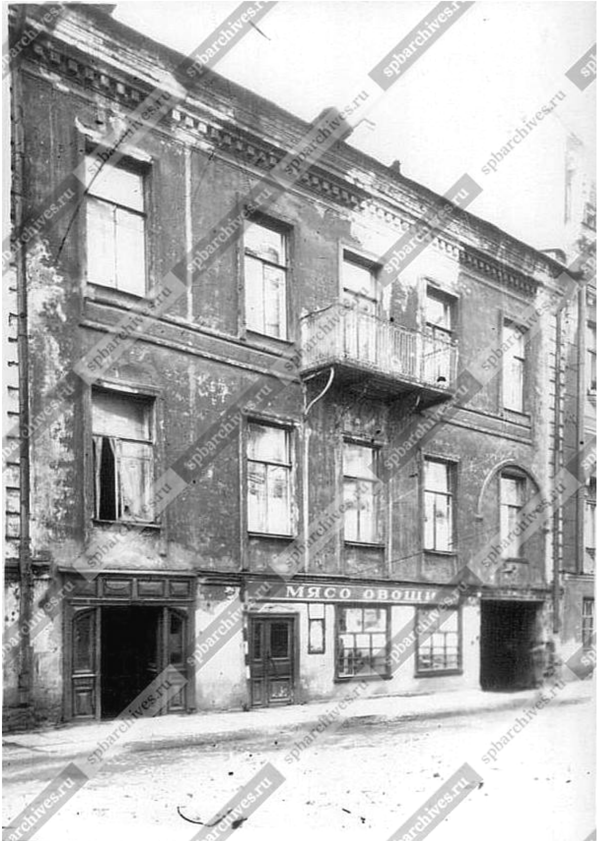
Илл.41. Фасад дома №46 на Красной улице. Фотография 1949 г. ЦГАКФФД СПб. Фотодокумент Гр 71100.
