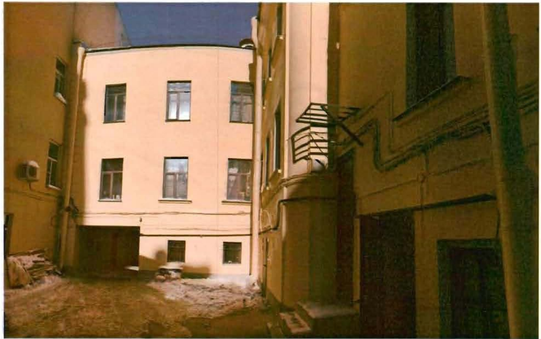
2. Дворовый фасад. Общий вид.
