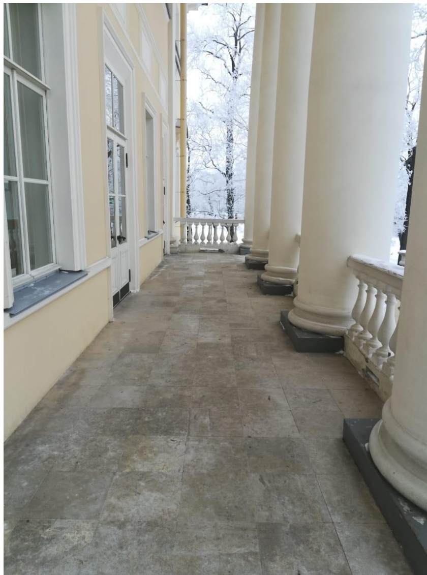
5. Объект культурного наследия федерального значения «Дом главный» по адресу: Санкт-Петербург, город Пушкин, Садовая улица, дом 22, литера А (Санкт-Петербург, г. Пушкин, Садовая ул., д. 22), входящий в состав объекта культурного наследия федерального значения «Дача Кочубей М.В. (Запасный дворец, Владимирский дворец)» (согласно постановлению Правительства РФ от 10.07.2001 № 527: г. Пушкин, Садовая ул., 22, Софийский бульв., 2, 4, 6, 8, 10). Восточный фасад. Шестиколонный портик. Фрагмент.
