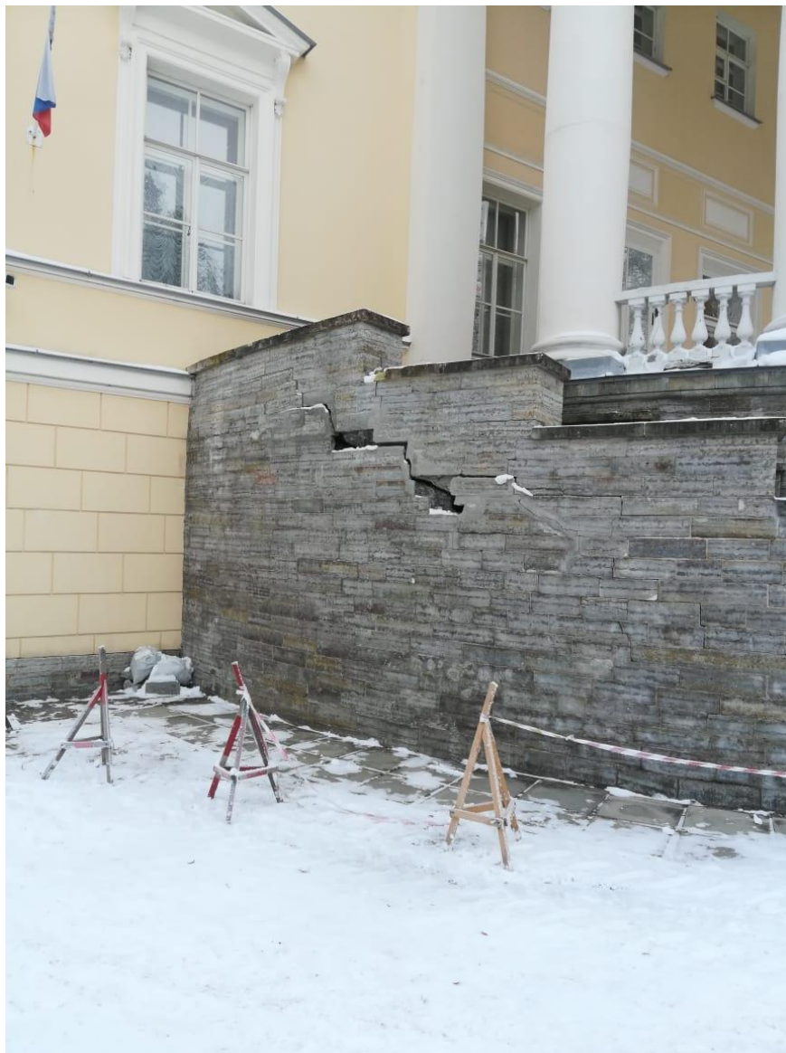
9. Объект культурного наследия федерального значения «Дом главный» по адресу: Санкт-Петербург, город Пушкин, Садовая улица, дом 22, литера А (Санкт-Петербург, г. Пушкин, Садовая ул., д. 22), входящий в состав объекта культурного наследия федерального значения «Дача Кочубей М.В. (Запасный дворец, Владимирский дворец)» (согласно постановлению Правительства РФ от 10.07.2001 № 527: г. Пушкин, Садовая ул., 22, Софийский бульв., 2, 4, 6, 8, 10). Западный фасад. Фрагмент.
