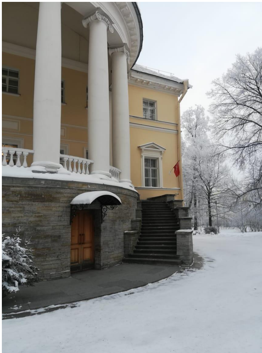
8. Объект культурного наследия федерального значения «Дом главный» по адресу: Санкт-Петербург, город Пушкин, Садовая улица, дом 22, литера А (Санкт-Петербург, г. Пушкин, Садовая ул., д. 22), входящий в состав объекта культурного наследия федерального значения «Дача Кочубей М.В. (Запасный дворец, Владимирский дворец)» (согласно постановлению Правительства РФ от 10.07.2001 № 527: г. Пушкин, Садовая ул., 22, Софийский бульв., 2, 4, 6, 8, 10). Западный фасад. Фрагмент. Дуговая лестница.
