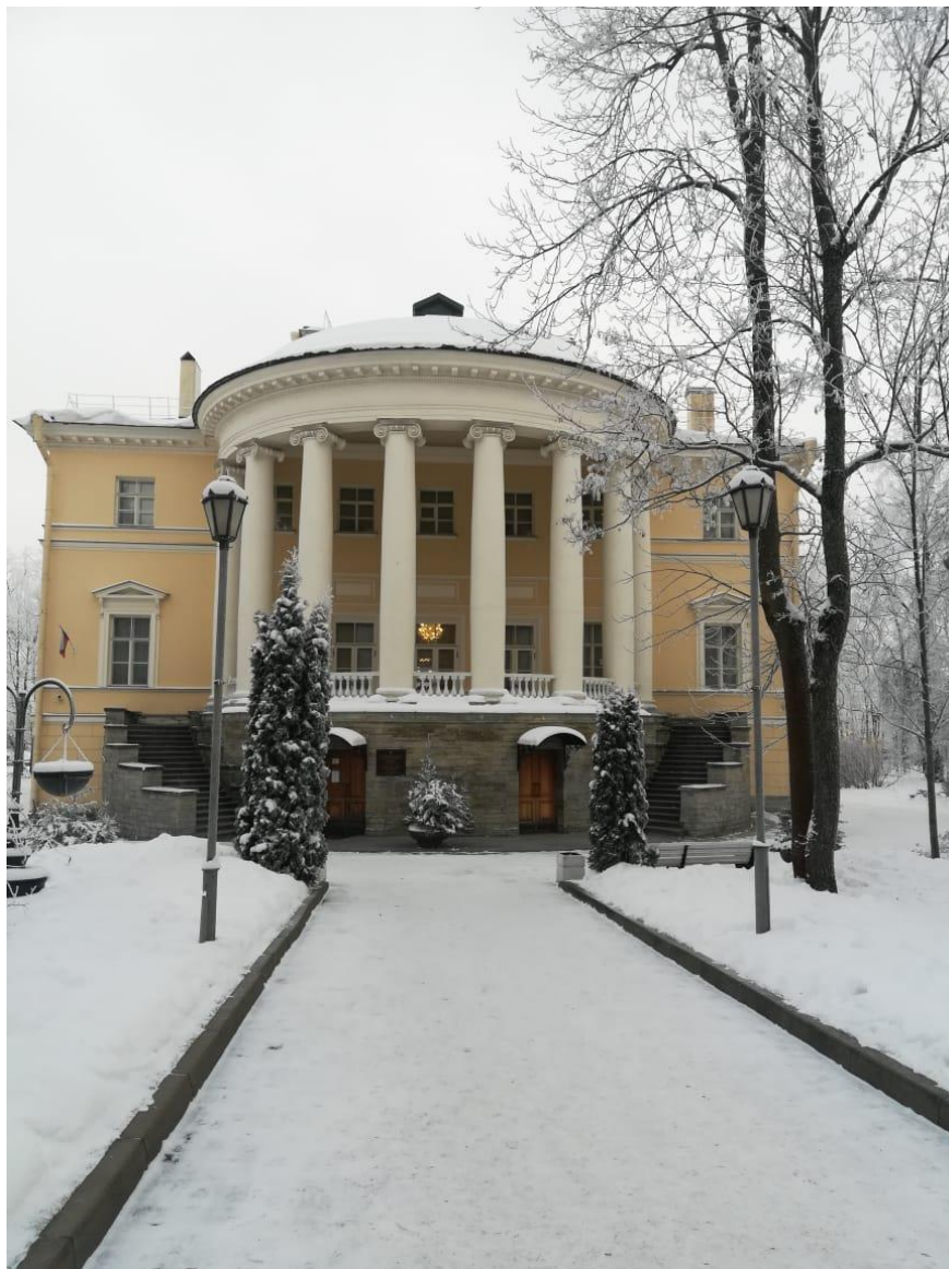
6. Объект культурного наследия федерального значения «Дом главный» по адресу: Санкт-Петербург, город Пушкин, Садовая улица, дом 22, литера А (Санкт-Петербург, г. Пушкин, Садовая ул., д. 22), входящий в состав объекта культурного наследия федерального значения «Дача Кочубей М.В. (Запасный дворец, Владимирский дворец)» (согласно постановлению Правительства РФ от 10.07.2001 № 527: г. Пушкин, Садовая ул., 22, Софийский бульв., 2, 4, 6, 8, 10). Западный (лицевой) фасад. Общий вид.
