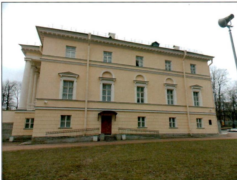
3. Северо-западный фасад здания.
