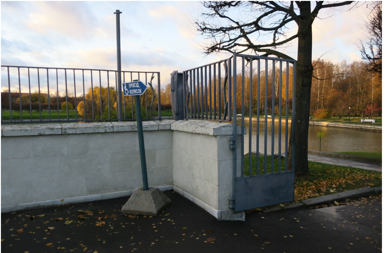
7. Южная часть ограды объекта культурного наследия федерального значения «Кладбище Пискаревское», расположенного по адресу: г. Санкт-Петербург, пр. Непокоренных, д. 72 литера А. Западная сторона. 15.10.2021
