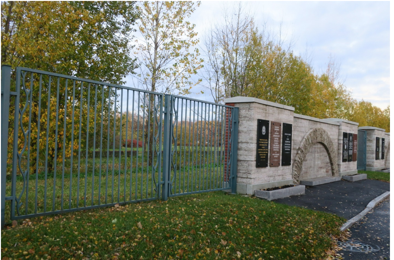
18. Северная часть ограды объекта культурного наследия федерального значения «Кладбище Пискаревское», расположенного по адресу: г. Санкт-Петербург, пр. Непокоренных, д. 72 литера А. 15.10.2021
