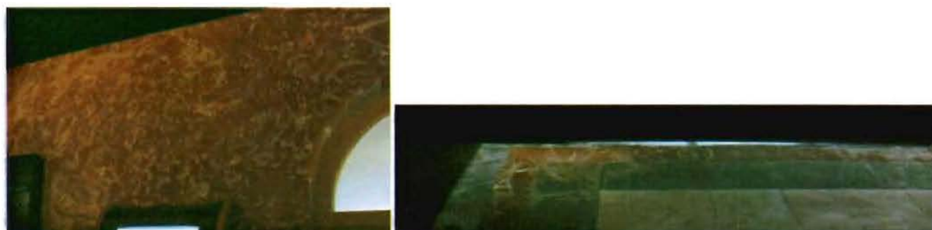
Отделка пола и стен центрального помещения первого этажа правого павильона. Съёмка 20.08.2012, К.С. Евтеев.
