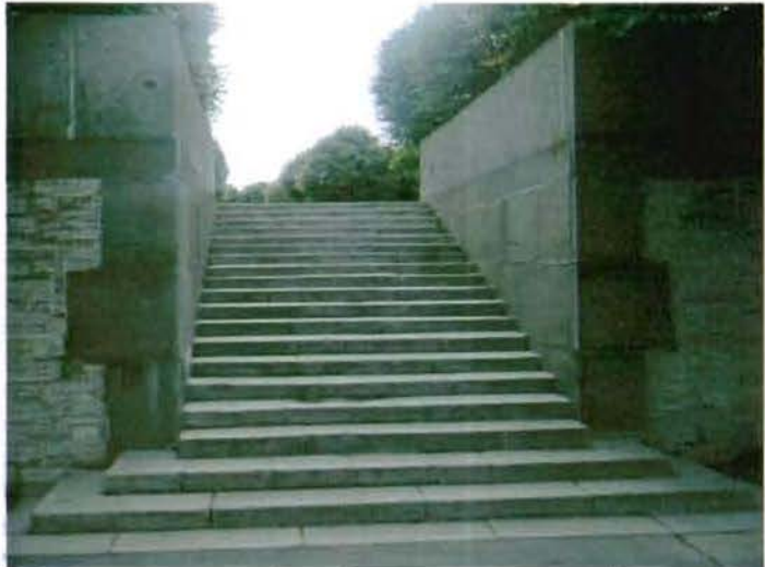
Художественно-обособленный участок «Вечный огонь». Боковые лестницы подпорной стенки террасы.
