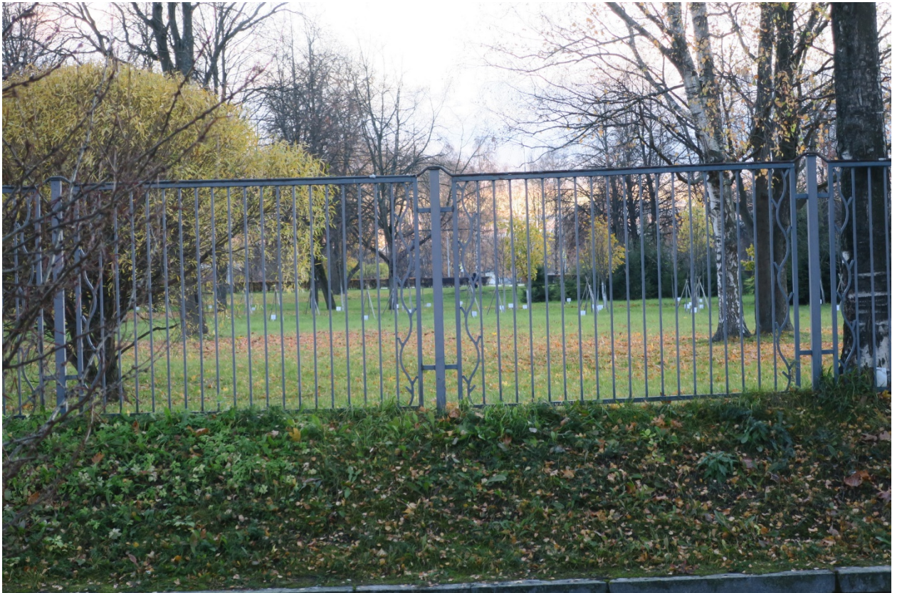
12. Южная часть ограды объекта культурного наследия федерального значения «Кладбище Пискаревское», расположенного по адресу: г. Санкт-Петербург, пр. Непокоренных, д. 72 литера А. Западная сторона. 15.10.2021
