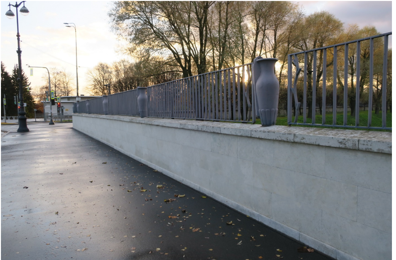
8. Южная часть ограды объекта культурного наследия федерального значения «Кладбище Пискаревское», расположенного по адресу: г. Санкт-Петербург, пр. Непокоренных, д. 72 литера А. Западная сторона. 15.10.2021
