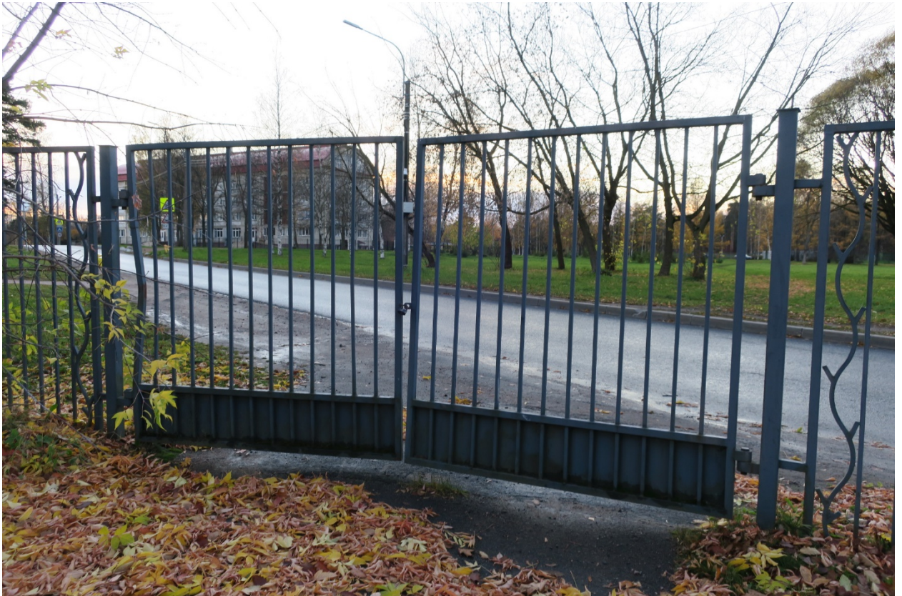
13. Южная часть ограды объекта культурного наследия федерального значения «Кладбище Пискаревское», расположенного по адресу: г. Санкт-Петербург, пр. Непокоренных, д. 72 литера А. Ворота (въезд – вход №2). 15.10.2021
