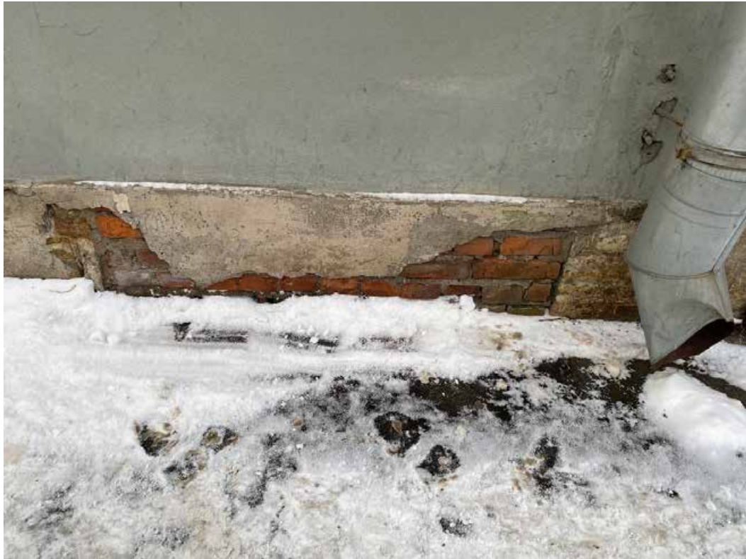
Фото 6. Лицевой фасад в осях «4-3» по Масляному каналу. Фрагмент с цоколем и закладкой на месте бывшего дверного проема.
