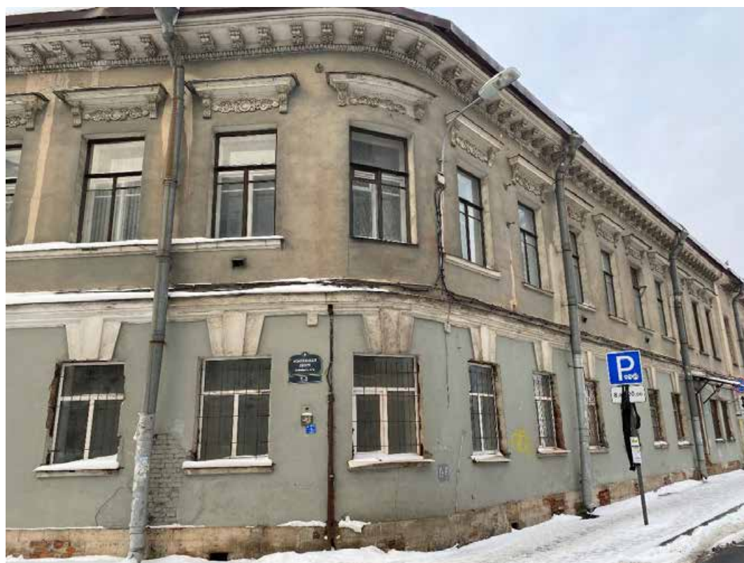
Фото 2. Лицевой фасад «7-1» по Масляному каналу. Общий вид.
