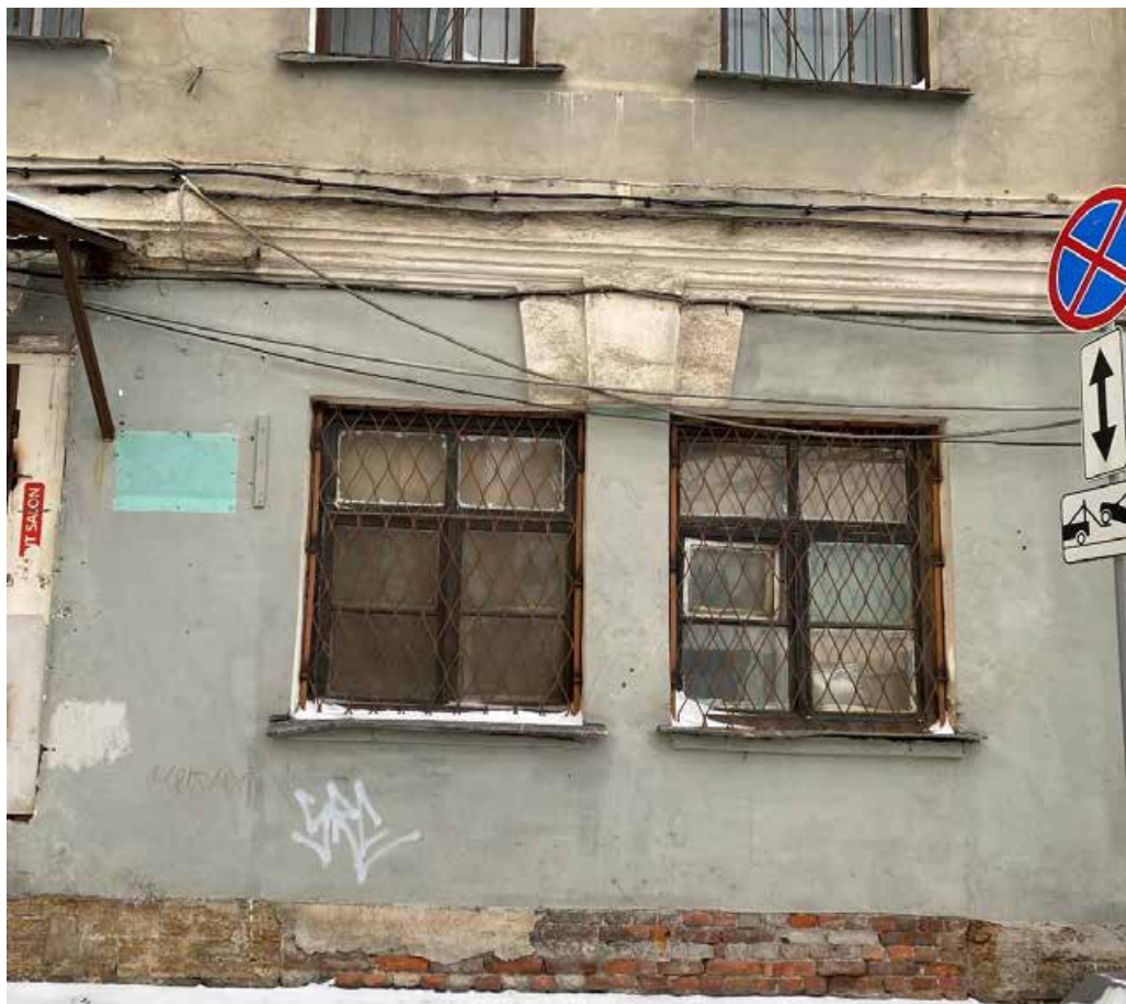
Фото 4. Лицевой фасад в осях «2-1» по Масляному каналу. Фрагмент с окнами 1 этажа, на месте бывшего исторического проезда.
