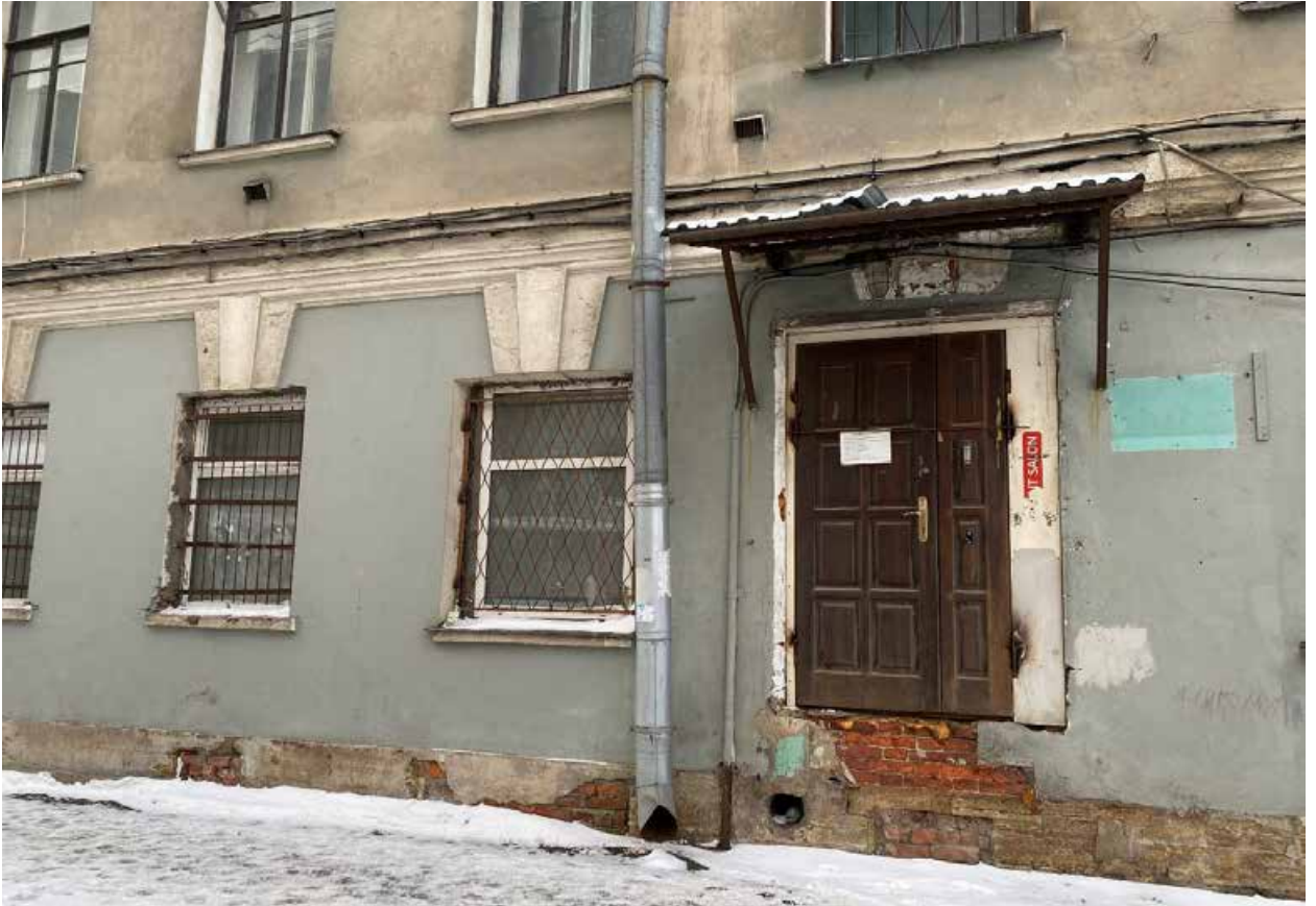
Фото 5. Лицевой фасад в осях «4-2» по Масляному каналу. Фрагмент с входной дверью и окнами 1 этажа.
