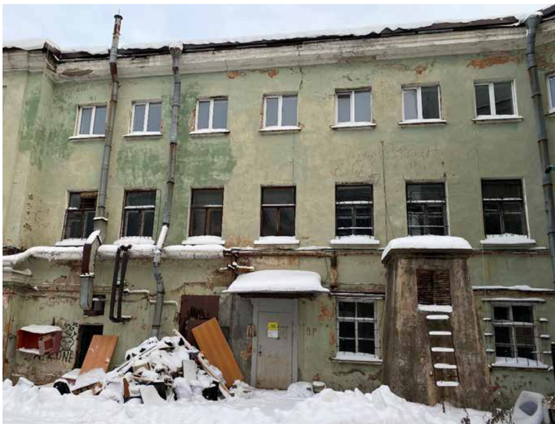
Фото 9. Общий вид фасада со двора в осях «1-7».
