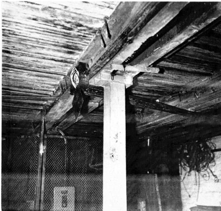
22. Фотография № 102. «Вход в грузовой лифт». Итальянская ул., д. 17. 1-й этаж.
