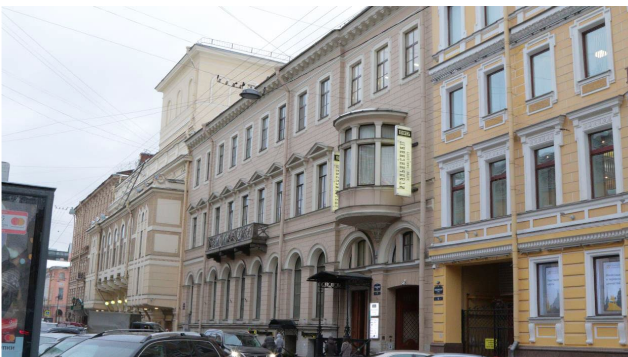
Фото 2. Северные фасады. Итальянская ул. д. 17, д. 19.
