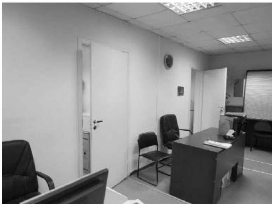
315. «Дом Н.Я. и Ф.Я. Колотовых». Санкт-Петербург, Большой пр. П.С., 16-18; Красно го курсанта ул., д.1; Пионерская ул., д.6, литера А. Большой пр. П.С., 18. 6-й этаж. Фрагмент помещения 11-Н. Фото: 21.03.2023.
