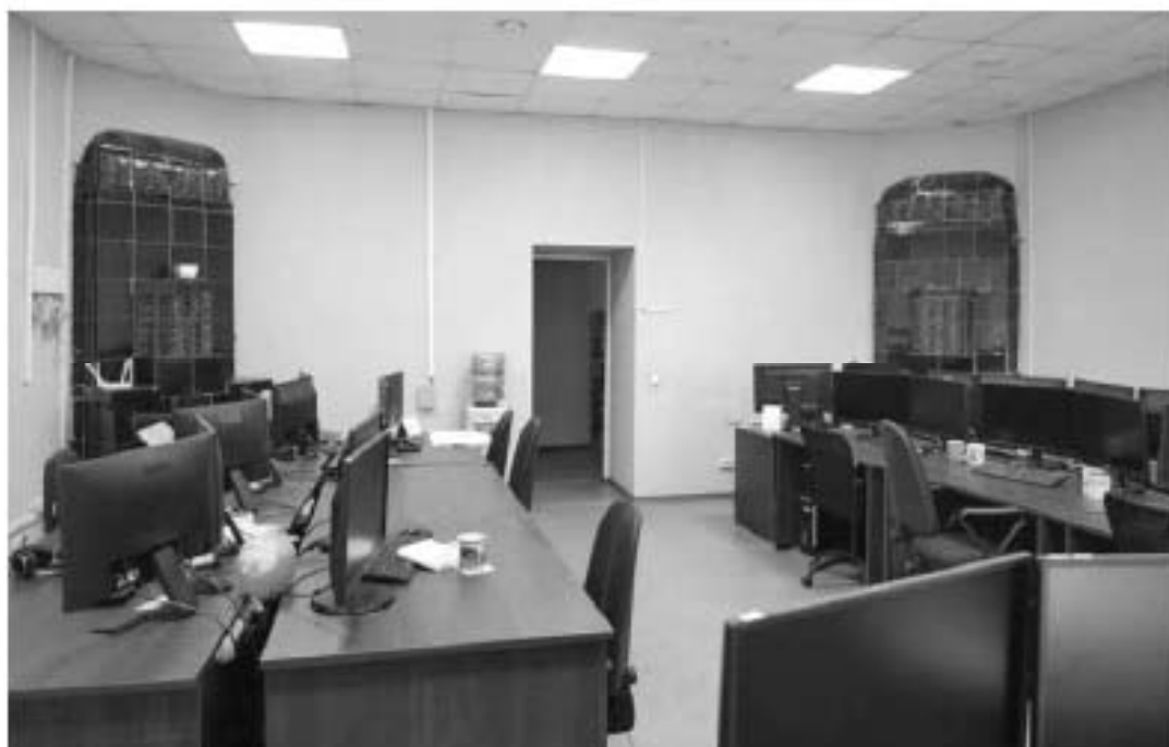
251. «Дом Н.Я. и Ф.Я. Колобовых». Санкт-Петербург, Большой пр. П.С., 16-18; Красного курсанта ул., д.1; Пионерская ул., д.6, литера А. Большой пр. П.С., 18. 5-й этаж. Фрагмент помещения 8-Н. Две идентичные печи угловые двухъярусные. Фото: 21.03.2023.
