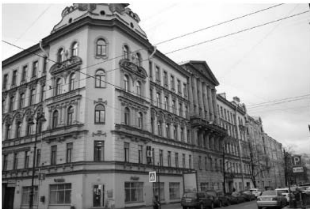
17. «Дом Н.Я. и Ф.Я. Колобовых». Санкт-Петербург; Большой пр. П.С., 16-18; Красно го курсанта ул., д.1; Пионерская ул., д.6, литера А. Лицевые фасады по Большому пр., П.С. и Пионерской ул. Фото: 21.03.2023.
