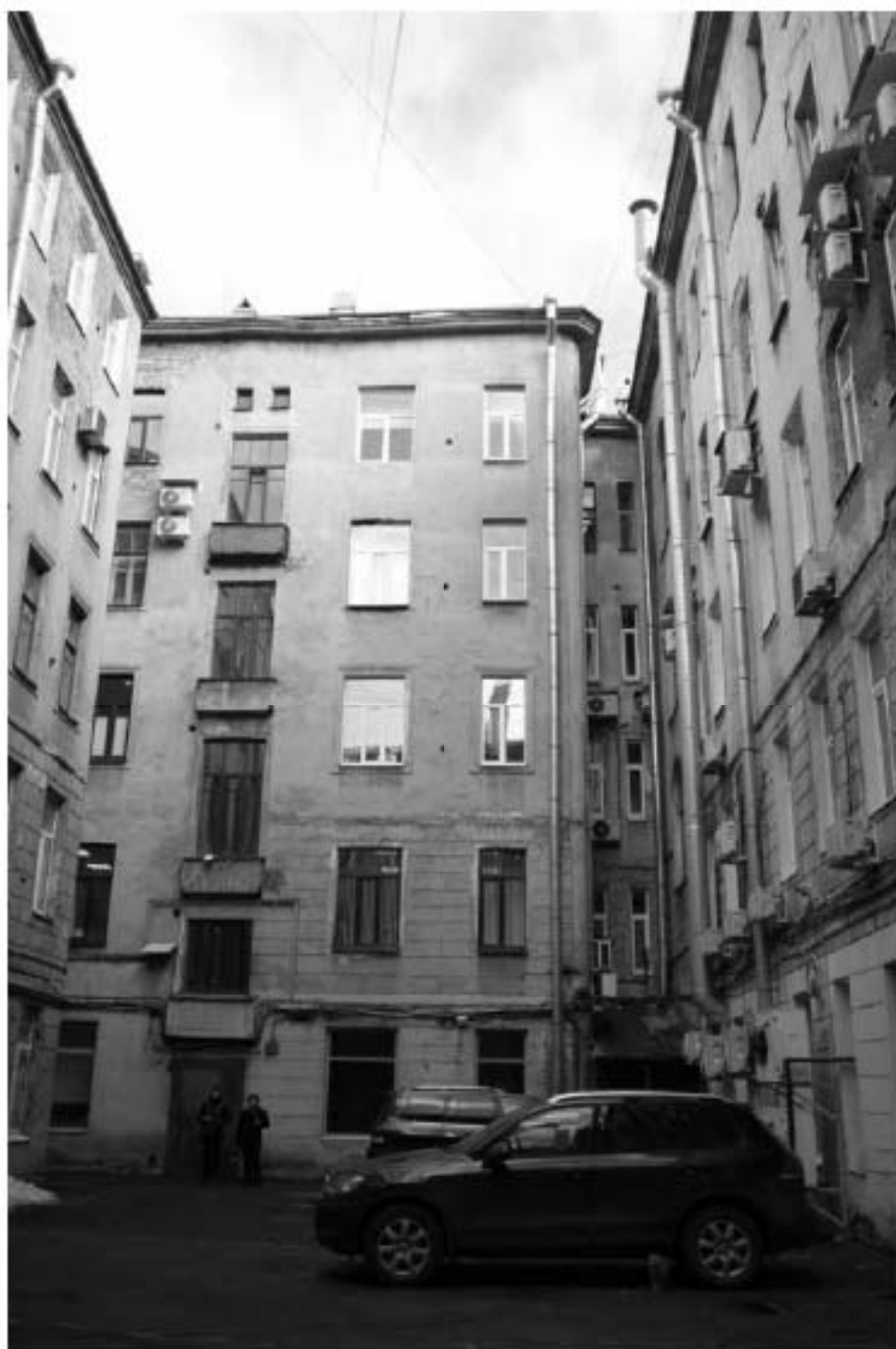
37. «Дом Н.Я. и Ф.Я. Колобовых». Санкт-Петербург, Большой пр. П.С., 16-18; Красного курсанта ул., д.1; Пионерская ул., д.6, литера А. Фрагмент фасадов дворовых корпусов. Фото: 21.03. 2023.
