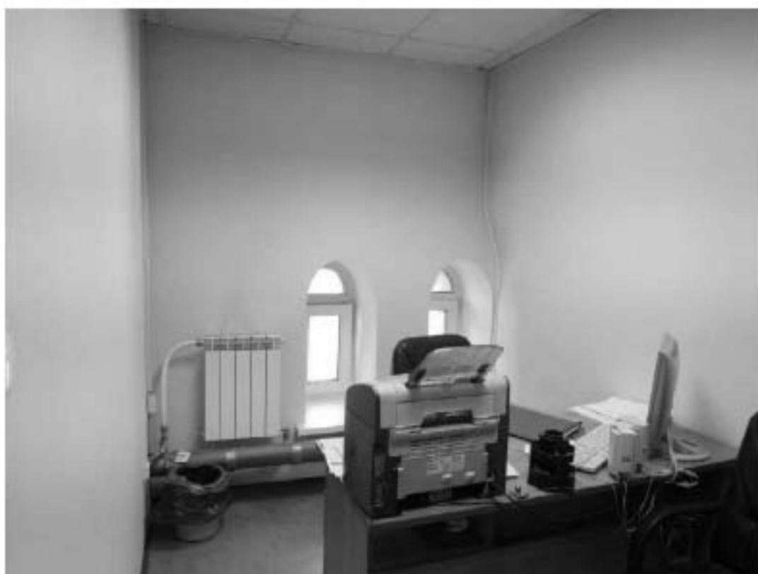
316. «Дом Н.Я. и Ф.Я. Колотовых». Санкт-Петербург: Большой пр. П.С., 16-18; Красно го курсанта ул., д.1; Пионерская ул., д.6, литера А. Большой пр. П.С., 18. 6-й этаж. Фрагмент помещения 11-Н. Фото: 21.03.2023.
