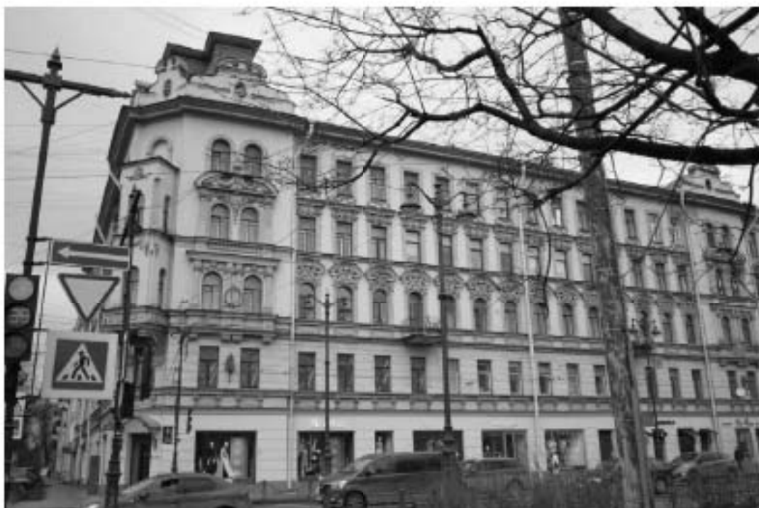
4. «Дом Н.Я. и Ф.Я. Колобовых». Санкт-Петербург, Большой пр. П.С., 16-18; Красного курсанта ул., д.1; Пионерская ул., д.6, литера А. Лицевой фасад по Большому пр., П.С. Фрагмент. Левая часть. Фото: 21.03. 2023.
