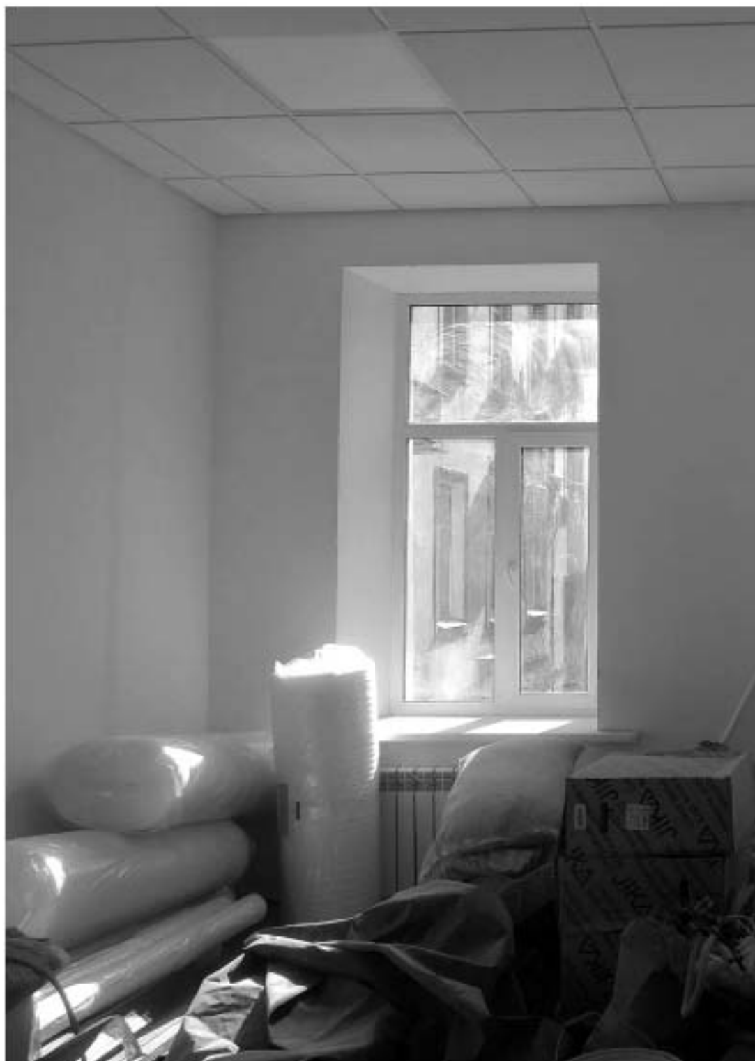
99. «Дом Н.Я. и Ф.Я. Колобовых». Санкт-Петербург, Большой пр. П.С., 16-18; Красного курсанта ул., д.1; Пионерская ул., д.6, литера А. Большой пр. П.С., 18. 3-й этаж. Фрагмент помещения 17-Н. Фото: 21.03. 2023.
