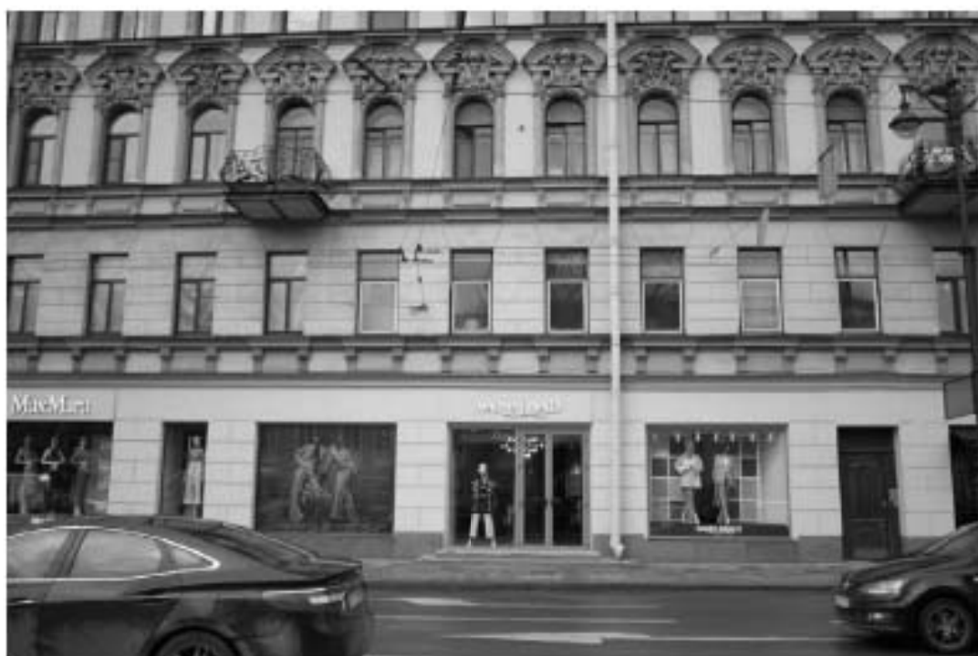
5. «Дом Н.Я. и Ф.Я. Колобовских». Санкт-Петербург, Большой пр. П.С., 16-18; Красного курсанта ул., д.1; Пионерская ул., д.6, литера А. Лицевой фасад по Большому пр., П.С. Фрагмент. Фото: 21.03. 2023.
