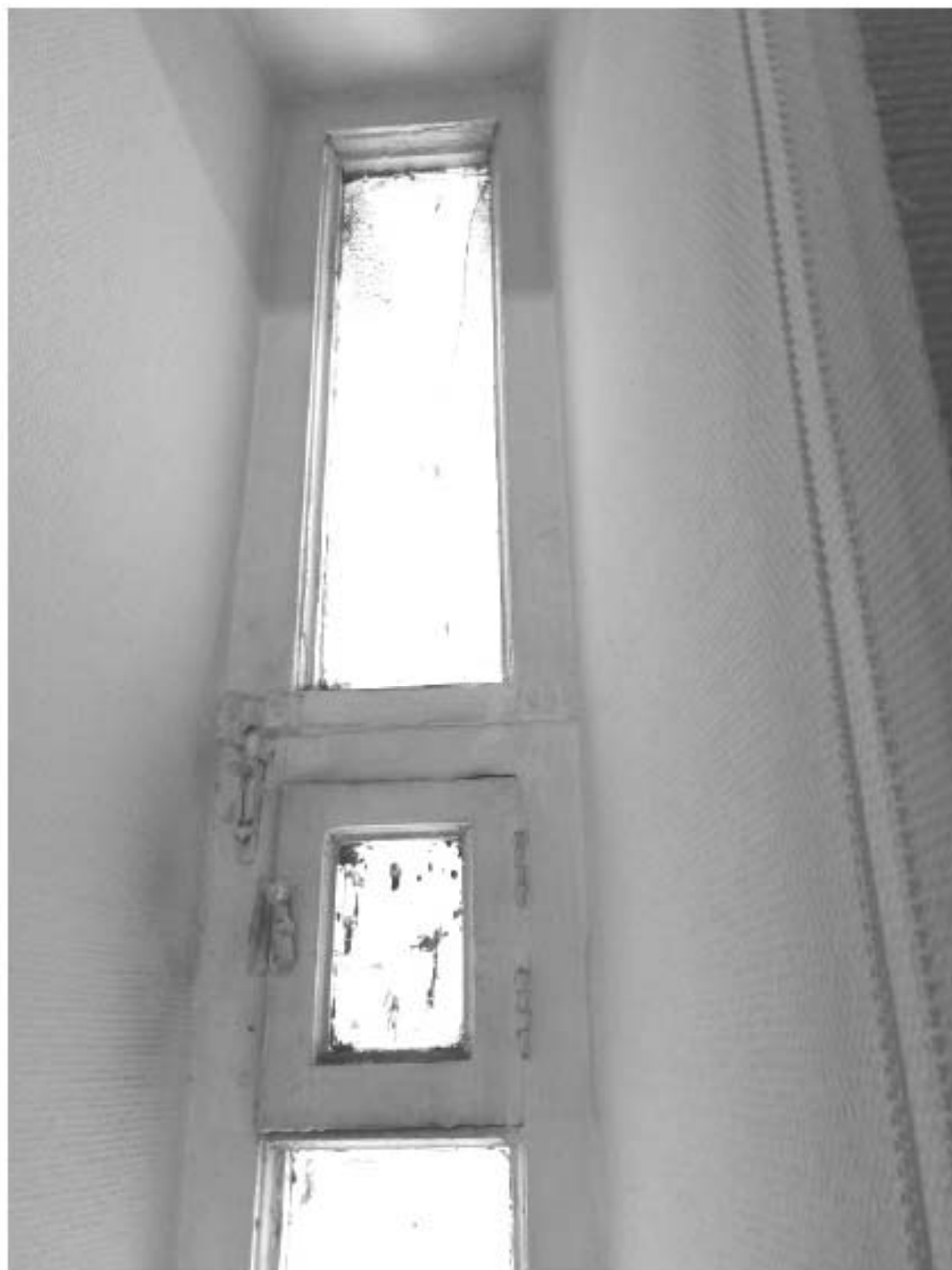
280. «Дом Н.Я. и Ф.Я. Колобовых». Санкт-Петербург, Большой пр. П.С., 16-18; Красного курсанта ул., д.1; Пионерская ул., д.6, литера А. Большой пр. П.С., 18. 5-й этаж. Фрагмент помещения 26-Н. Оконный проем. Фото: 21.03. 2023.
