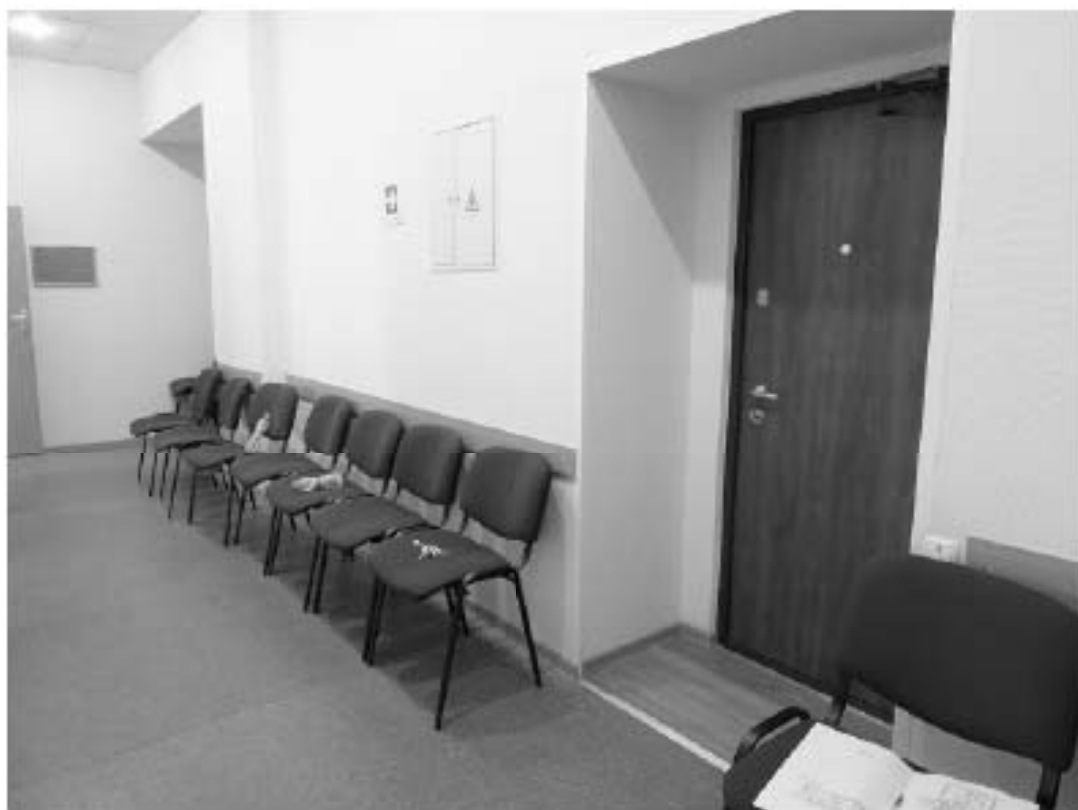
127. «Дом Н.Я. и Ф.Я. Колобовых». Санкт-Петербург, Большой пр. П. С., 16-18; Красного курсанта ул., д.1; Пионерская ул., д.6, литера А. Большой пр. П. С., 18. 3-й этаж. Фрагмент помещения 17-Н. Коридор. Фото: 21.03. 2023.
