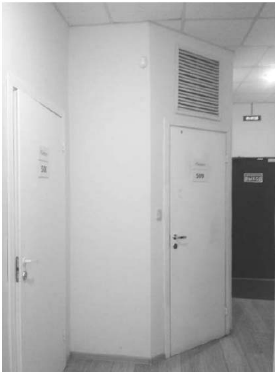
240. «Дом Н.Я. и Ф.Я. Колобовых». Санкт-Петербург, Большой пр. П.С., 16-18; Красного курсанта ул., д.1; Пионерская ул., д.6, литера А. Большой пр. П.С., 18. 5-й этаж. Фрагмент помещения 8-Н. Коридор. Фото: 21.03. 2023.
