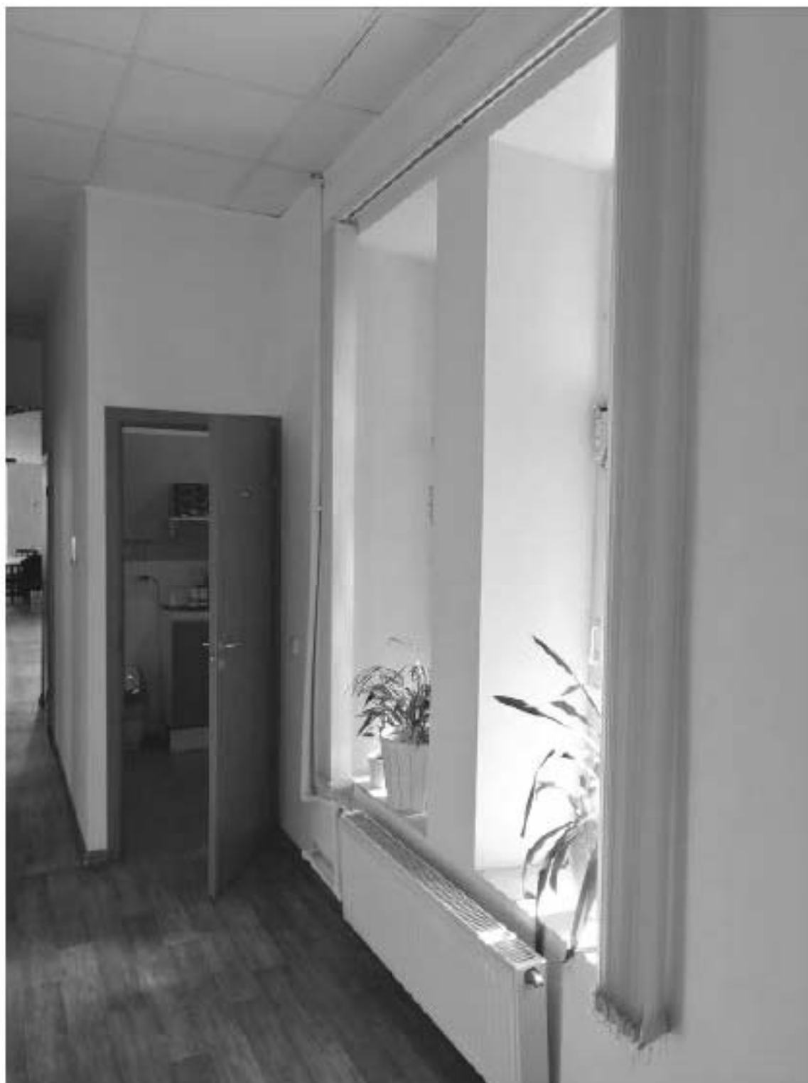
267. «Дом Н.Я. и Ф.Я. Колобовых». Санкт-Петербург, Большой пр. П.С., 16-18; Красного курсанта ул., д.1; Пионерская ул., д.6, литера А. Большой пр. П.С., 18. 5-й этаж. Фрагмент помещения 26-Н. Фото: 21.03. 2023.
