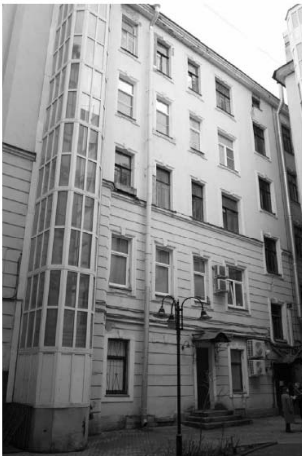
28. «Дом Н.Я. и Ф.Я. Колобовых». Санкт-Петербург, Большой пр. П.С., 16-18; Красного курсанта ул., д.1; Пионерская ул., д.6, литера А. Фрагмент лицевого корпуса по Большому пр. П.С. со стороны двора. Фото: 21.03. 2023.
