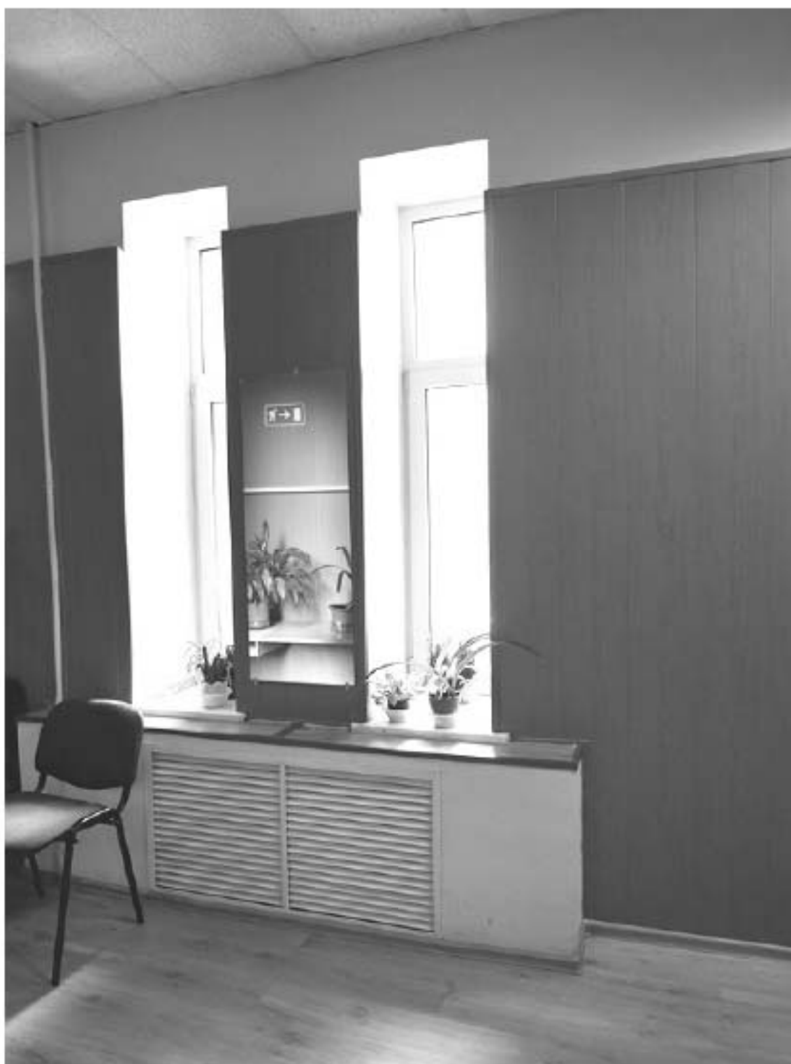
176. «Дом Н.Я. и Ф.Я. Колобовых». Санкт-Петербург, Большой пр. П.С., 16-18; Красного курсанта ул., д.1; Пионерская ул., д.6, литера А. Большой пр. П.С., 18. 4-й этаж. Фрагмент помещения 18-Н. Коридор. Фото: 21.03. 2023.
