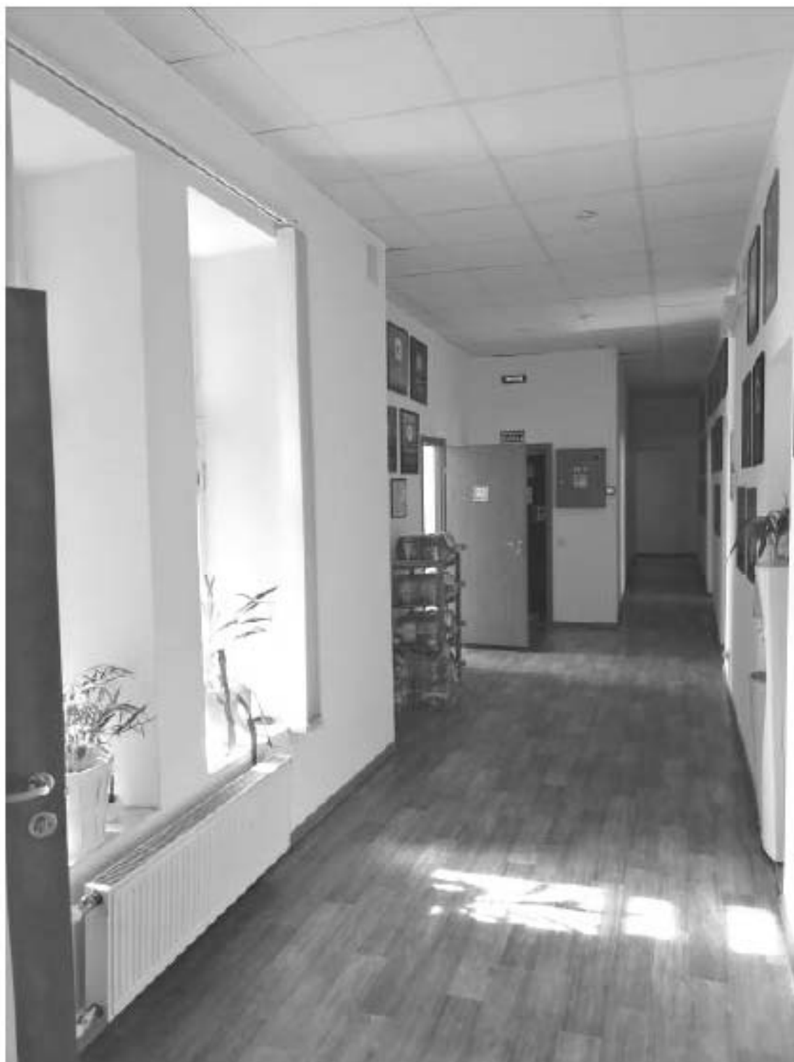
265. «Дом Н.Я. и Ф.Я. Колобовых». Санкт-Петербург, Большой пр. П.С., 16-18; Красного курсанта ул., д.1; Пионерская ул., д.6, литера А. Большой пр. П.С., 18. 5-й этаж. Фрагмент помещения 26-Н. Коридор. Фото: 21.03. 2023.
