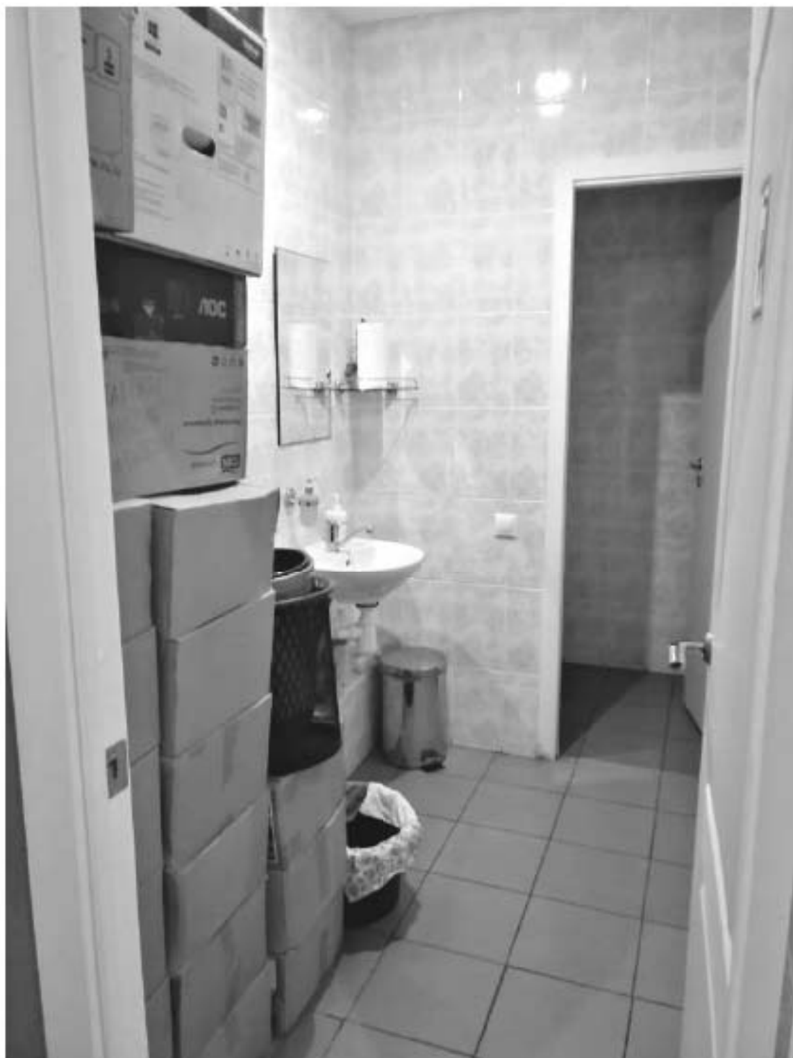
233. «Дом Н.Я. и Ф.Я. Колобовых». Санкт-Петербург, Большой пр. П.С., 16-18; Красного курсанта ул., д.1; Пионерская ул., д.6, литера А. Большой пр. П.С., 18. 5-й этаж. Фрагмент помещения 8-Н. Санузел. Фото: 21.03. 2023.
