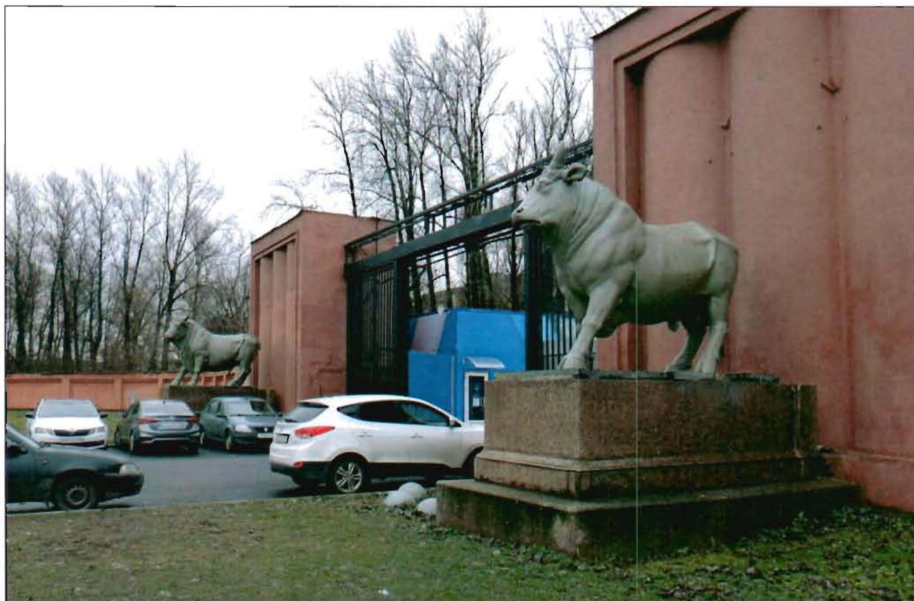
1. Общий вид с севера.
