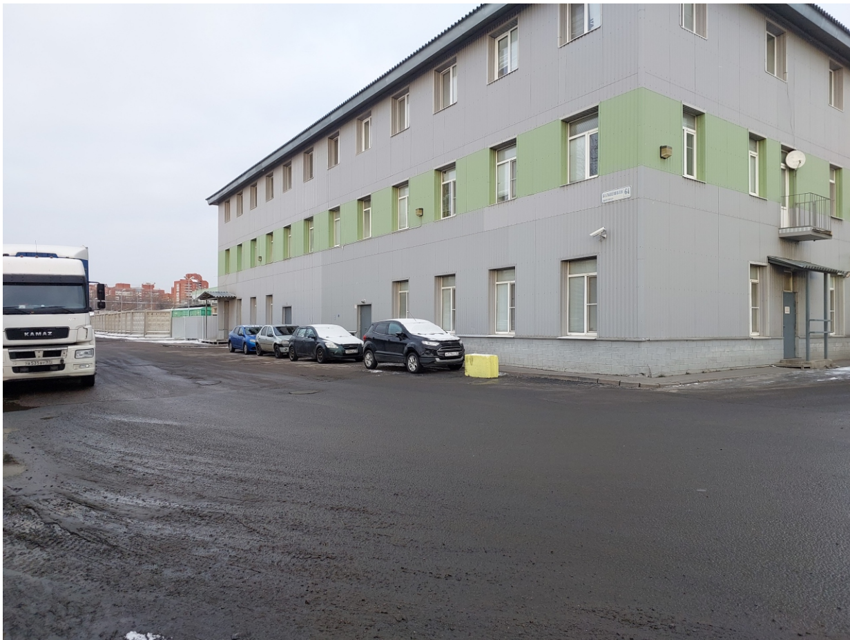
Точка фотофиксации 1. Северо-восточная часть участка обследования. Проезд вдоль ЛЭП. Вид с ВЮВ.
