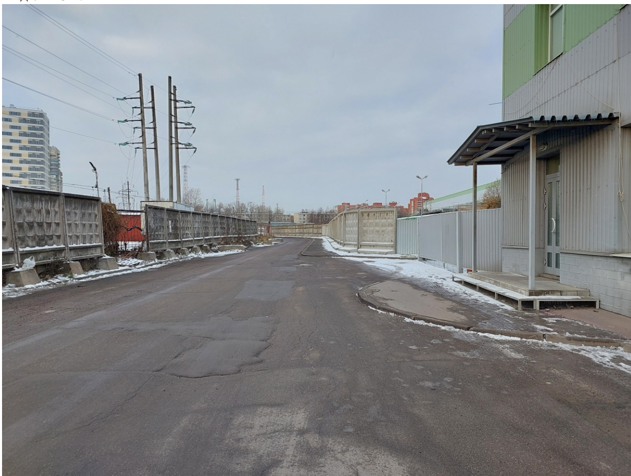
Точка фотофиксации 2. Северо-восточная часть участка обследования. Проезд вдоль ЛЭП. Съемка от дома, расположенного по адресу: Октябрьская набережная, 104к2Л. Вид с ВЮВ.
