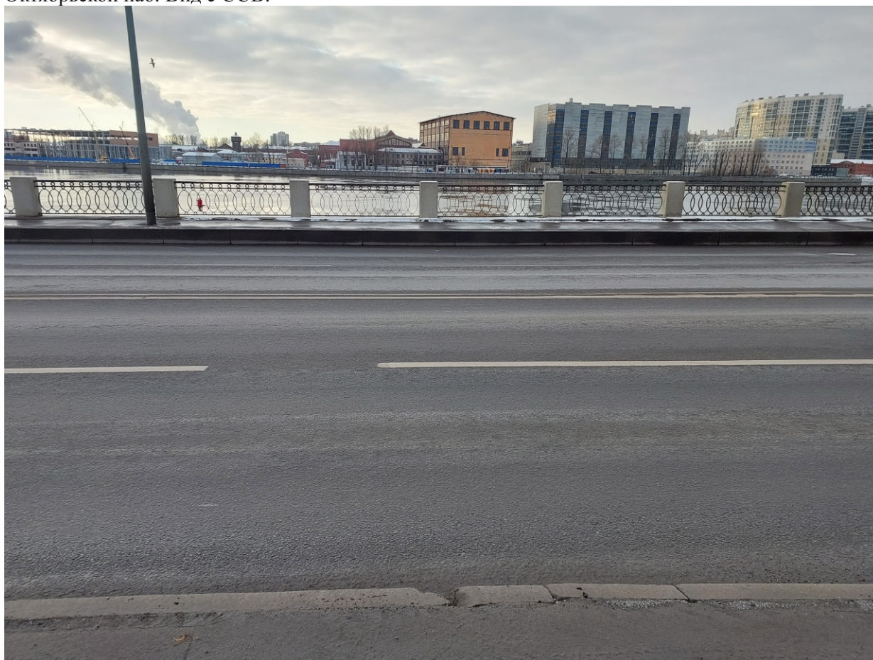
Точка фотофиксации 16. Юго-восточная часть участка обследования, Октябрьская наб. Вид с ССВ.
