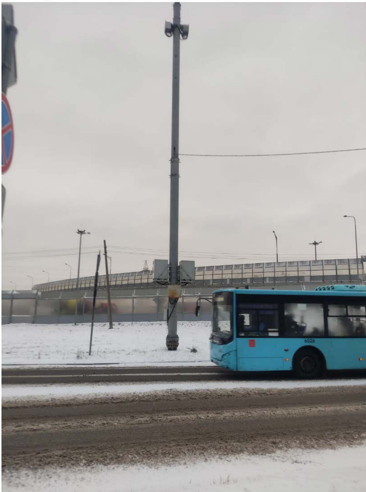
Точка фотофиксации Ф1. Вид с Ю.
