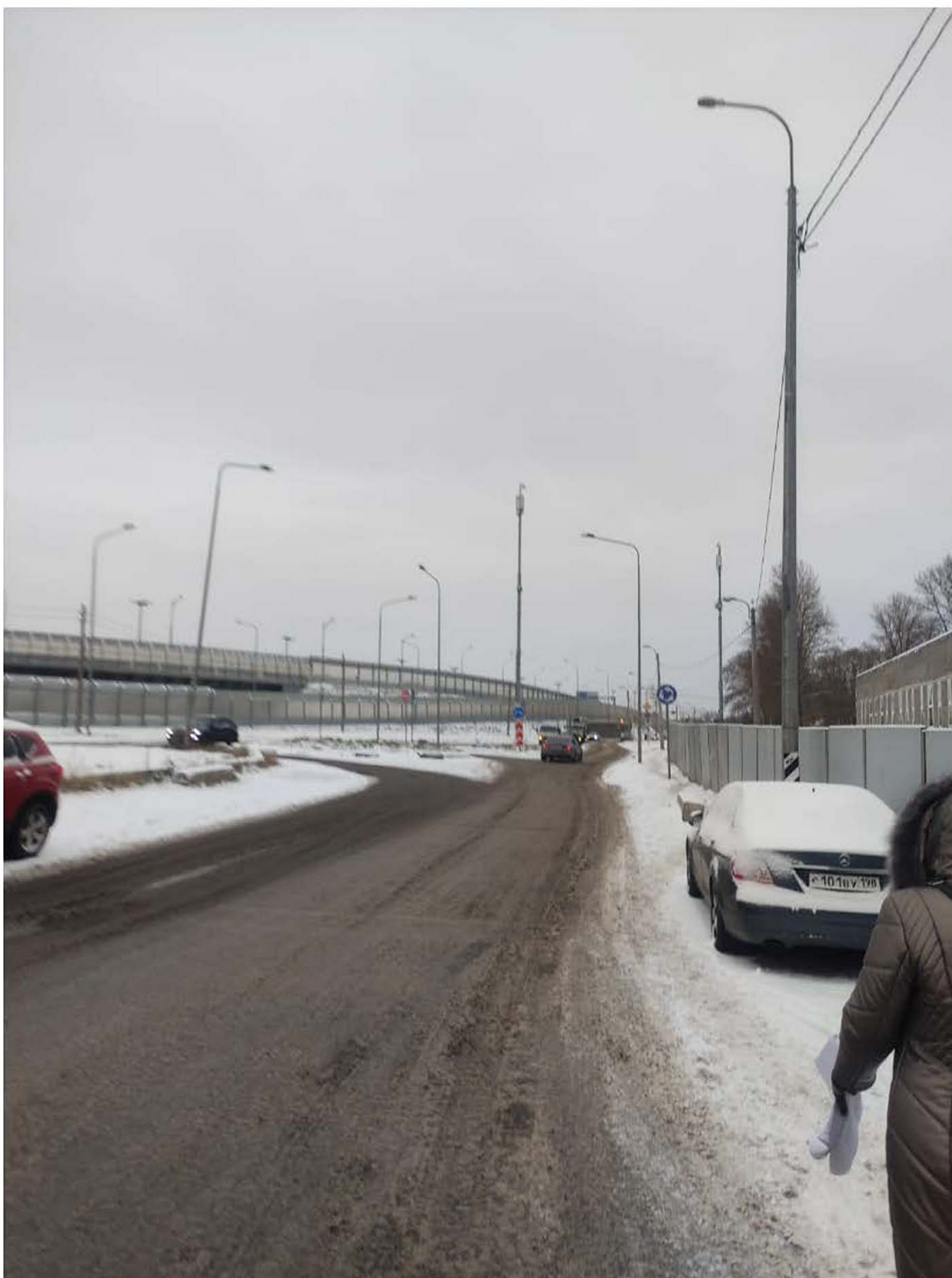
Точка фотофиксации Ф2. Вид с СЗ.
