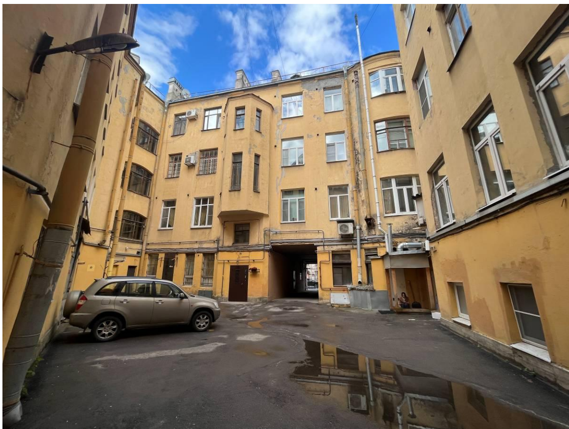
Фото 9. Фрагмент дворового фасада выявленного объекта культурного наследия «Дом А.И. Цеховой»
