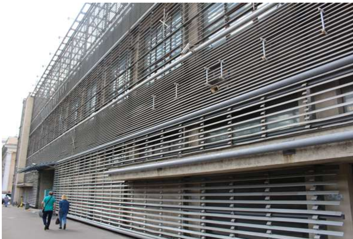
11. Фрагмент восточного фасада
