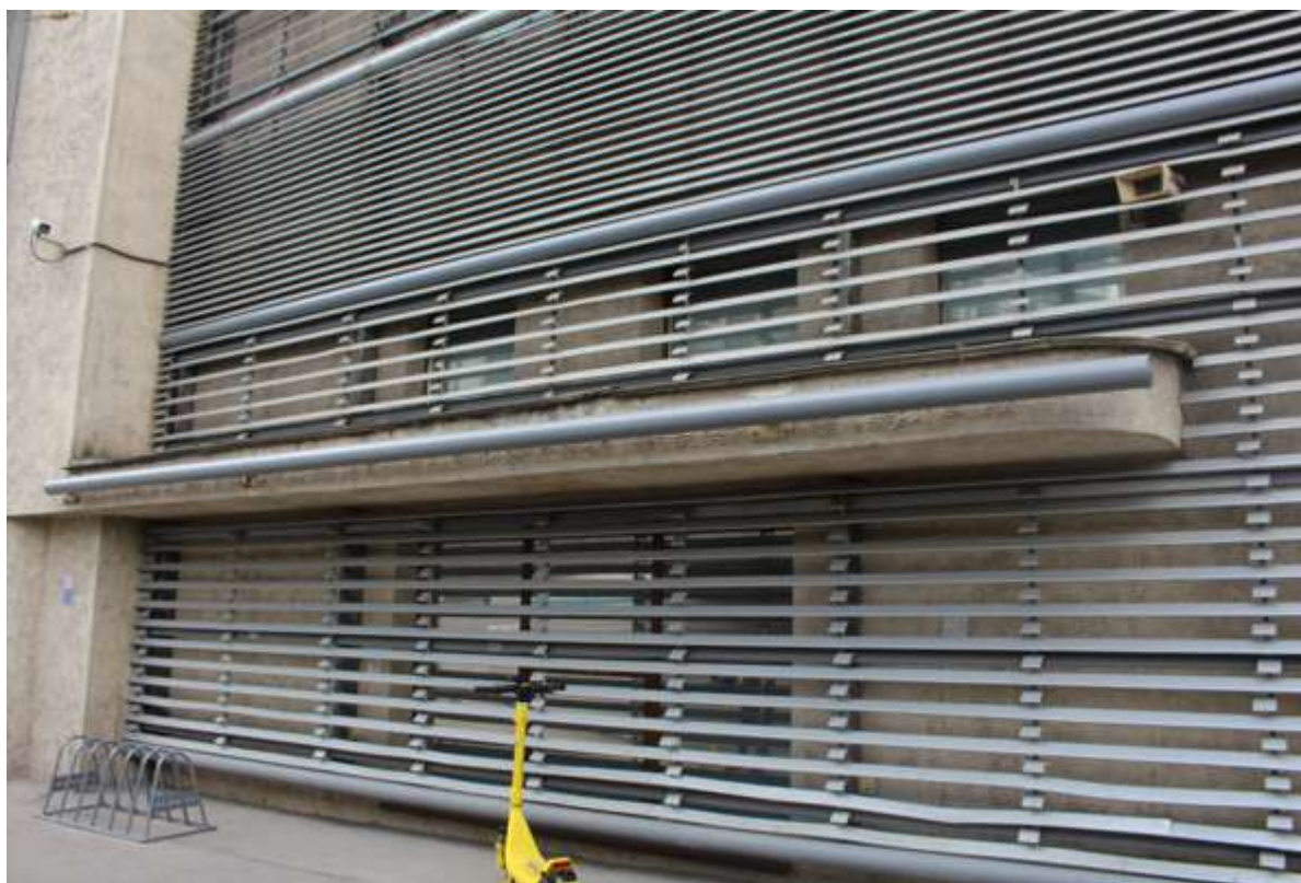
13. Фрагмент восточного фасада
