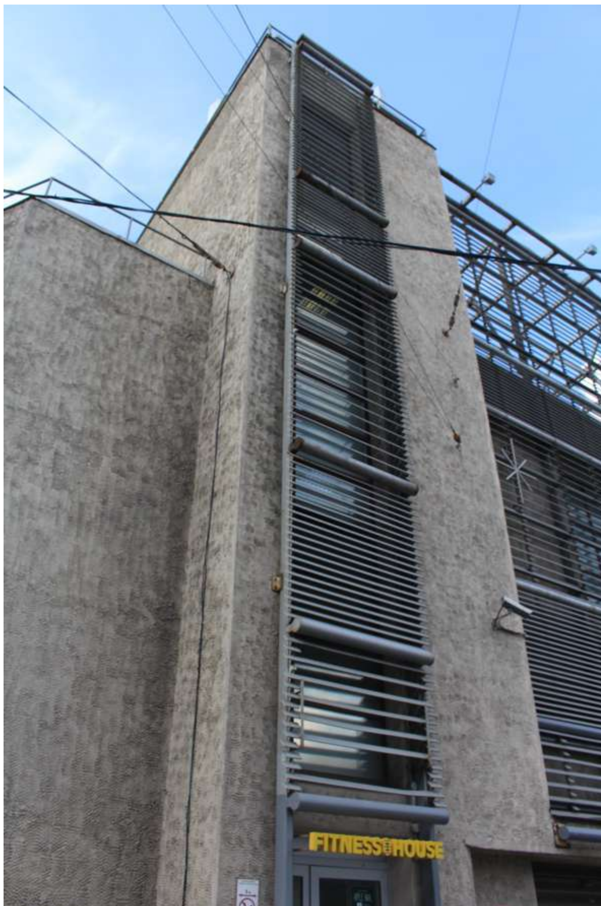
15. Фрагмент восточного фасада
