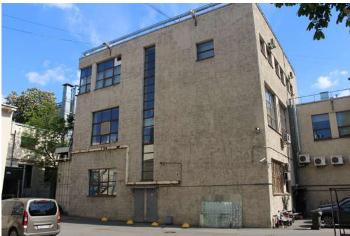
1. Фрагмент юго-западного фасада
