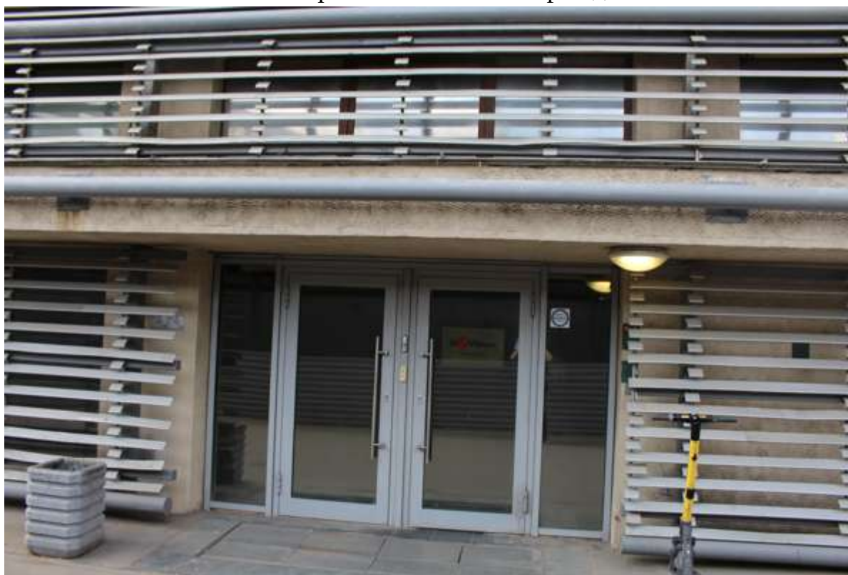
10. Фрагмент восточного фасада
