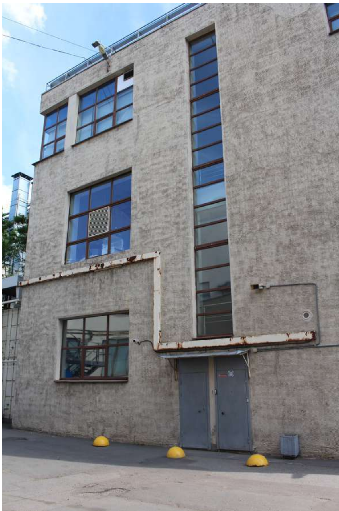
3. Фрагмент юго-западного фасада
