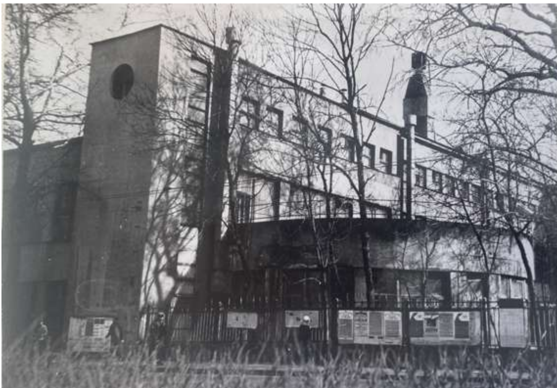
56. Западный фасад фабрики-кухни. 1984 г. ЦГАНТД СПб, ф. Р-448, оп. 323, д. 592
