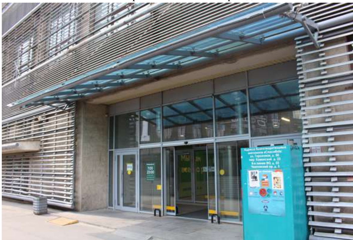
12. Фрагмент восточного фасада
