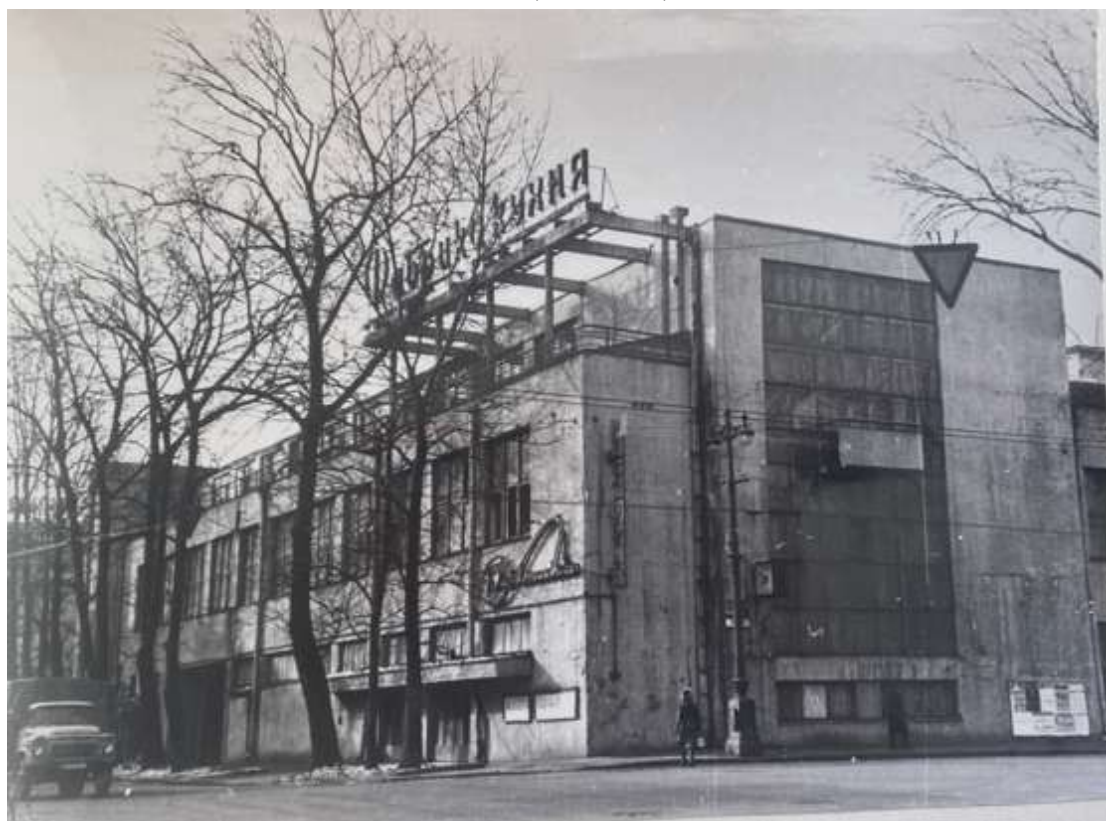
55. Восточный фасад фабрики-кухни. 1984 г. ЦГАНТД СПб, ф. Р-448, оп. 323, д. 592
