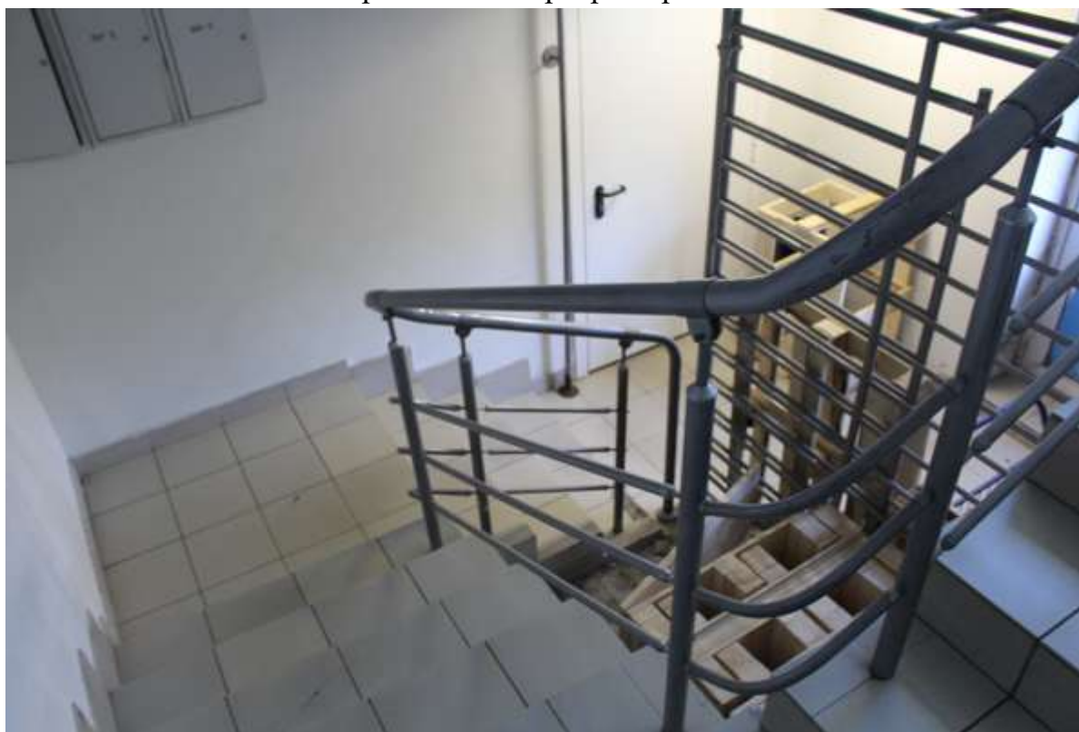
31. Фрагмент интерьера первого этажа
