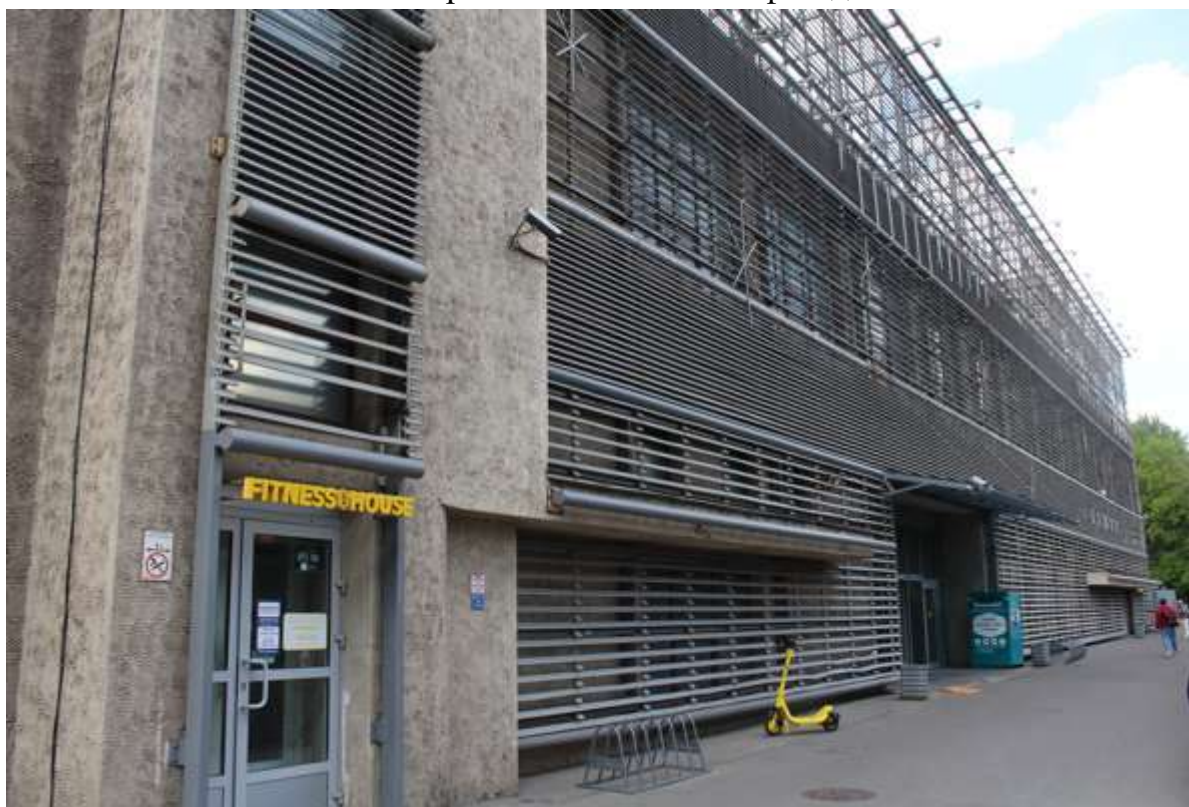
14. Фрагмент восточного фасада
