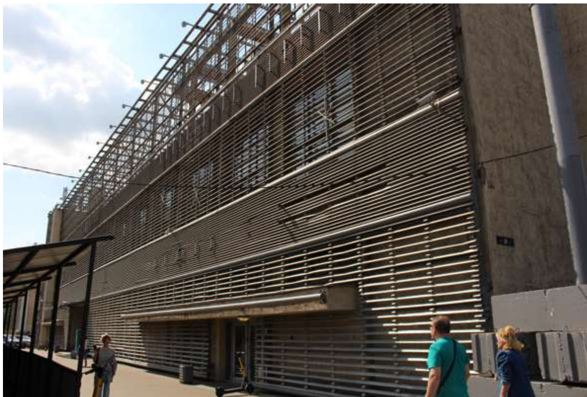
9. Фрагмент восточного фасада
