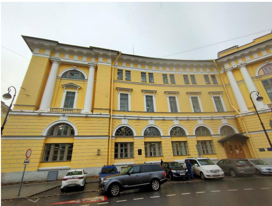
2. «Ансамбль улицы Зодчего Росси», ул. Зодчего Росси, д. 1-3, лит. А. Восточный фасад. Общий вид. Фото 12.10.2023г.
