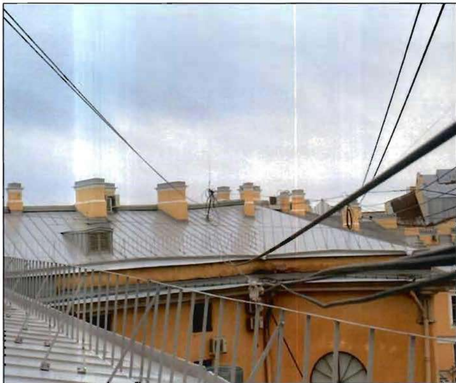
24. Металлическая кровля лицевого корпуса (со стороны пл. Ломоносова и ул. Зодчего Росси). Фото от 16.11.2021 г.
