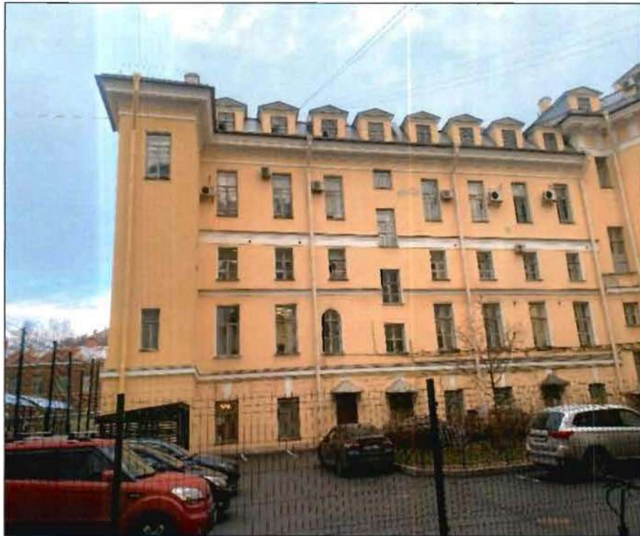
17. Юго-западный дворовый фасад со стороны Торгового переуллка. Общий вид. Фото от 19.11.2021 г
