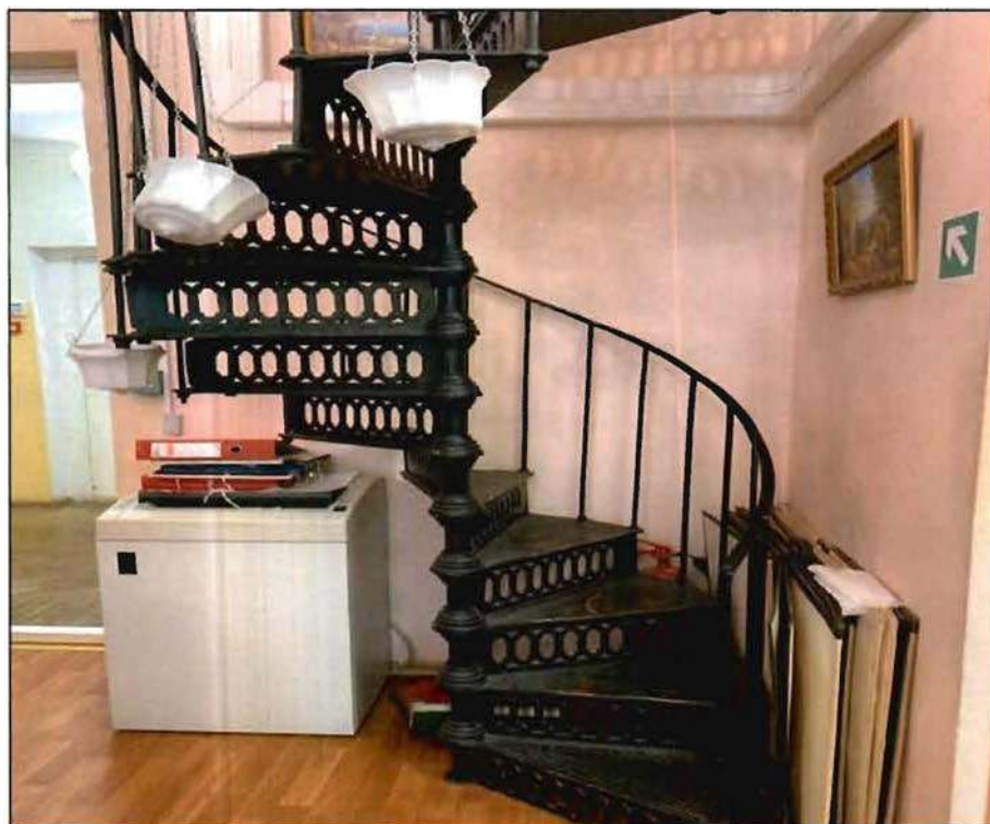
46. Металлическая винтовая лестница. в уровне 3-го этажа (пом. 27-Н (22)). Фото от 19.11.2021 г.
