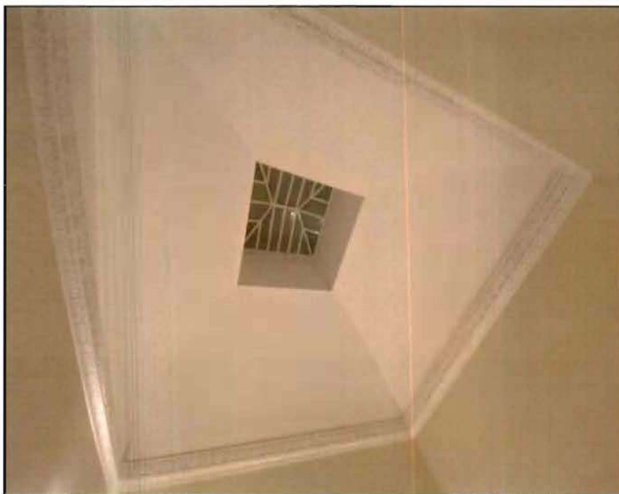
33. Прямоугольный в плане световой фонарь над четырехмаршевой железной лестницей (12ЛК) в пом. 39-Н (50). Фото от 16.11.2021 г.
