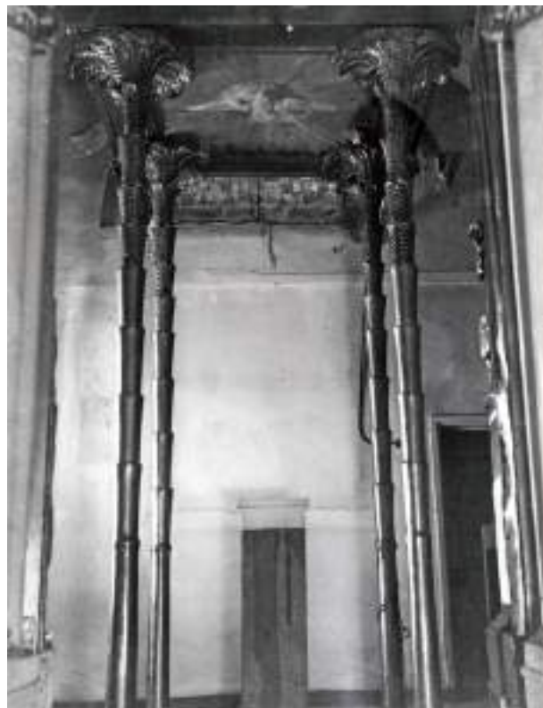
42. Бывшая домовая церковь. Надпрестольная сень. Фотография 1930 г. Архив КГИОП.
