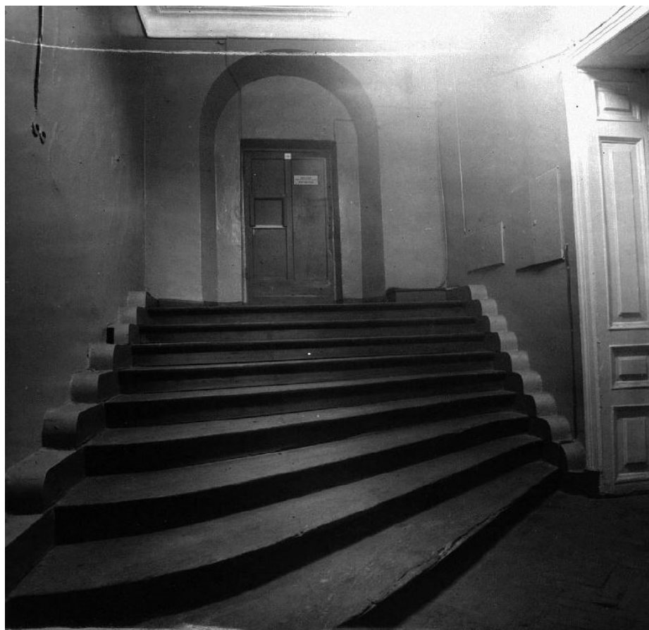
76. Лестница в большую домовую церковь. Фото 1991. Архив КГИОП.
