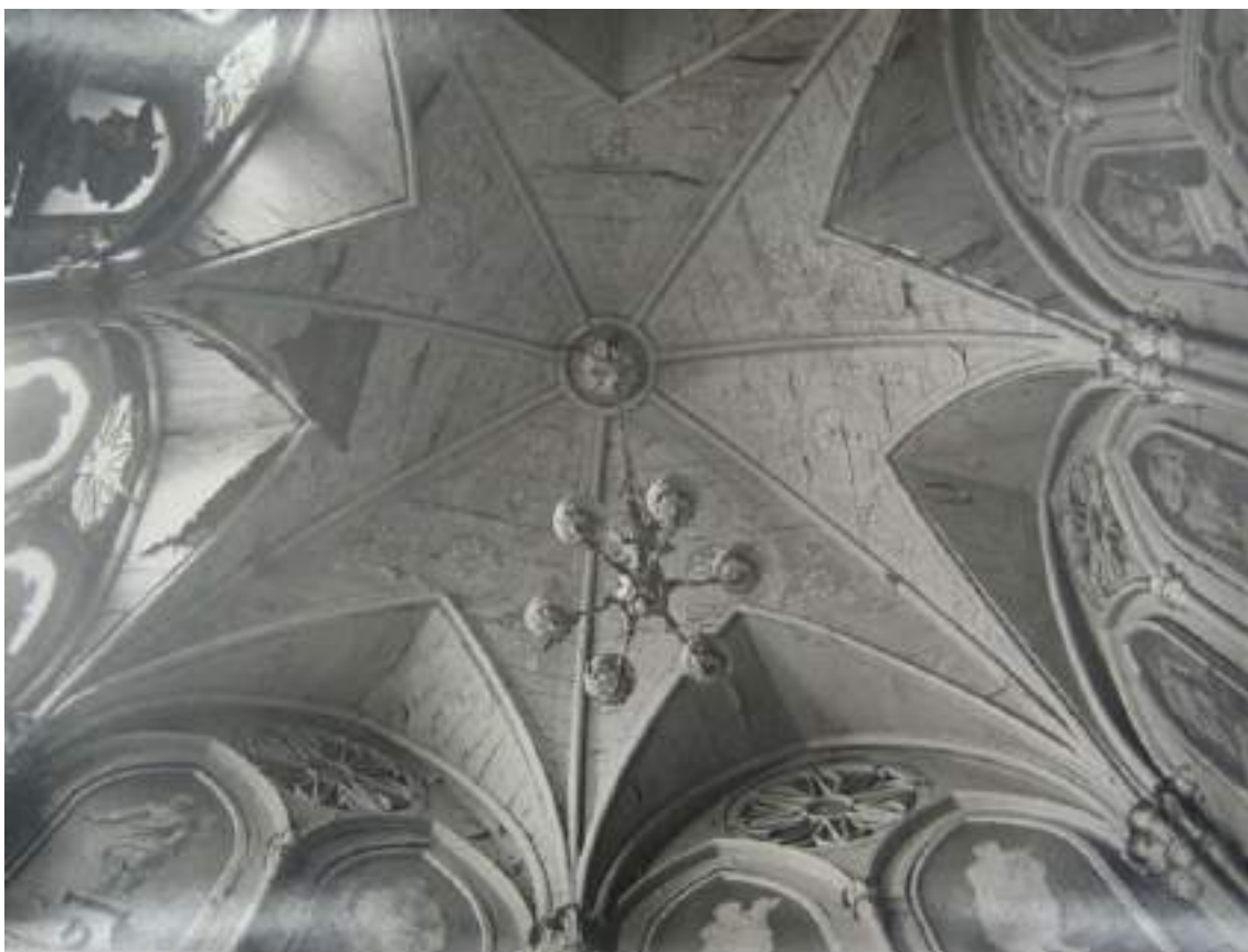
49. Притвор домової церкви. Вид плафона. Фото к.1930-х гг. Архив КГІОП.
