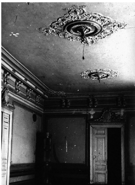
67. Главный корпус. Фрагмент интерьера большого зала приемной на 2 этаже. Фото 1946 г. Архив КГИОП.
