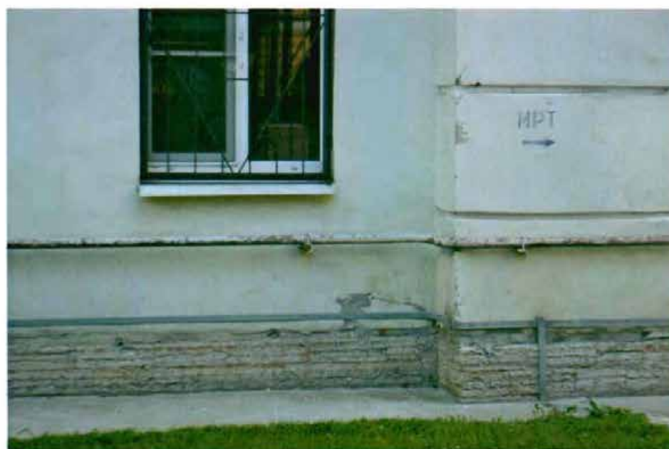
Фото 9. Фрагмент восточного фасада. Цоколь.
