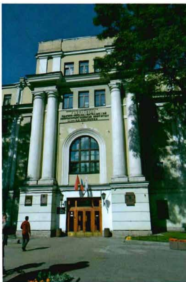
Фото 1. Фрагмент восточного фасада. Центральный вход.
