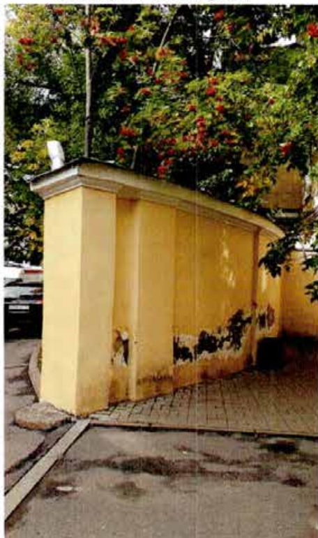
4. Северная часть ограды
