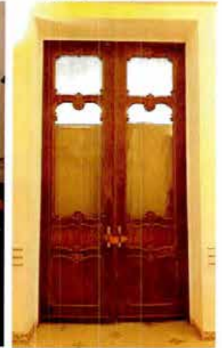
33. Дверной проем 1Н
