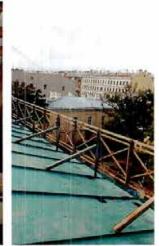
37. Вид на металлическую кровлю
