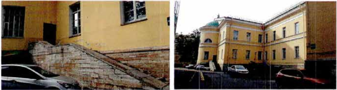
16. Северный фасад здания
