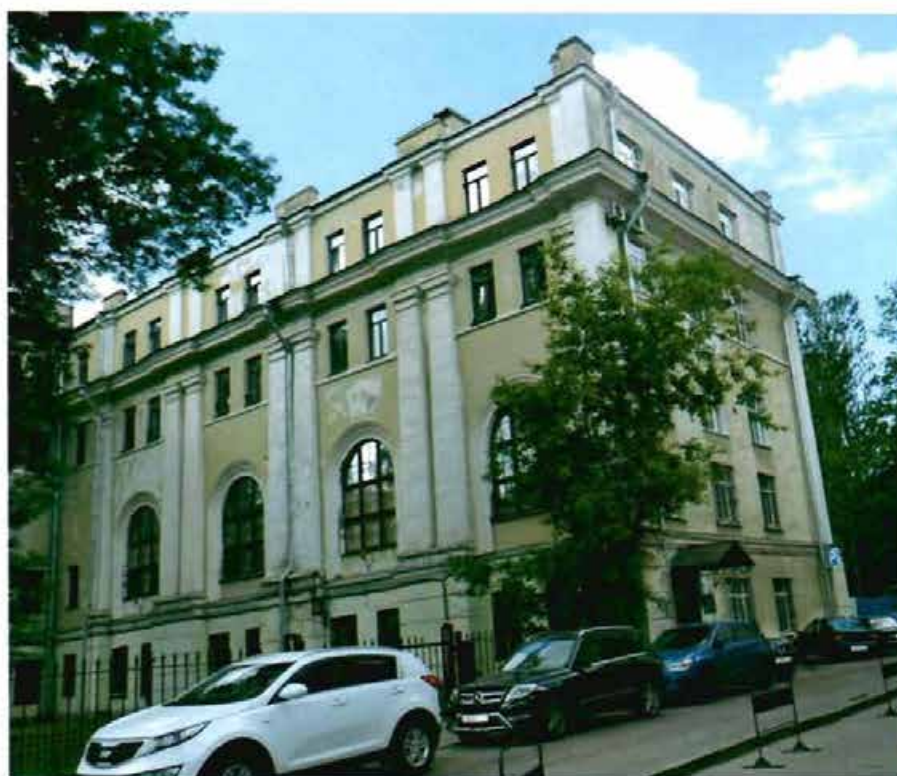
Фото 3. Фрагмент восточного фасада и северный фасад
