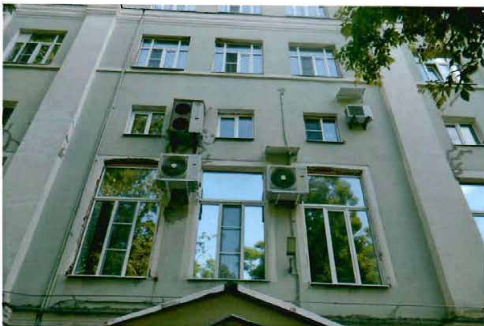
Фото 6. Фрагмент восточного фасада.
