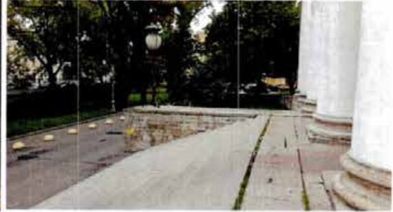
6. Крыльцо с западной стороны здания
