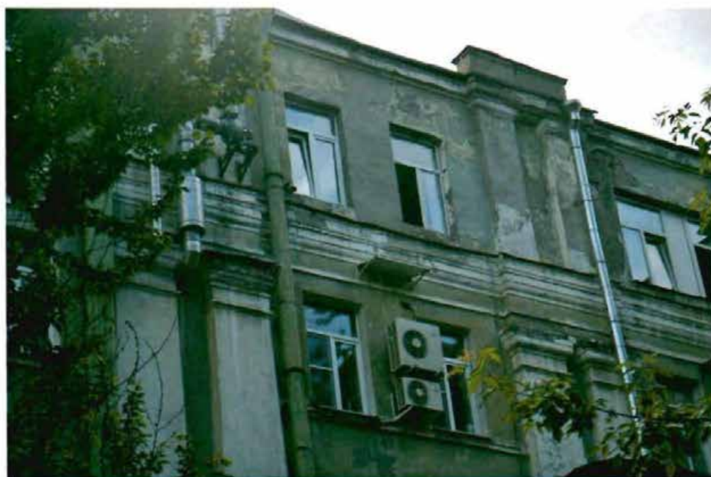
Фото 5. Фрагмент восточного фасада.
