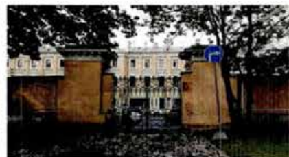
7. Металлическое заполнение ограды
