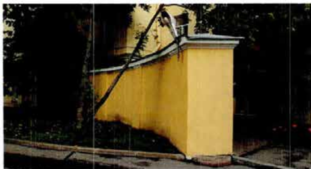
3. Северная часть ограды
