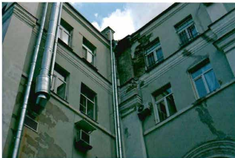
Фото 8. Фрагмент восточного фасада.
