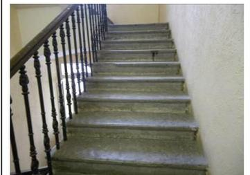
металлическая полувинтовая лестница с забежными металлическими ступенями, с двумя металлическими площадками, с ограждениями в виде стоек чугунного литья с перехватами;
