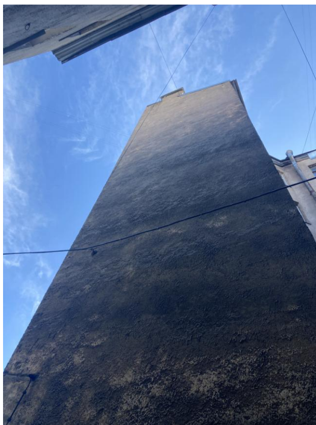
Фото 12. Фрагмент дворового фасада выявленного объекта культурного наследия «Дом Н.И. Алексева»
