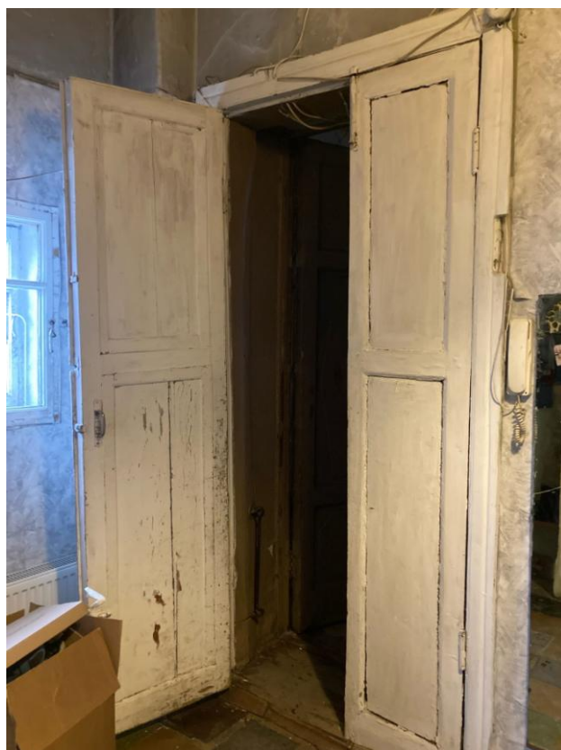
Фото 14. Интерьер квартиры № 24 выявленного объекта культурного наследия «Дом Н.И. Алексева», вход со стороны квартиры
