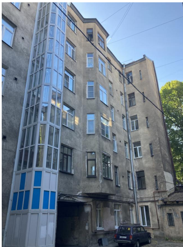
Фото 11. Фрагмент дворового фасада выявленного объекта культурного наследия «Дом Н.И. Алексева»
