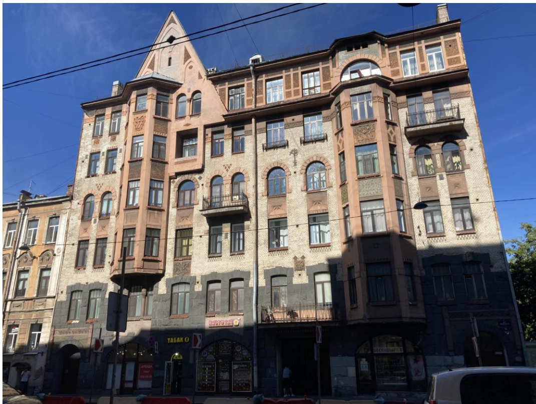
Фото 1. Лицевой фасад выявленного объекта культурного наследия «Дом Н.И. Алексева»
