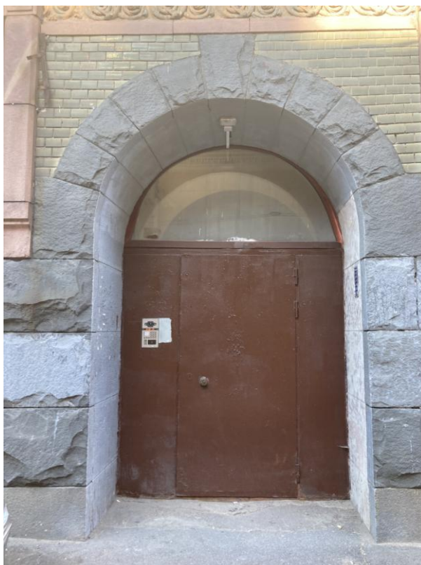
Фото 3. Фрагмент лицевого фасада выявленного объекта культурного наследия «Дом Н.И. Алексева», вход в парадную
