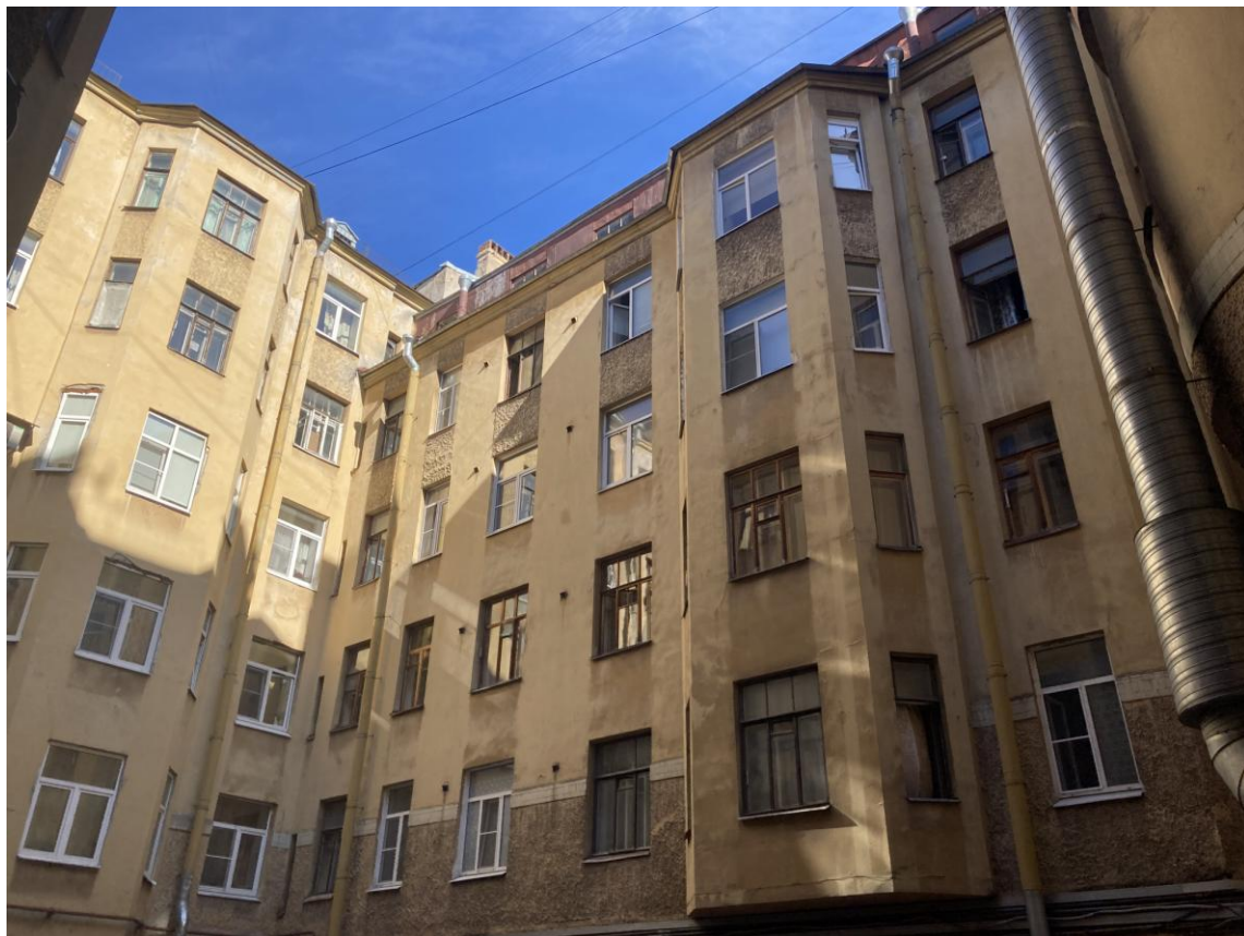
Фото 6. Фрагмент дворового фасада выявленного объекта культурного наследия «Дом Н.И. Алексева»
