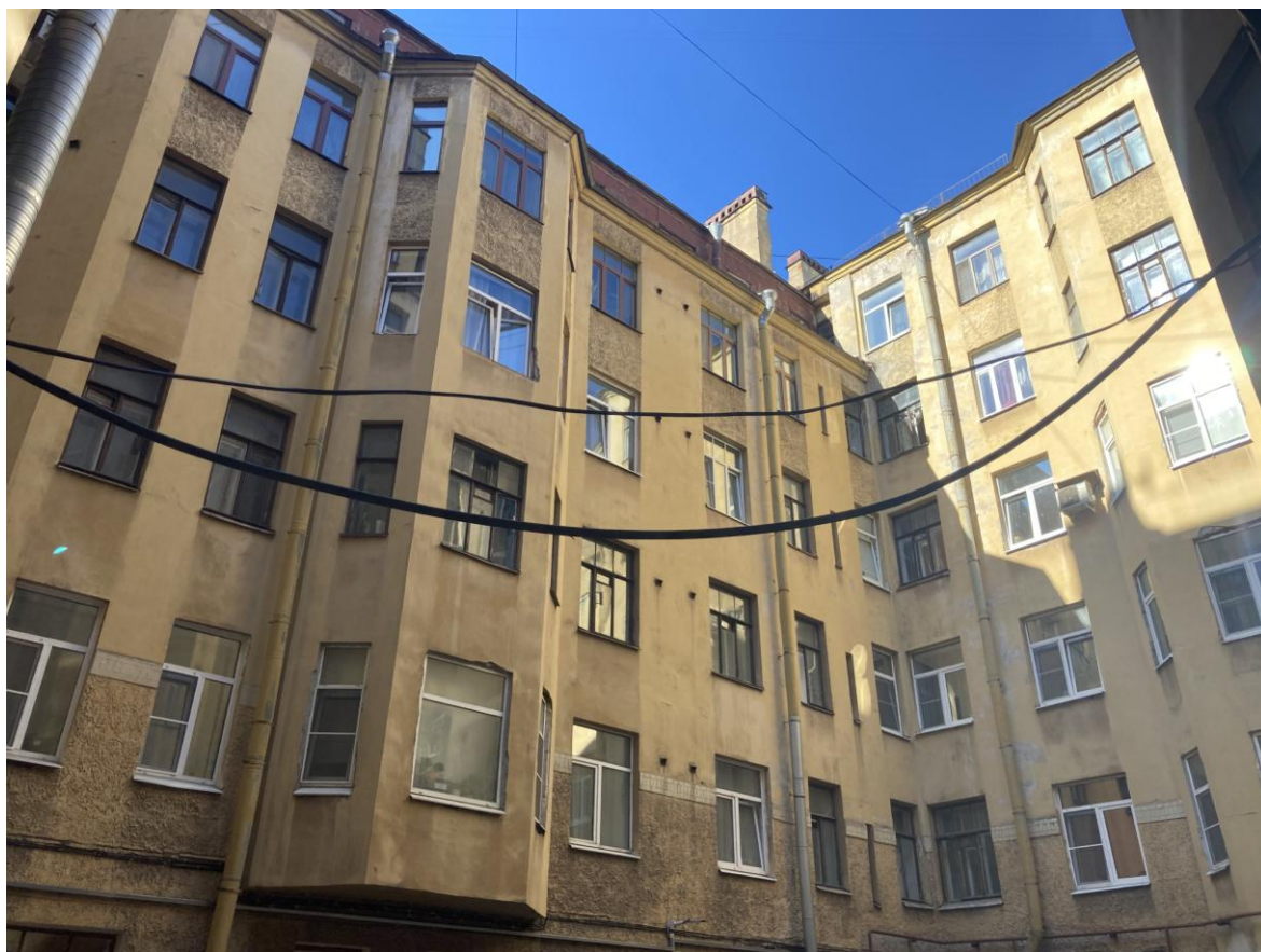
Фото 5. Фрагмент дворового фасада выявленного объекта культурного наследия «Дом Н.И. Алексева»
