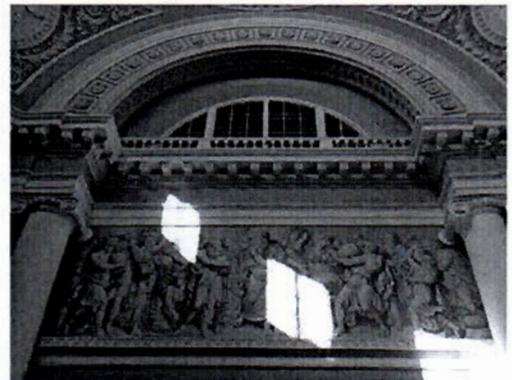
лепной раскрепованный антаблемент, опоясывающий зал: профилированный архитрав, гладкий фриз, профилированный карниз с иониками и розетками на модульонах;
