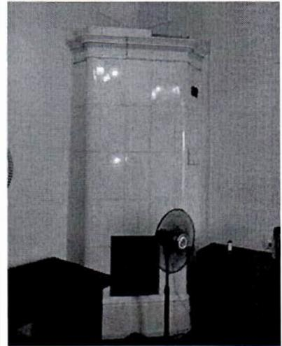
печи и средистенный камин (в один ярус, оштукатуренный, окрашенный), расположенные в помещениях 409, 412, 418, 419, 424, 444, второго этажа центральной части здания в настоящее время зашиты;
