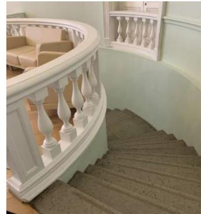
лестница, расположенная в северо-восточной части центральной части здания, ведущая из помещения 1-Н(67) в помещения 2-го этажа: средистенная, двухмаршевая, со ступенями из лещадной плиты и площадками на коробовых сводах, с деревянным профилированным поручнем;
