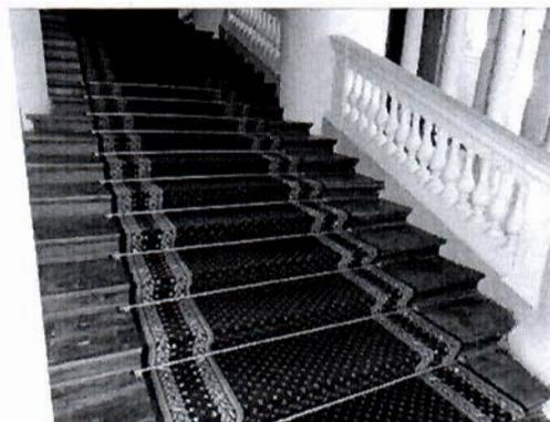
6. четыре деревянные лестницы, ведущие в «Думский зал» из помещений 1-Н(80) и 1-Н(118): расположены в юго-восточной и юго-западной частях центральной части здания: дубовые, в один марш, ограждение выполнено в виде резной балюстрады под профилированным поручнем;
