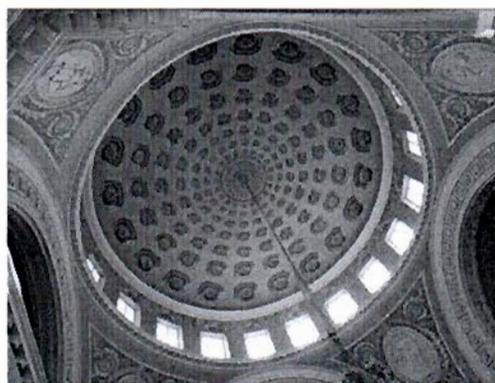
с медальонами, грифонами и вазонами (клеевая монохромная живопись в технике гризайль); широкий лепной профилированный карниз с иониками и сухариками на модульонах - в основании светового барабана;
