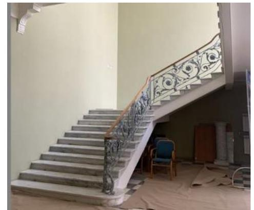
рисунок ограждения: вертикальные, прямоугольные в сечении стойки, завершенные стилизованными цветочными бутонами и горизонтальными перехватами, в образованные секторы вписаны ветви с листьями и розетками;
