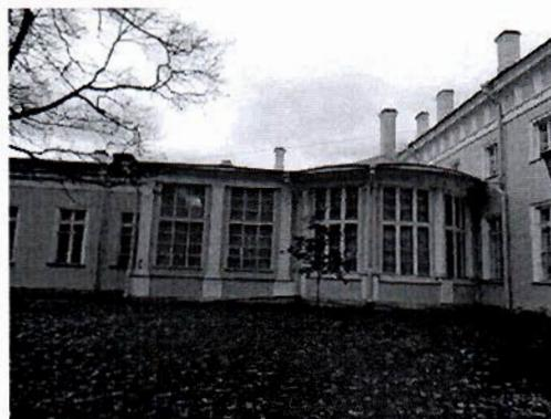
междуэтажные карнизы; профилированный карниз с сухариками, завершающий фасады флигелей; профилированный карниз, завершающий фасады галерей.
