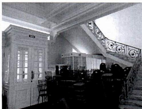
площадки второго этажа завершены профилированным карнизом значительного выноса на кронштейнах; потолки с высокой штукатурной падугой оформлены профилированными тягами;
