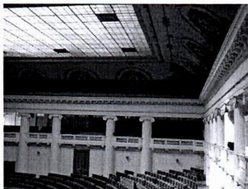
колонны и полуколонны ионического ордера, расположенные по периметру зала;
