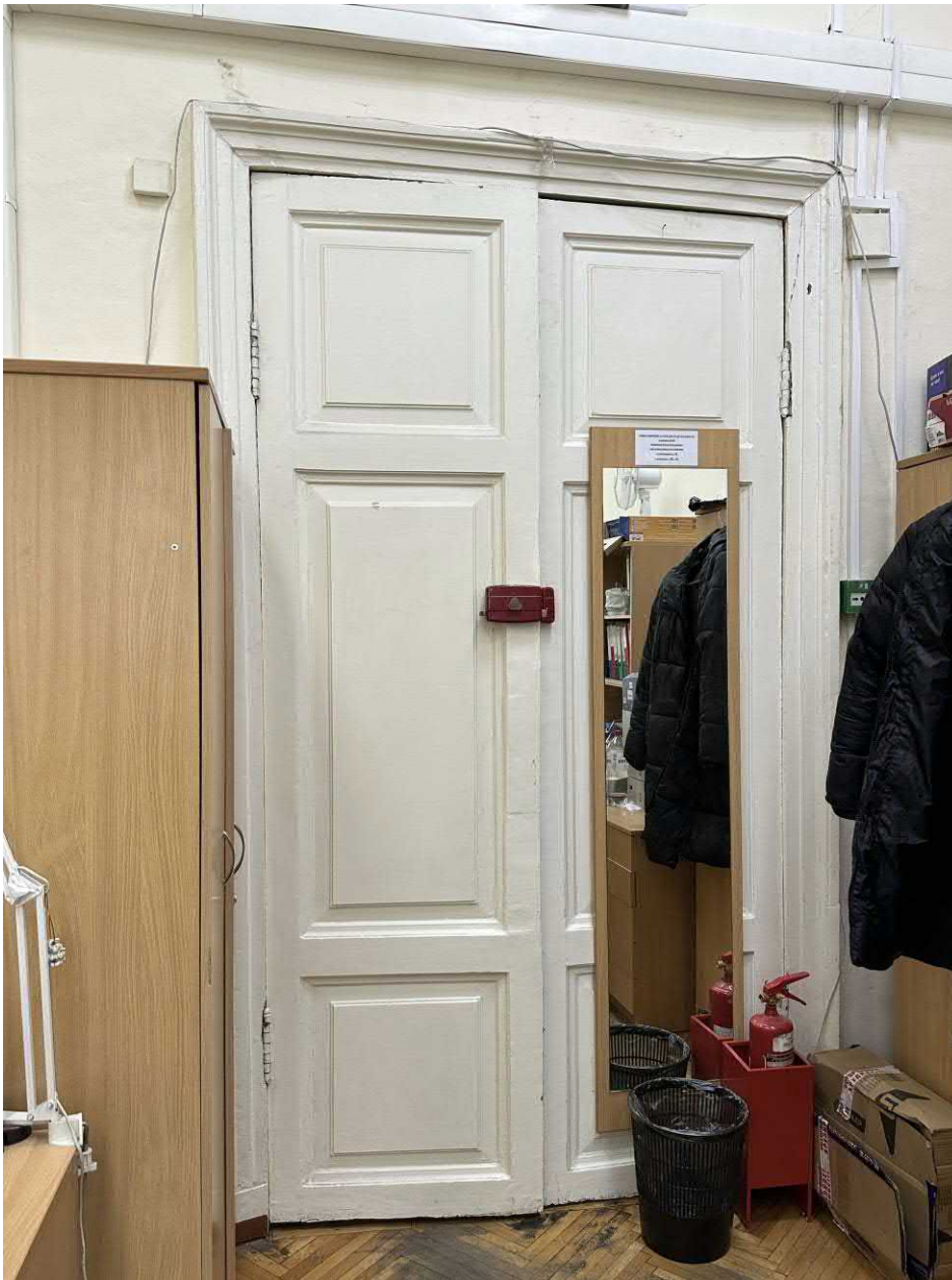
Фото 5. Вид двери Д-1 в помещении 37-Н (ч.п. 15)
