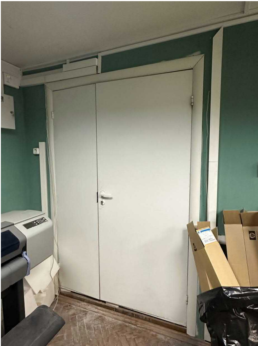
Фото 12. Вид двери Д-4, в помещении 33-Н
