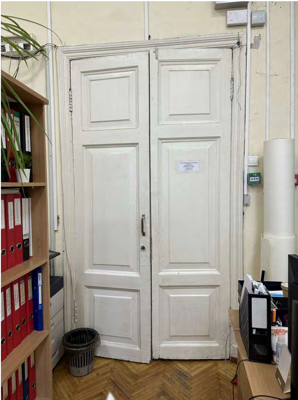
Фото 2. Вид двери Д-3 в помещении 37-Н (ч.п. 24)
