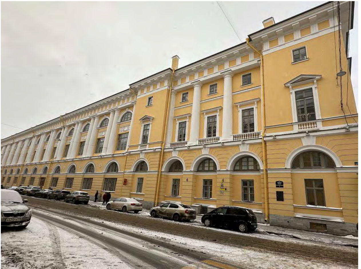
Общий вид здания
