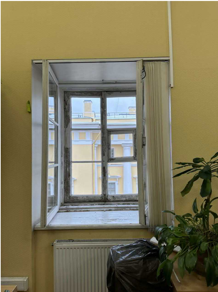
Фото 7. Вид окна ОК-6, в помещении 37-Н (ч.п. 28)
