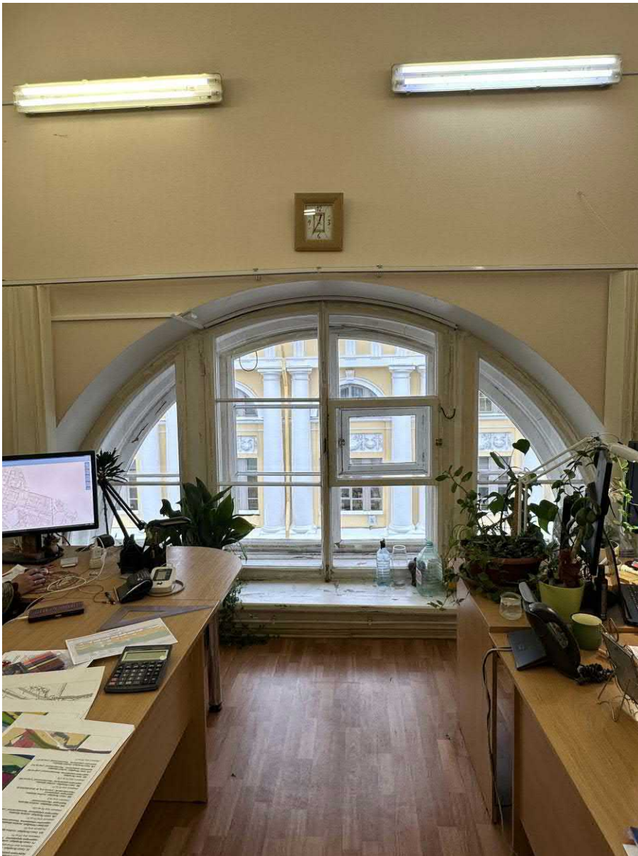
Фото 8. Вид окна ОК-4, в помещении 37-Н (ч.п. 44)
