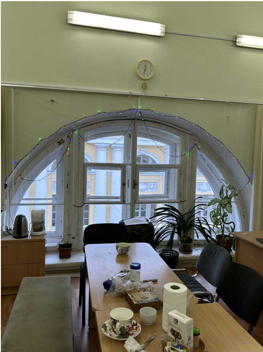
Фото 9. Вид окна ОК-3, в помещении 37-Н (ч.п. 76, 77)
