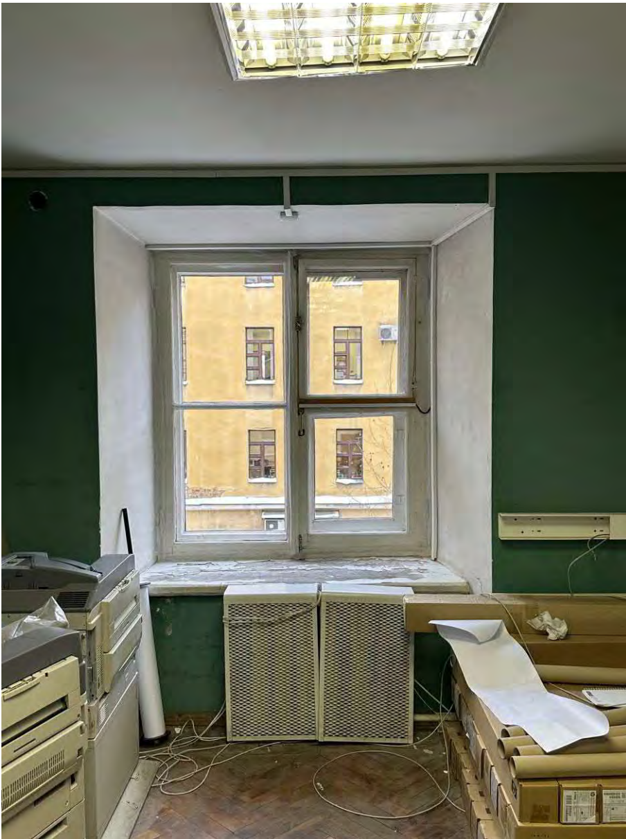
Фото 11. Вид окна ОК-1, в помещении 33-Н
