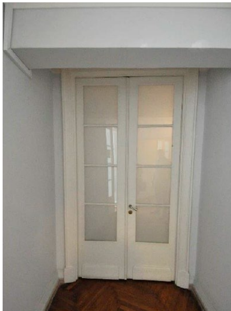
2. Помещение № 537 в уровне 2-го этажа объекта культурного наследия федерального значения «Дворец Таврический. Дворец», расположенного по адресу: г. Санкт-Петербург, ул. Шпалерная, д. 47, лит. А. 01.11.2023
