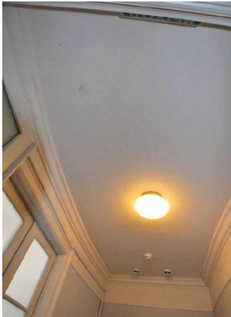
3. Помещение № 537 в уровне 2-го этажа объекта культурного наследия федерального значения «Дворец Таврический. Дворец», расположенного по адресу: г. Санкт-Петербург, ул. Шпалерная, д. 47, лит. А. 01.11.2023
