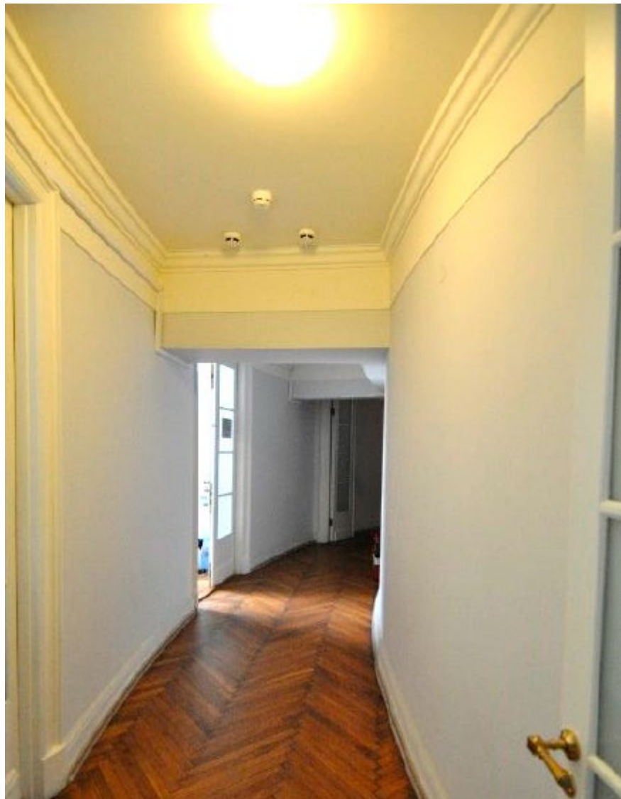
12. Помещение № 539 в уровне 2-го этажа объекта культурного наследия федерального значения «Дворец Таврический. Дворец», расположенного по адресу: г. Санкт-Петербург, ул. Шпалерная, д. 47, лит. А. 01.11.2023
