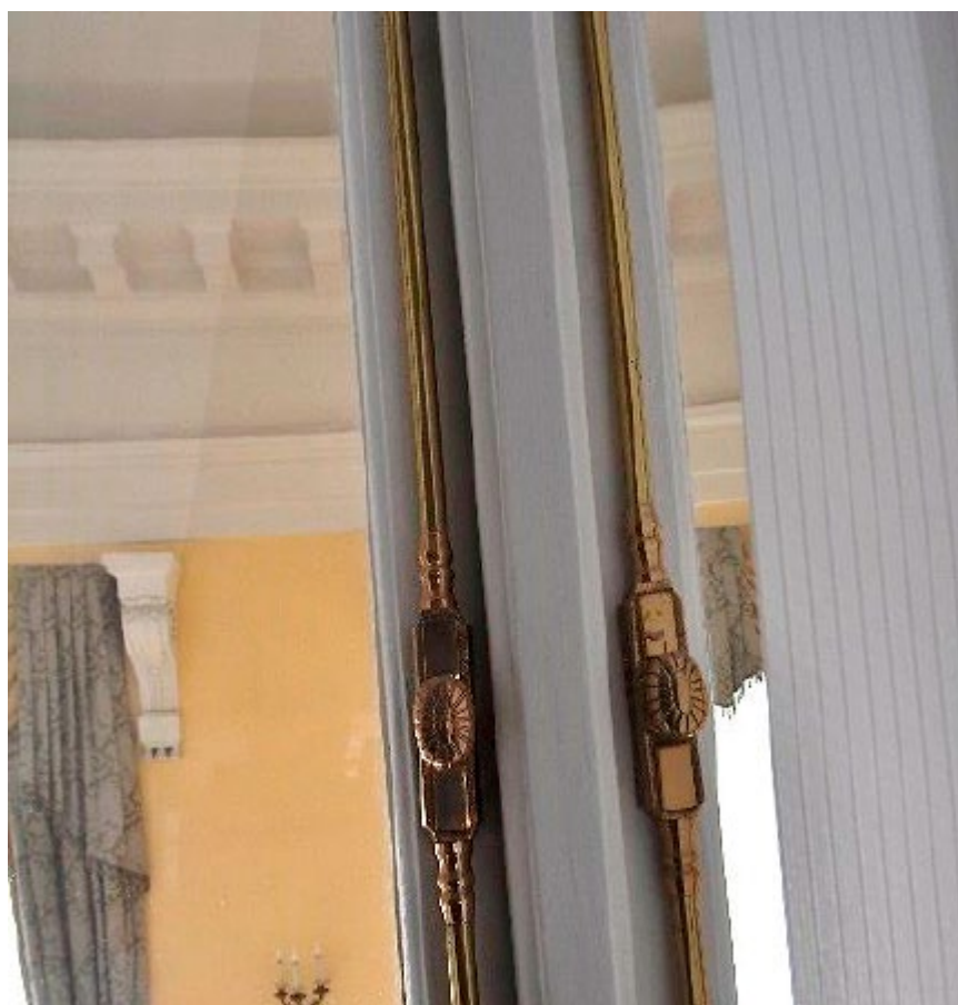
18. Помещение № 540 в уровне 2-го этажа объекта культурного наследия федерального значения «Дворец Таврический. Дворец», расположенного по адресу: г. Санкт-Петербург, ул. Шпалерная, д. 47, лит. А. 01.11.2023
