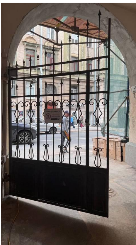
Фото 14. Вид на дворовые фасады объекта культурного наследия регионального значения «Здание приюта для детей-идиотов и эпилептиков Братства во имя Царицы Небесной с примыкающей часовней при домовая церкви Божьей Матери Скорбящих Радости», воротный проезд
