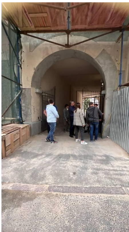
Фото 10. Вид на дворовые фасады объекта культурного наследия регионального значения «Здание приюта для детей-идиотов и эпилептиков Братства во имя Царицы Небесной с примыкающей часовней при домово́й церкви Божьей Матери Скорбящих Радости», воротный проезд
