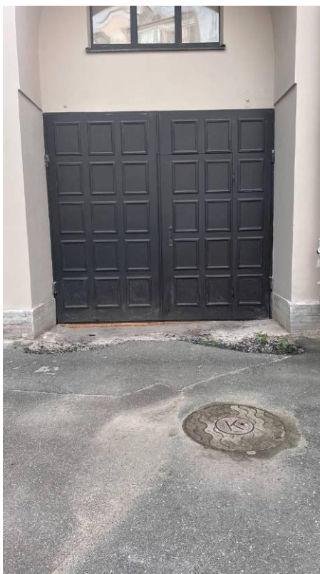
Фото 9. Вид на дворовые фасады объекта культурного наследия регионального значения «Здание приюта для детей-идиотов и эпилептиков Братства во имя Царицы Небесной с примыкающей часовней при домово́й церкви Божьей Матери Скорбящих Радости», вход в объект
