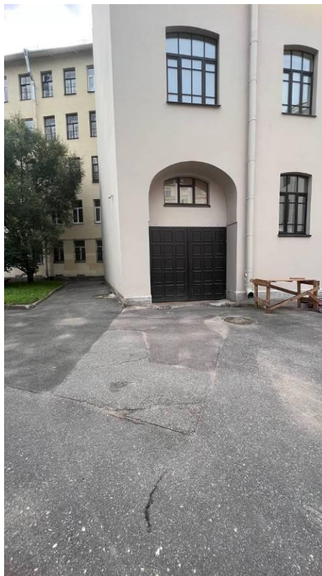
Фото 8. Вид на дворовые фасады объекта культурного наследия регионального значения «Здание приюта для детей-идиотов и эпилептиков Братства во имя Царицы Небесной с примыкающей часовней при домово́й церкви Божьей Матери Скорбящих Радости»
