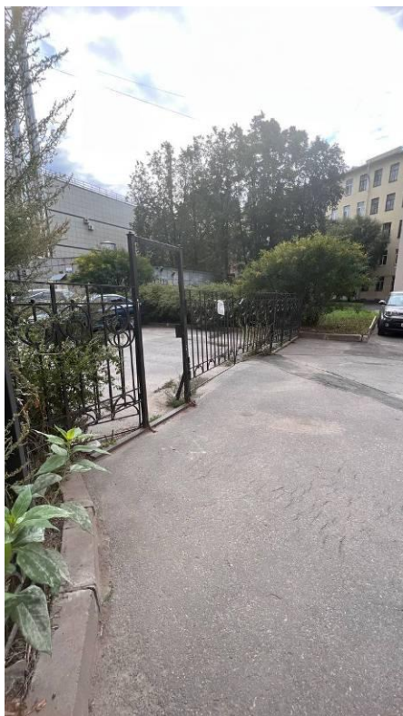
Фото 3. Вид на дворовые фасады объекта культурного наследия регионального значения «Здание приюта для детей-идиотов и эпилептиков Братства во имя Царицы Небесной с примыкающей часовней при домово́й церкви Божьей Матери Скорбящих Радости»
