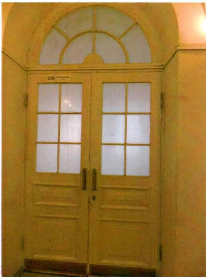
Фото 11. Двустворчатые двери с арочным завершением.
