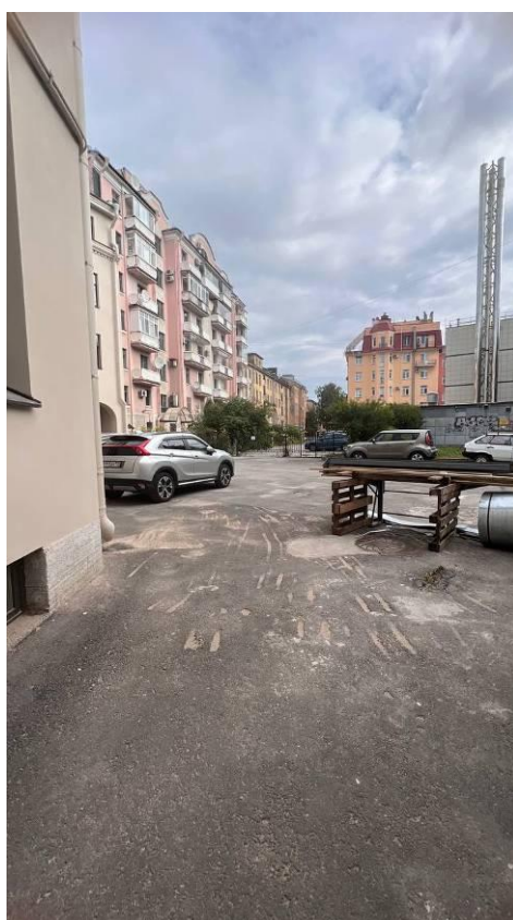
Фото 4. Вид на дворовые фасады объекта культурного наследия регионального значения «Здание приюта для детей-идиотов и эпилептиков Братства во имя Царицы Небесной с примыкающей часовней при домово́й церкви Божьей Матери Скорбящих Радости»
