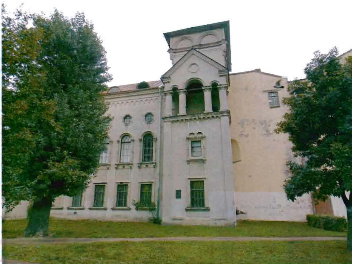
Фото 3. Часть западного фасада.
