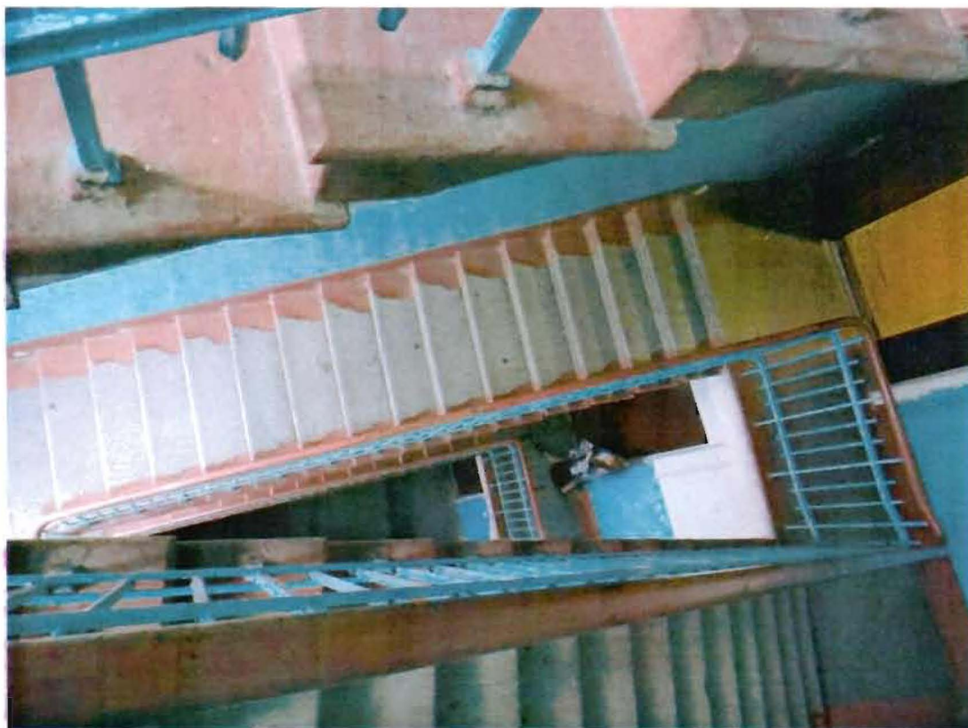
Фото 14. Лестница в южной части здания, пом. Н-2.
