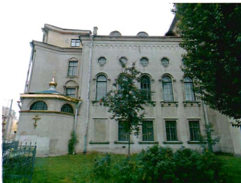
Фото 2. Часть западного фасада.
