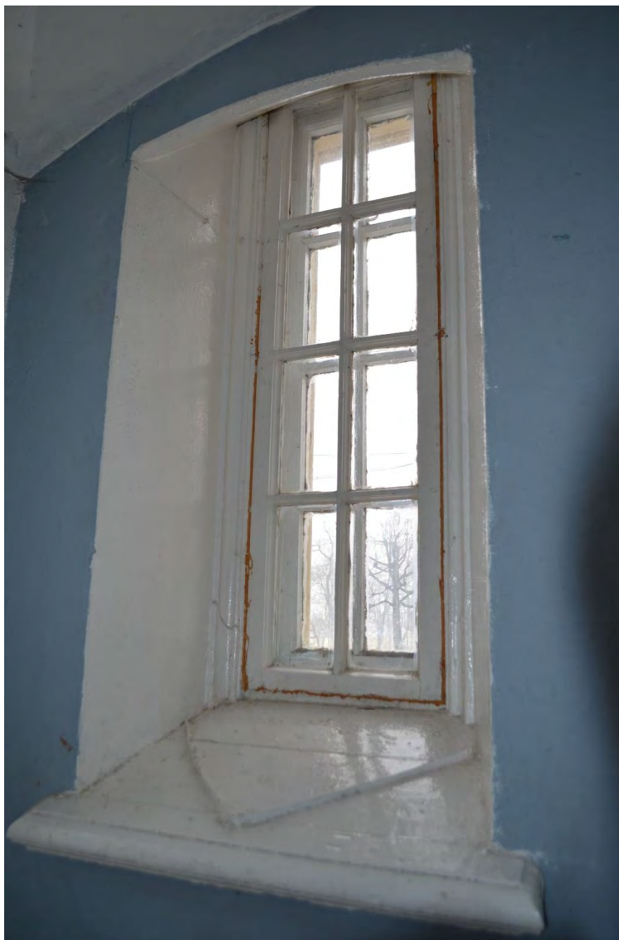
Фото 60. Объект культурного наследия федерального значения «Церковь лютеранская Воскресения Христова». Второй этаж. Помещение 1-Н (18). Оконный проём. Общий вид. Съёмка 31.10.2022 г.
