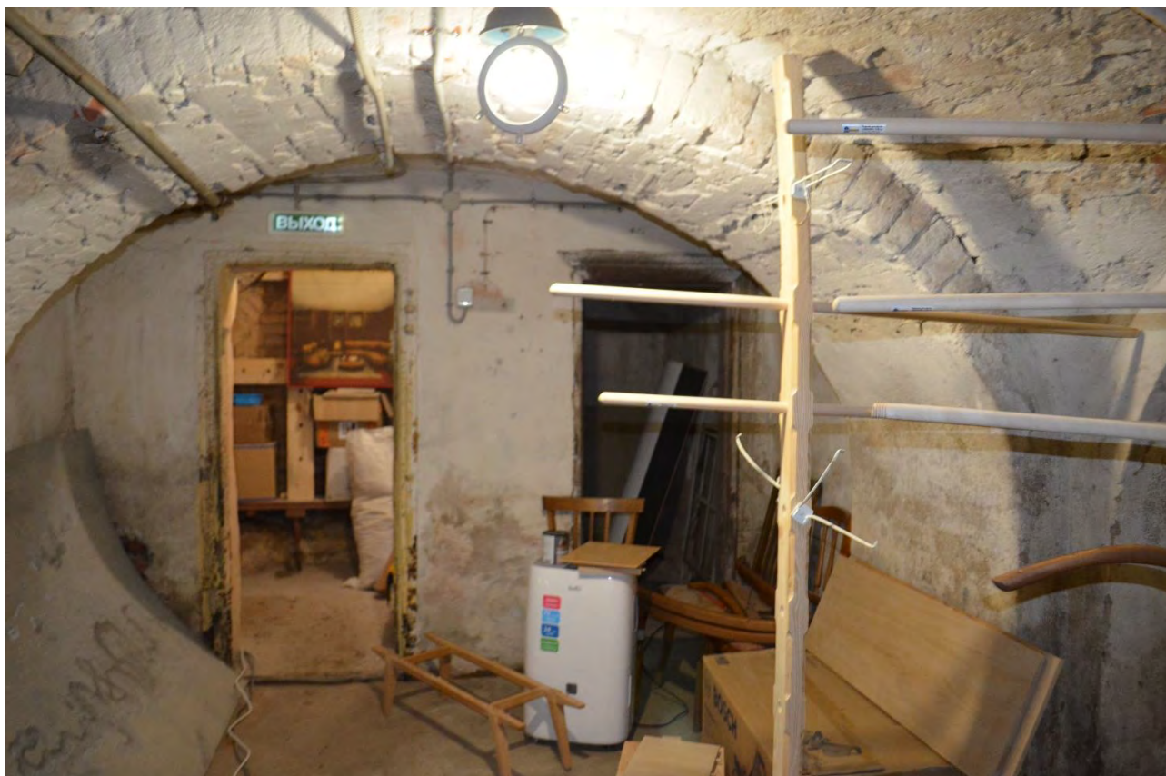
Фото 36. Объект культурного наследия федерального значения «Церковь лютеранская Воскресения Христова». Подвал. Помещение 2-Н (5). Фрагмент. Съёмка 31.10.2022 г.
