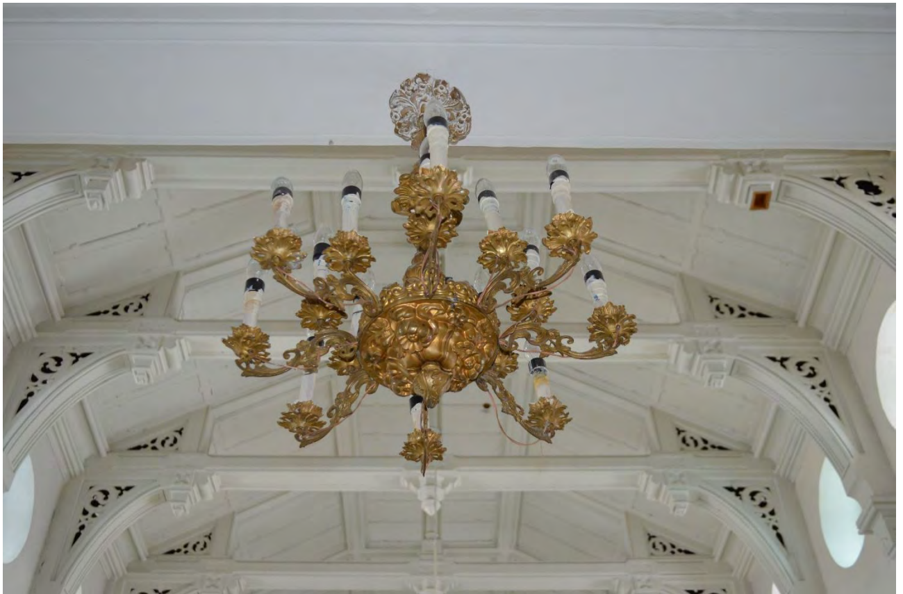
Фото 78. Объект культурного наследия федерального значения «Церковь лютеранская Воскресения Христова». Второй этаж. Помещение 1-Н (15). Церковный зал. Фрагмент. Съёмка 31.10.2022 г.
