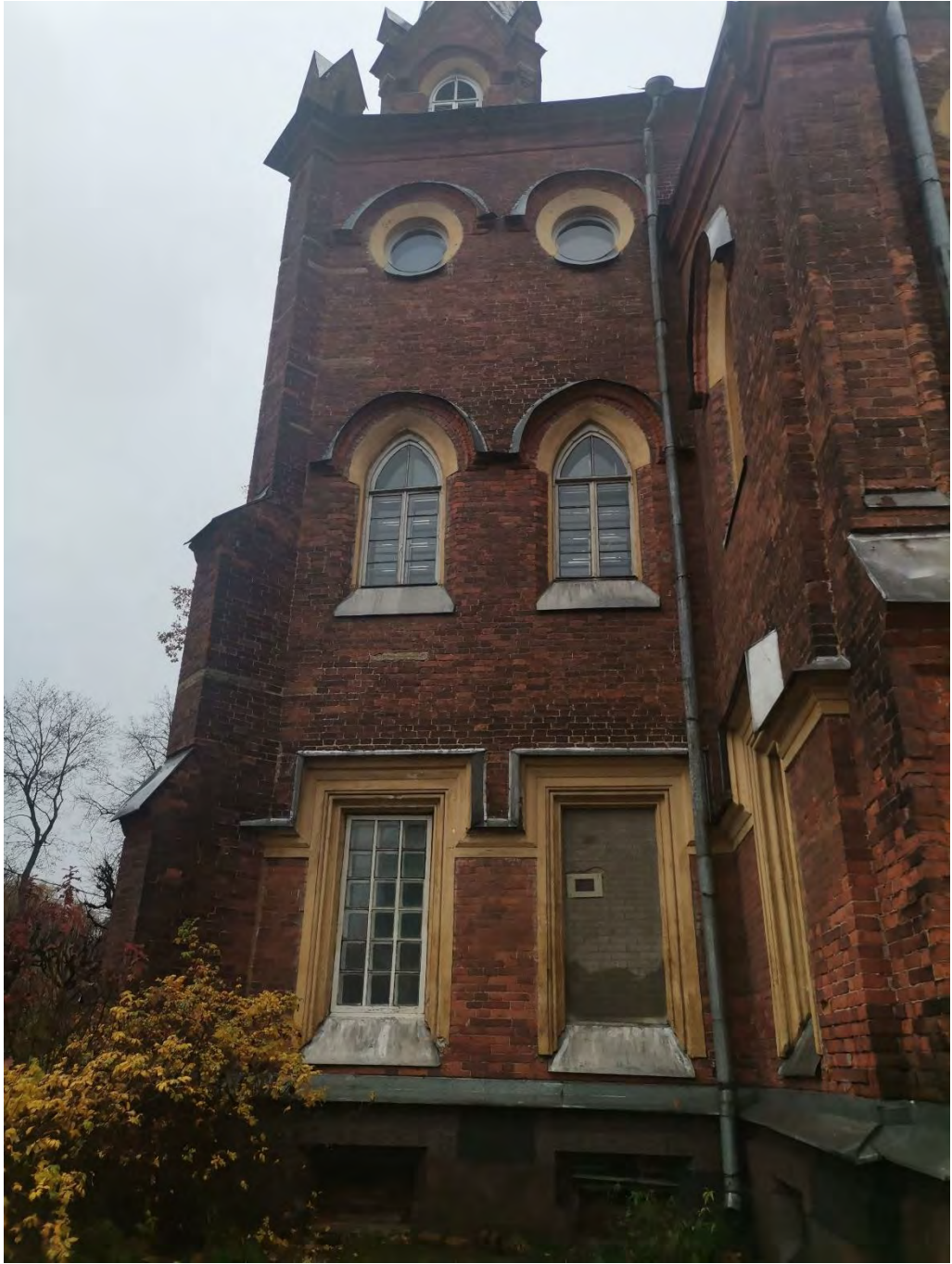
Фото 06. Объект культурного наследия федерального значения «Церковь лютеранская Воскресения Христова». Северо-восточный фасад. Фрагмент. Съёмка 31.10.2022 г.
