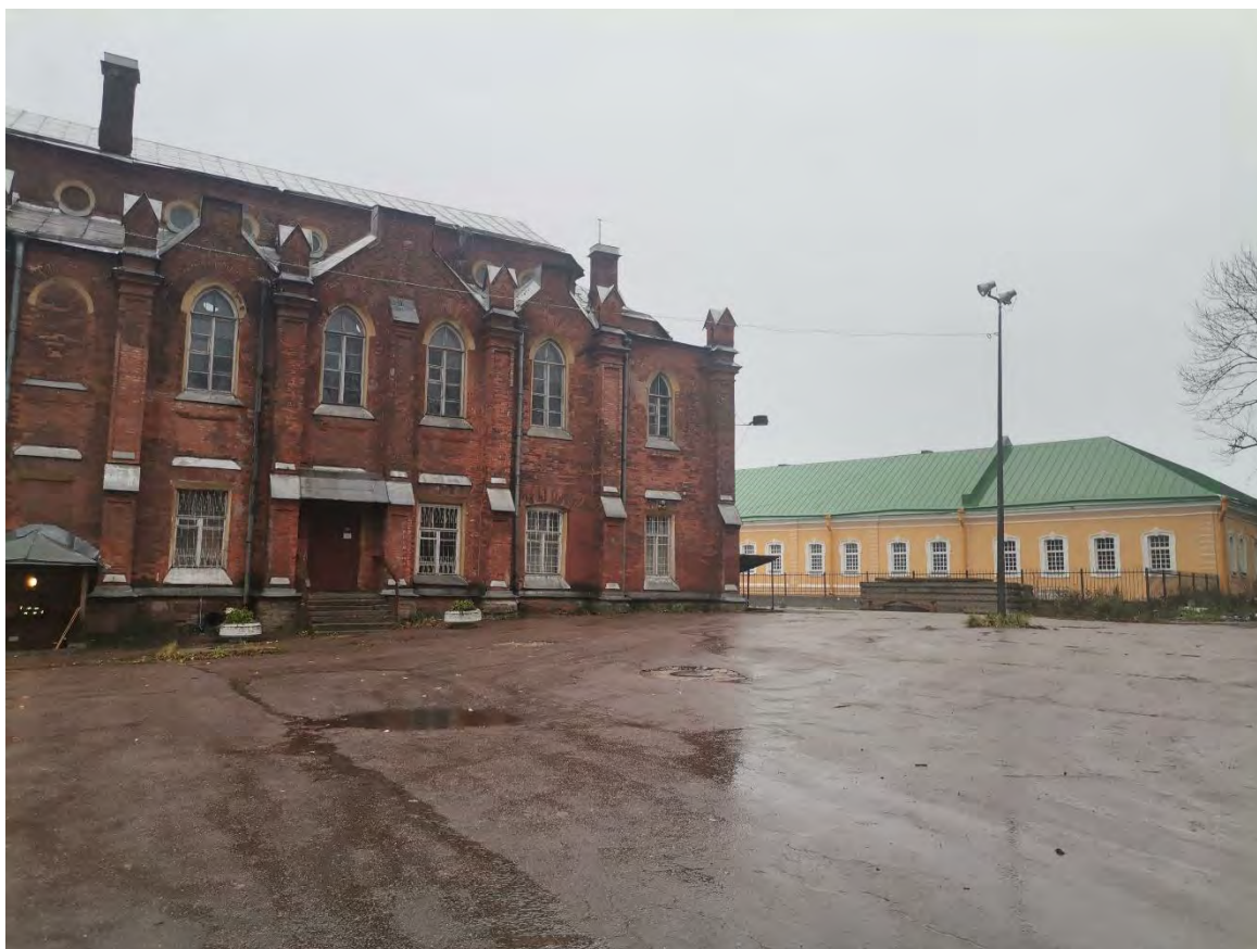
Фото 02. Объект культурного наследия федерального значения «Церковь лютеранская Воскресения Христова». Северо-восточный фасад. Фрагмент. Съёмка 31.10.2022 г.
