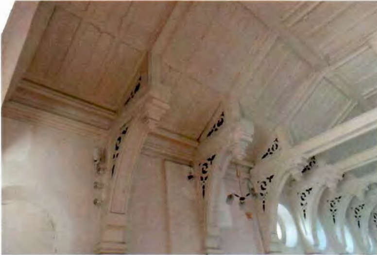
Фото 10.Фрагмент перекрытия центрального нефа
