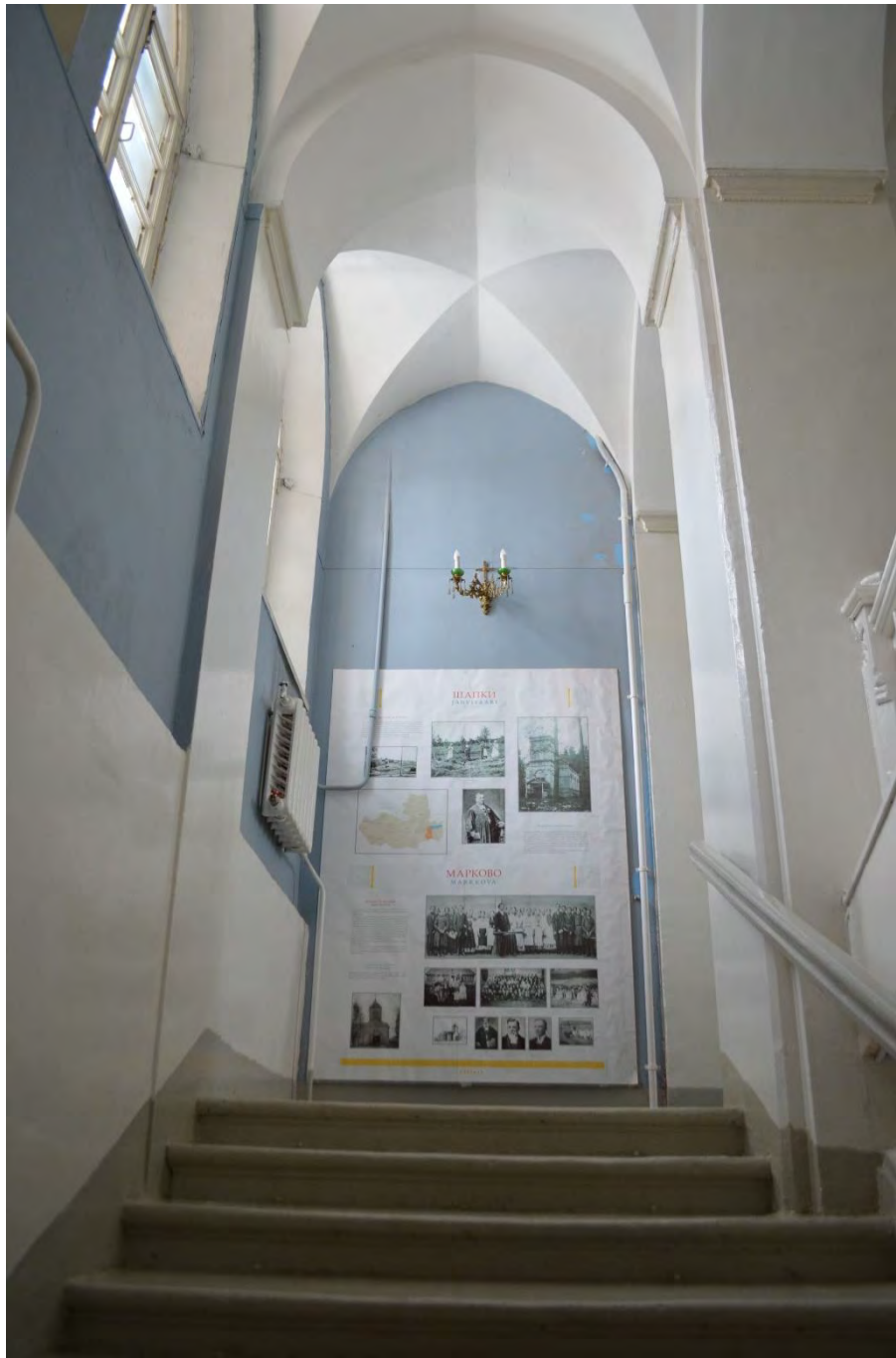
Фото 58. Объект культурного наследия федерального значения «Церковь лютеранская Воскресения Христова». Второй этаж. Помещение 1-Н (18). Лестница. Фрагмент. Съёмка 31.10.2022 г.
