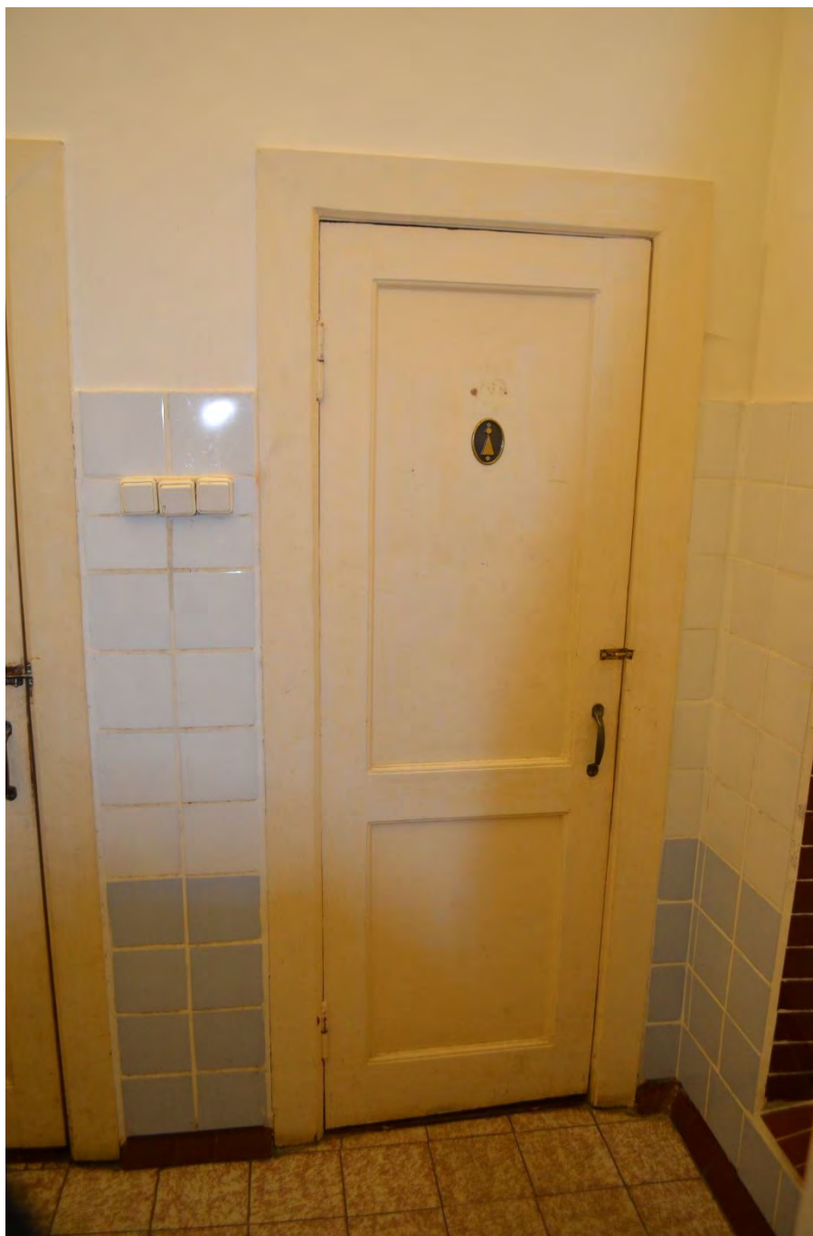
Фото 52. Объект культурного наследия федерального значения «Церковь лютеранская Воскресения Христова». Первый этаж. Помещение 1-Н (1). Фрагмент. Съёмка 31.10.2022 г.
