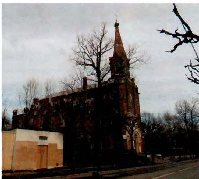
Фото 2. Церковь. Вид с юга.
