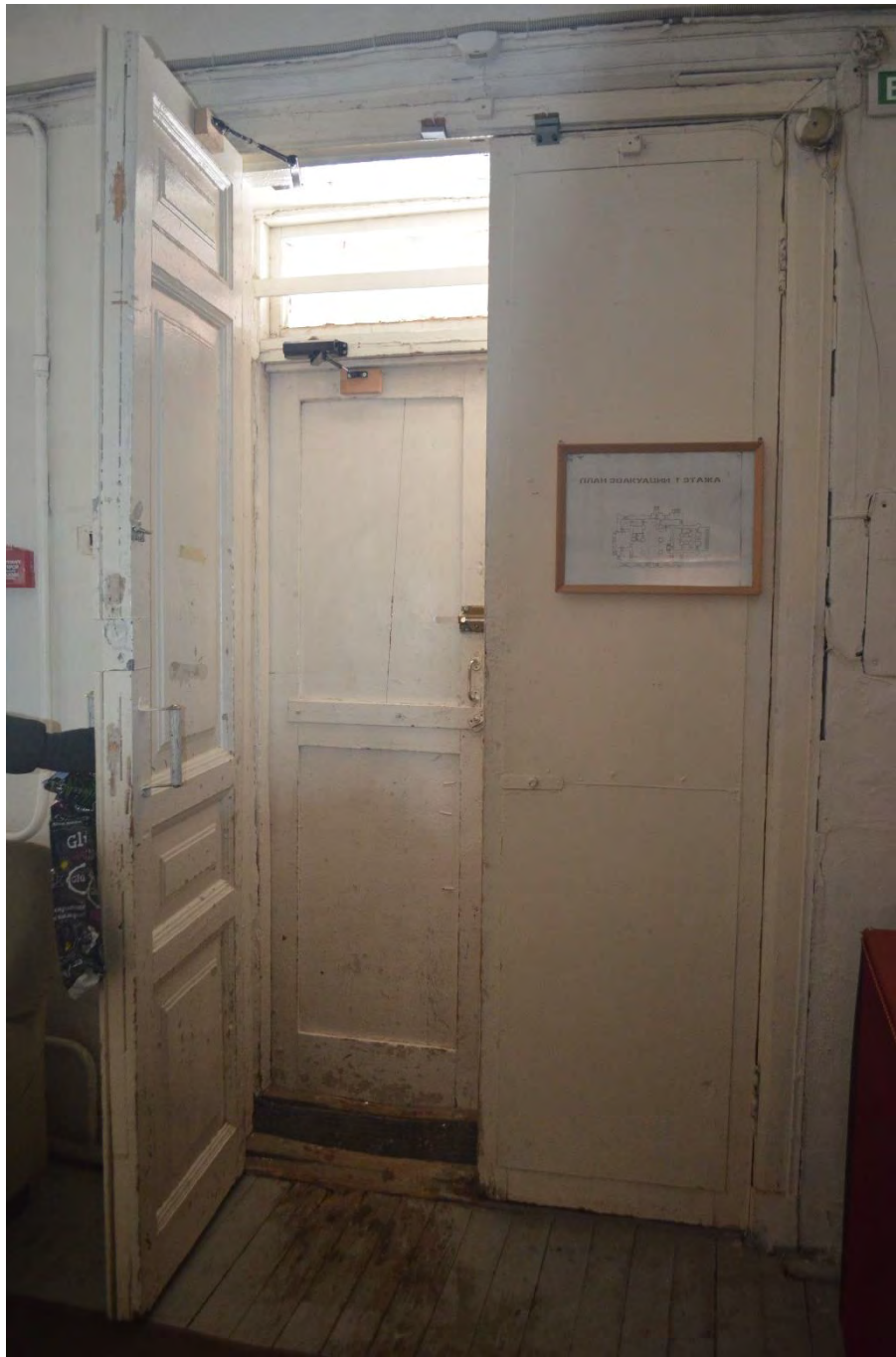
Фото 41. Объект культурного наследия федерального значения «Церковь лютеранская Воскресения Христова». Первый этаж. Помещение 1-Н (2). Фрагмент. Съёмка 31.10.2022 г.
