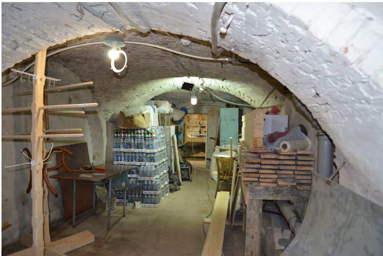
Фото 39. Объект культурного наследия федерального значения «Церковь лютеранская Воскресения Христова». Подвал. Помещение 2-Н (8). Фрагмент. Съёмка 31.10.2022 г.
