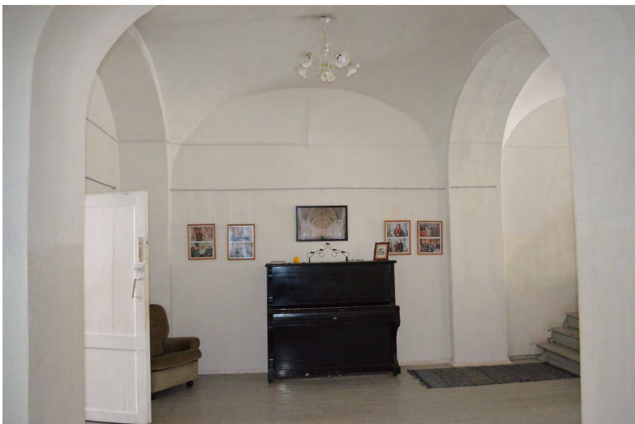
Фото 43. Объект культурного наследия федерального значения «Церковь лютеранская Воскресения Христова». Первый этаж. Помещение 1-Н (5). Фрагмент. Съёмка 31.10.2022 г.
