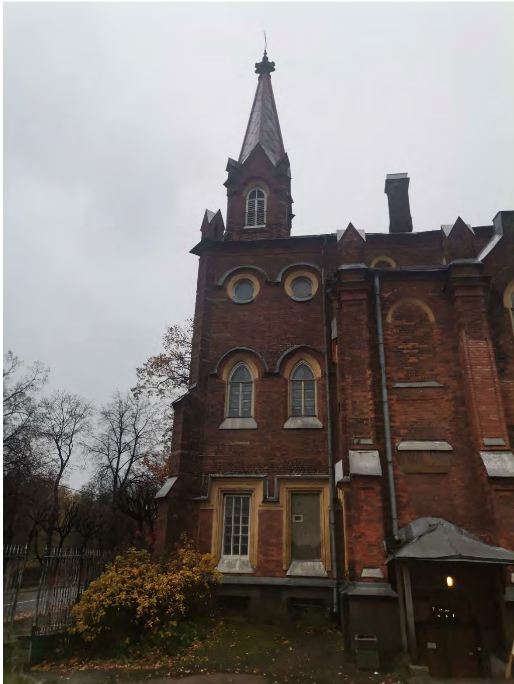
Фото 03. Объект культурного наследия федерального значения «Церковь лютеранская Воскресения Христова». Северо-восточный фасад. Фрагмент. Съёмка 31.10.2022 г.
