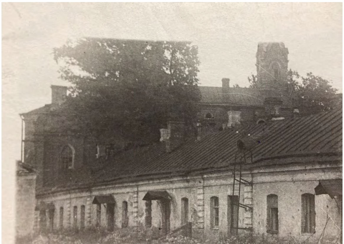
Иллюстрация 53. г. Пушкин. Домик б. Конюшенного ведомства угол ул. Комсомола и ул. Пролеткульта. Фасад со стороны двора. Фото 1944 г. Архив КГИОП.
