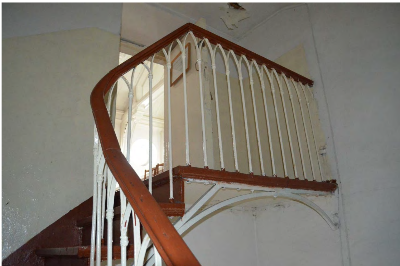
Фото 81. Объект культурного наследия федерального значения «Церковь лютеранская Воскресения Христова». Второй этаж. Помещение 1-Н (15). Лестница, ведущая на хоры. Фрагмент. Съёмка 31.10.2022 г.
