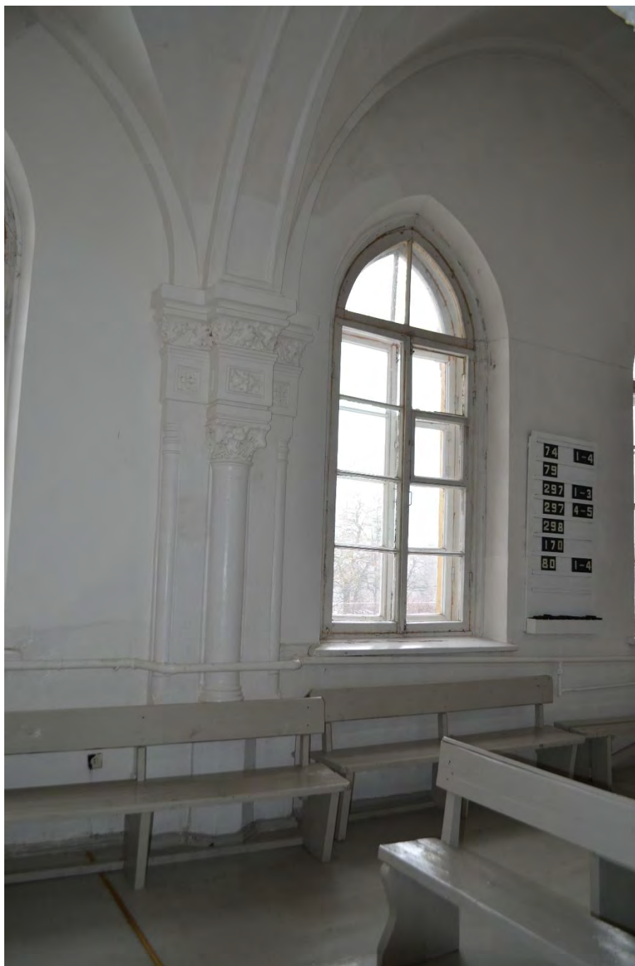
Фото 71. Объект культурного наследия федерального значения «Церковь лютеранская Воскресения Христова». Второй этаж. Помещение 1-Н (15). Церковный зал. Фрагмент. Съёмка 31.10.2022 г.
