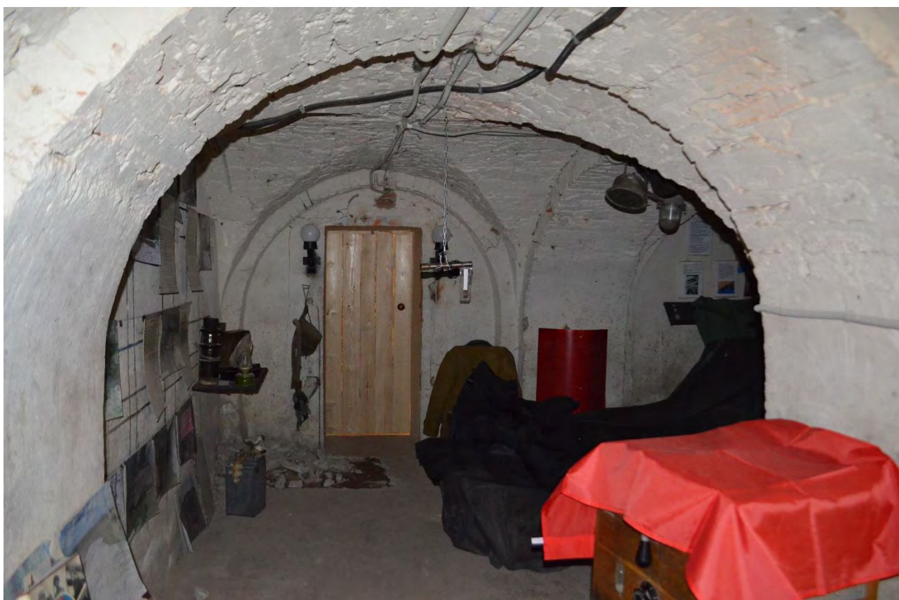
Фото 32. Объект культурного наследия федерального значения «Церковь лютеранская Воскресения Христова». Подвал. Помещение 2-Н (1). Фрагмент. Съёмка 31.10.2022 г.
