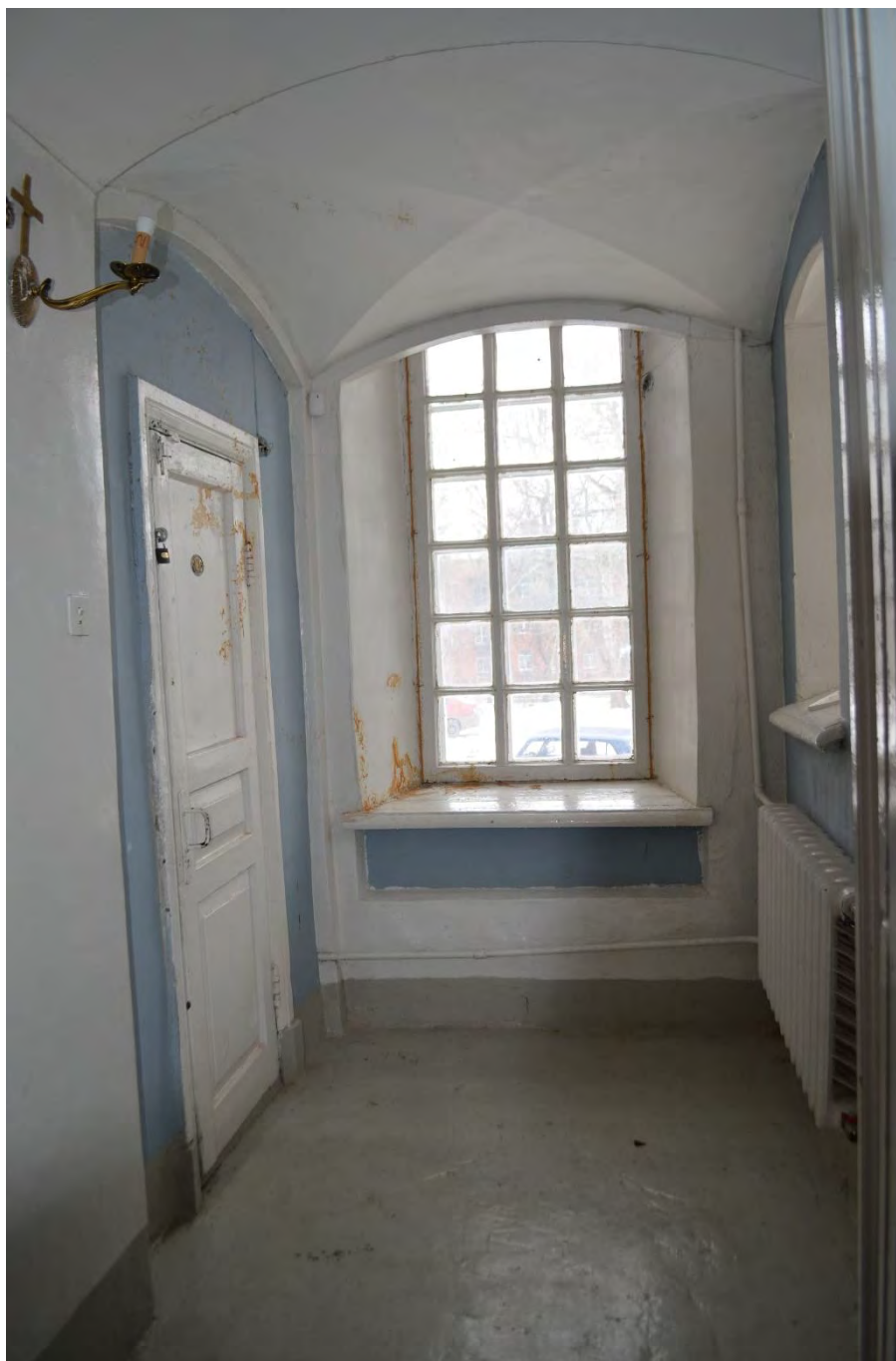
Фото 56. Объект культурного наследия федерального значения «Церковь лютеранская Воскресения Христова». Первый этаж. Помещение 1-Н (2). Фрагмент. Съёмка 31.10.2022 г.
