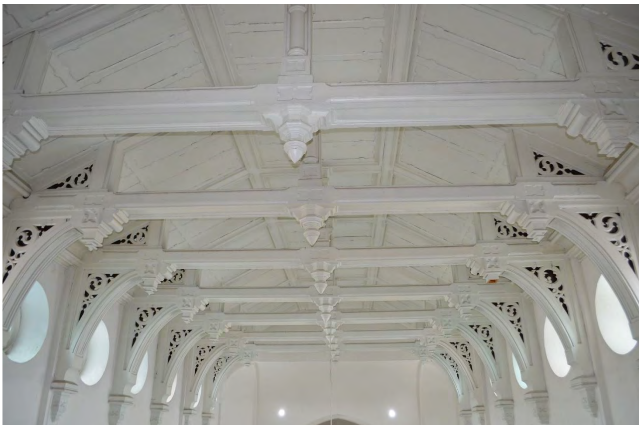
Фото 83. Объект культурного наследия федерального значения «Церковь лютеранская Воскресения Христова». Второй этаж. Помещение 1-Н (15). Церковный зал, потолок: фермы, кессоны и кронштейны. Съёмка 31.10.2022 г.
