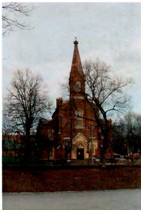
Фото 1. Лицевой юго-восточный фасад
