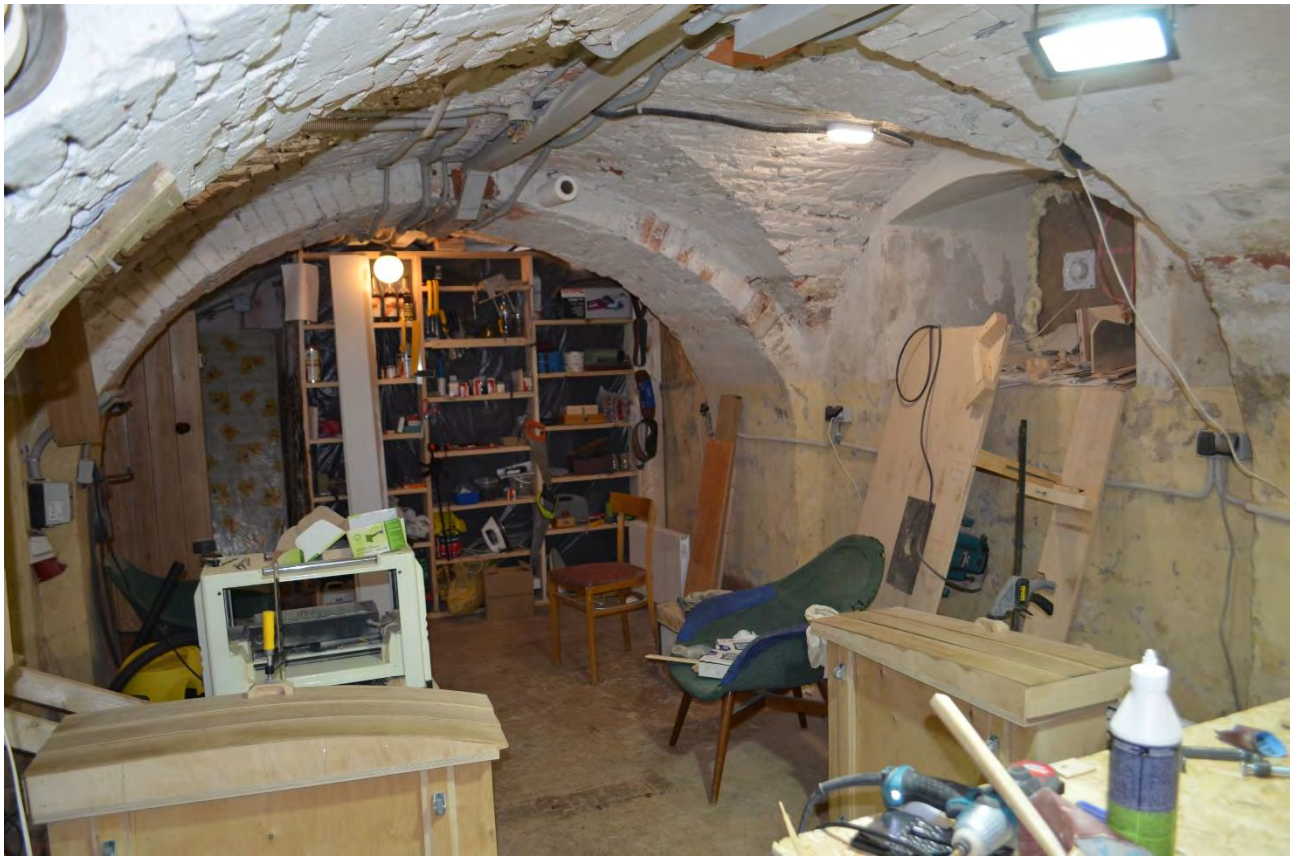
Фото 40. Объект культурного наследия федерального значения «Церковь лютеранская Воскресения Христова». Подвал. Помещение 2-Н (8). Фрагмент. Съёмка 31.10.2022 г.
