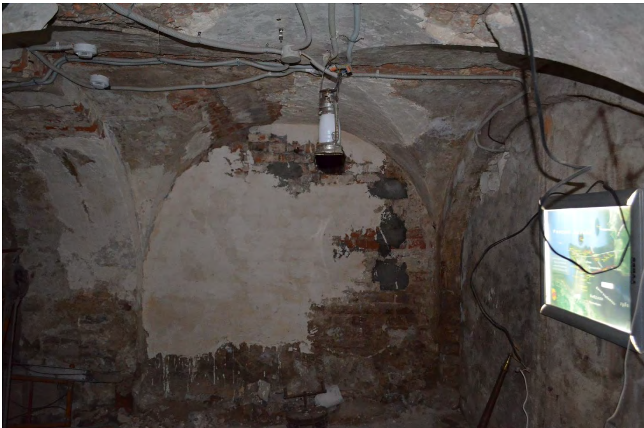
Фото 33. Объект культурного наследия федерального значения «Церковь лютеранская Воскресения Христова». Подвал. Помещение 2-Н (1). Фрагмент. Съёмка 31.10.2022 г.
