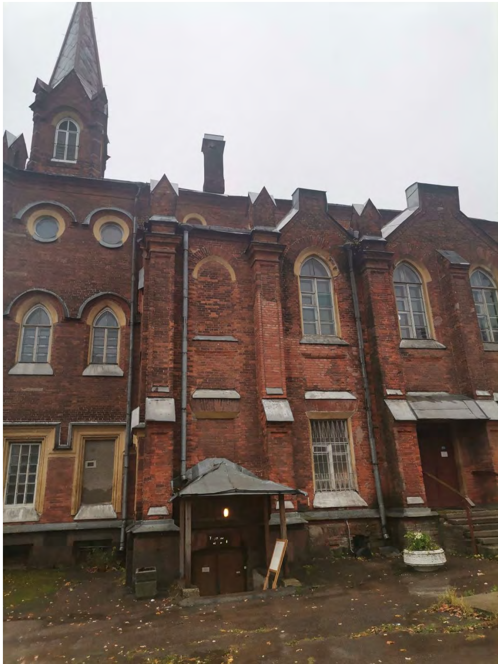
Фото 04. Объект культурного наследия федерального значения «Церковь лютеранская Воскресения Христова». Северо-восточный фасад. Фрагмент. Съёмка 31.10.2022 г.
