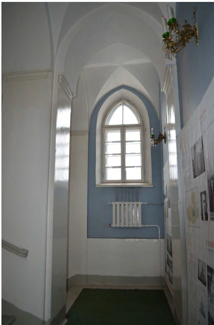
Фото 61. Объект культурного наследия федерального значения «Церковь лютеранская Воскресения Христова». Второй этаж. Помещение 1-Н (18). Лестница. Фрагмент. Съёмка 31.10.2022 г.
