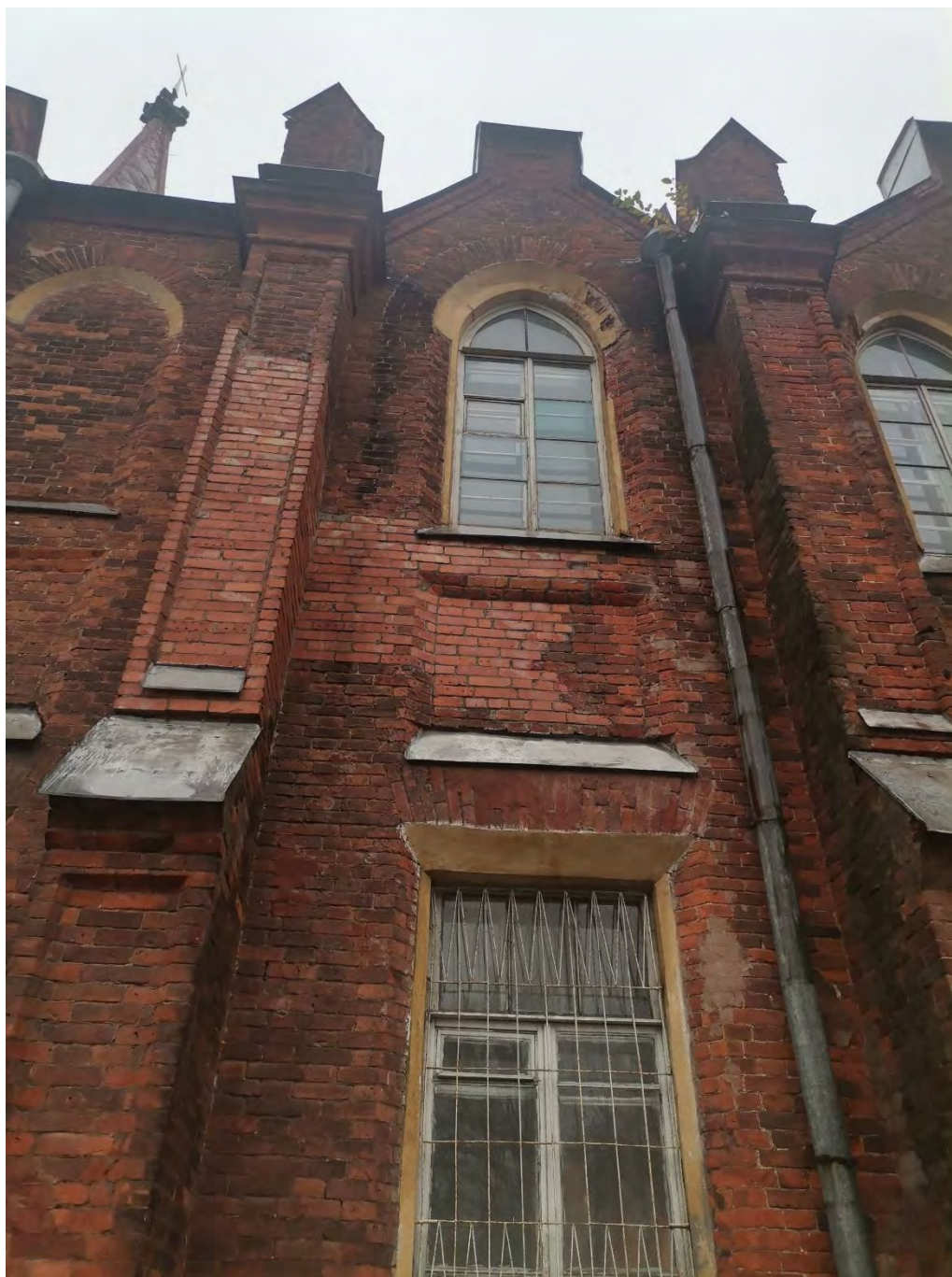
Фото 10. Объект культурного наследия федерального значения «Церковь лютеранская Воскресения Христова». Северо-восточный фасад. Фрагмент. Съёмка 31.10.2022 г.
