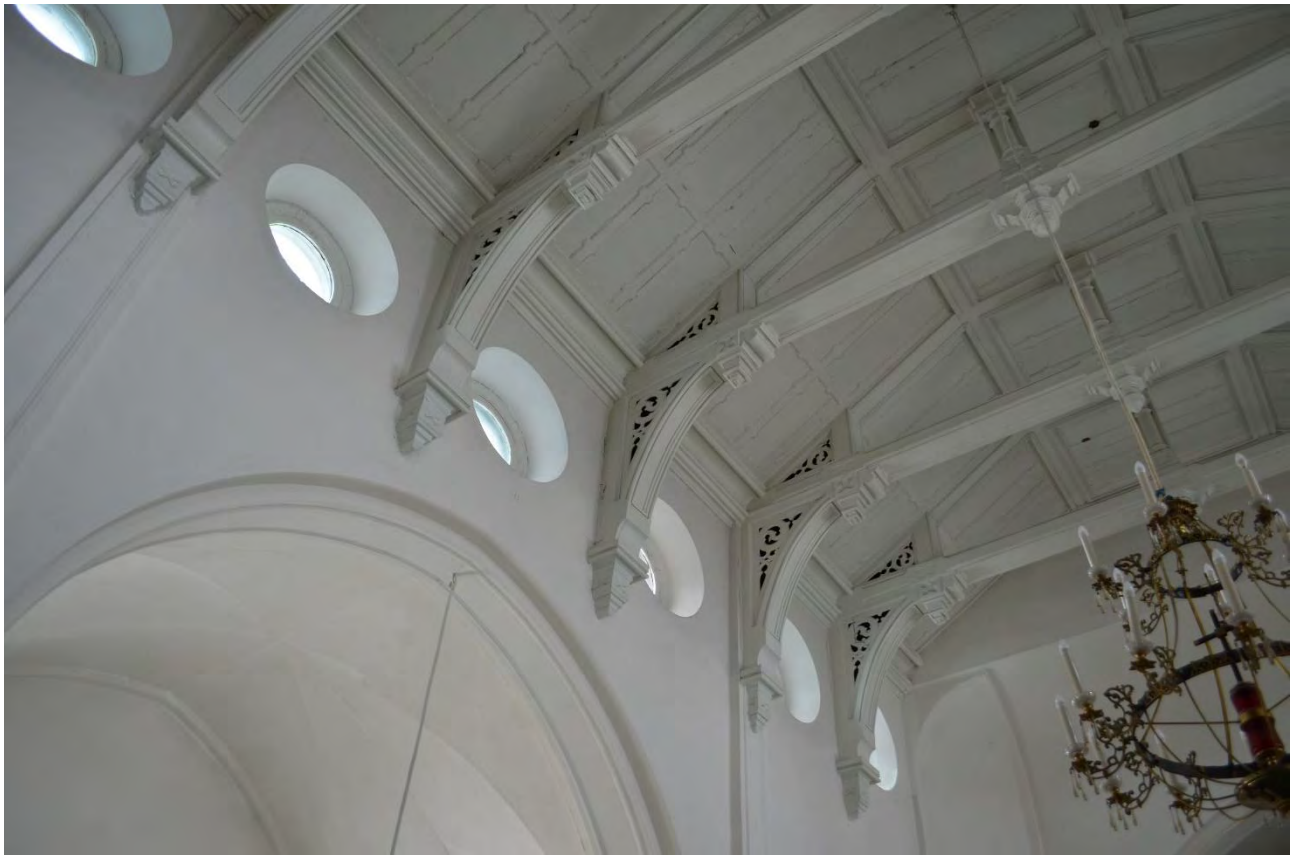
Фото 68. Объект культурного наследия федерального значения «Церковь лютеранская Воскресения Христова». Второй этаж. Помещение 1-Н (15). Церковный зал. Фрагмент. Съёмка 31.10.2022 г.
