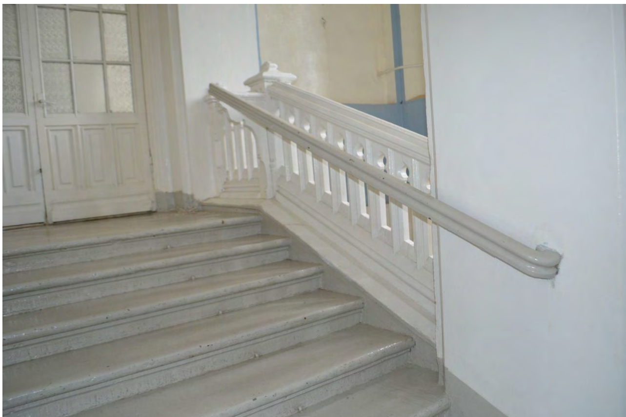
Фото 62. Объект культурного наследия федерального значения «Церковь лютеранская Воскресения Христова». Второй этаж. Помещение 1-Н (18). Лестница. Фрагмент. Съёмка 31.10.2022 г.
