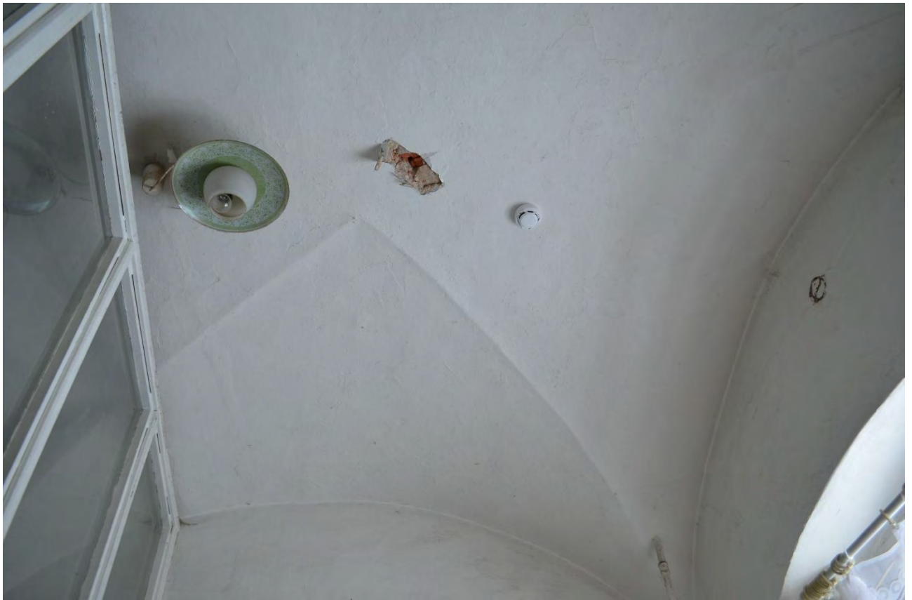
Фото 48. Объект культурного наследия федерального значения «Церковь лютеранская Воскресения Христова». Первый этаж. Помещение 1-Н (13). Фрагмент. Съёмка 31.10.2022 г.
