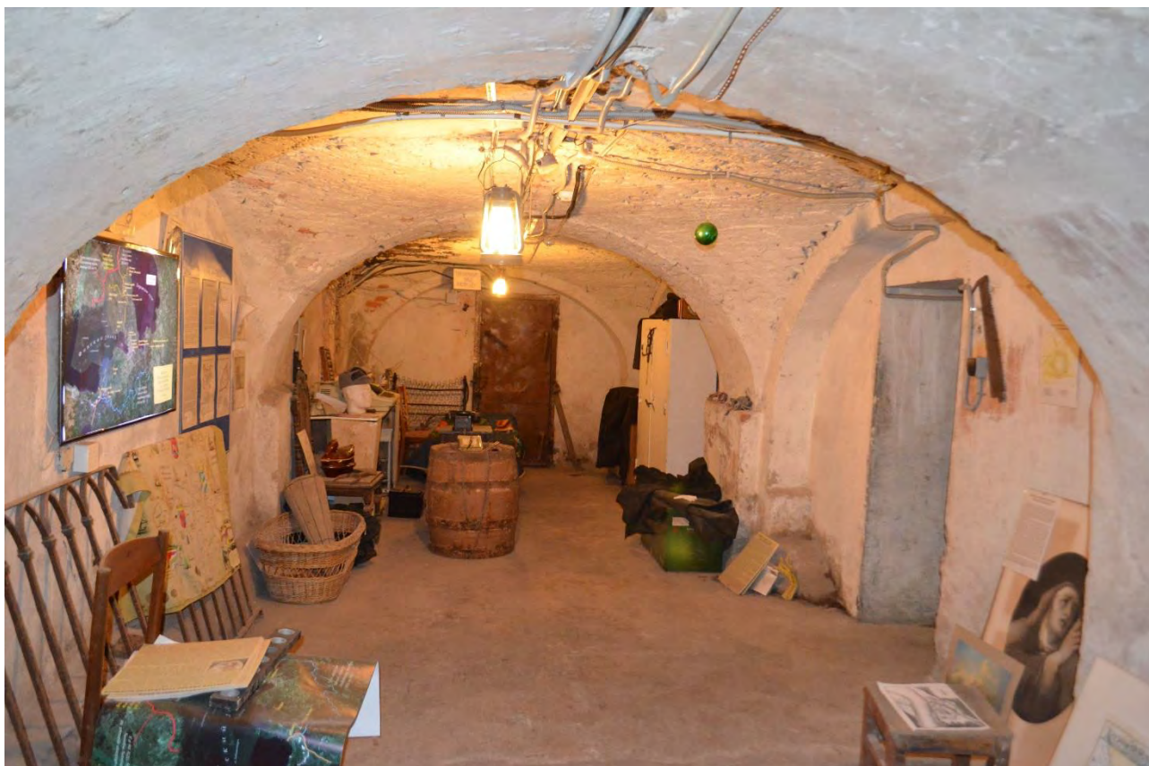
Фото 30. Объект культурного наследия федерального значения «Церковь лютеранская Воскресения Христова». Подвал. Помещение 2-Н (1). Фрагмент. Съёмка 31.10.2022 г.
