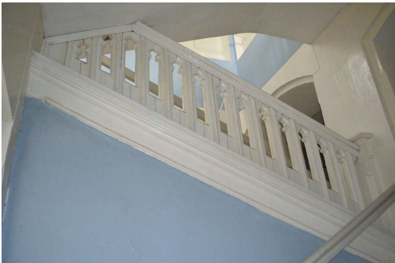
Фото 59. Объект культурного наследия федерального значения «Церковь лютеранская Воскресения Христова». Второй этаж. Помещение 1-Н (18). Лестница. Фрагмент. Съёмка 31.10.2022 г.
