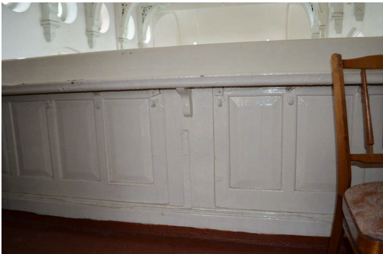
Фото 82. Объект культурного наследия федерального значения «Церковь лютеранская Воскресения Христова». Второй этаж. Помещение 1-Н (15). Хоры. Фрагмент. Съёмка 31.10.2022 г.
