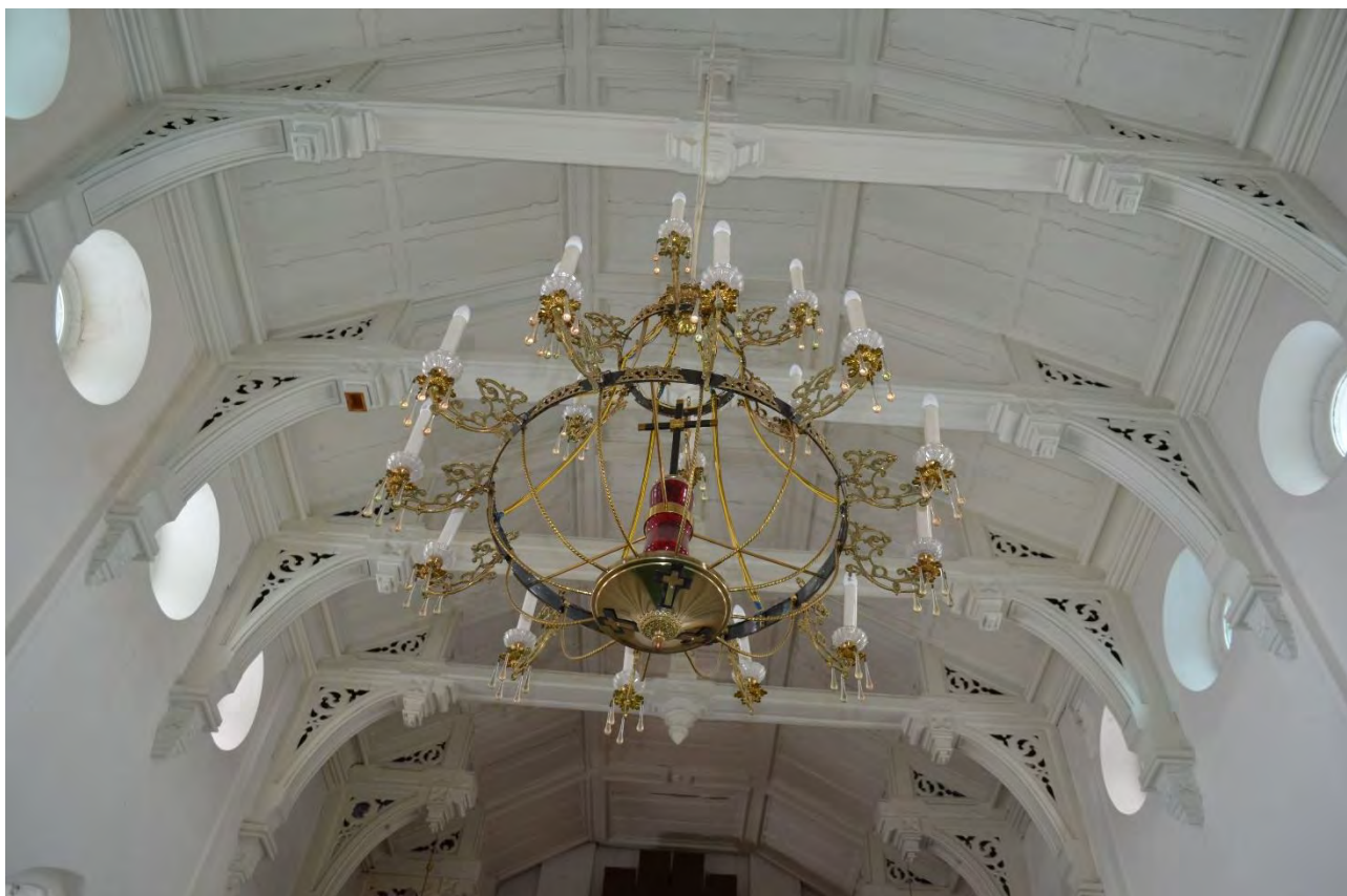
Фото 77. Объект культурного наследия федерального значения «Церковь лютеранская Воскресения Христова». Второй этаж. Помещение 1-Н (15). Церковный зал. Фрагмент. Съёмка 31.10.2022 г.
