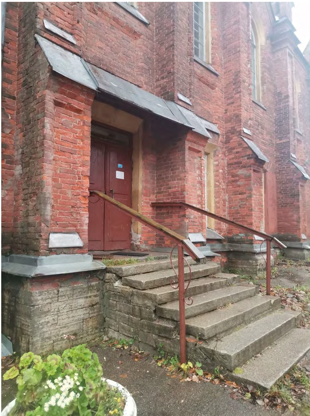
Фото 09. Объект культурного наследия федерального значения «Церковь лютеранская Воскресения Христова». Северо-восточный фасад. Фрагмент. Съёмка 31.10.2022 г.
