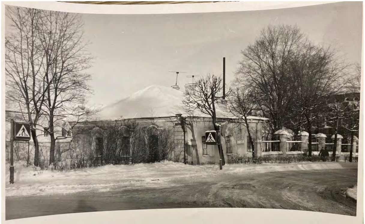
Иллюстрация 73. О. В. Трубский. г. Пушкин. Нижние конюшни. Отдельностоящее здание на углу Комсомольской ул. и ул. Пролеткульта. Фото 1985 г. Архив КГИОП.
