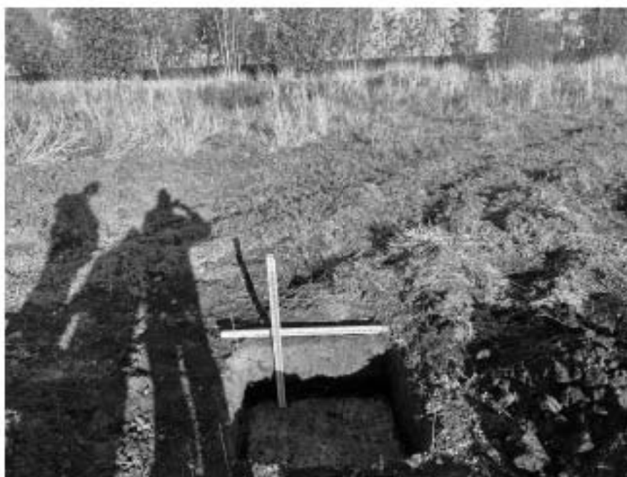
Илл. 28. Санкт-Петербург, пос. Шушары, отд. Бадаевское, участок 118. Шурф 1 разобран до материка. Вид с юга.
