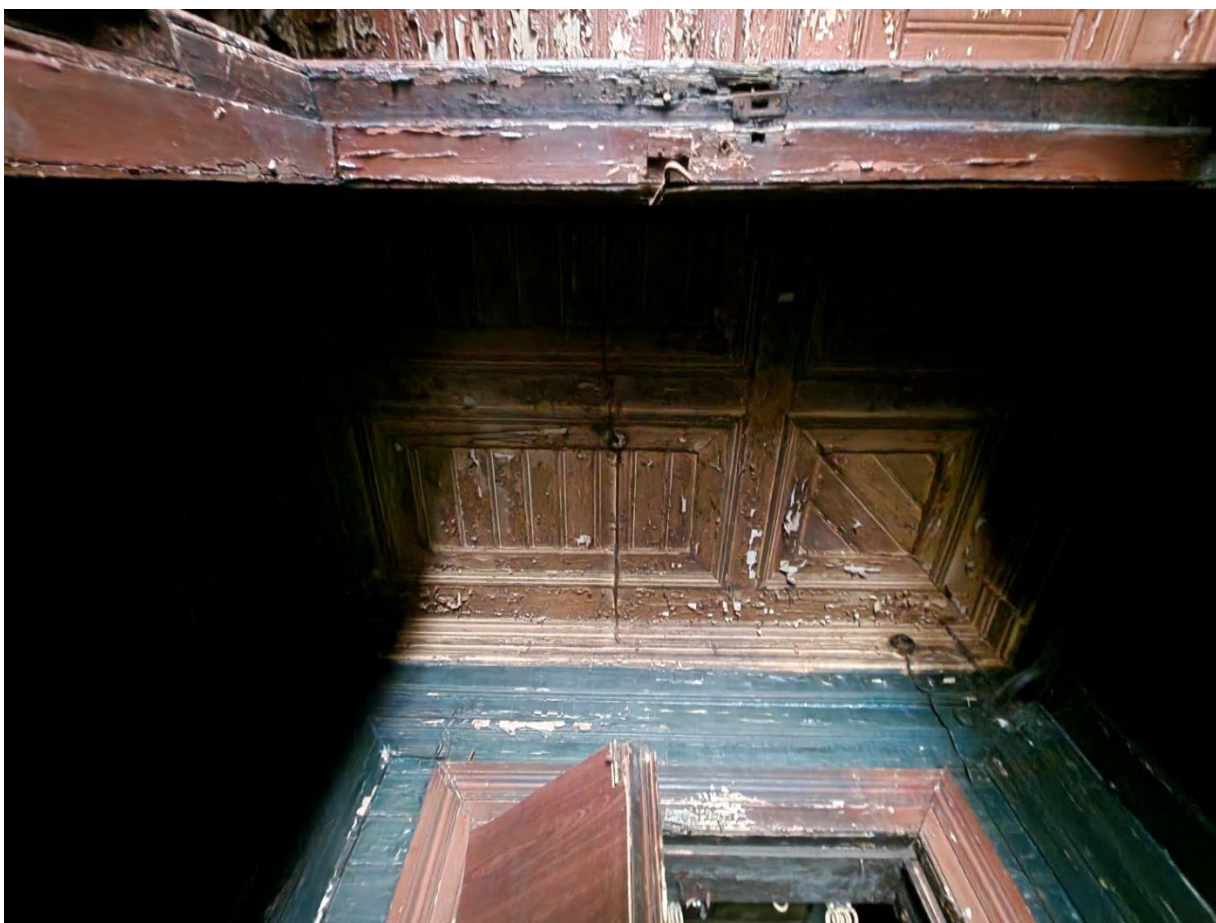
20. Потолок тамбура (пом. 1 (4-Н) выявленного объекта культурного наследия «Жилой дом (деревянный)».
