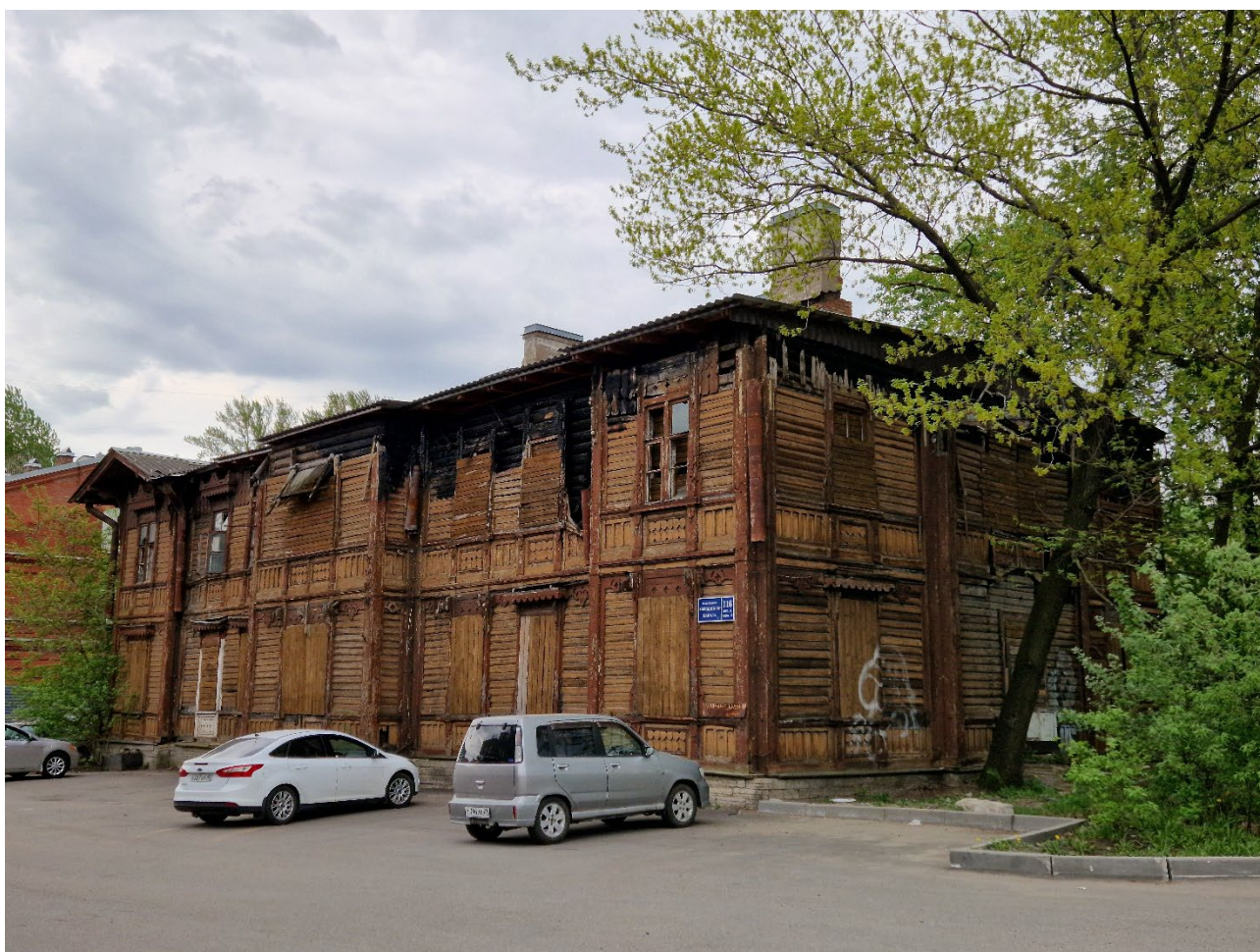
1. Выявленный объект культурного наследия «Жилой дом (деревянный)». Вид с северо-запада.
