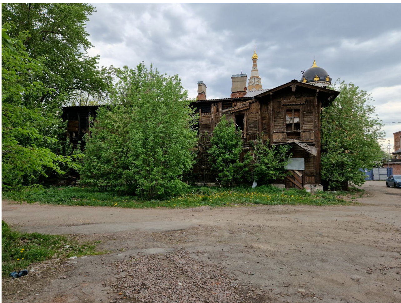
10. Выявленный объект культурного наследия «Жилой дом (деревянный)». Южный фасад. Общий вид фасада. Вид с юго-востока.
