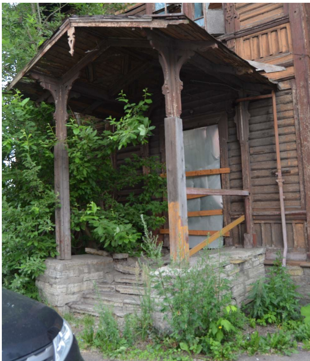
13. Выявленный объект культурного наследия «Жилой дом (деревянный)». Восточный фасад. Крыльцо главного входа. Вид с северо-востока.
