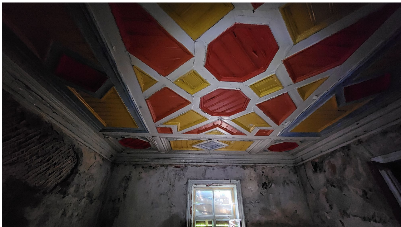
28. Помещение №5 (4-Н) в уровне 1-го этажа выявленного объекта культурного наследия «Жилой дом (деревянный)».
