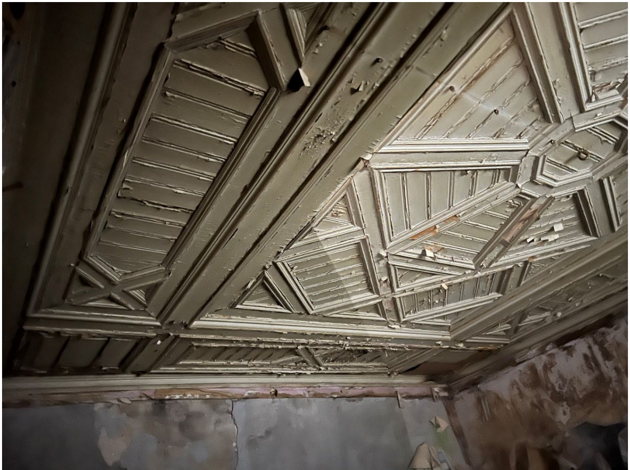
26. Помещение №6 (4-Н) в уровне 1-го этажа выявленного объекта культурного наследия «Жилой дом (деревянный)».
