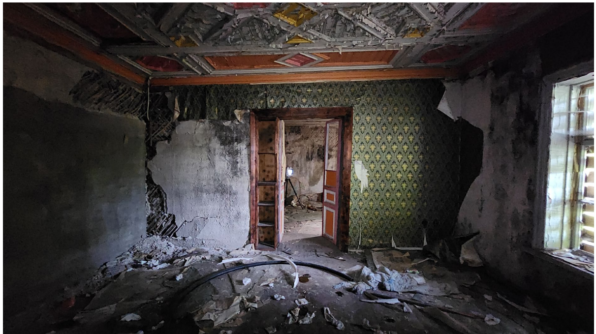
27. Помещение №7 (4-Н) в уровне 1-го этажа выявленного объекта культурного наследия «Жилой дом (деревянный)».
