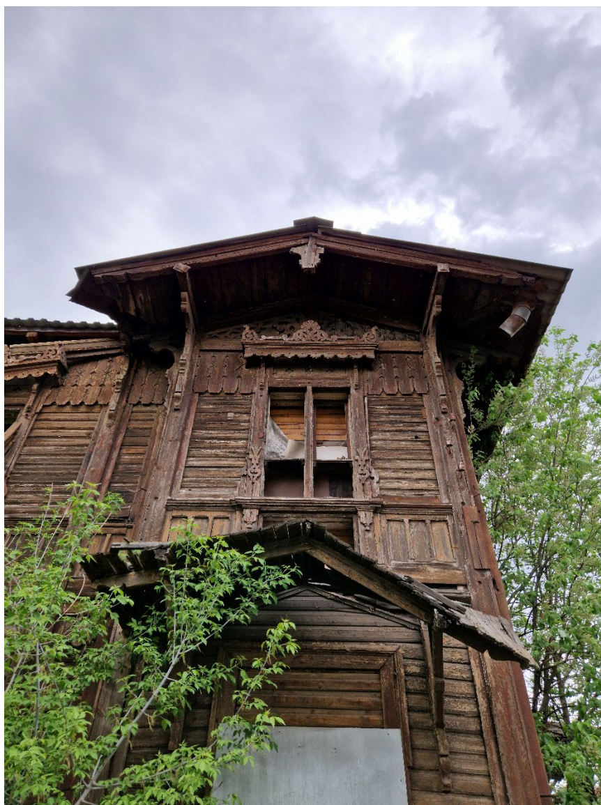
12. Выявленный объект культурного наследия «Жилой дом (деревянный)». Восточный фасад. Оформление главного входа. Вид с востока.
