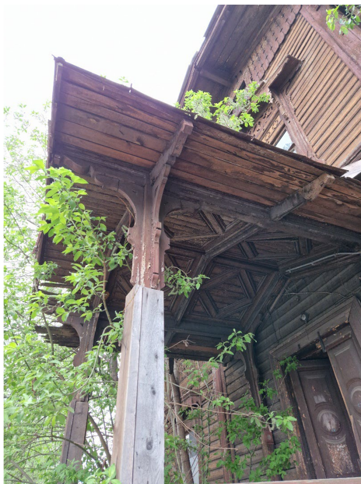
14. Выявленный объект культурного наследия «Жилой дом (деревянный)». Восточный фасад. Оформление крыльца главного входа. Вид с северо-востока.
