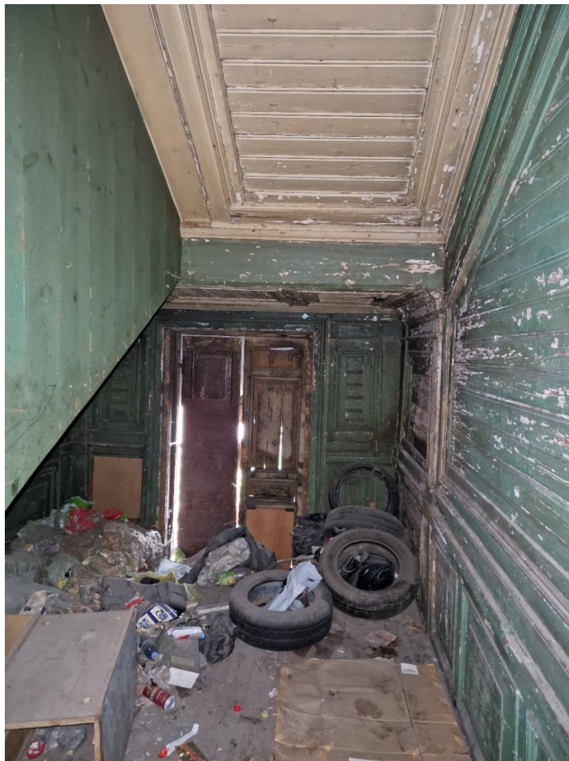
29. Помещение №2 (4-Н) в уровне 1-го этажа выявленного объекта культурного наследия «Жилой дом (деревянный)».
