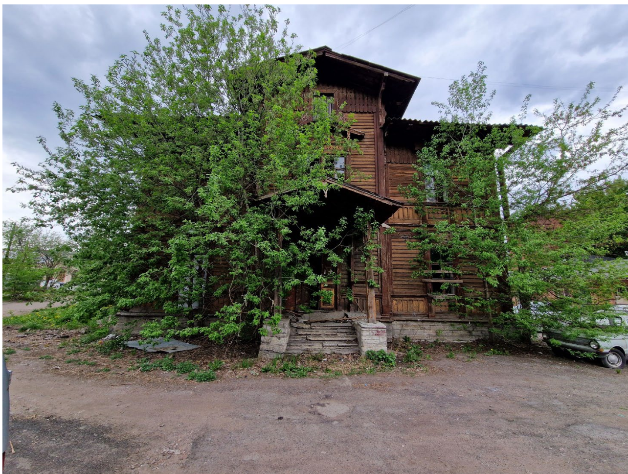
11. Выявленный объект культурного наследия «Жилой дом (деревянный)». Восточный фасад. Общий вид. Вид с юго-востока.
