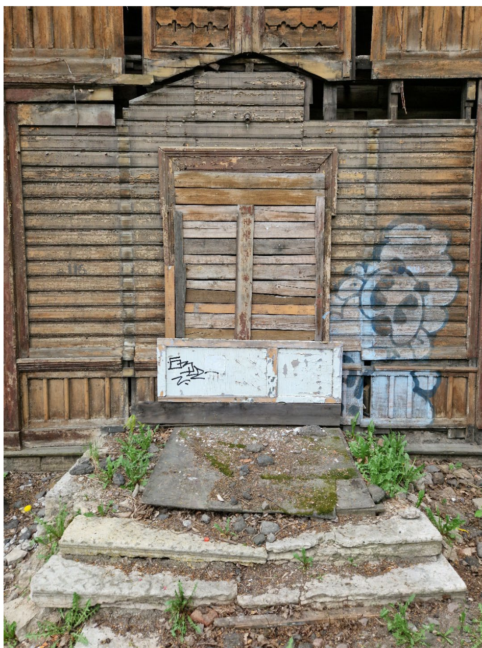
6. Выявленный объект культурного наследия «Жилой дом (деревянный)». Западный фасад. Крыльцо западного входа. Вид с запада.
