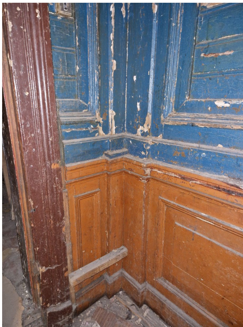
19. Тамбур пом. 1 (4-Н) выявленного объекта культурного наследия «Жилой дом (деревянный)».
