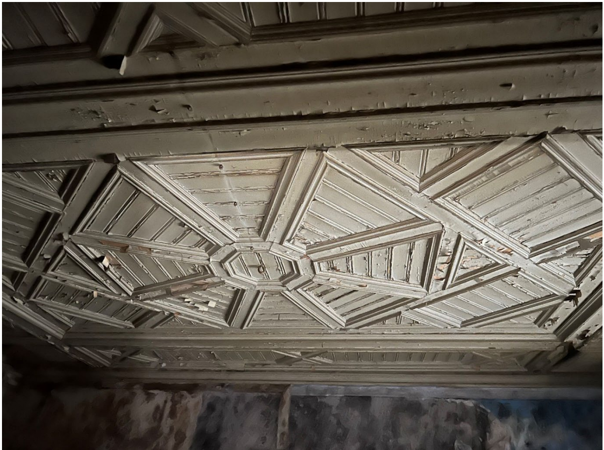
25. Помещение №6 (4-Н) в уровне 1-го этажа выявленного объекта культурного наследия «Жилой дом (деревянный)».
