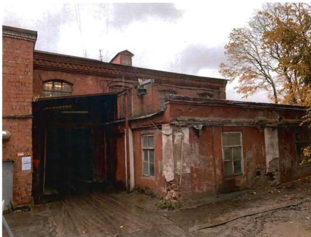
4. Вид на северо-восточный фасад. Фрагмент.
