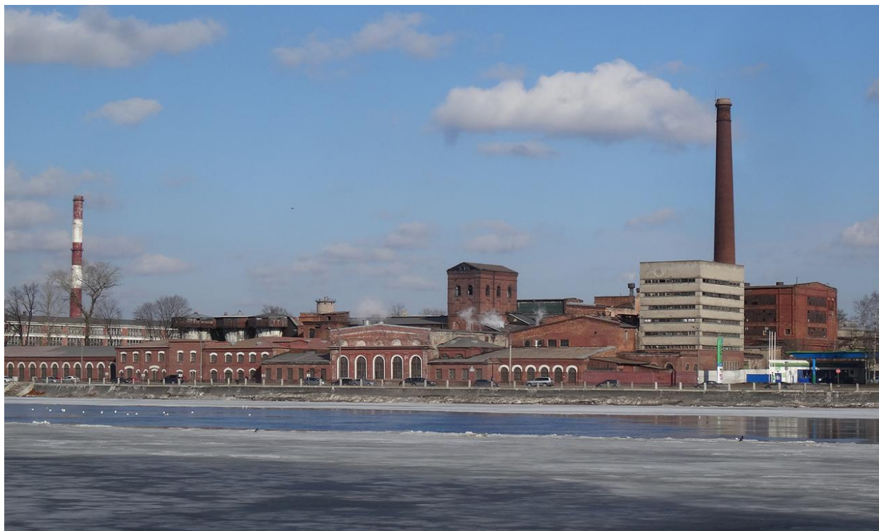
26. Панорама фабричных корпусов ОАО «Бумага». Фото 2019 г.
