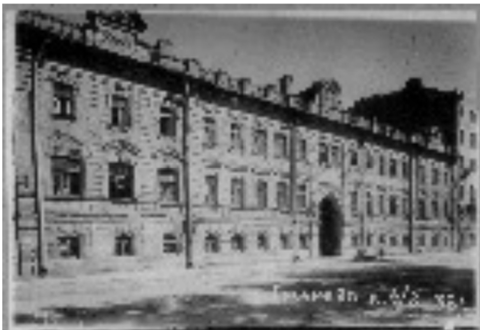
Илл. 8. ЦГАКФФД СПб Гр 71378 Фасад дома №6/8 на улице Писарева. Архитектор Слупский И.Б., 1889-1891 гг. 1949 г.
