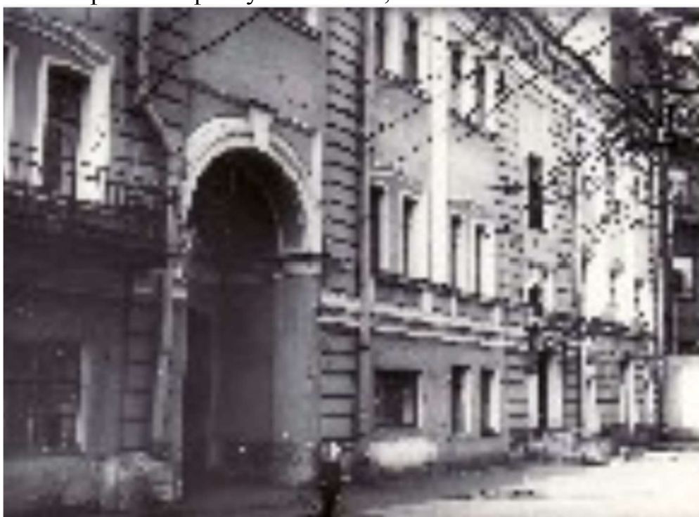
Илл. 9. ЦГАКФФД СПб Ар 212329 Вид части фасада со стороны двора бывшего запасного дома великого князя Павла Александровича по улице Писарева, 8 ( архитектор И.Б.Слупский, 1889- 1891 гг.). 1977 г.
