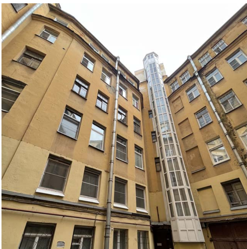
Фото №11. Южный дворовой фасад, вход в общедомовую лестничную клетку.
